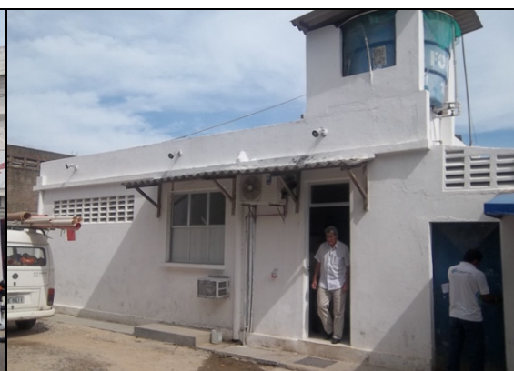
Foto 13 – Vista externa do Centro avançado de apoio operacional.
