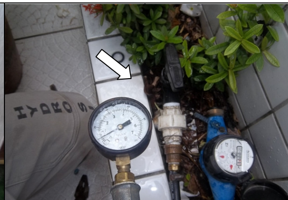
Foto 8 – Medição de pressão na Rua 1H, nº 74, Parque Tabapuá, antes do hidrômetro.
