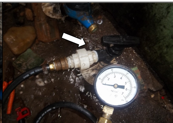
Foto 10 – Medição de pressão na Rua Areré, n°434, Parque Potira, antes do hidrômetro.
