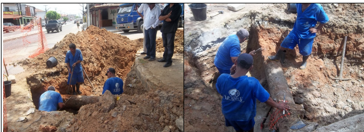
Foto 1 e 2 – Injetamento na adutora de reforço, localizado no cruzamento da Av. Contorno Leste com a Rua José Moura.
