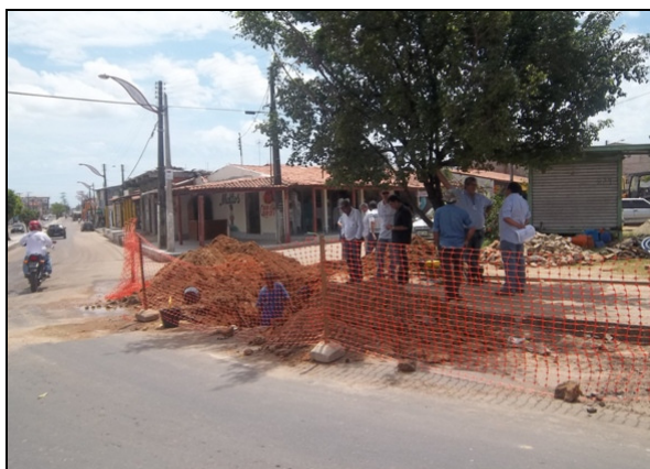
Foto 3 – Injetamento na adutora de reforço, localizado no cruzamento da Av. Contorno Leste com a Rua José Moura.
