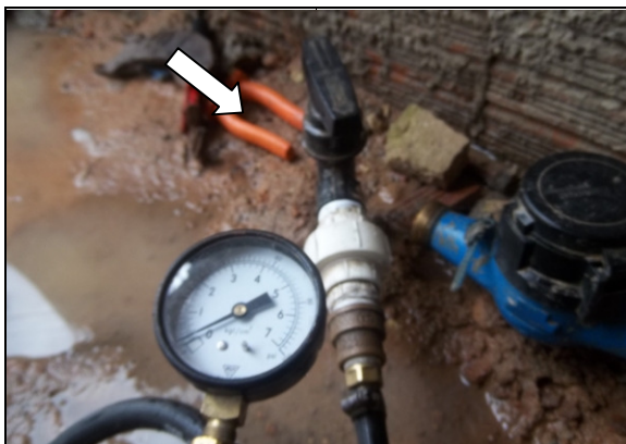
Foto 9 – Medição de pressão na Rua 12, n° 238, Parque Tabapuá, antes do hidrômetro.
