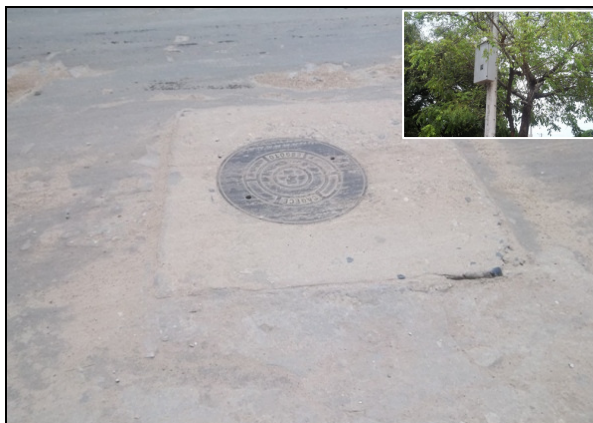
Foto 4 – UTR 53: Localizada na Rua Dom Almeida Lustosa.
