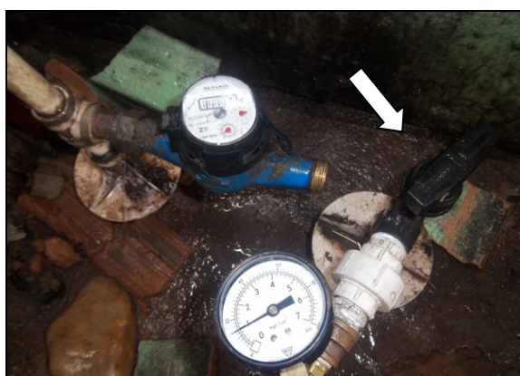
Foto 11 – Medição de pressão na Rua Consunel, n° 402, Parque Potira, antes do hidrômetro.
