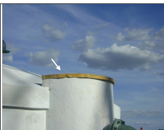
Foto 33 – RAP-03: Tampa de visita adequada.
