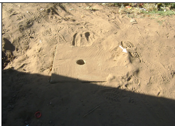
Foto 37 – Registro de descarga localizado na Rua Maria das Dores da Conceição.
