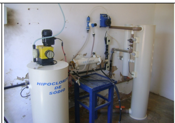
Foto 16 – Fabrica de hipoclorito de sódio desativada.
