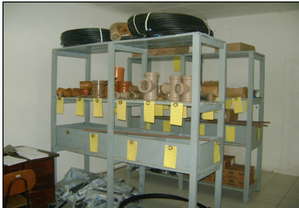
Foto 49 – Almojarifado (localizado no escritório/loja do SAA de Porteiras).
