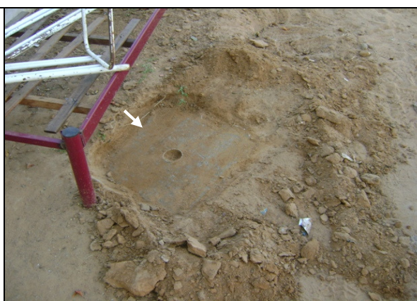
Foto 41 – Registro de descarga localizado na Rua José Vilmar Anselmo.
