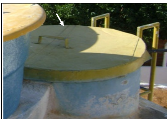
Foto 29 – RAP-01: Tampa de visita adequada.
