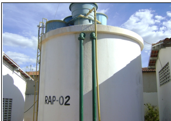
Foto 27 – RAP-02: Existência de identificação.
