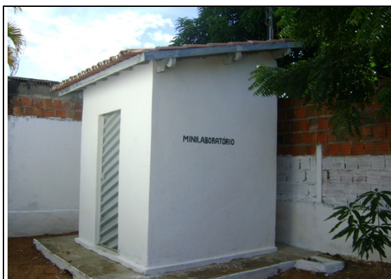
Foto 9 – Laboratório: Vista externa.
