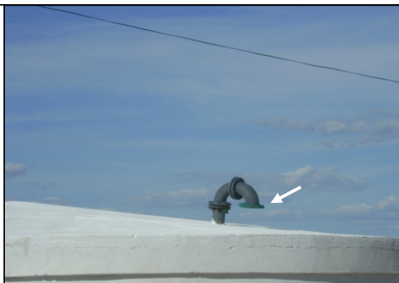
Foto 25 – RAP-01: Tubulação de ventilação adequada.
