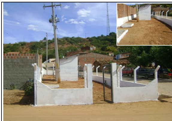
Foto 3 – PT-02: Área cercada e sinalizada.
