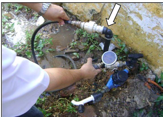
Foto 44 – Medição de pressão na Rua José Alencar, nº 23, Centro, antes do hidrômetro.
