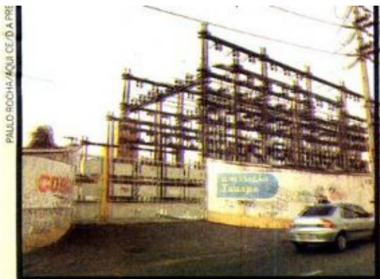
FALHA NA DISTRIBUIÇÃO PROVOCA DANOS EM APARELHOS
