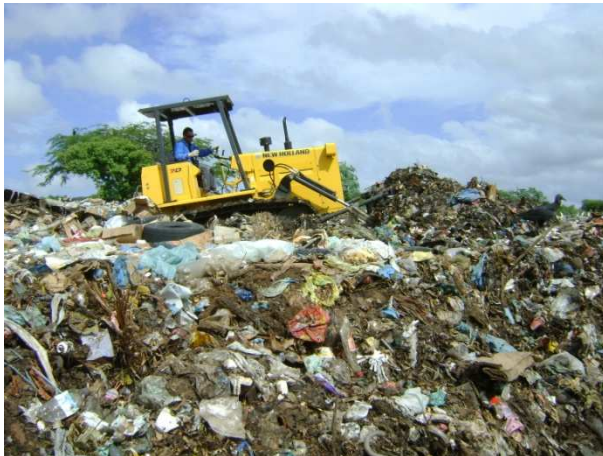
Figura 4.19 – Compactação das camadas de resíduos
