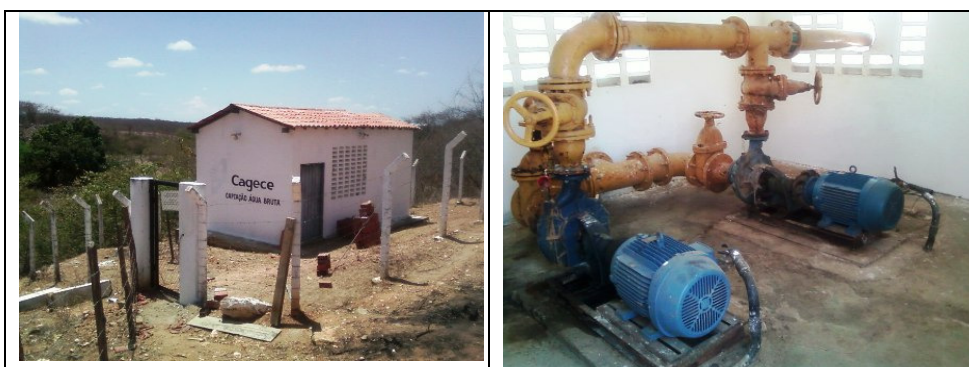
Fotos 16 e 17 – EEAB-01 – Casa de abrigo e conjuntos motores-bomba
