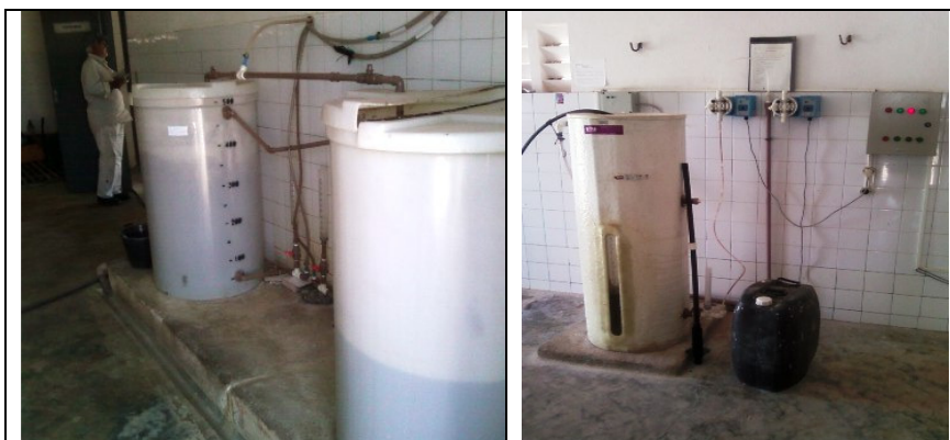
Fotos 10 e 11 – Tanques dosadores e sistema de fluoretação
