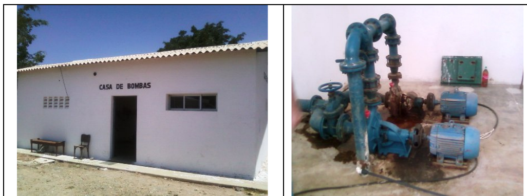
Fotos 18 e 19 – EEAT-01 – Casa de abrigo e conjuntos motores-bomba
