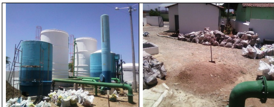
Fotos 4 e 5 – Vistas dos filtros
