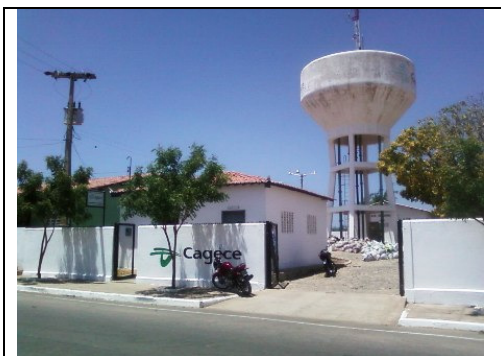
Foto 3 – Vista da entrada da ETA do SAA de Parambu
