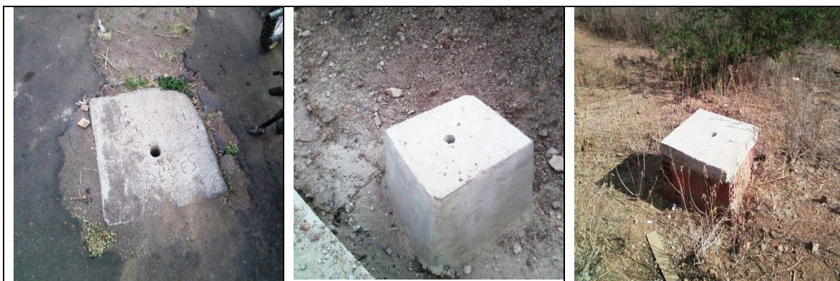
Fotos 31, 32 e 33 – Registros de descarga nas Ruas Pedro Alves da Costa, José Romero Lima e Sítio Cachimbo do Severino
