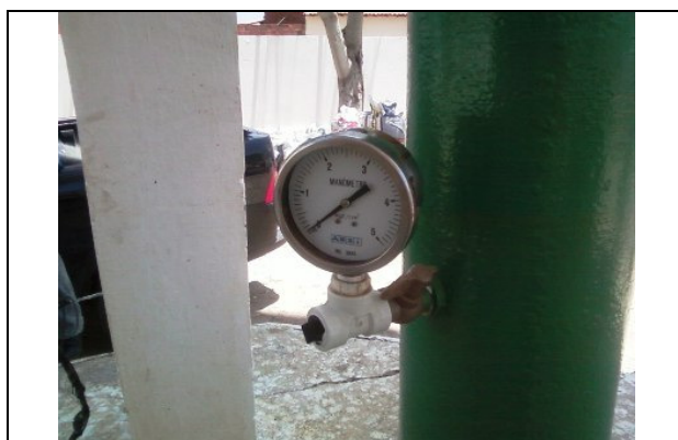
Foto 28 – Dispositivo de medição de nível no REL-01
