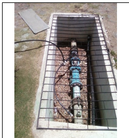
Foto 29 – Macromedidor na saída do RAP-01
