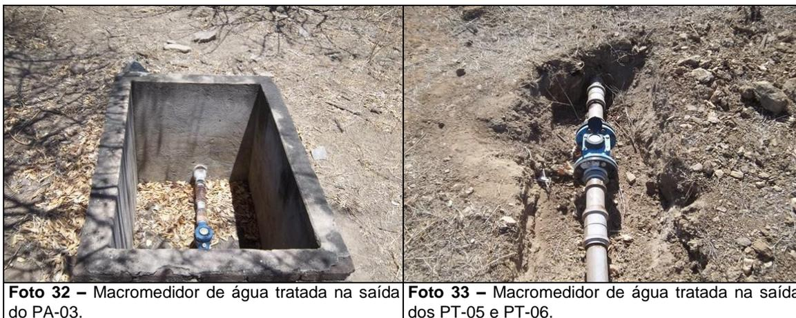
**Foto 32** – Macromedidor de água tratada na saída do PA-03.
