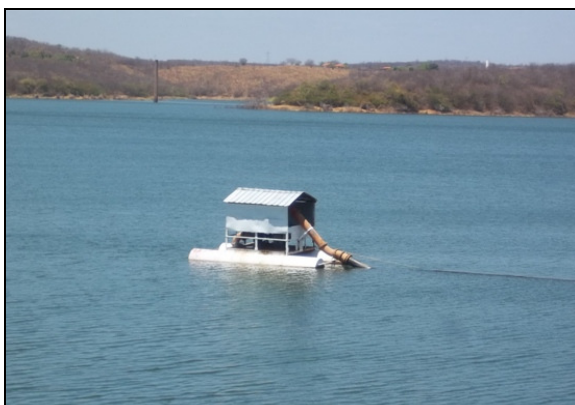
Foto 22 – Elevatória EE-01, em flutuante.
