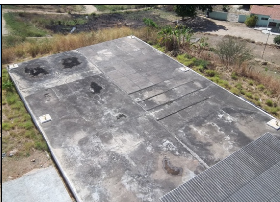
Foto 48 – Tampas de inspeção e tubulações de ventilação do RAP-02.
