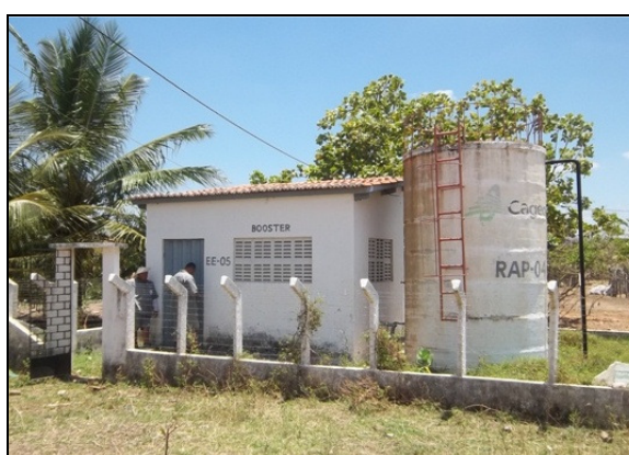
Foto 39 – Prédio de abrigo do quadro da EE-05.
