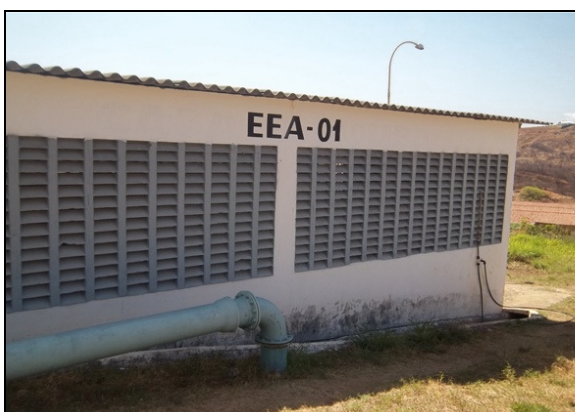
Foto 31 – Prédio de abrigo do quadro da EE-03.
