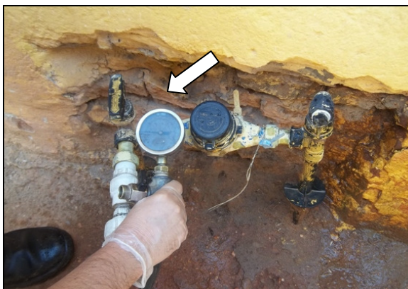
Foto 84 – Medição de pressão sem hidrômetro, na Rua Anália Correia, 43 - Praça Santo Antônio.
