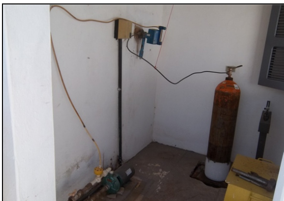
Foto 7 – Cilindros de cloro.
