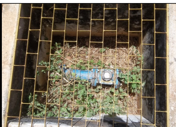
Foto 68 – Macromedidor de água tratada na entrada do RAP-03.
