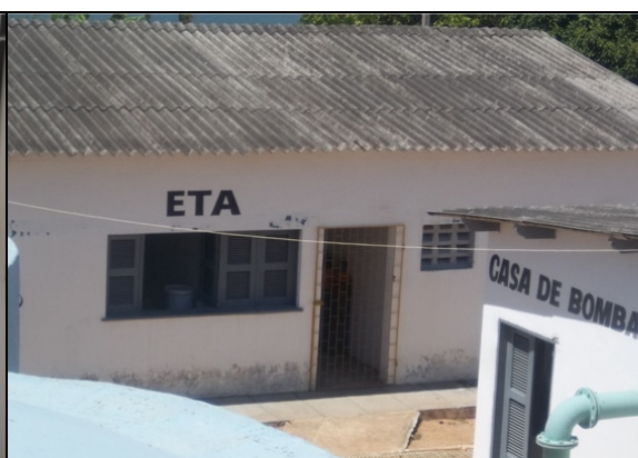
Foto 25 – Prédio de abrigo do quadro da EE-01.
