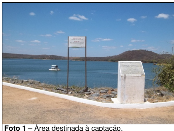
Foto 1 – Área destinada à captação.
