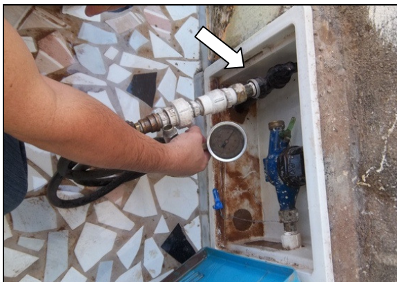
Foto 80 – Medição de pressão sem hidrômetro, na Rua Manoel Dantas, 198 - Dona Rosinha.
