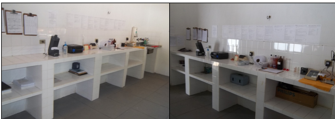
Fotos 15 e 16 – Vistas do laboratório da ETA.
