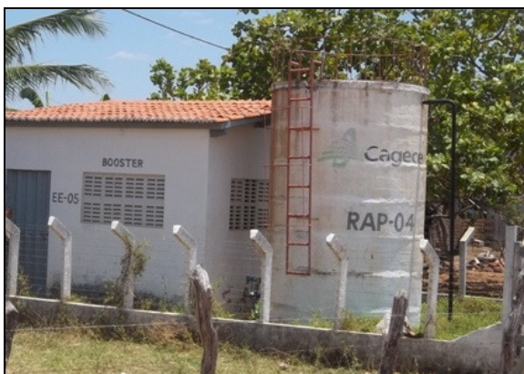
Foto 52 – Cerca de proteção e escada de acesso do RAP-04.
