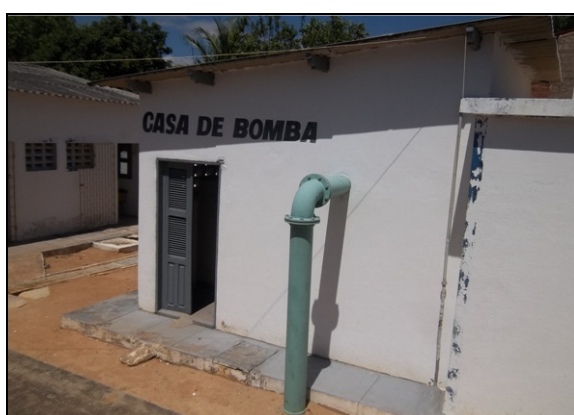
Foto 28 – Prédio de abrigo dos quadros da EE-02.
