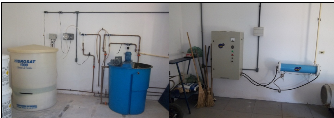
Fotos 9 e 10 – Fábrica de cloro inativa.
