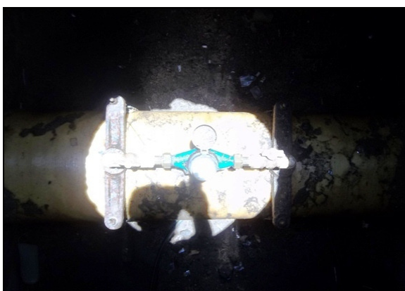
Foto 67 – Medidor proporcional de água tratada na entrada do RAP-02.
