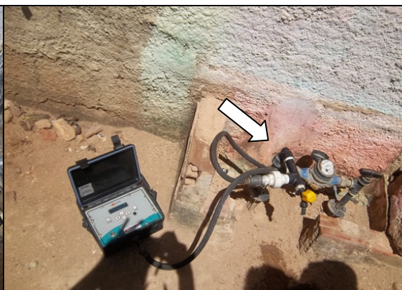
Foto 79 – Medição de pressão sem hidrômetro, na Rua Inácio Gonçalves da Costa, 37 - Centro.
