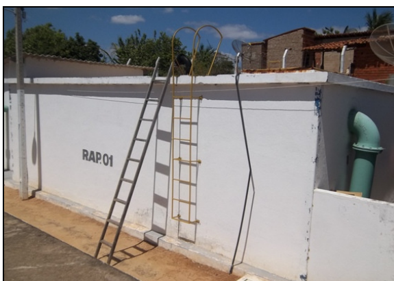
Foto 45 – Escada de acesso do RAP-01.
