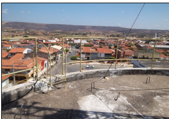
Foto 57 – Escada de acesso e guarda-corpo do REL-01.
