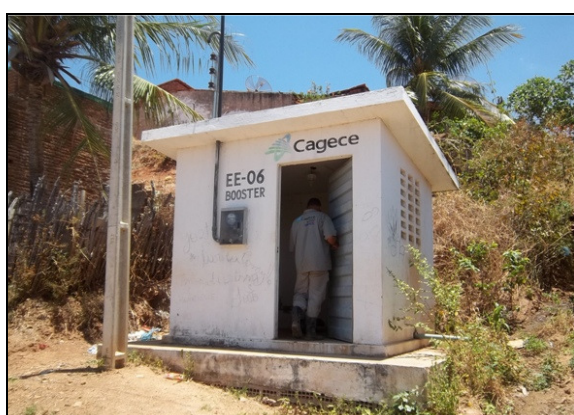
Foto 42 – Prédio de abrigo do quadro da EE-06.
