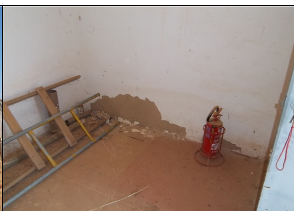
Foto 36 – Extintor de incêndio da EE-04.
