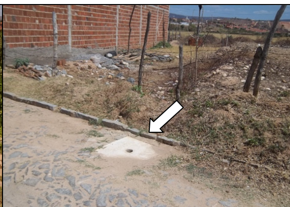
Foto 74 – Registro de descarga localizada na Rua Sérgio Pontes, Betânia.
