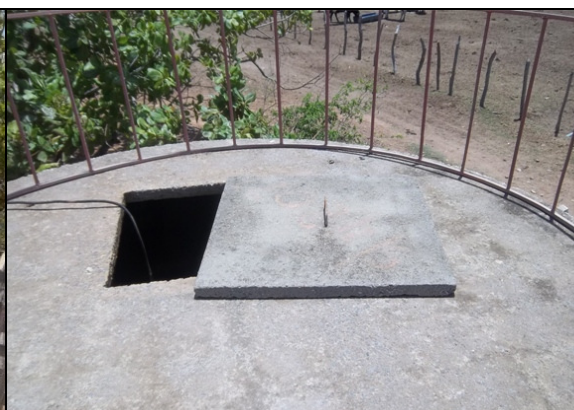
Foto 53 – Tampa de inspeção e guarda-corpo do RAP-04.
