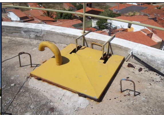
Foto 56 – Tampa de inspeção e tubulação de ventilação do REL-01.
