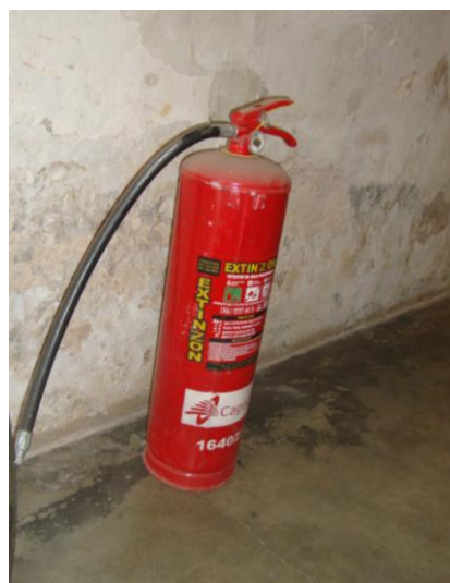
Foto 160 – Extintor de incêndio do almoxarifado com validade até jun/2017.
