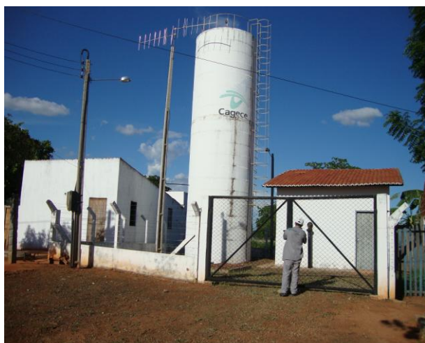
Foto 73 – Vista externa da casa de abrigo da EEAT-03 e do QC.
