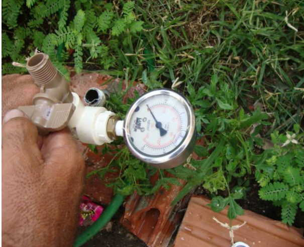
Foto 106 – Medição de pressão na Rua Maia Alarcon, nº 573.
