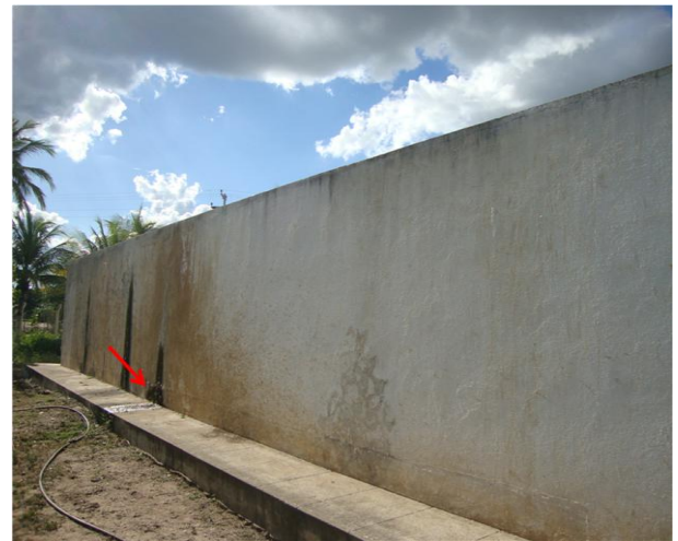
Foto 10 – Vista frontal do floco-decantador com vazamento.
