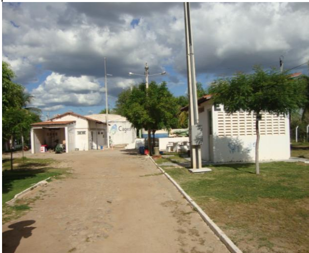
Foto 9 – Vista interna da ETA.
