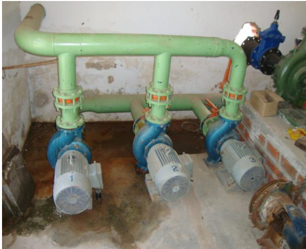
Foto 53 – Conjunto motor-bomba da EELF-01.
