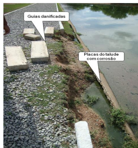
Foto 143 – Guias danificadas e placa do talude com corrosão.
