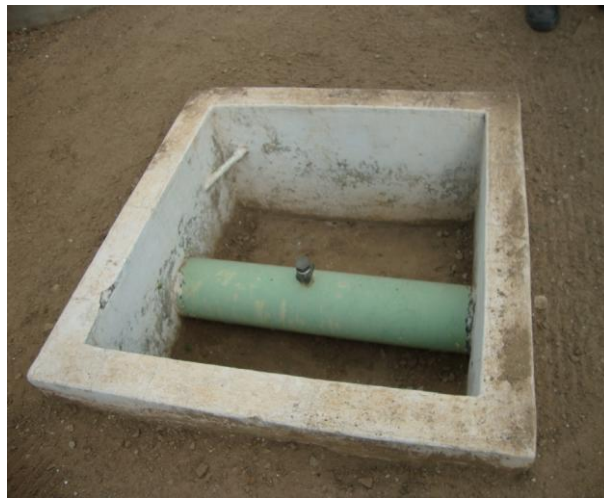
Foto 44 – Caixa de inspeção com estação pitométrica de água tratada.
