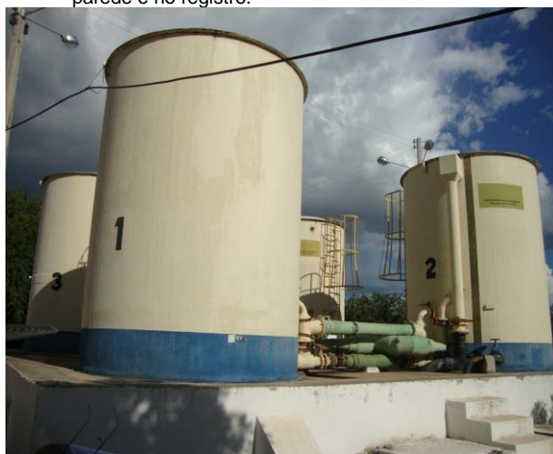
Foto 15 – Vista frontal dos filtros de fluxo ascendente 1 e 2.
