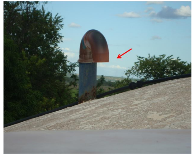
Foto 80 – RAP-01: Tubulação de ventilação sem tela de proteção.
