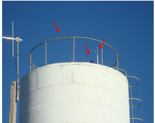
Foto 96 – REL-04 com existência de guarda-corpo na laje, para-raios e sinalizador noturno.
