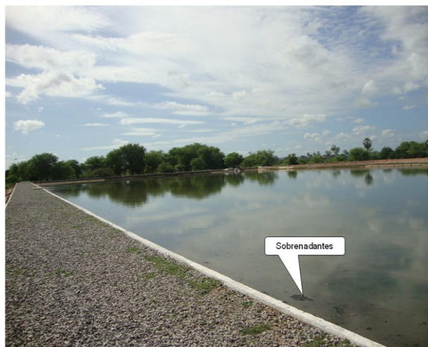
Foto 144 – Ocorrência de sobrenadante na lagoa facultativa.
