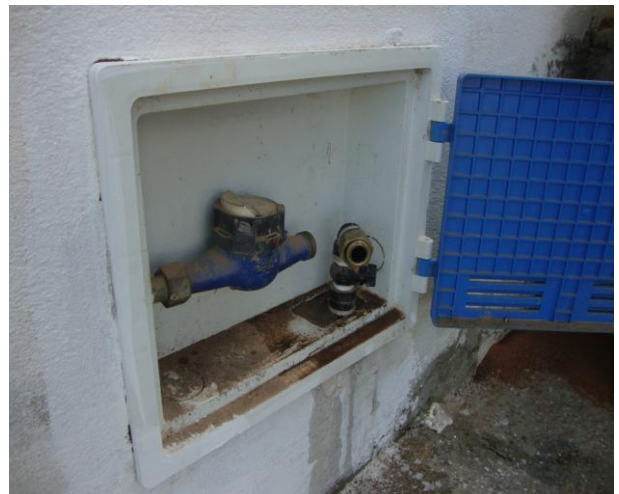
Foto 111 – Medição de pressão na Rua Zitimir Chaves, nº 3.666.
