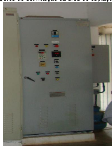
Foto 6 – Quadro de comando da captação superficial.
