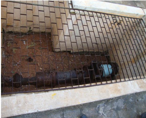
Foto 89 – Caixa de inspeção da estação pitométrica.
