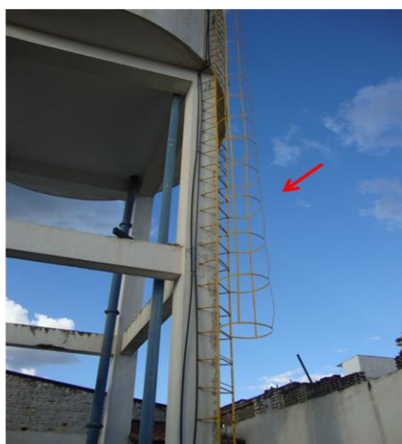
Foto 86 – Escada de acesso com guarda-corpo do REL-01.
