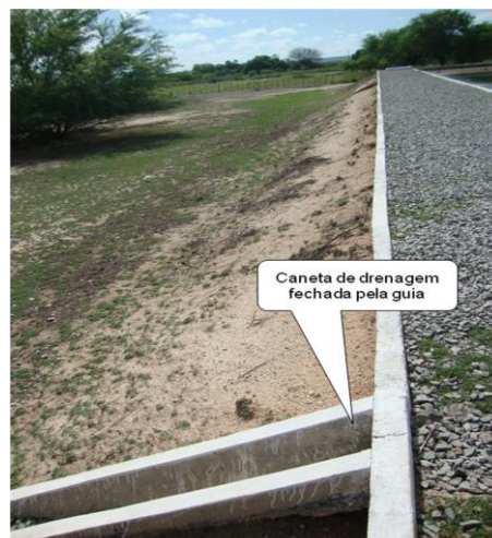
Foto 145 – Caneleta fechada pela guia.
