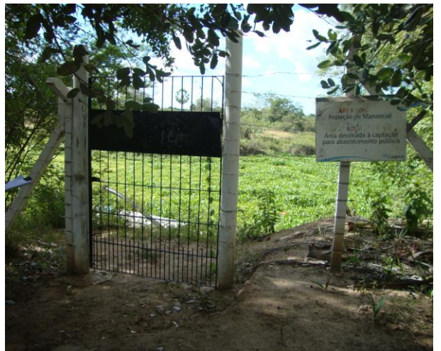
Foto 4 – Cerca de delimitação da área de captação
