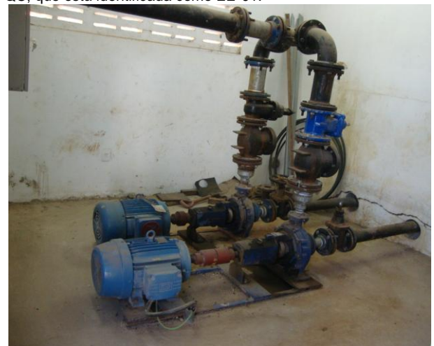
Foto 58 – Conjunto motor-bomba da EEAT-02.
