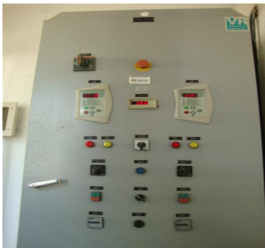
Foto 49 – Quadro de comando da EEAB-01.
