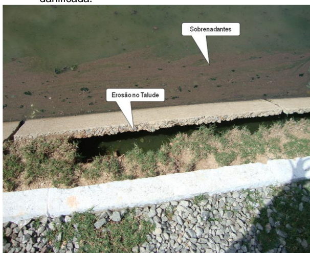
Foto 142 – Erosão no talude e ocorrência de sobrenadante na lagoa facultativa.
