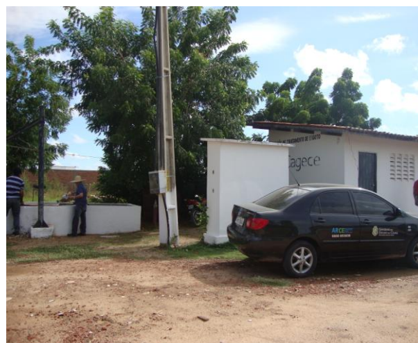
Foto 129 – Vista interna da ETE.
