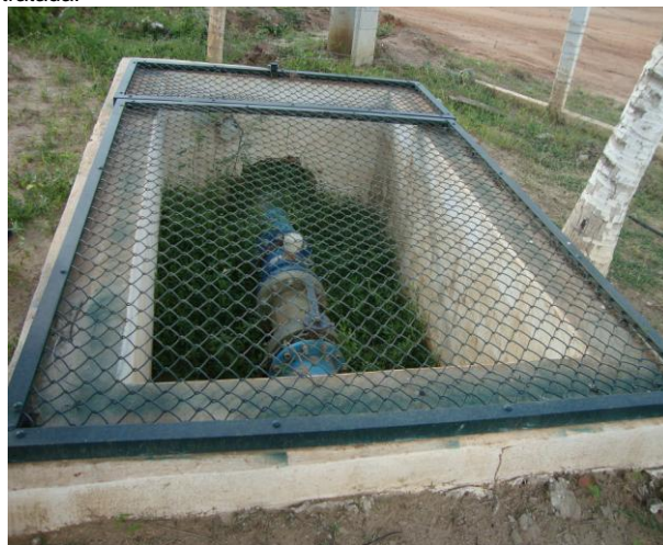
Foto 46 – Caixa de inspeção com medidor eletromagnético de água tratada.
