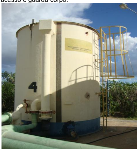
Foto 23 – Vista do filtro-04 com escada de acesso e guarda-corpo.
