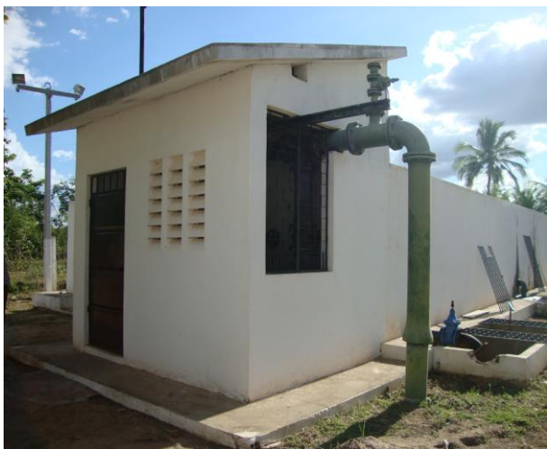
Foto 47 – Vista da casa de abrigo da EEAB-01 e do QC.
