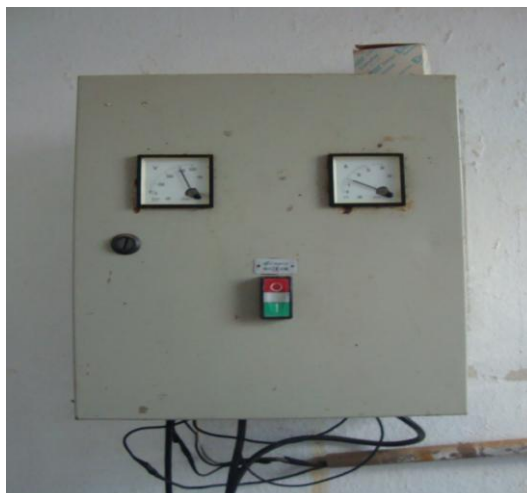
Foto 72 – Quadro de comando do booster-02 .
