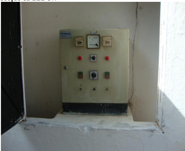
Foto 125 – Quadro de controle automatizado.
