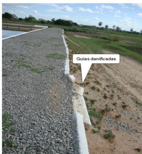
Foto 146 – Caneleta fechada pela guia.
