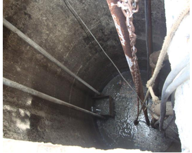
Foto 122 – Acúmulo de sólidos no poço de sucção da EEE-01.
