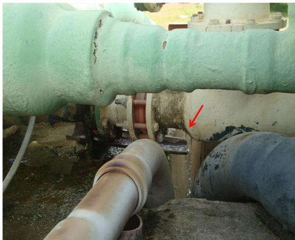
Foto 25 – Vazamento no registro dos filtros.
