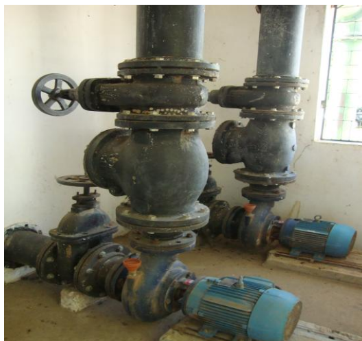
Foto 48 – Conjunto motor-bomba da EEAB-01.
