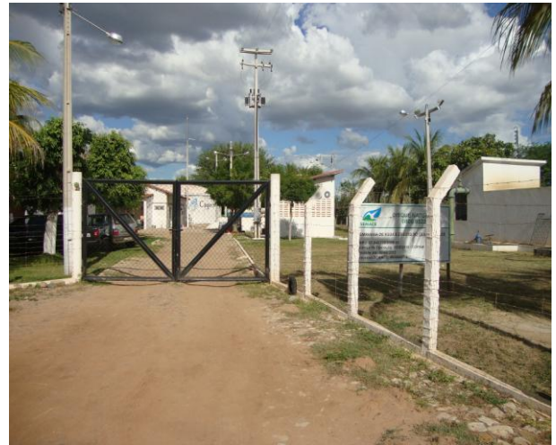
Foto 8 – Vista externa da ETA.
