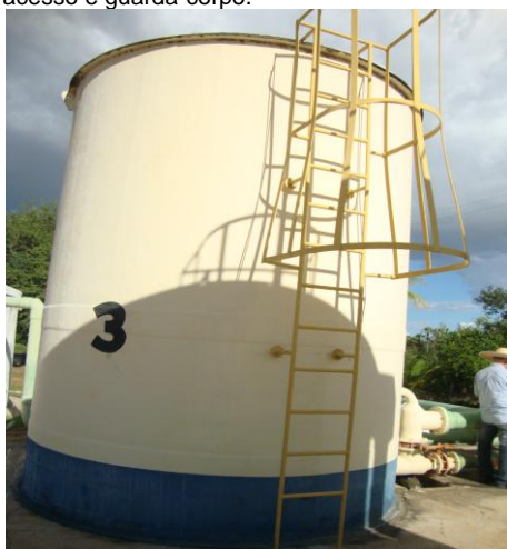
Foto 21 – Vista do filtro-03 com escada de acesso e guarda-corpo.
