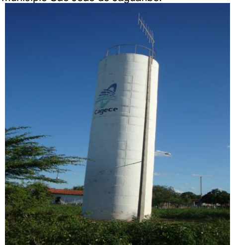
Foto 94 – REL-04, que abastece a localidade Sítio Chanercas, localizados no município São João do Jaguaribe.
