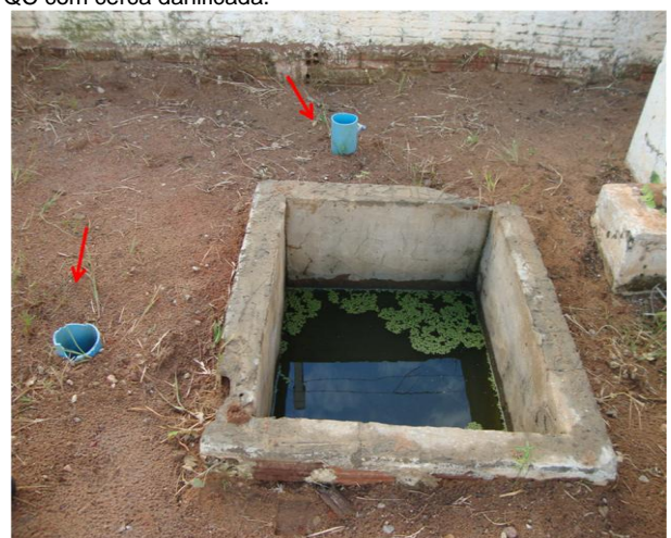
Foto 70 – Caixa de inspeção com ventosas próximas ao booster-02 .
