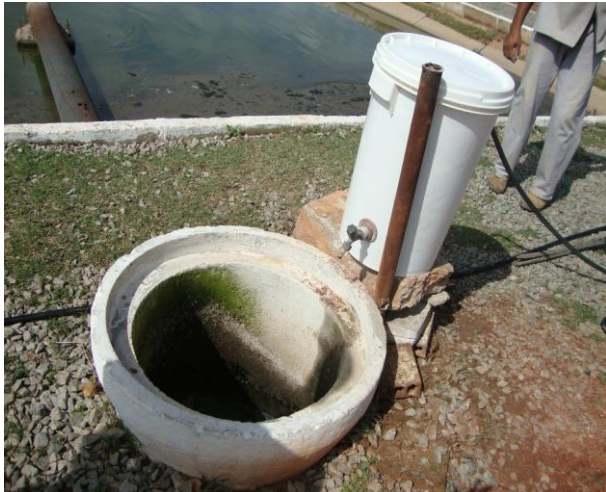
Foto 138 – Poço de recepção de esgoto na lagoa facultativa, sem tampa.
