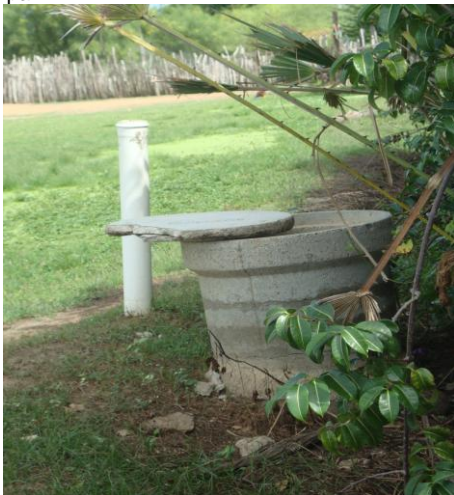
Foto 140 – Poço de saída com tampa danificada.
