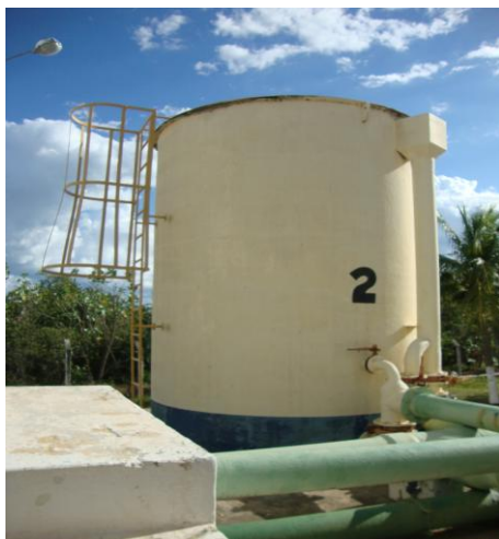
Foto 19 – Vista do filtro-02 com escada de acesso e guarda-corpo.
