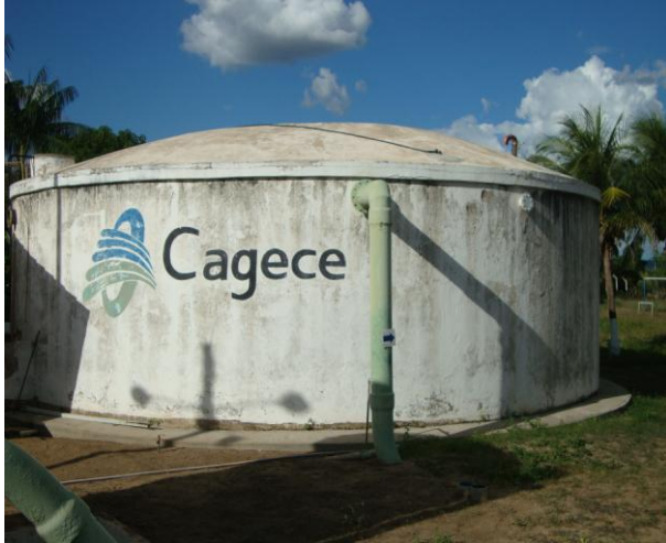
Foto 77 – Vista do RAP-01, localizado na ETA.
