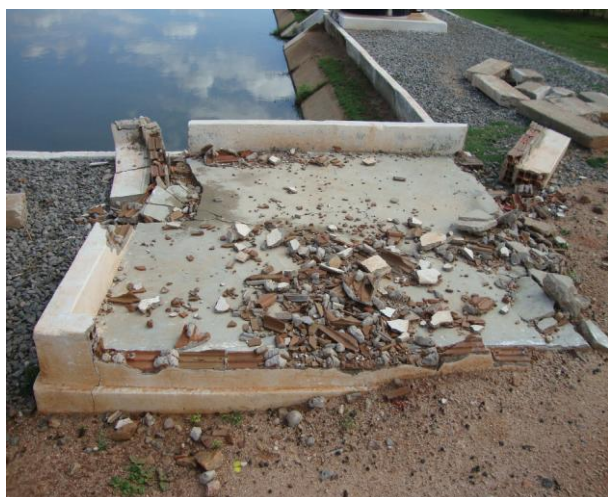
Foto 152 – Leito de secagem danificada.
