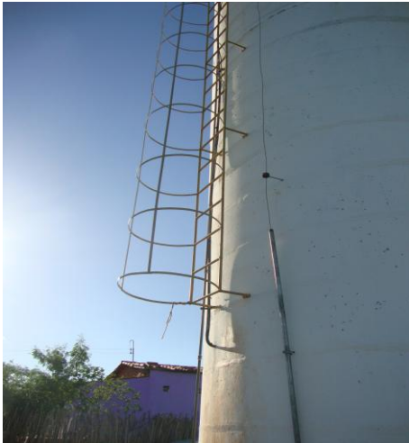
Foto 95 – REL-04, com guarda-corpo na escada.
