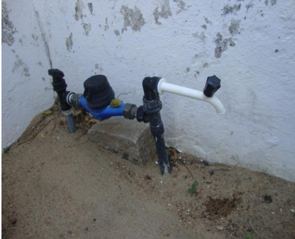
Foto 112 – Medição de pressão na Rua Antônio Torquato, nº 861.
