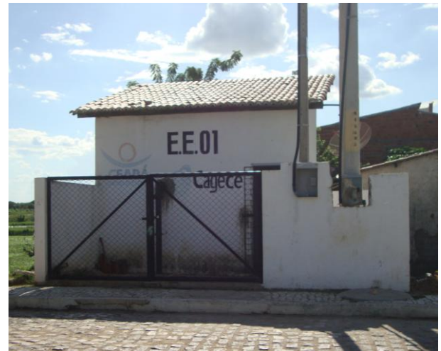
Foto 56 – Vista externa da casa de abrigo da EEAT-02 e do QC, que está identificada como EE-01.
