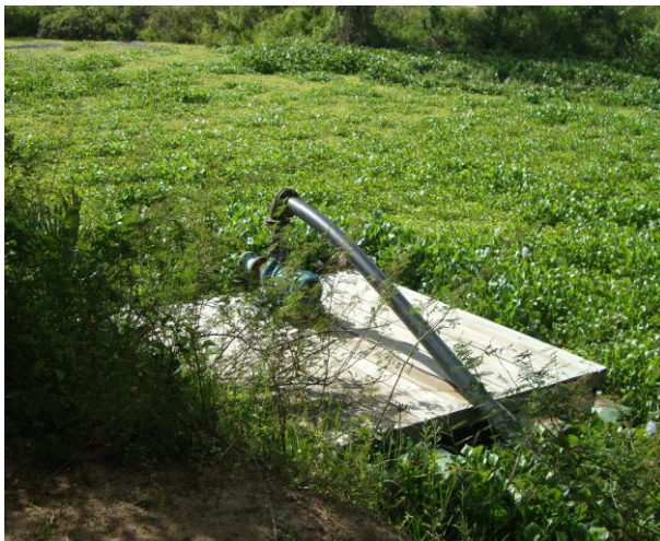
Foto 3 – Vista da captação no rio Jaguaribe.
