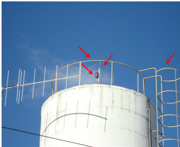
Foto 91 – REL-02 (desativado): com existência de guarda-corpo na escada e na laje, para-raios e sinalizador noturno.
