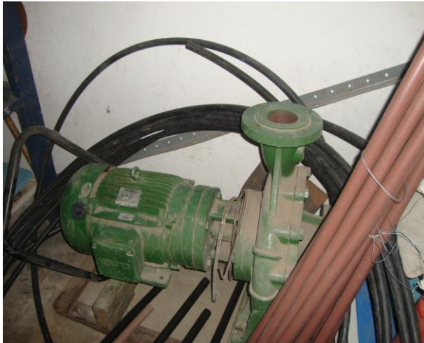
Foto 65 – Bomba reserva do booster-01 alocado no almoxarifado do escritório/loja de atendimento.
