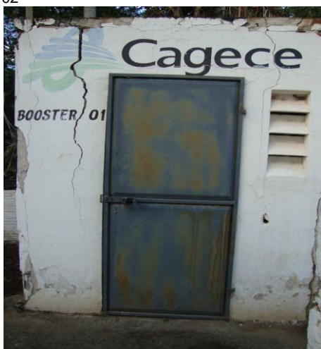
Foto 63 – Casa de abrigo da bomba e do QC do booster-01.
