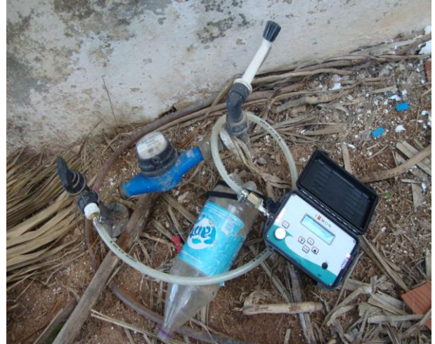
Foto 113 – Medição de pressão com instalação às 15:00h do dia 3/06/13 e retirada às 15:00h do dia 3/06/13, com aparelho datalogger na Rua José Pessoa da Silva, nº 100.
