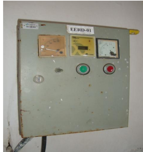
Foto 66 – Quadro de comando do booster-01 .
