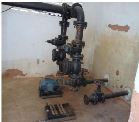
Foto 74 – Motor-bomba da EEAT-03.
