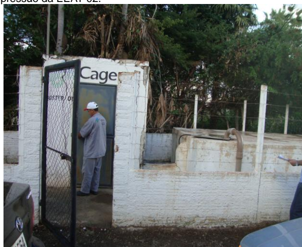
Foto 62 – Vista externa da casa de abrigo do booster-01 e do QC.
