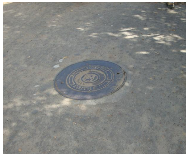
Foto 120 – PV na rua Manoel Franklin.
