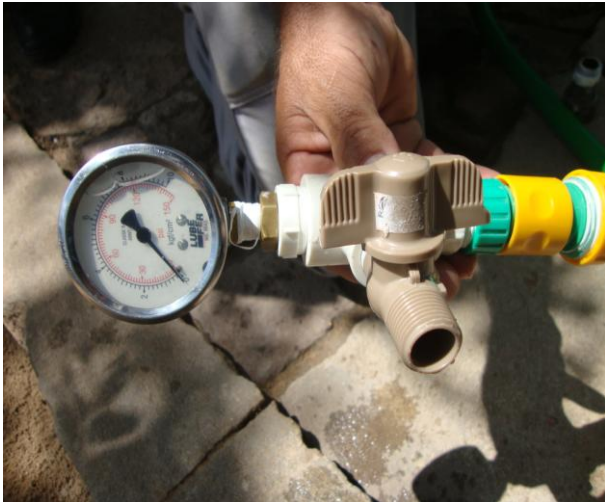
Foto 108 – Medição de pressão na Rua São José, nº 96.
