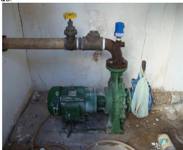
Foto 64 – Motor-bomba do booster-01.
