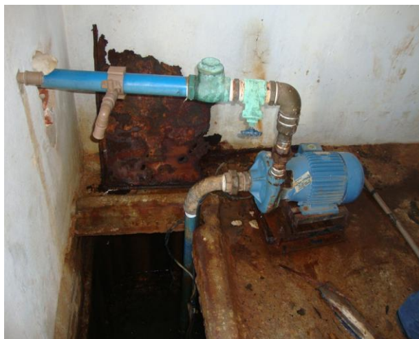
Foto 71 – Motor-bomba do booster-02 .
