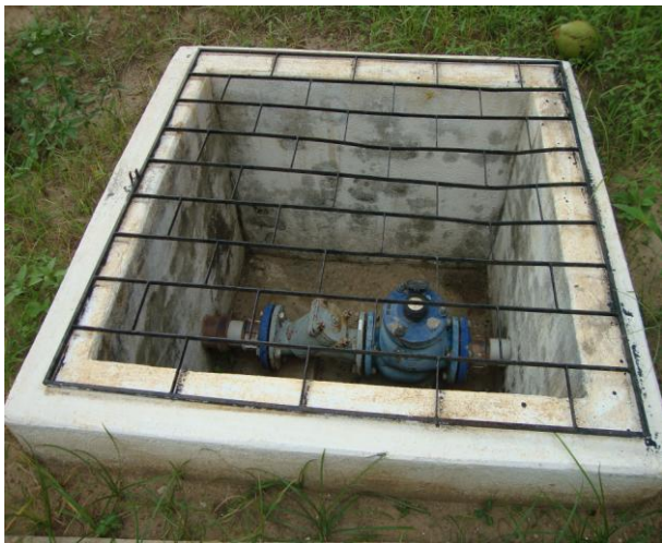
Foto 43 – Caixa de inspeção com macromedidor de água tratada.
