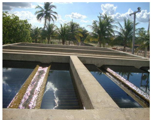
Foto 12 – Vista superior do floco-decantador.
