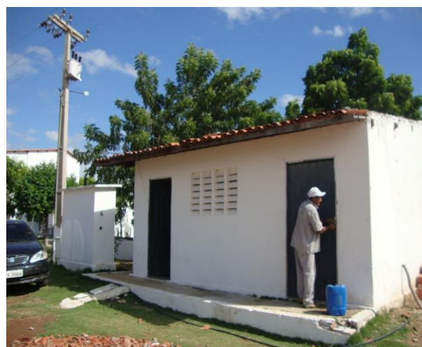
Foto 131 – Casa de apoio operacional na ETE.
