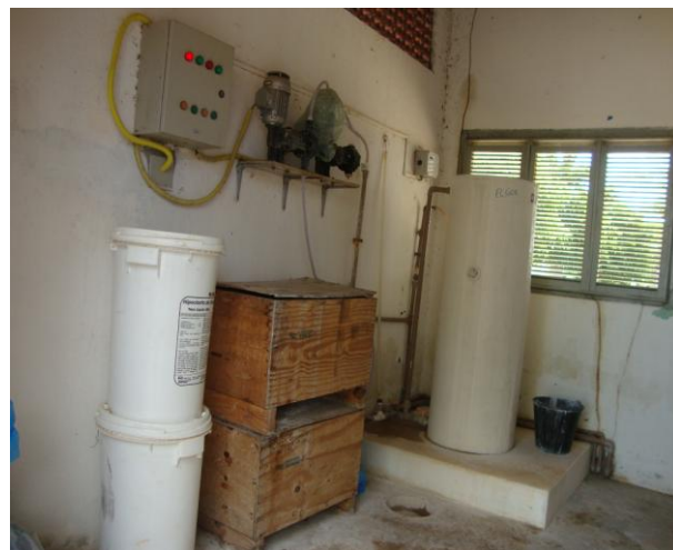
Foto 28 – Sistema de fluoretação.
