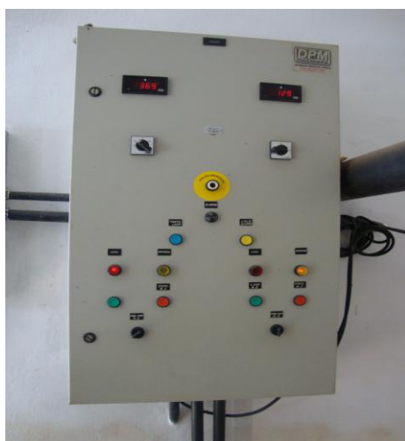
Foto 75 – Quadro de comando da EEAT-03.
