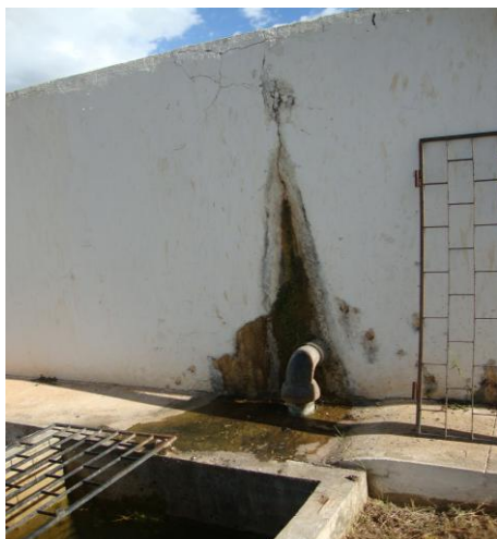
Foto 13 – Floco-decantador com vazamento na parede e no registro.
