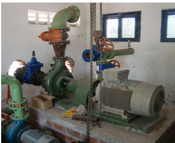
Foto 51 – Conjunto motor-bomba da EEAT-01.
