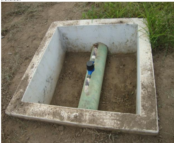
Foto 45 – Caixa de inspeção com medidor proporcional de água tratada do RAP-01.
