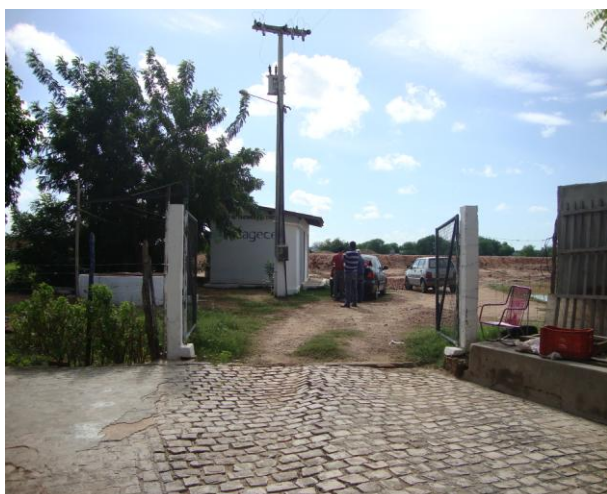
Foto 128 – Vista externa da ETE.
