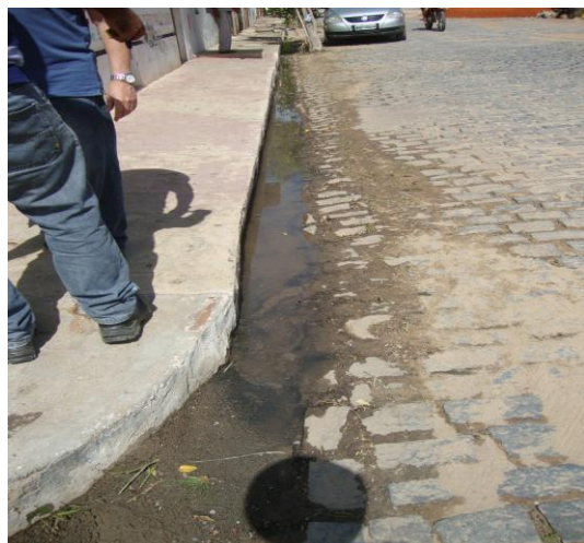
Foto 119 – Lançamento de esgoto a céu aberto em área de cobertura do sistema na rua Francisco de Almeida Chaves com Manuel Franklin.
