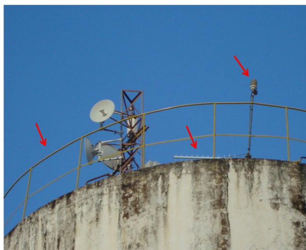
Foto 87 – REL-01: com existência de guarda-corpo na laje, para-raios e sinalizador noturno.
