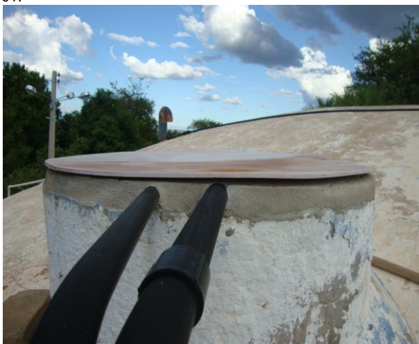
Foto 81 – RAP-01: Instalação adequada das tubulações de produtos químicos.
