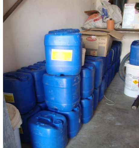
Foto 133 – Interior da casa de apoio operacional da ETE.
