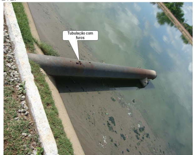
Foto 137 – Furos na tubulação de chegada do esgoto bruto na lagoa facultativa.
