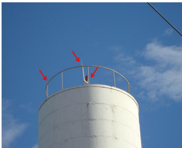
Foto 93 – REL-03 com existência de guarda-corpo na laje, para-raios e sinalizador noturno.
