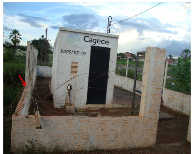
Foto 68 – Vista externa da casa de abrigo do booster-02 e do QC com cerca danificada.
