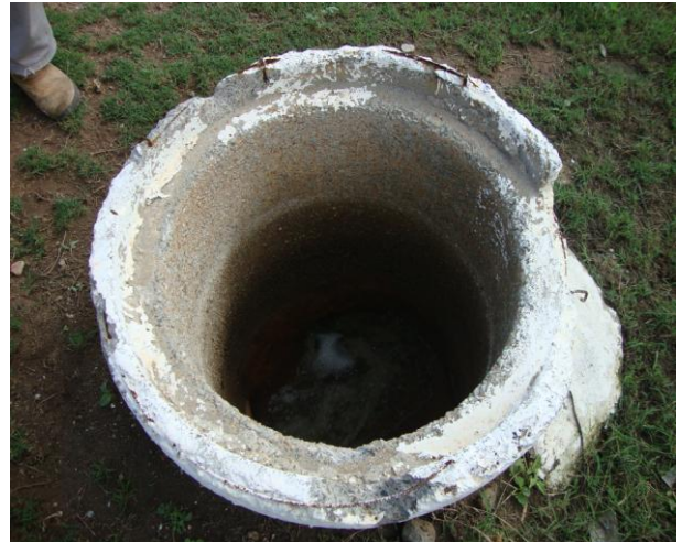
Foto 139 – Poço de saída de esgoto danificado e sem tampa.
