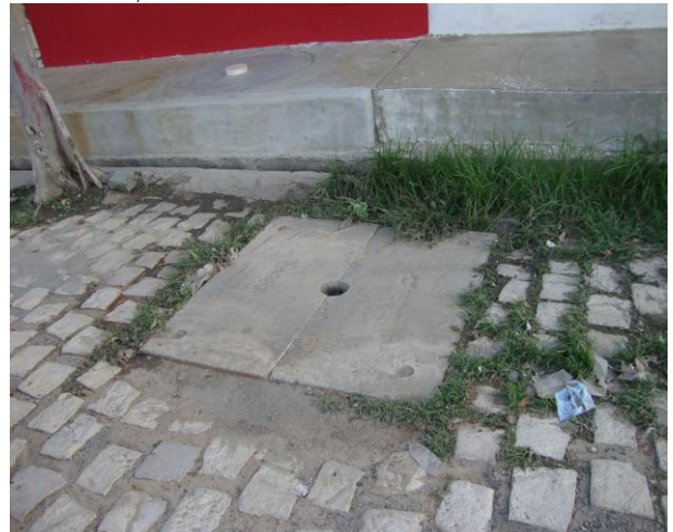
Foto 117 – Registro de descarga na Rua Hercílio Pinheiro, nº 664.
