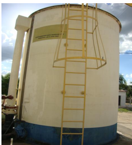
Foto 17 – Vista do filtro-01 com escada de acesso e guarda-corpo.
