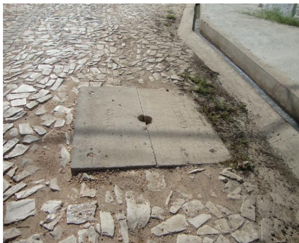
Foto 118 – Registro de descarga na Rua Manoel Tavares, s/n.
