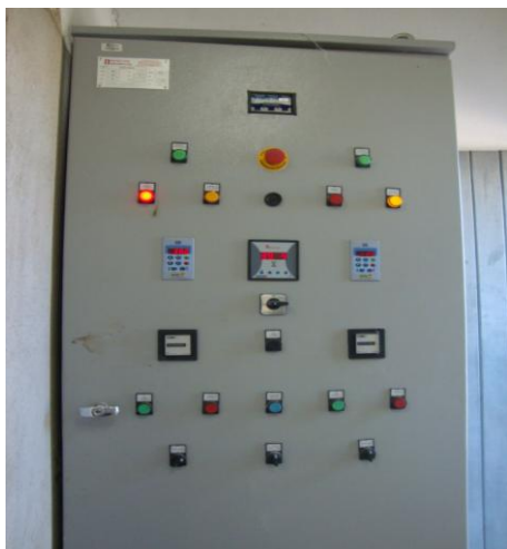
Foto 59 – Quadro de comando da EEAT-02.
