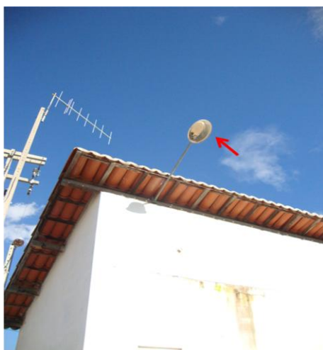
Foto 61 – Sem lâmpada na luminária da EEAT-02.
