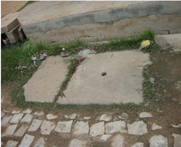
Foto 114 – Registro de descarga na Rua Manoel Franklin, nº 5.162.
