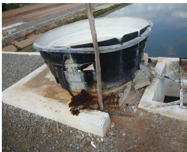
Foto 148 – Tanque de mistura.
