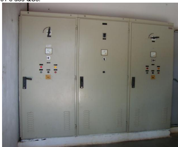
Foto 52 – Quadro de comando da EEAT-01 e da EELF-01.
