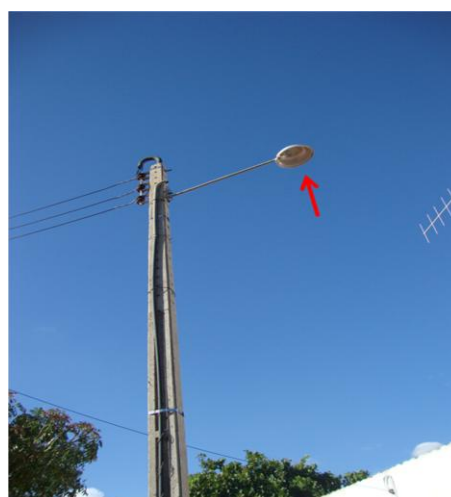
Foto 76 – Sem lâmpada na luminária da EEAT-03
