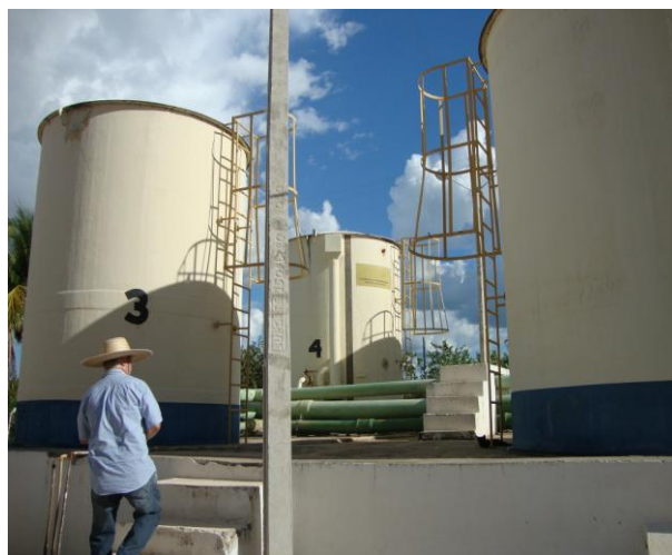
Foto 16 – Vista frontal dos filtros de fluxo ascendente 3 e 4.
