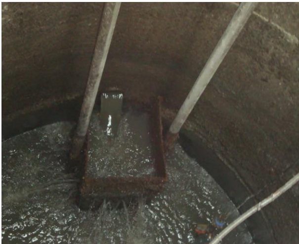
Foto 123 – Gradeamento com cesto quebrado no poço de sucção da EEE-01.
