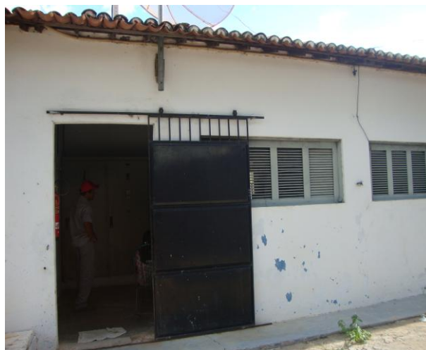
Foto 50 – Vista externa da casa de abrigo da EEAT-01, EELF-01 e dos QCs.
