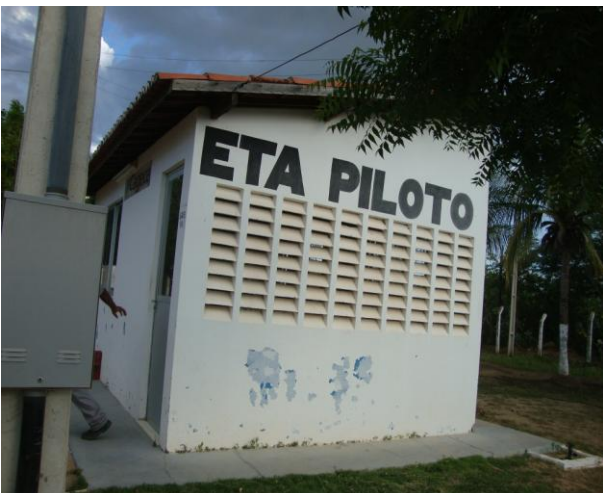
Foto 41 – ETA piloto desativada no interior da ETA de Tabuleiro do Norte.
