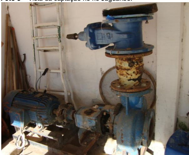
Foto 5 – Bomba reserva da captação superficial.
