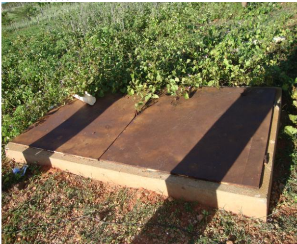
Foto 97 – Caixa de inspeção com registro do REL-04.
