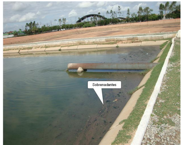
Foto 141 – Ocorrência de sobrenadante na lagoa facultativa.
