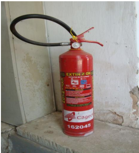
Foto 55 – Extintor de incêndio das EEAT-01 e EELF-01 com validade até set/13.
