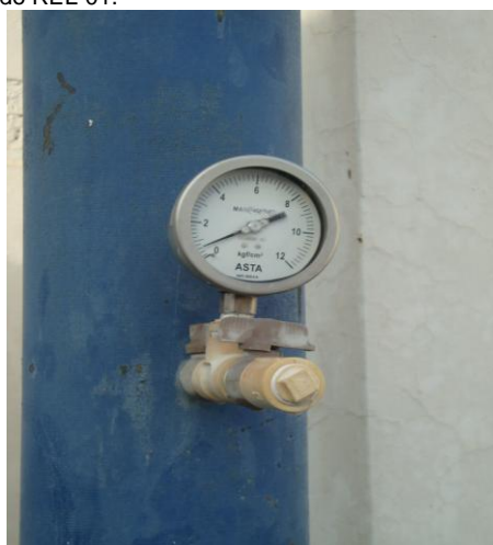
Foto 88 – Medidor de nível do REL-01.
