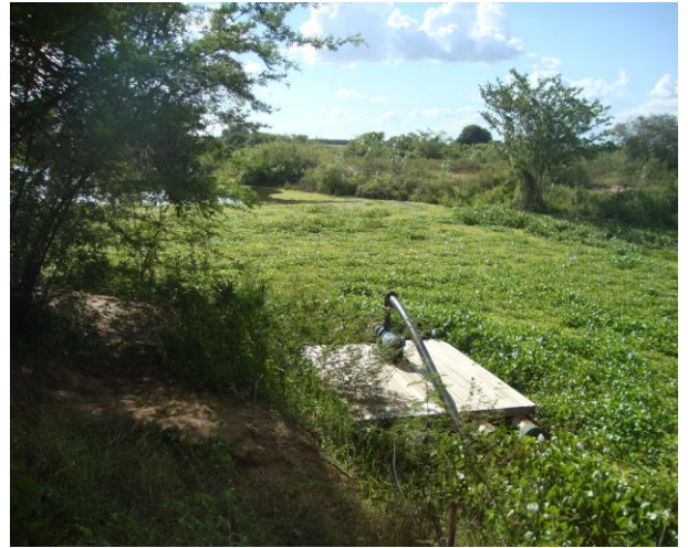
Foto 2 – Vista da captação no rio Jaguaribe.
