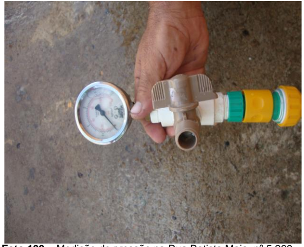
Foto 109 – Medição de pressão na Rua Batista Maia, nº 5.269.
