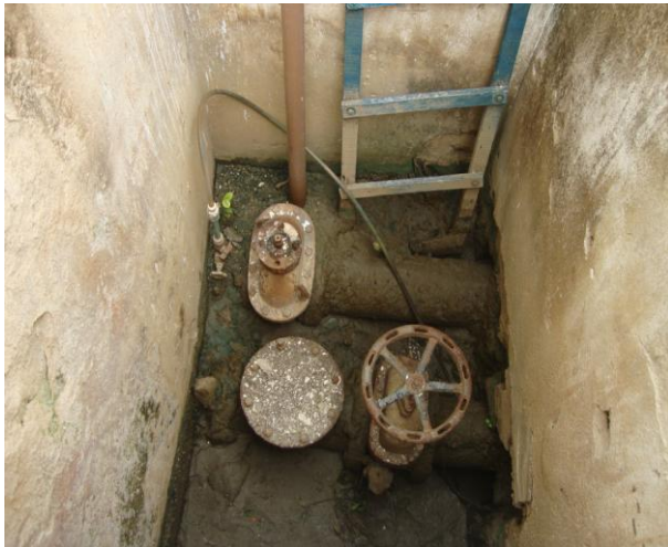
Foto 79 – Ventosa e registro de descarga próxima ao RAP-01.
