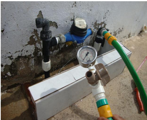
Foto 110 – Medição de pressão na Rua Manoel Guerreiro, nº 4.772.
