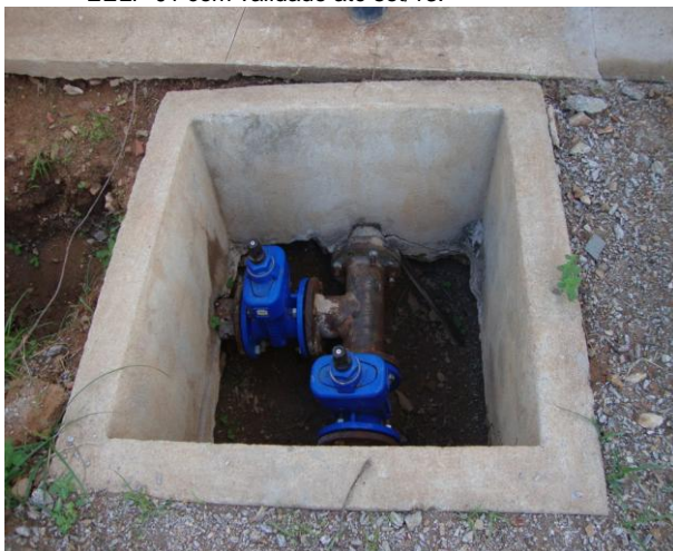
Foto 57 – Caixa de inspeção com ventosas próximas a EEAT-02.
