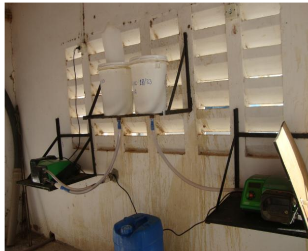
Foto 26 – Casa de química com dosador de cloro.
