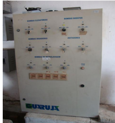
Foto 54 – Quadro de comando da EELF-01.
