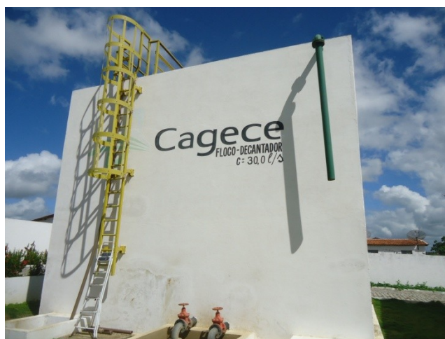
Foto 10 – Floco-decantador.
