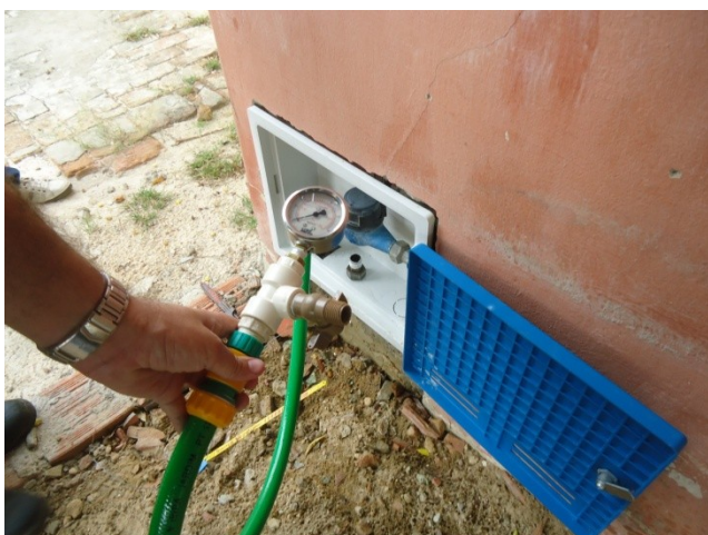
Foto 47 – Medição instantânea – R. Pedro Rodrigues Severiano, 369.
