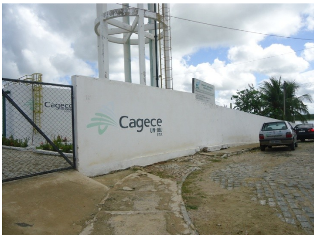
Foto 7 – Entrada da ETA.
