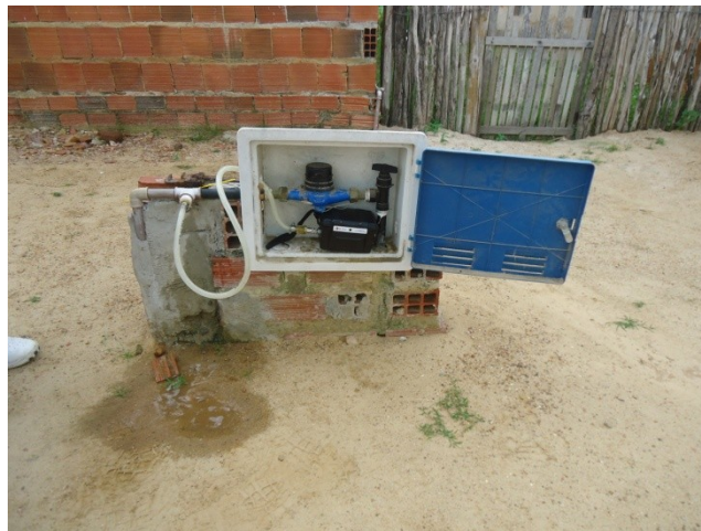
Foto 50 – Equipamento Datalogger instalado – R. Vila Nova, 59.
