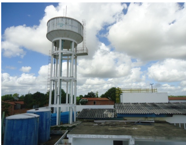
Foto 37 – Vista lateral do REL-01.
