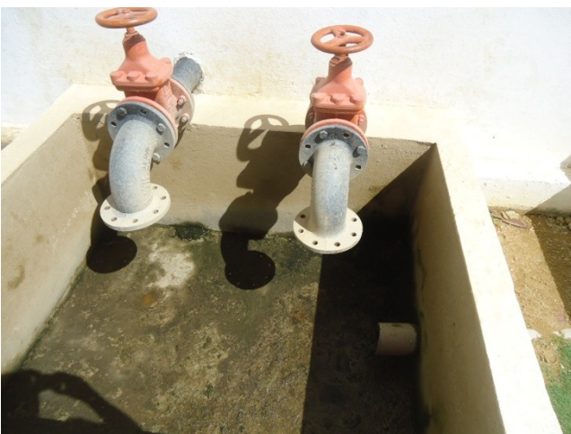
Foto 12 – Caixa de descarga do Floco-decantador sem grade de proteção.
