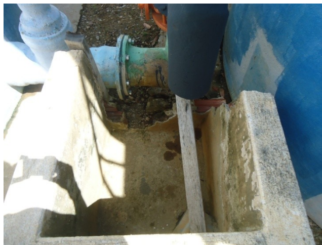
Foto 14 – Caixa de descarga do F-02 sem grade de proteção.
