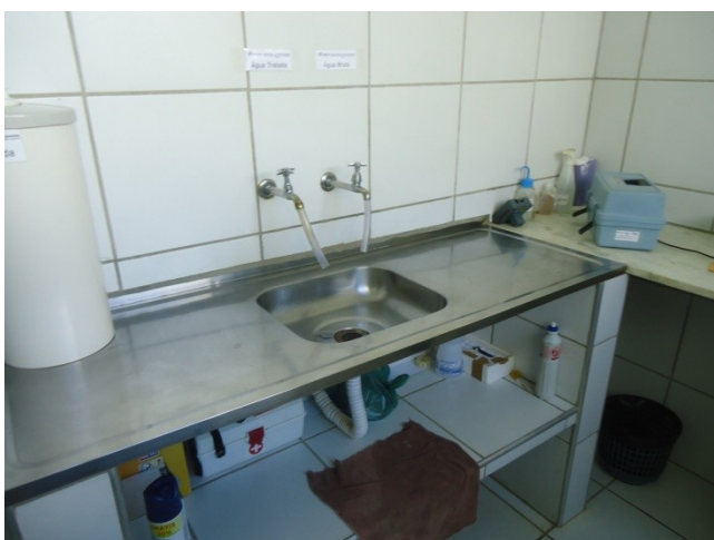
Foto 21 – Laboratório da ETA.
