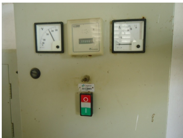
Foto 29 – Quadro de comando EEAT-01.
