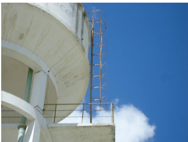
Foto 39 – Escadas de acesso enferrujadas.
