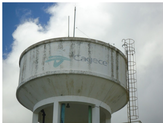
Foto 40 – Pintura deteriorada e ausência de sinalizador no REL-01.
