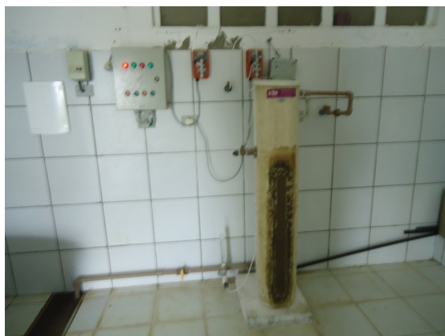
Foto 16 – Dosador de flúor.
