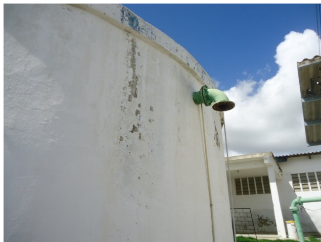
Foto 32 – Vista lateral RAP-02
