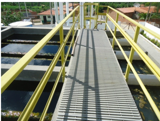
Foto 11 – Passarelas com guarda-corpo de proteção.
