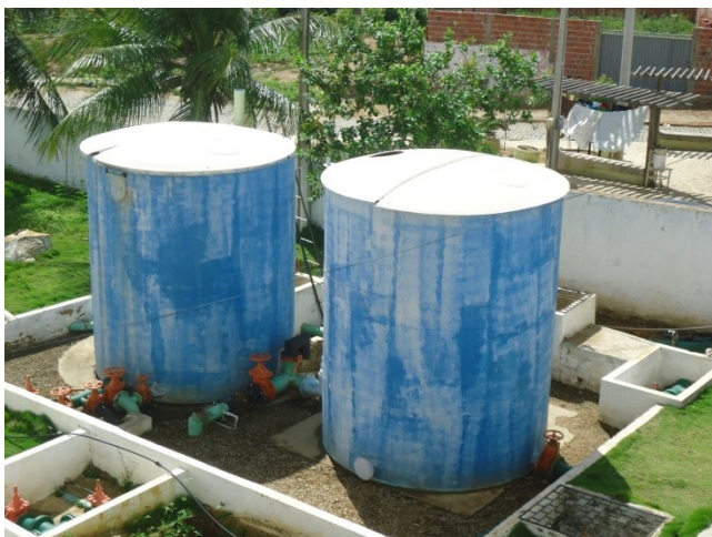
Foto 13 – Vista dos filtros F-01 e F-02.
