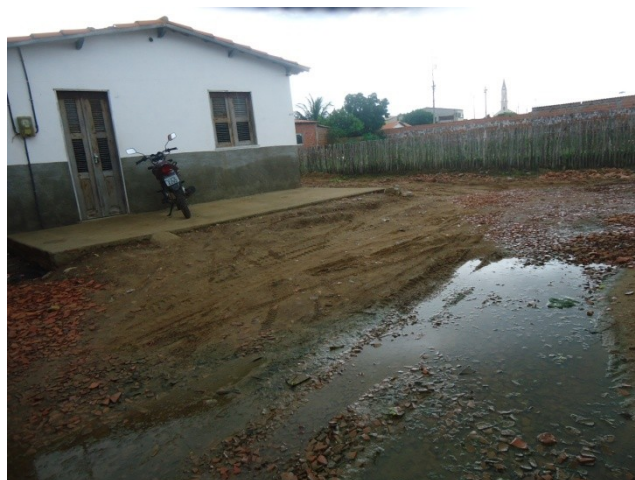
Foto 44 – Registro de Descarga soterrado – Rua 106, 366 – COHAB.
