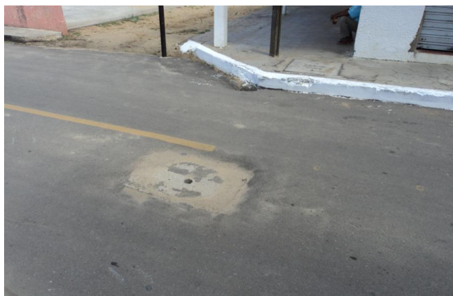
Foto 55 – Registro de descarga na Rua 7 de setembro.
