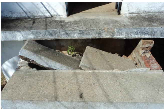
Foto 11 – PA: escada deteriorada.
