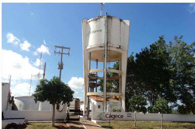
Foto 15 – ETA: área de acesso e identificação.
