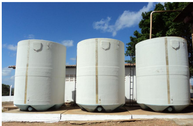
Foto 19 – Filtros: vista geral e ausência de identificação.
