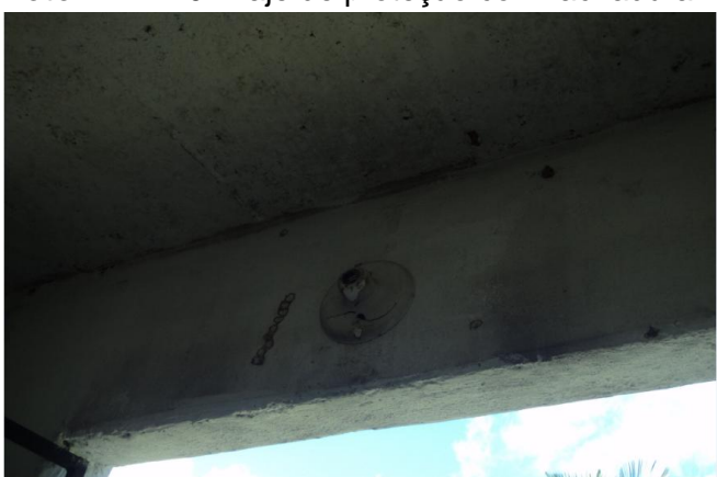
Foto 9 – PT-02: ausência de iluminação interna.
