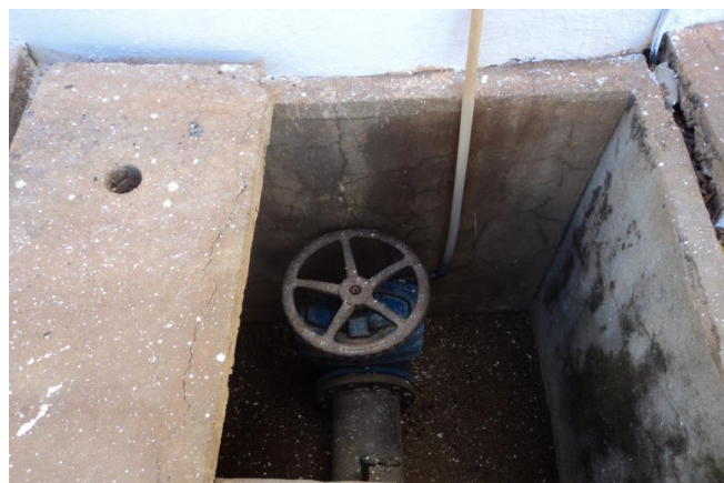
Foto 50 – RAP-01: caixa do registro sem grade de proteção.
