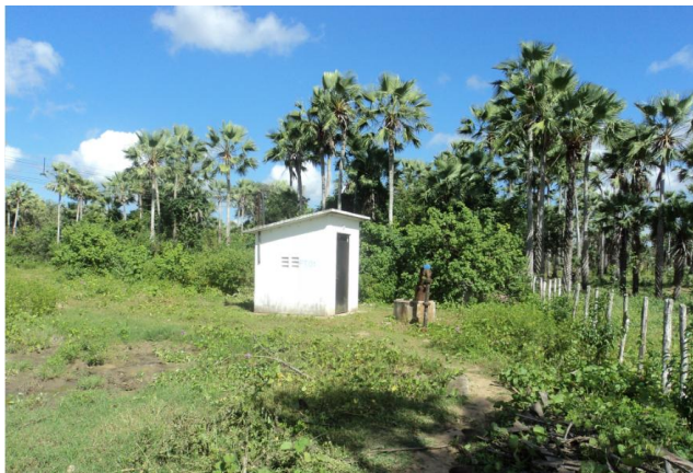
Foto 1 – PT-01: área de acesso e ausência de iluminação para trabalhos noturnos.
