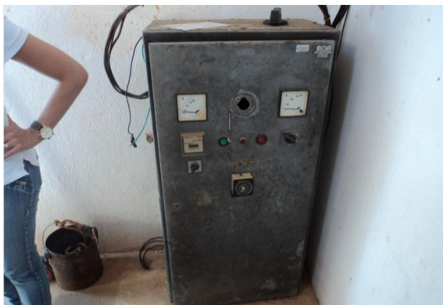
Foto 13 – PA: quadro de comando.
