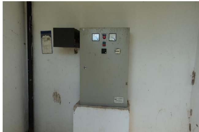
Foto 4 – PT-01: quadro de comando.
