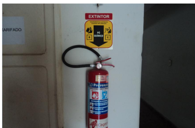
Foto 74 – Loja de atendimento: extintor de incêndio.
