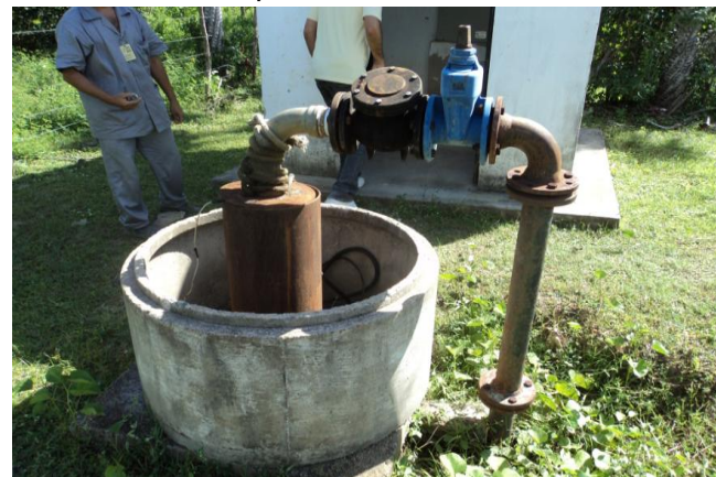
Foto 6 – PT-02: laje de proteção.
