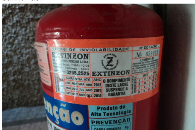
Foto 75 – Loja de atendimento: extintor dentro do prazo de validade.
