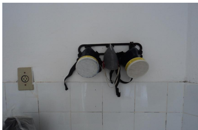
Foto 30 – Casa de química: ausência de máscara de proteção de cloro gasoso.
