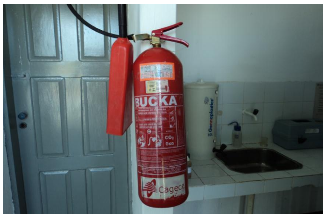
Foto 31 – Laboratório: extintor de incêndio.
