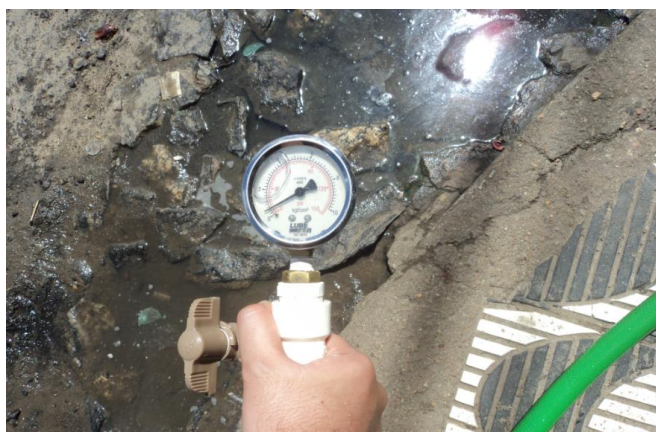
Foto 66 – Medição instantânea de pressão na Rua 30 de julho, 621.
