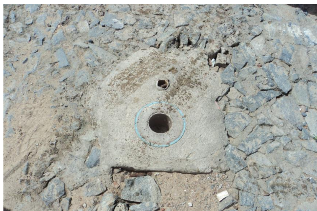
Foto 56 – Registro de descarga na Rua José Maria Farias.
