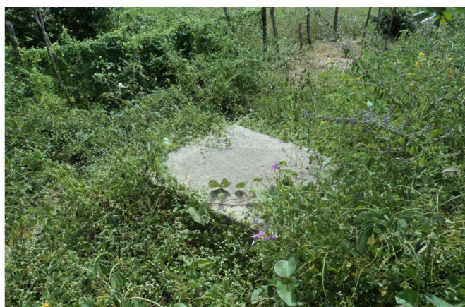
Foto 35 – Adutora: registro de descarga com área coberta por vegetação.
