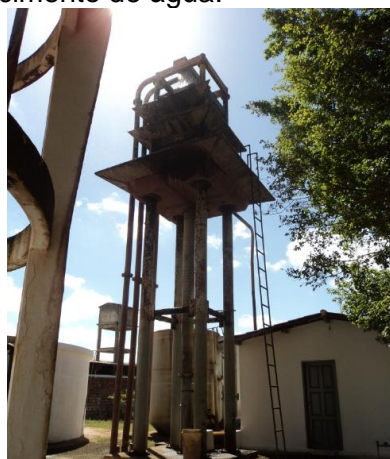
Foto 18 – Aerador: escada sem guarda-corpo.
