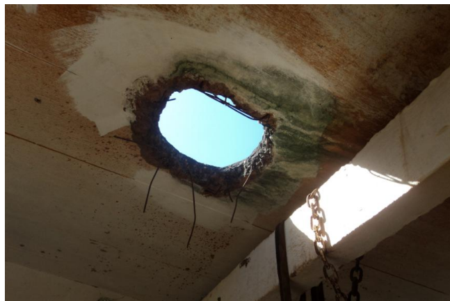
Foto 14 – PA: abertura na laje superior.
