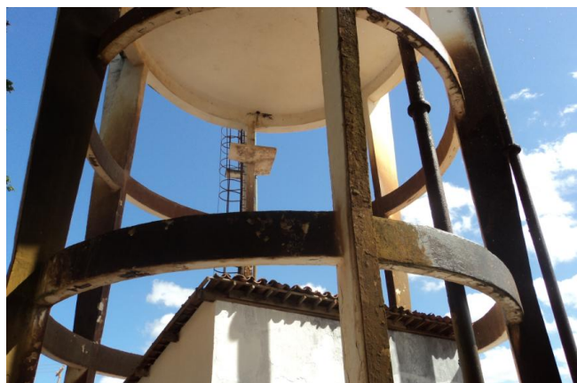
Foto 44 – REL-01: pintura deteriorada.
