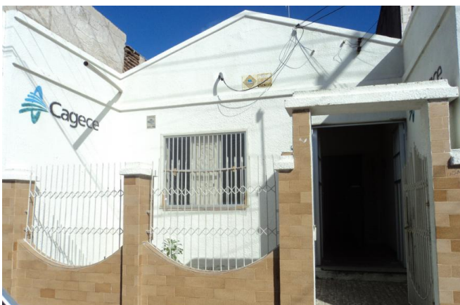
Foto 70 – Loja de atendimento: vista externa.
