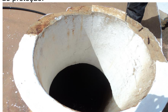
Foto 52 – RAP-01: ausência de tampa de inspeção.
