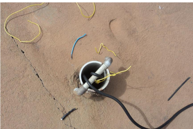
Foto 53 – RAP-01: tubulação de ventilação inadequada.
