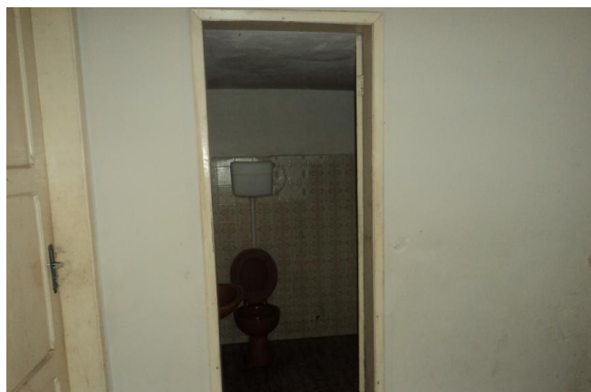
Foto 73 – Loja de atendimento: instalações sanitárias.
