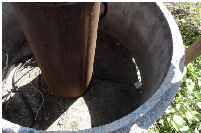
Foto 7 – PT-02: laje de proteção com rachadura.
