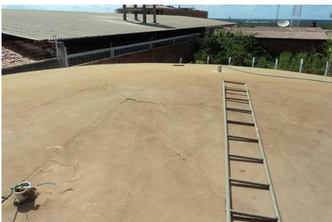
Foto 51 – RAP-01: cobertura do reservatório.
