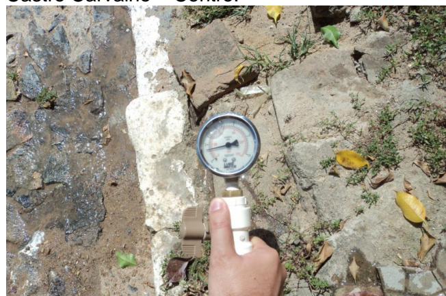
Foto 65 – Medição instantânea de pressão na Rua Governador Raul Barbosa, nº1222.
