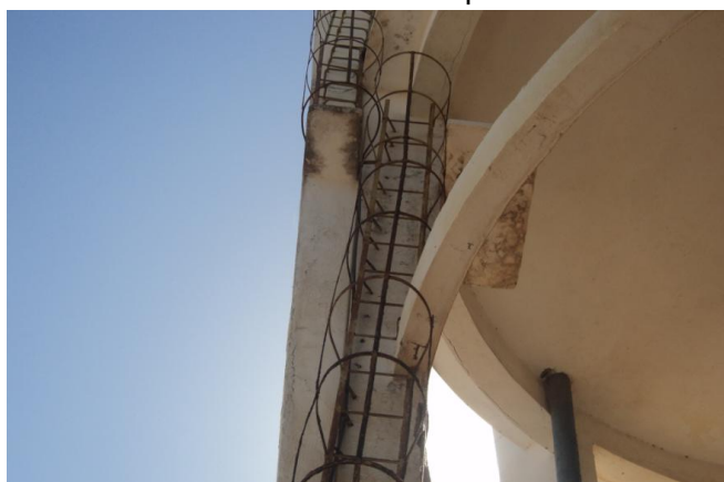
Foto 47 – REL-01: escada e guarda-corpo em processo de corrosão.
