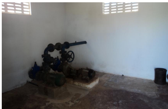
Foto 40 – EE-03: conjunto moto-bomba.
