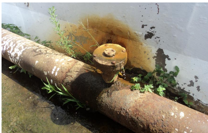
Foto 37 – Adutora: ventosa localizada na ponte do Rio Acaraú com vazamento.
