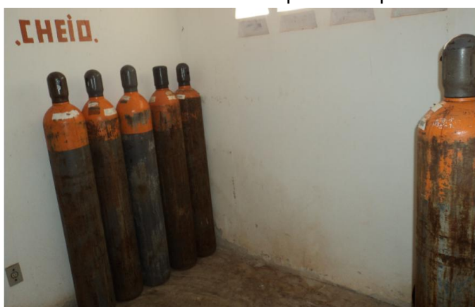
Foto 27 – Casa de química: armazenamento dos cilindros de cloro.
