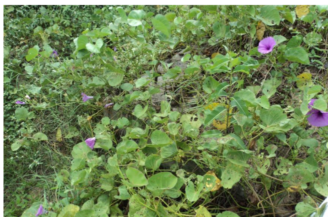
Foto 36 – Adutora: registro de descarga próximo a ponte do rio Acaraú com área coberta por vegetação.
