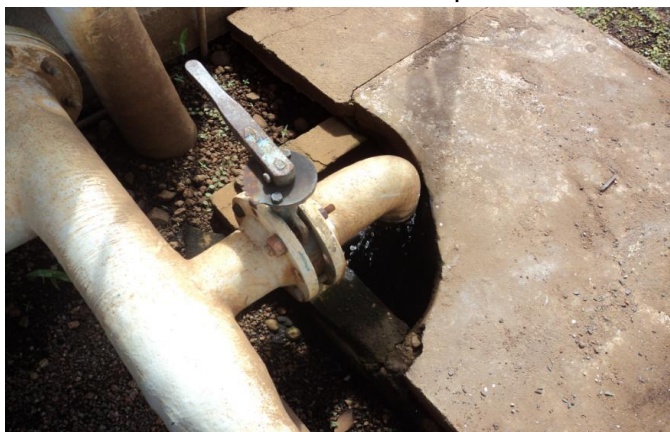
Foto 23 – Filtros: registro com problemas de vedação.
