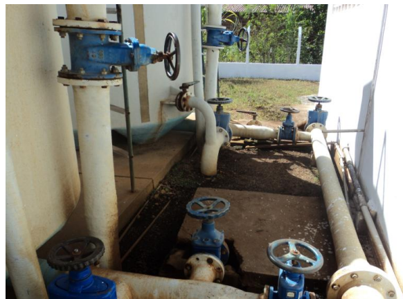
Foto 20 – Filtros: tubulações e registros.
