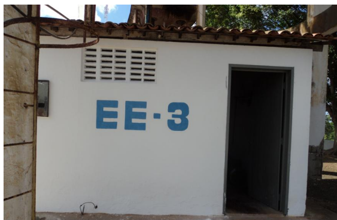
Foto 39 – EE-03: área de acesso e identificação.
