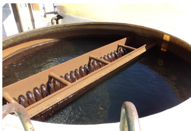
Foto 22 – Filtro-01: superfície da água filtrada.
