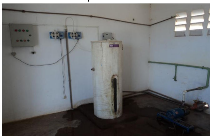
Foto 28 – Casa de química: sistema de fluoretação com vazamento.
