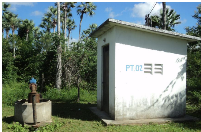
Foto 5 – PT-02: área de acesso e identificação.
