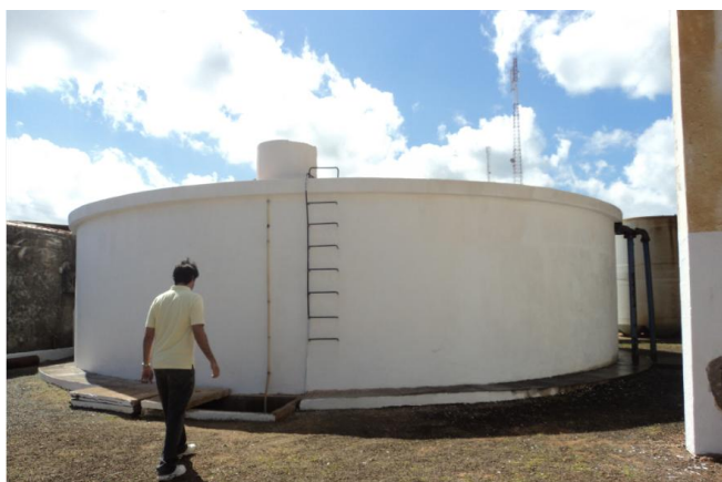
Foto 49 – RAP-01: ausência de identificação.
