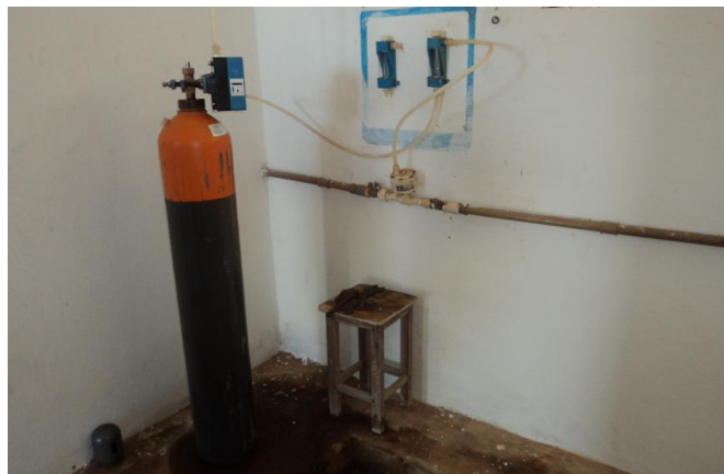
Foto 26 – Casa de química: dosador de cloro.
