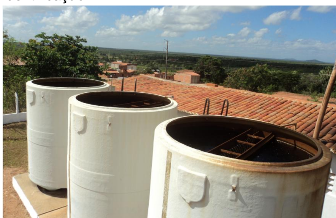
Foto 21 – Filtros: ausência de tampas.
