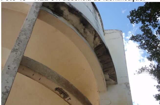
Foto 45 – REL-01: armadura exposta.
