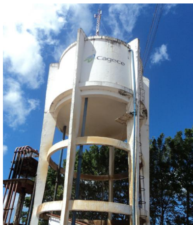
Foto 43 – REL-01: ausência de identificação.
