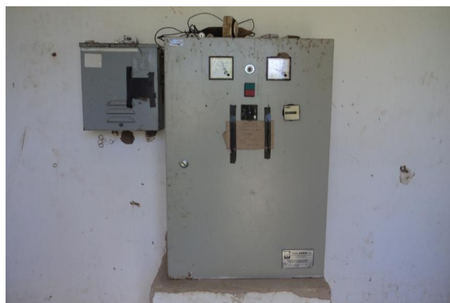
Foto 8 – PT-02: quadro de comando.
