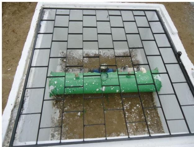
**Foto 52** – Medidor proporcional instalado na saída RAP-02 e RAP-03.
