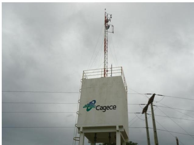
**Foto 57** – Guarda corpo da lage de cobertura, pára-raio e sinalizador noturno REL-01.
