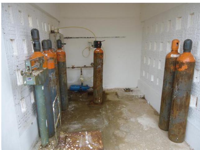
**Foto 13** – Cloro gasoso armazenado em abrigo.
