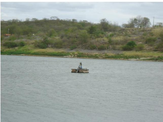
**Foto 3** - Conjunto moto-bomba instalado em flutuante.
