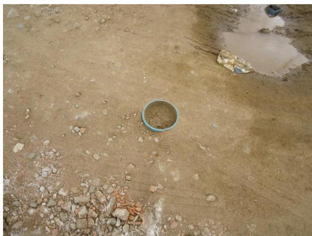
**Foto 68** - Registro de descarga na rede (sem caixa de proteção) – Rua Raimunod Moacir Mota (ao lado do colégio)
