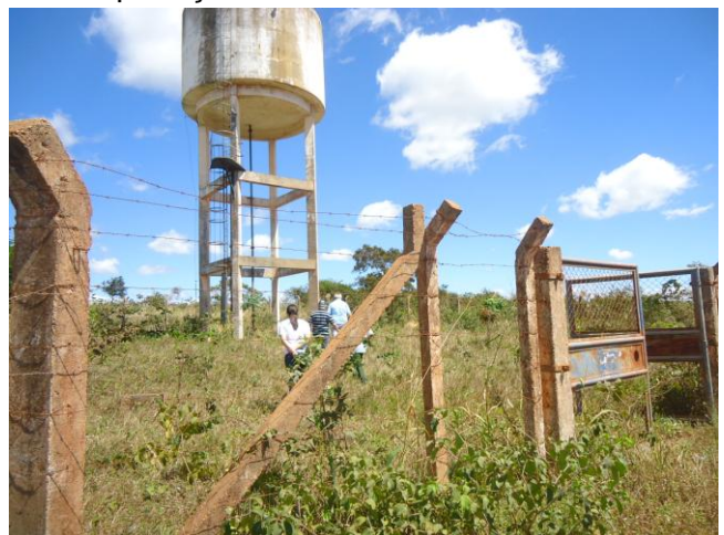
Foto 21 – REL-12 (Betânia): ausência de identificação e pintura deteriorada.
