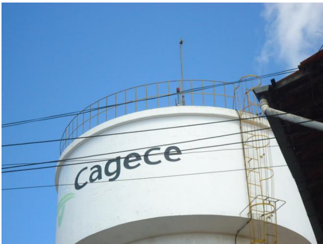
Foto 14 – REL-11: identificação, pára raio, escada de acesso e guarda-corpo..
