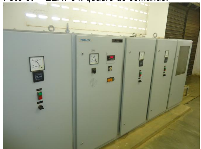
Foto 09 – EEAT-05: quadro de comando.
