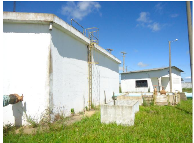
Foto 17 – RAP-09: escada de acesso e guarda-corpo.
