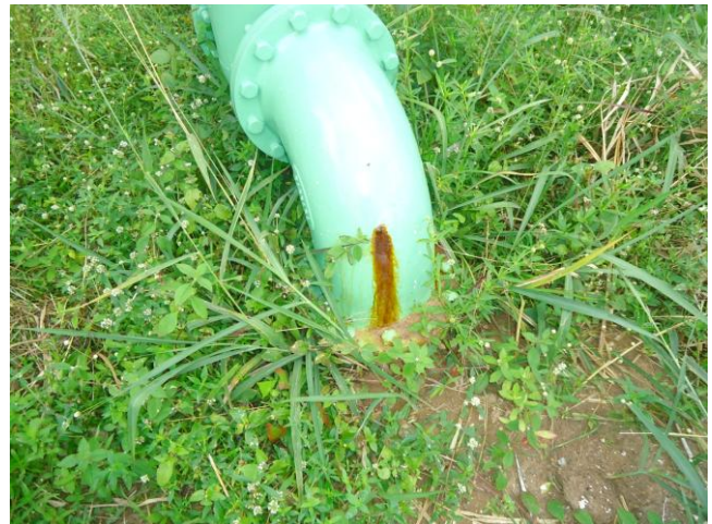
Foto 02 – TAU-01: vazamento no registro.
