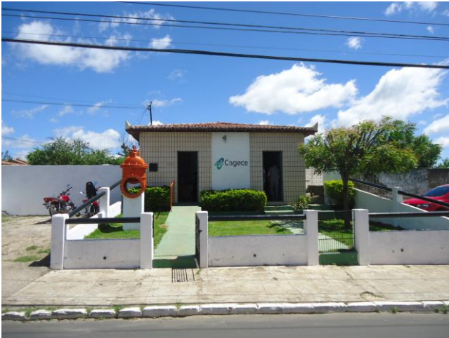
Foto 39 – Loja de Atendimento: vista externa.
