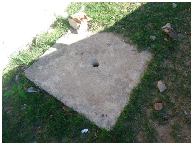
Foto 28 – Rede de distribuição: registro de descarga na Rua Capitão Pedro (4).
