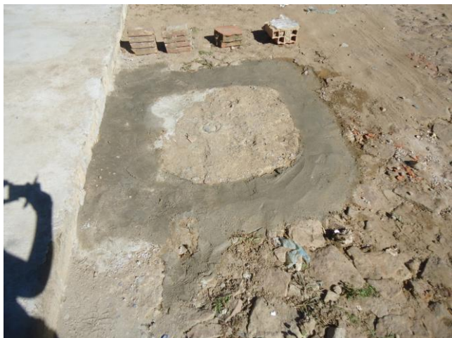
Foto 27 – Rede de distribuição: registro de descarga na Rua Tarcísio Araújo Santana (3).
