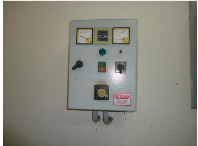
Foto 11 – Booster RAP-09: quadro de comando.
