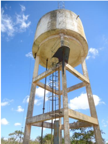
Foto 22 – REL-12 (Betânea): escada de acesso e guarda corpo apresentam corrosão.
