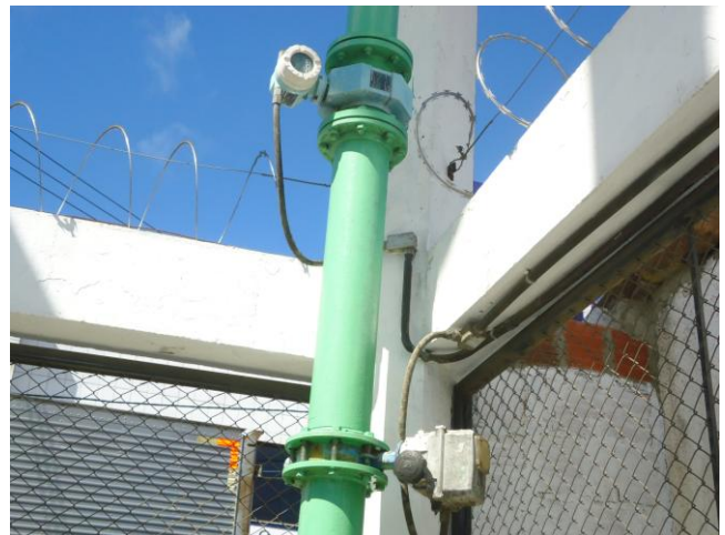
Foto 15 – REL-11: macromedidor instalado na entrada de água.
