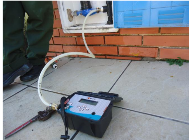
Foto 34 – Medição instantânea de pressão na Rua José Avelino, 84 – São João.
