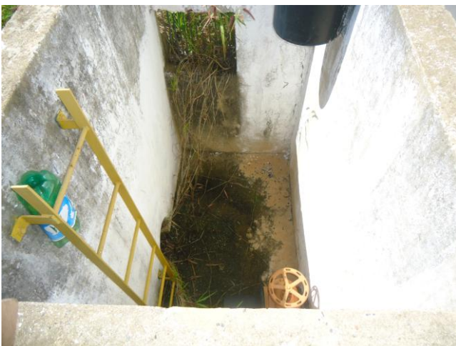
Foto 20 – RAP-09: registro sem grade na caixa de proteção.
