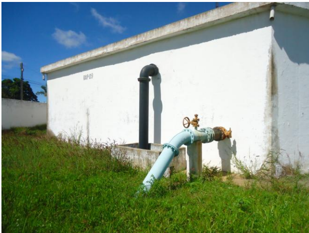
Foto 16 – RAP-09: registro e tubo extravasor.
