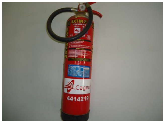
Foto 44 – Loja de Atendimento: extintor de incêndio fora do prazo de validade.
