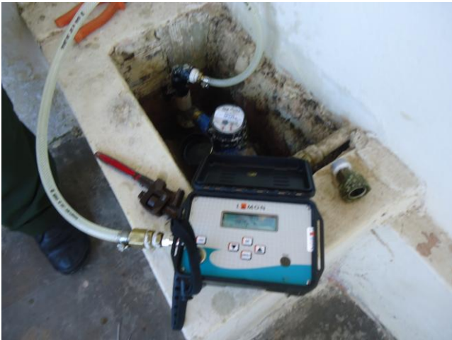
Foto 35 – Medição instantânea de pressão na Rua Tarciso Araújo Santana, 19 – Pedrinhas.
