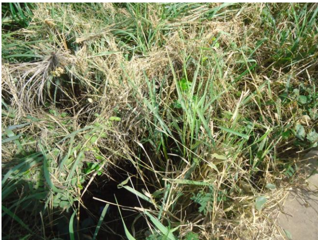
Foto 03 – AAT-11: registro de descarga encoberto pela vegetação.
