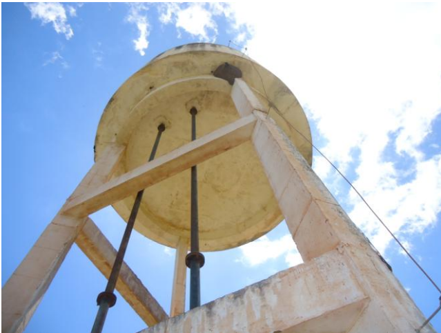
Foto 24 – REL-12 (Betânia): Presença de cupins na estrutura.
