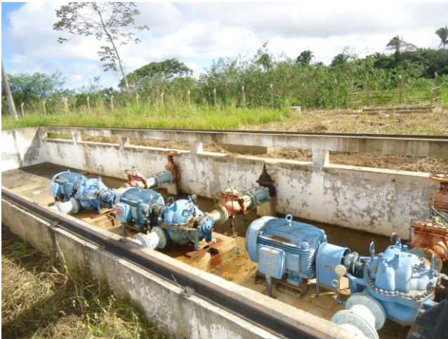
Foto 06 – EEAT-04: conjunto moto-bomba.
