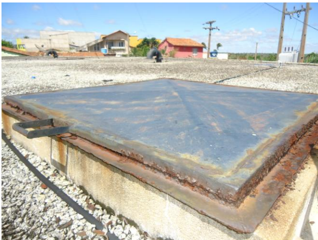
Foto 18 – RAP-09: tampa de inspeção com corrosão.
