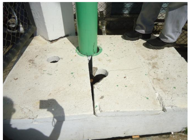
Foto 26 – Rede de distribuição: registro de descarga na Rua Pedro Ferreira de Assis – REL-11 (2).
