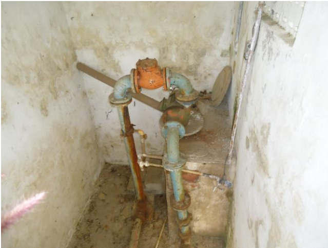
Foto 10 – Booster RAP-09: bomba sem fixação.
