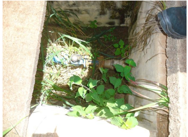
Foto 23 – REL-12 (Betânia): caixa do medidor sem grade de proteção.
