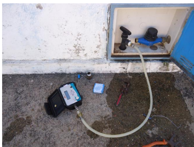
Foto 32 – Medição instantânea de pressão na Rua Miguel Sabino Gomes, 512.
