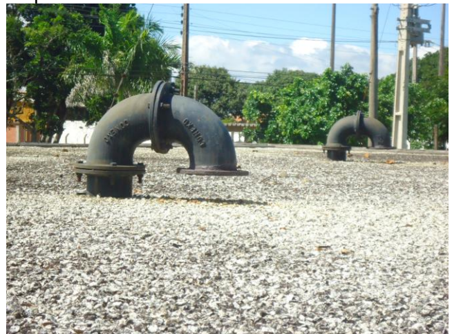
Foto 19 – RAP-09: tubulação de ventilação sem tela de proteção.
