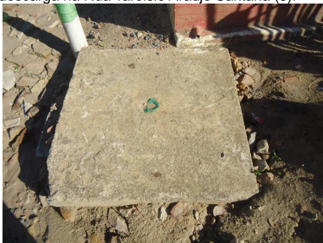
Foto 29 – Rede de distribuição: registro de descarga na Rua Miguel Canuto, ao lado do Colégio (5).
