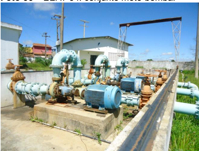
Foto 08 – EEAT-05: conjunto moto-bomba.
