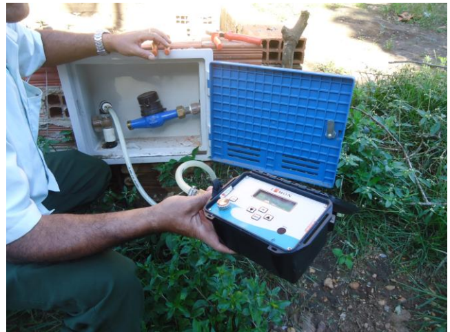
Foto 36 – Medição instantânea de pressão na Rua João Alfredo, S/N- Pimenta.
