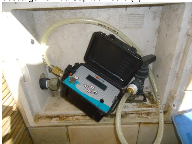
Foto 30 – Datalogger instalado na Avenida Fco Luis de Sousa, S/N.
