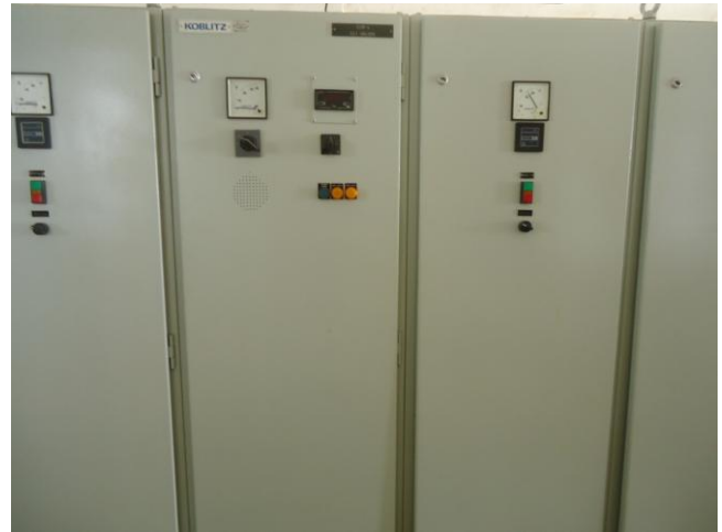
Foto 07 – EEAT-04: quadro de comando.
