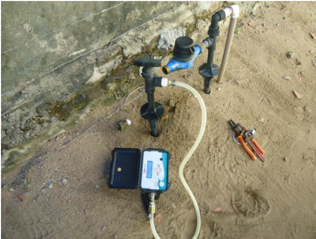
Foto 33 – Medição instantânea de pressão na Estrada para Paratibe, S/N.
