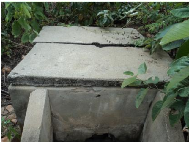
Foto 22 – Adutora: registro de descarga.
