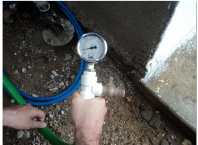
Foto 46 – Medição instantânea de pressão na Rua SDO 27, 100.
