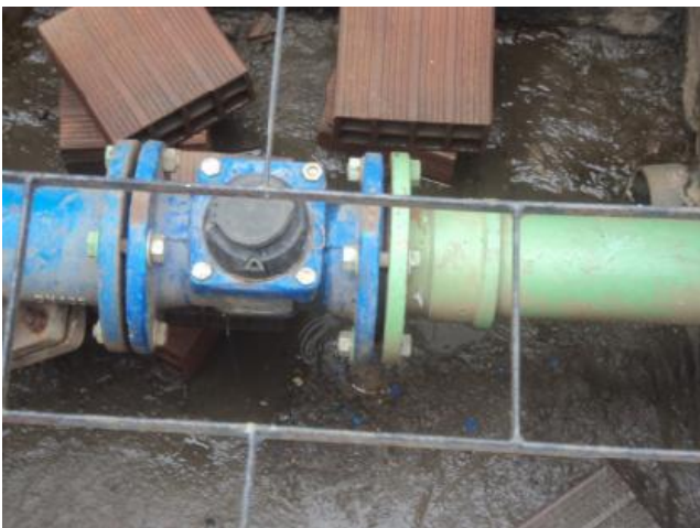
Foto 21 – ETA: medidor com vazamento no interior da ETA.
