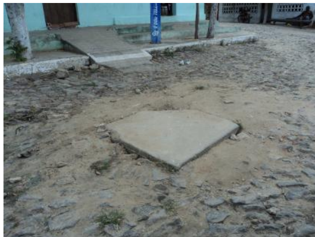
Foto 40 – Rede de distribuição: registro de descarga na Rua Etevaldo Paiva Nunes (1).
