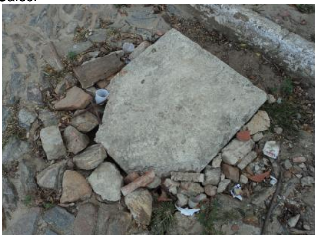
Foto 41 – Rede de distribuição: registro de descarga na Rua Etevaldo Paiva Nunes (2).
