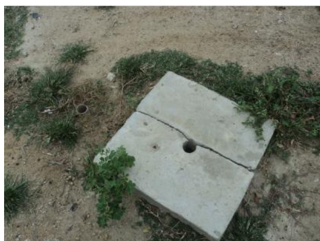
Foto 36 – Rede de distribuição: registro de descarga com tampa rachada na Rua Gabriel Aguiar Filho - Centro.
