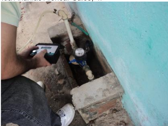
Foto 49 – Medição contínua de pressão na Rua Antonio T. Tavares, 351 – Centro.
