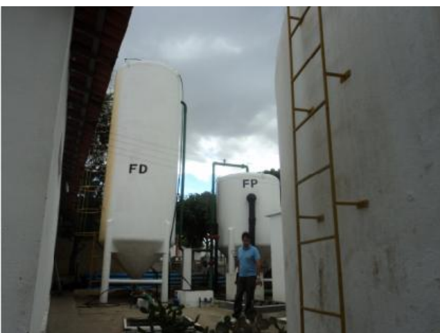
Foto 9 – ETA: vista do floco-decantador e do filtro de pressão.
