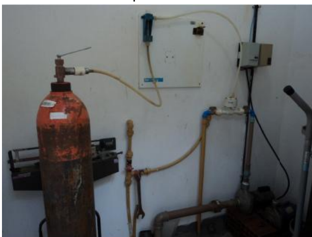
Foto 14 – Casa de química: cloro gasoso.
