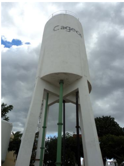
Foto 27 – REL-01: ausência de identificação.
