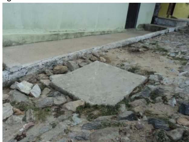
Foto 38 – Rede de distribuição: registro de descarga na Rua José Barroso Valente.
