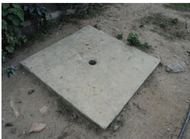
Foto 37 – Rede de distribuição: registro de descarga sem caixa na Rua SDO 40.
