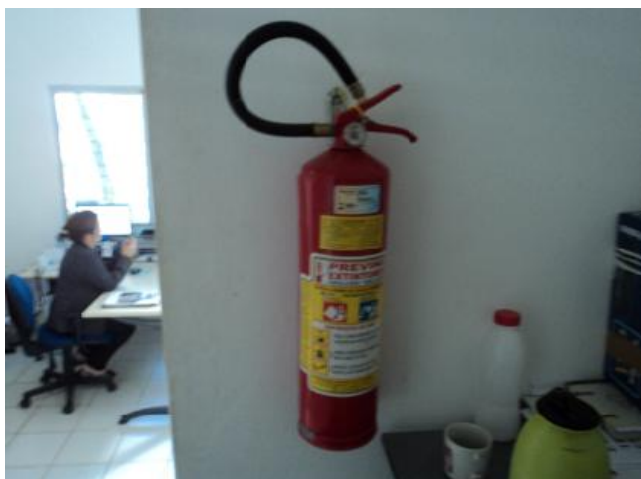
Foto 56 – Loja de Atendimento: extintor de incêndio dentro do prazo de validade.
