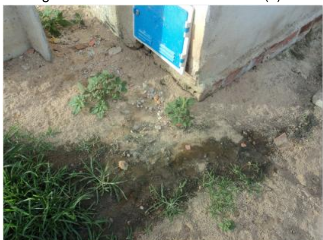
Foto 43 – Rede de distribuição: registro de descarga enterrado na Rua João Pinto de Mesquita.
