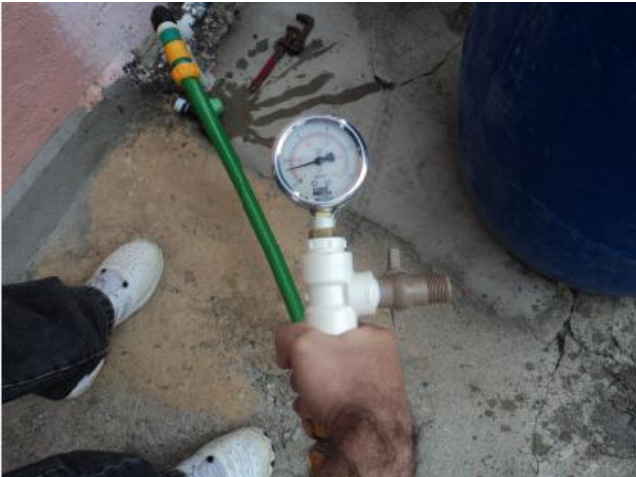
Foto 45 – Medição instantânea de pressão na Rua Sdo 26, 94.
