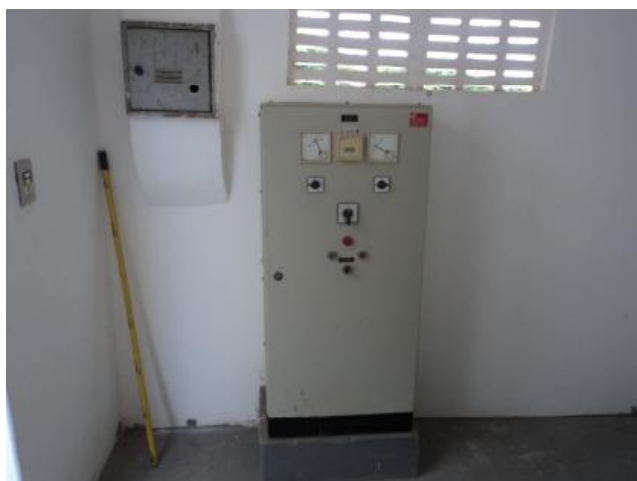
Foto 25 – EEAT: quadro de comando.
