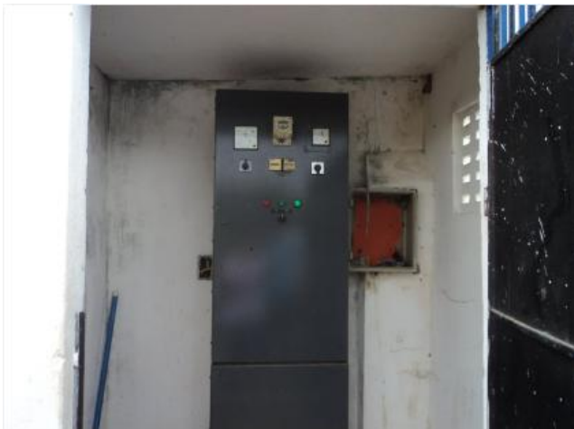
Foto 5 – Boqueirão: quadro de comando.
