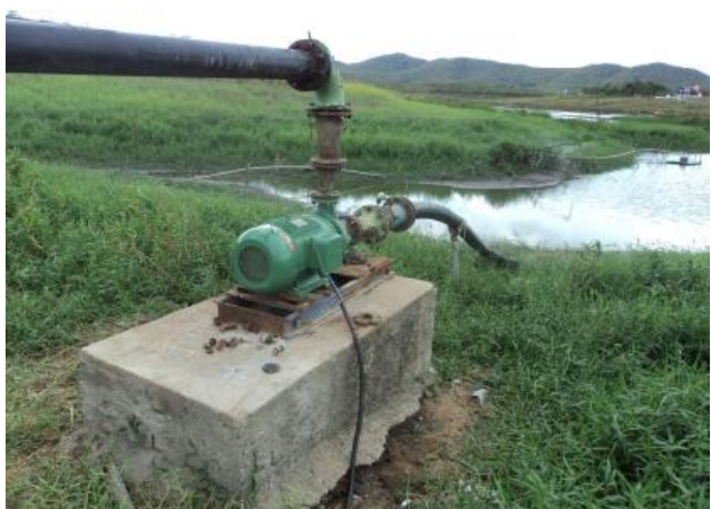
Foto 3 – Boqueirão: elevatória EECS-01 com bomba instalada na margem .
