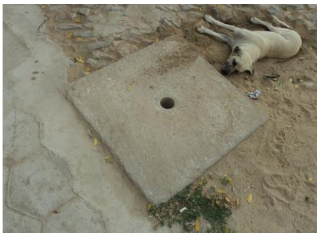
Foto 35 – Rede de distribuição: registro de descarga na Rua Joaquim Coelho da Cruz.
