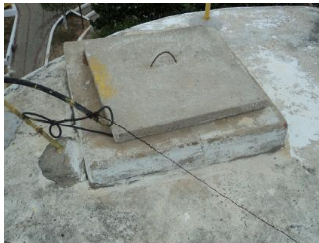
Foto 28 – REL-01: tampa de inspeção.
