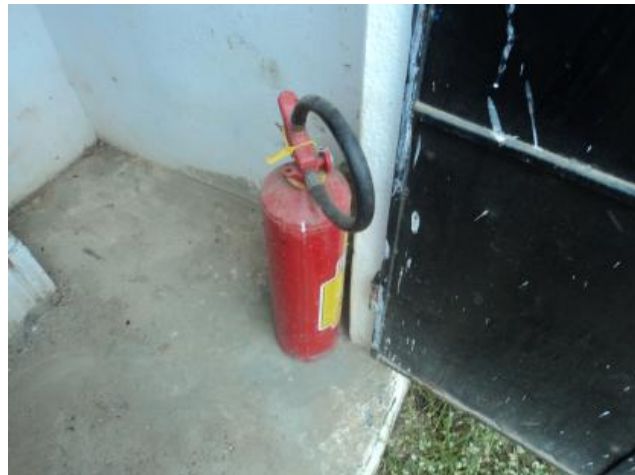
Foto 6 – Boqueirão: extintor de incêndio.
