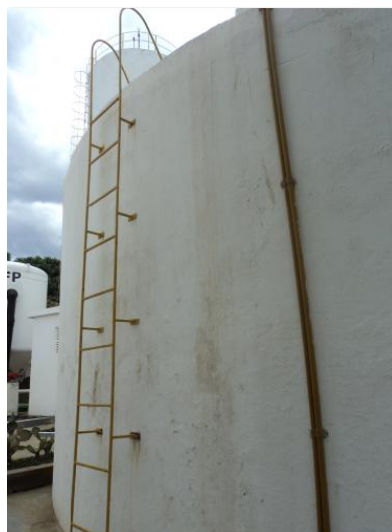
Foto 32 – RAP-01: escada de acesso.
