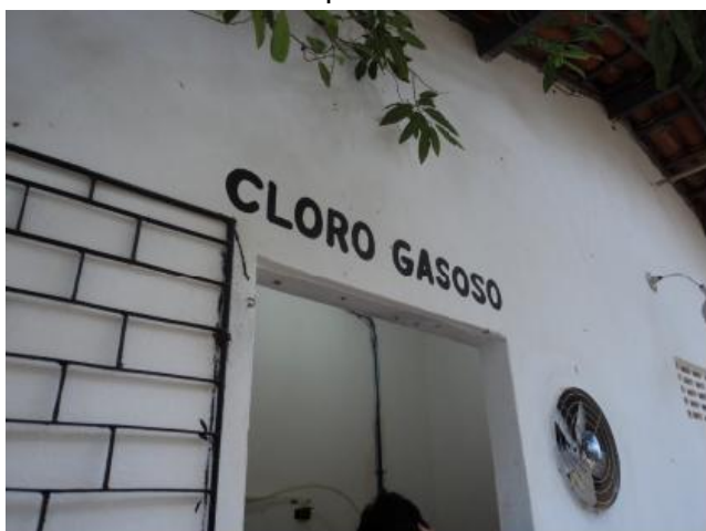
Foto 13 – Casa de química: local de armazenamento dos cilindros de cloro gasoso.
