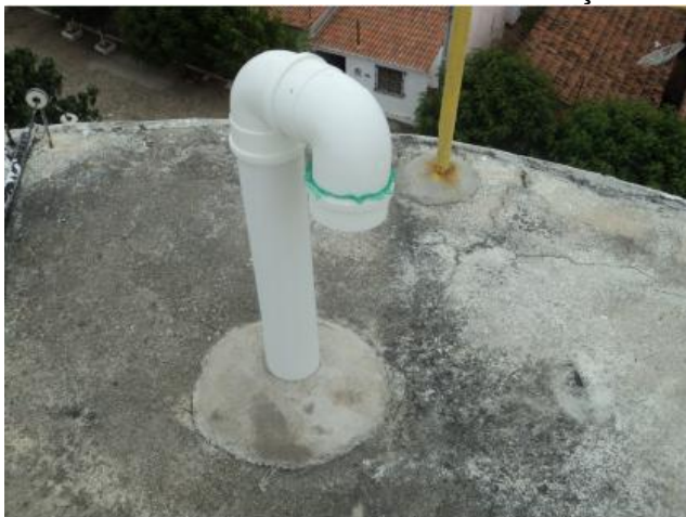
Foto 29 – REL-01: tubulação de ventilação.
