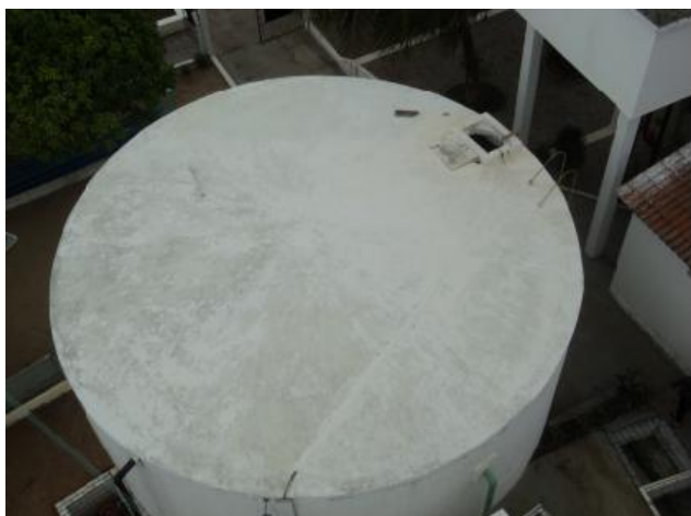
Foto 33 – RAP-01: vista superior do reservatório com tampa de injeção aberta.
