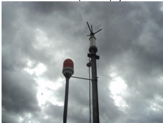
Foto 30 – REL-01: para-raios e sinalização noturna.
