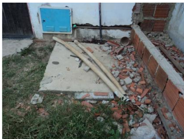
Foto 42 – Rede de distribuição: registro de descarga na Rua Catão Andrade Araújo.
