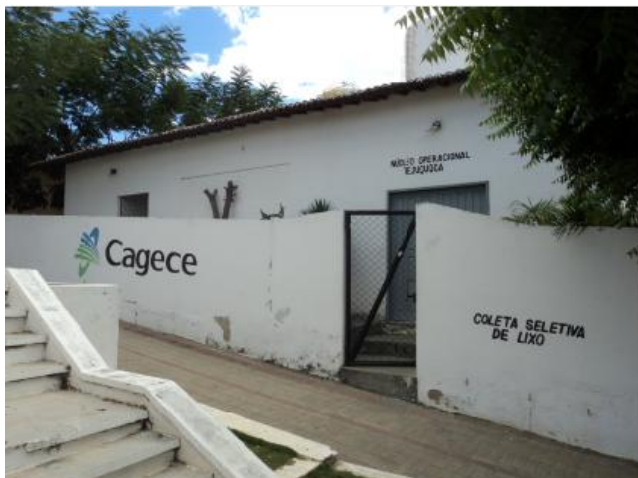
Foto 50 – Loja de Atendimento: vista externa.
