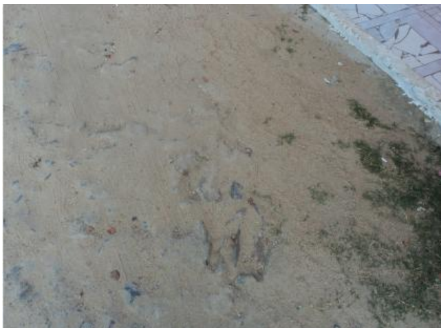
Foto 39 – Rede de distribuição: registro de descarga enterrado na Rua Ananias Alencar Sales.
