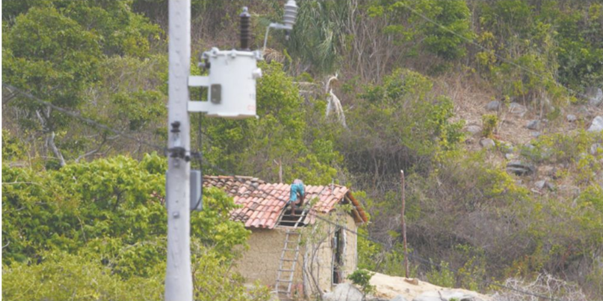
Em localidade da zona rural do Estado, a instalação da rede elétrica ainda é recente. Em muitas comunidades, no entanto, as famílias ainda não contam com o serviço regular. FOTO: KIKO SILVA
