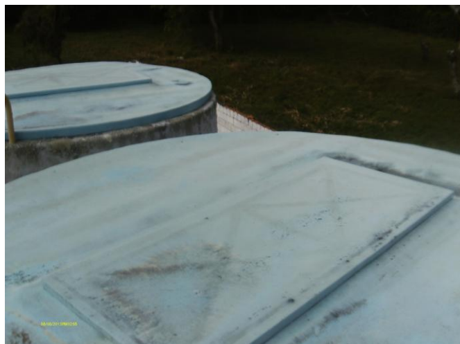
Foto 23 – Tampas dos filtros F-01 e F-02 (desativado).
