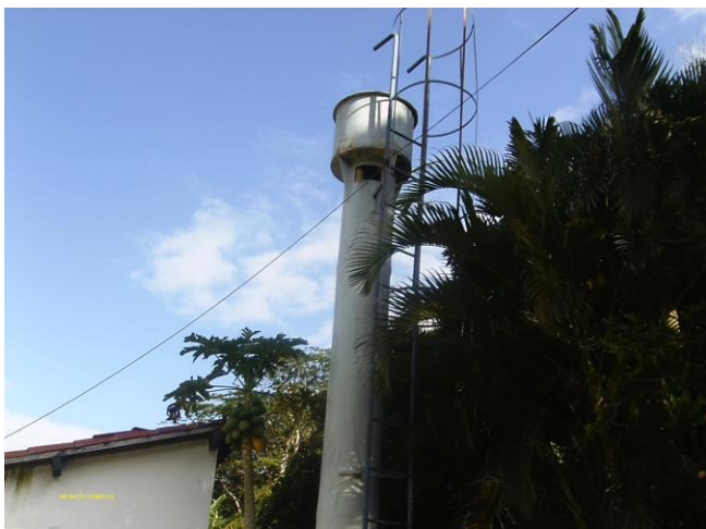
Foto 75 – Torre de equilíbrio.
