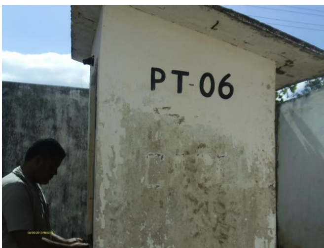
Foto 06 – Casa de abrigo do PT-06.
