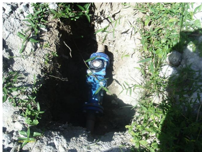
Foto 16 – PT-09- medidor instalado sem caixa de proteção.
