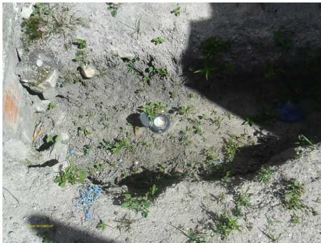
Foto 13 – PT-08: medidor instalado sem caixa de proteção.
