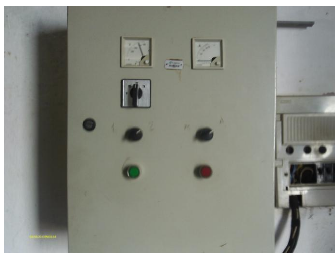
Foto 74 – Quadro de comando do gerador.
