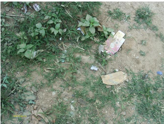
Foto 61 – Registro de descarga na rede soterrado: Rua Santa Inês (1).
