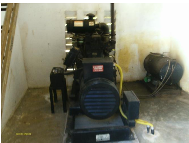
Foto 73 – Gerador de energia.
