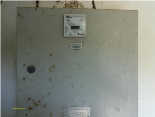
Foto 39 – Booster Sítio Espeto: horímetro do quadro de comando.
