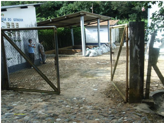
Foto 65 – Vista externa da ETE.
