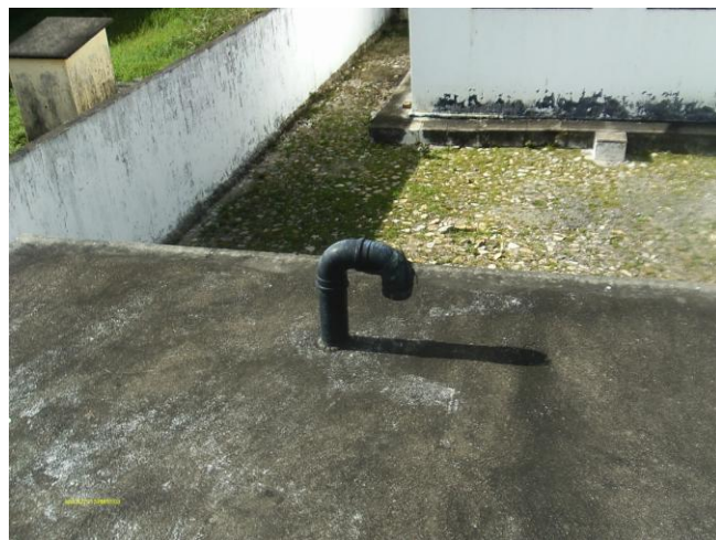
Foto 46 – RAP-01: tubulação de ventilação.
