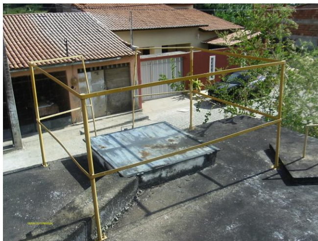
Foto 47 – RAP-01: tampa de inspeção enferrujada.
