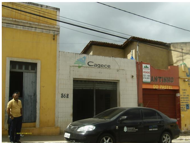
Foto 81 – Escritório: vista externa.
