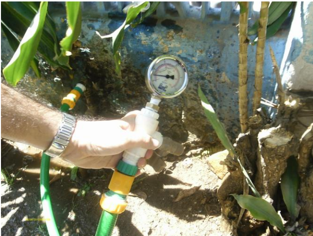
Foto 59 – Medição de pressão instantânea de pressão no endereço: Rua Tabelião João Mesquita, 35 – Hospital.
