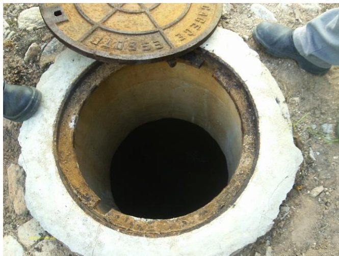
Foto 64 – PV localizado na saída da ETE.
