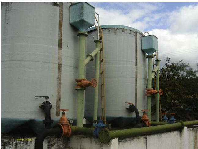
Foto 22 – Filtros: vista lateral F-01 e F-02(desativado).
