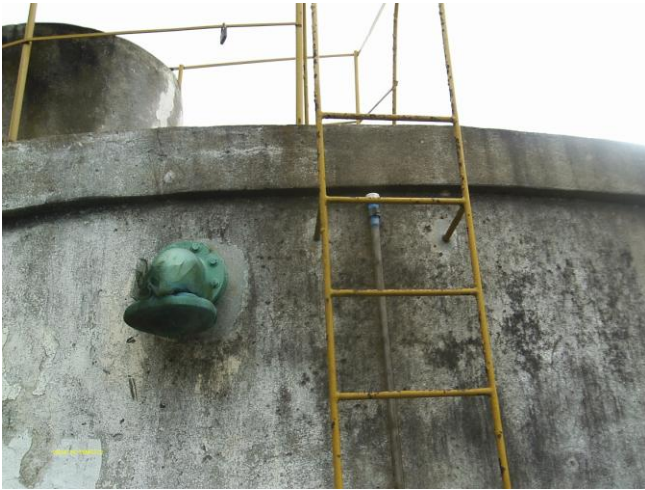
Foto 53 – RAP-02: escada de acesso.
