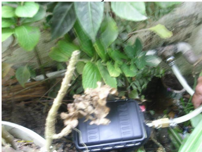
Foto 55 – Equipamento datalogger instalado no endereço: Rua Santa Inês, 10 – Centro.
