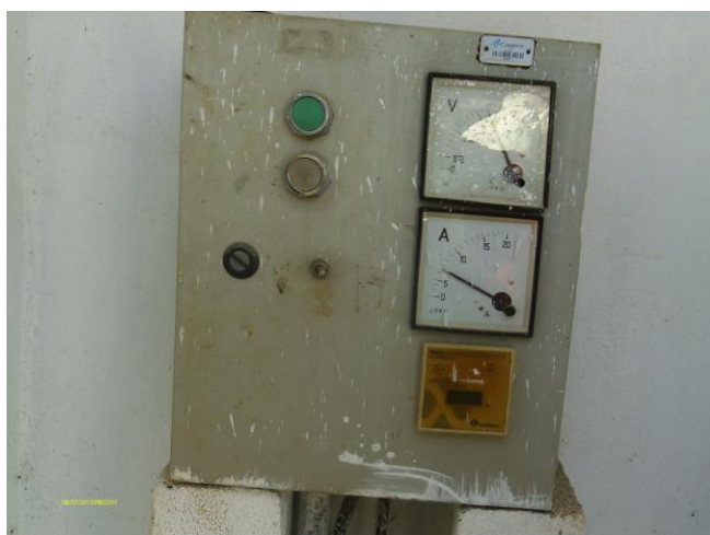
Foto 05 – Quadro de comando do PT-04.
