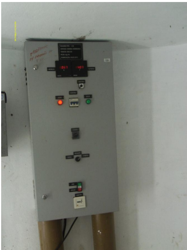
Foto 19 – PT-10: quadro de comando.
