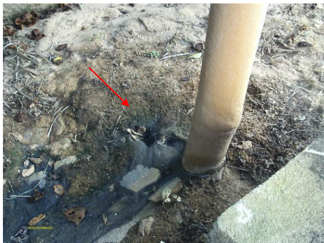
Foto 76 – Vazamento na entrada da torre de equilíbrio.
