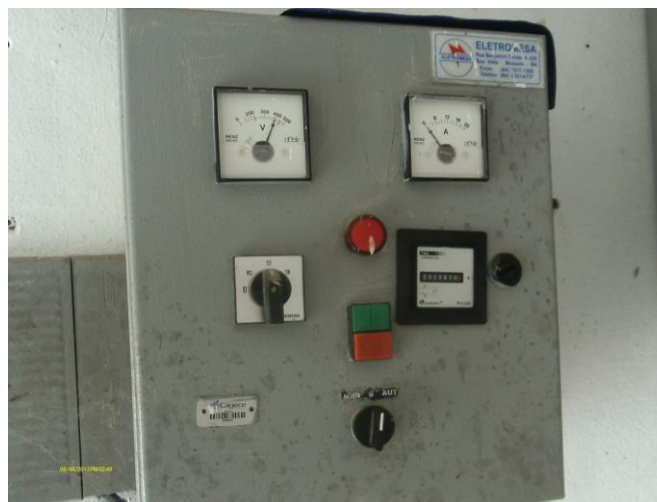
Foto 02 – PA-01: Quadro de comando.
