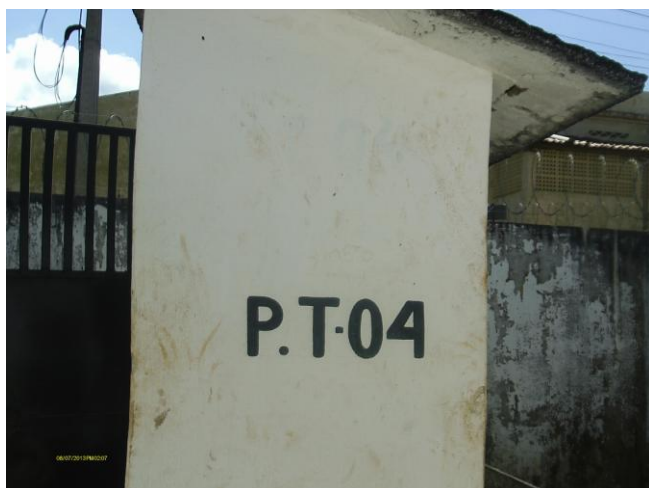
Foto 03 – Casa de abrigo do poço PT-04.
