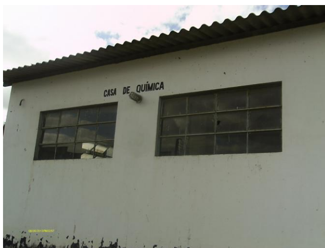
Foto 26 – Casa de química.
