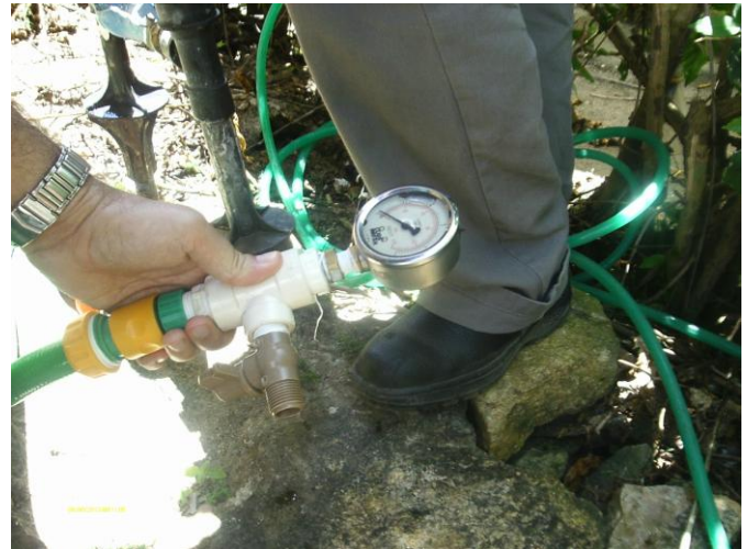
Foto 60 – Medição de pressão instantânea de pressão no endereço: Rodovia CE-065, 21 – Centro.
