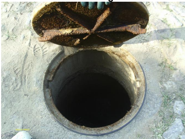
Foto 63 – PV localizado na Rua Nita Frota.
