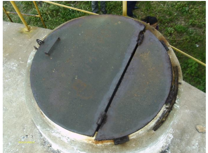
Foto 54 – RAP-02: tampa de inspeção enferrujada.
