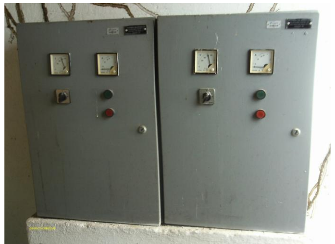
Foto 44 – EELF-09: quadro de comando.
