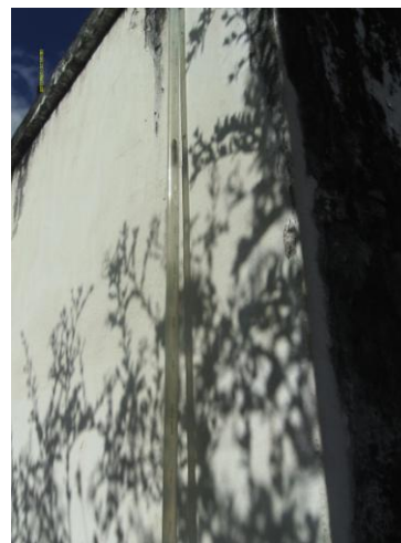
Foto 48 – RAP-01: tubulação de controle de nível.
