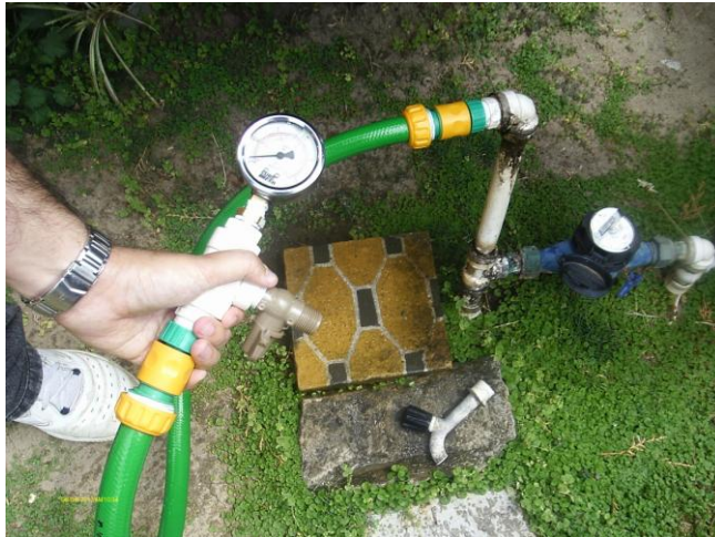
Foto 57 – Medição de pressão instantânea no endereço: Rua Areias, 135 – Centro.
