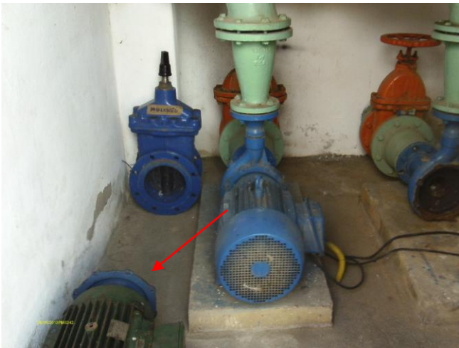
Foto 41 – EEAT-08 – bomba reserva sem instalação.
