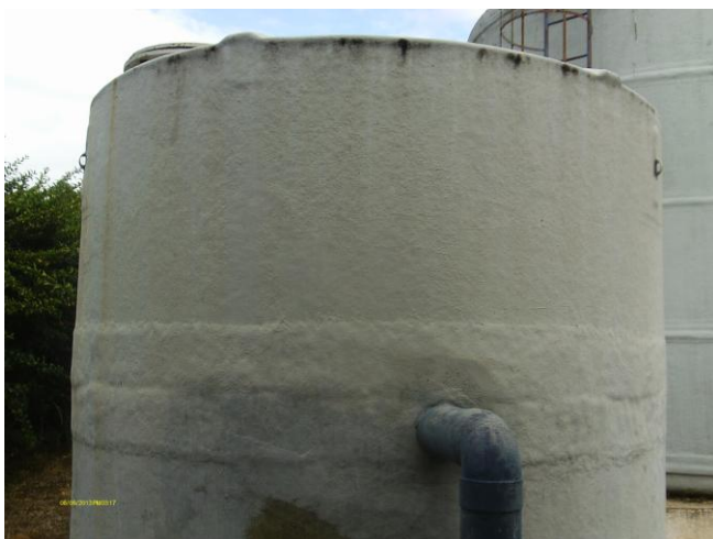
Foto 79 – Tanque de contato.
