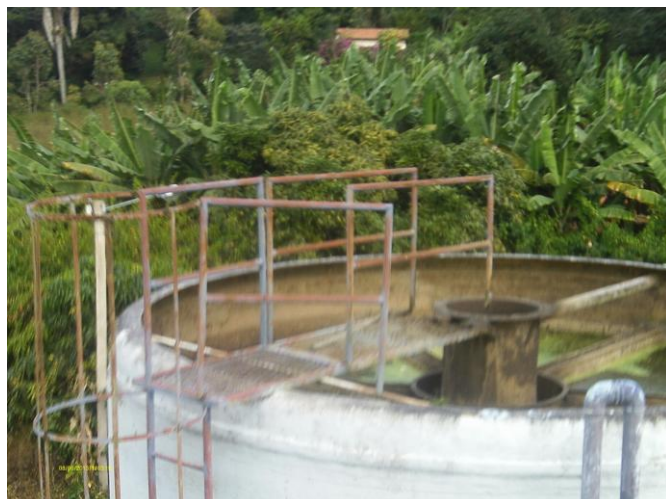
Foto 70 – Pasarelas, guarda-corpo e escadas de acesso dos reatores.
