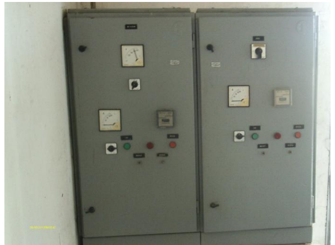
Foto 42 – EEAT-08: quadro de comando.
