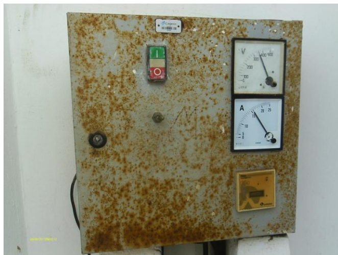
Foto 08 – Quadro de comando do PT-06.
