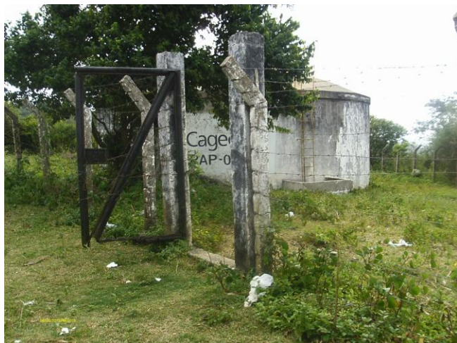
Foto 49 – RAP-02: entrada do reservatório.
