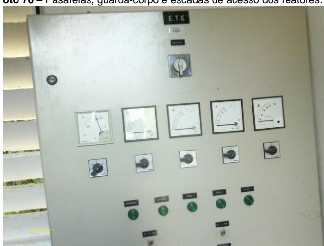
Foto 72 – Quadro de comando do compressor.
