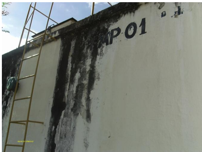
Foto 45 – RAP-01: pintura deteriorada e escada de acesso.
