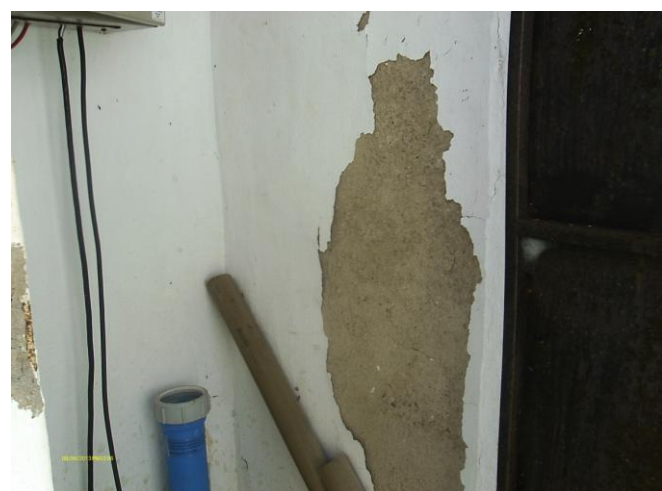
Foto 12 – PT-08: pintura deteriorada.
