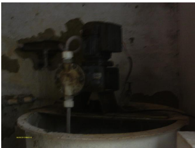
Foto 77 – Tanque dosador de cloro.
