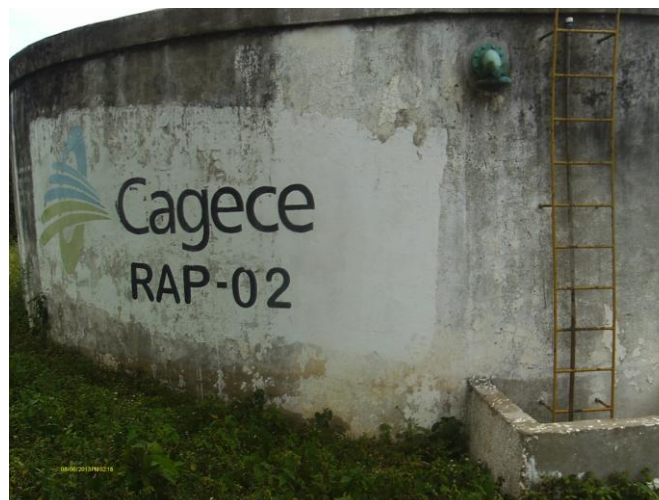
Foto 50 – RAP-02: pintura deteriorada.
