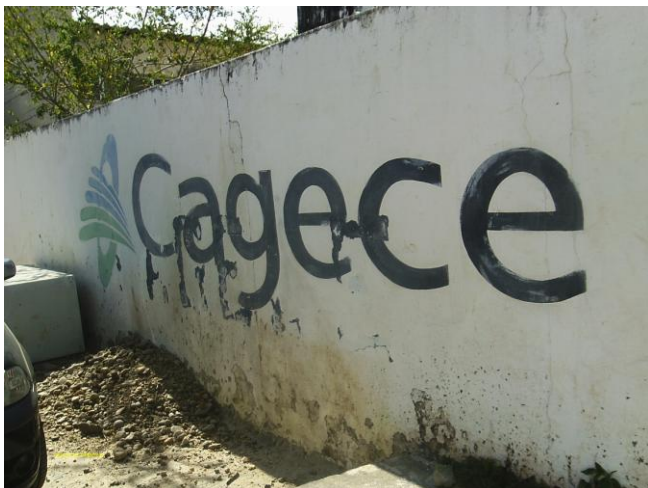
Foto 20 – ETA: Vista externa.
