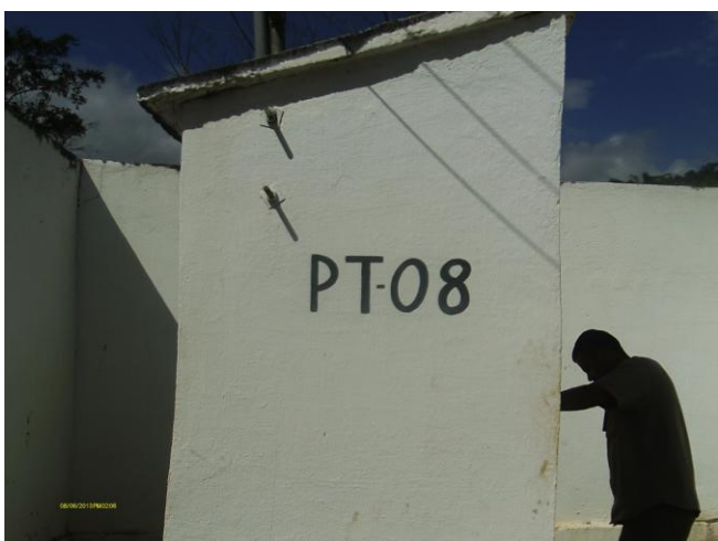
Foto 09 – Casa de abrigo do PT-08.
