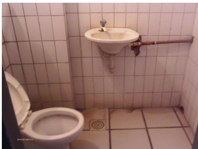
Foto 85 – Escritório: instalações sanitárias.
