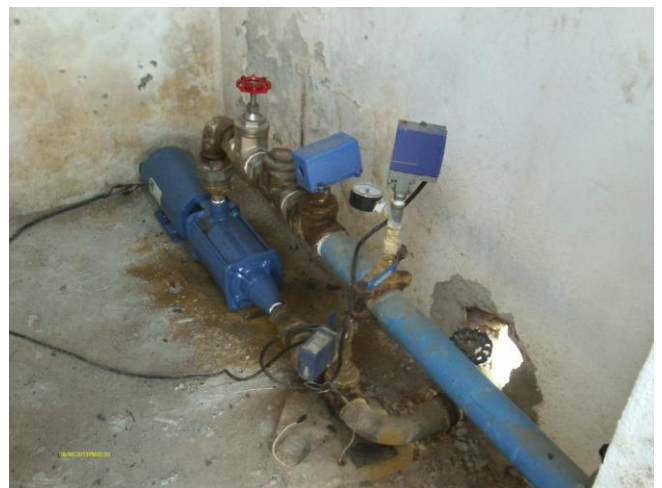
Foto 38 – Booster Sítio Espeto: ausência de bomba reserva.
