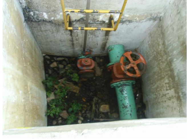
Foto 52 – RAP-02: caixa do registro sem grade de proteção.
