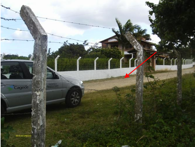
Foto 51 – RAP-02: cerca danificada.
