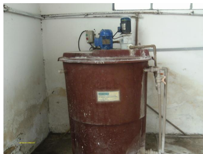
Foto 27 – Casa de química: tanque dosador.
