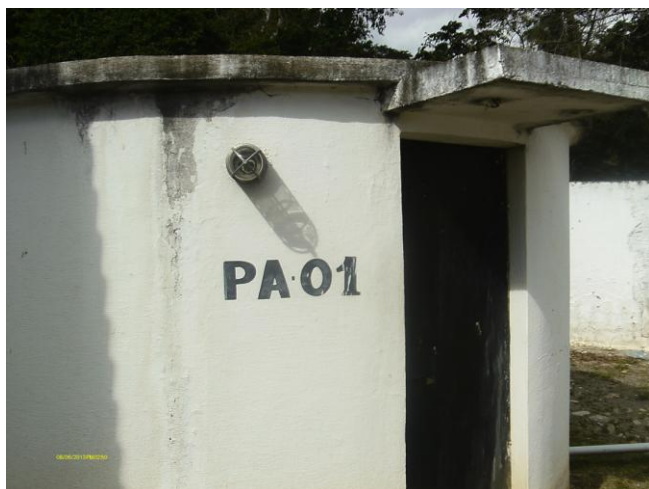
Foto 01 – Vista externa do PA-01.
