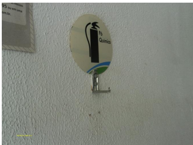
Foto 83 – Escritório: ausência de extintor de incêndio.
