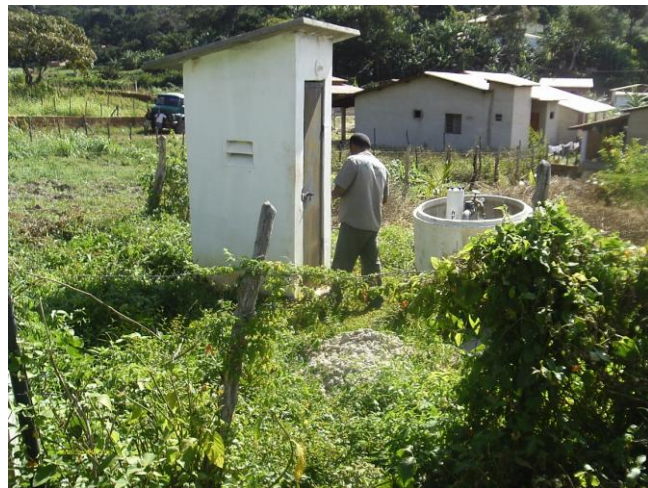
Foto 14 – PT-09: casa de abrigo sem identificação.
