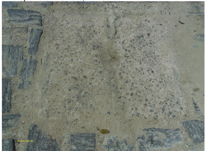
Foto 62 – Registro de descarga na rede soterrado: Rua Antenor Frota Vanderley (2).
