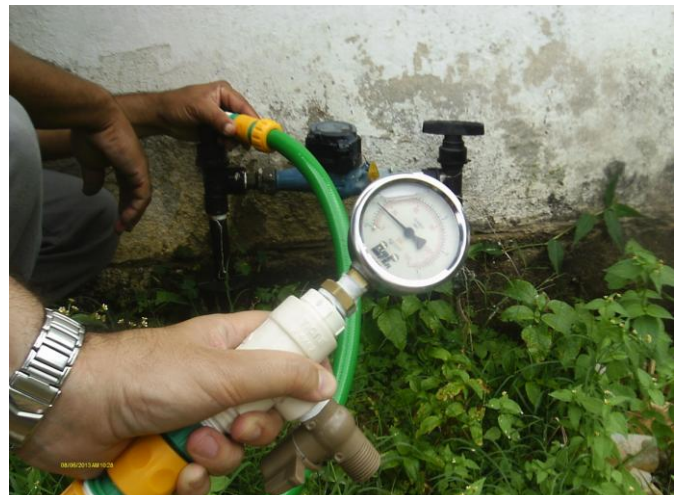
Foto 56 – Medição de pressão instantânea no endereço Rua Santa Inês, 10 – Centro.
