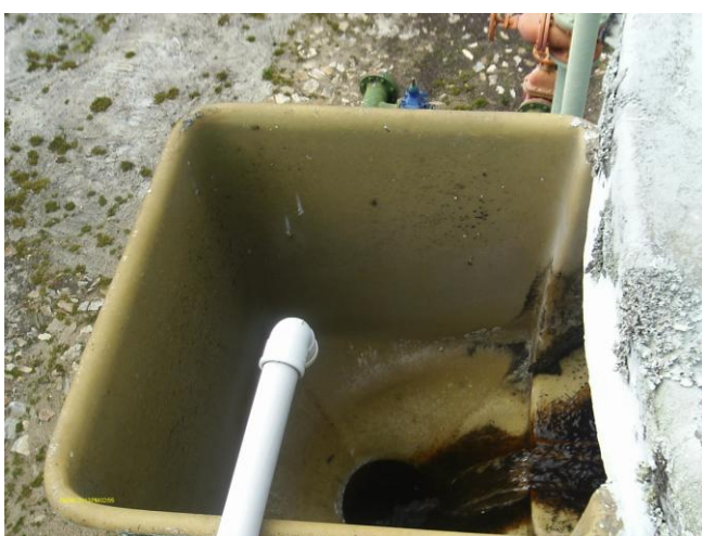
Foto 24 – Calha de saída de água sem tampa.
