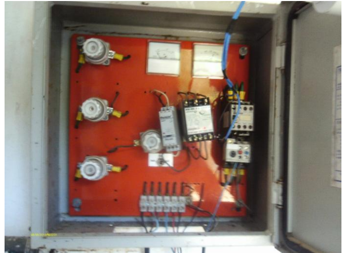
Foto 40 – Booster Sítio Espeto: volímetro e amperímetro do quadro de comando .
