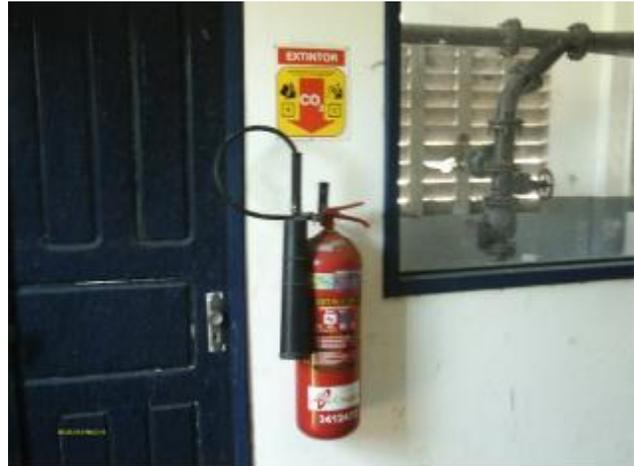
**Foto 49** – EEE: extintor de incêndio dentro do prazo de validade.
