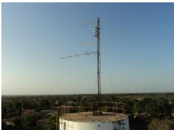
**Foto 8** – REL-04: guarda-corpo na laje de cobertura, tampa de inspeção, para-raios e sinalização noturna.
