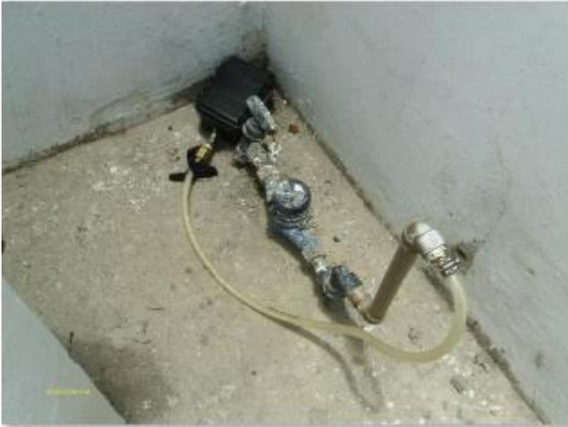
**Foto 38** – Medição contínua de pressão com o datalogger no Escritório da CAGECE.
