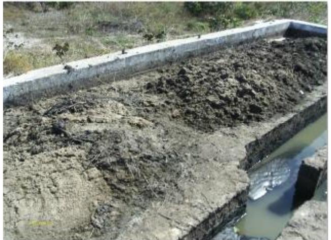
**Foto 57** – Caixa de areia: deposição do lodo para secagem .
