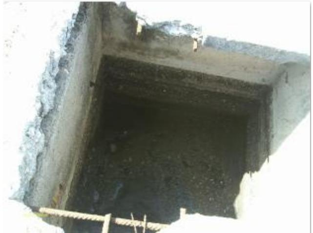
**Foto 55** – Caixa de recepção do esgoto.
