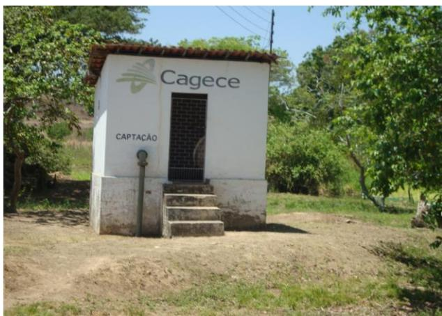
**Foto 5** – Casa de abrigo da elevatória EEAB-01 e do quadro de comando.
