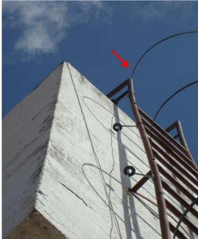
**Foto 41** – REL-01: com fio do para-raios enconstado na escada.
