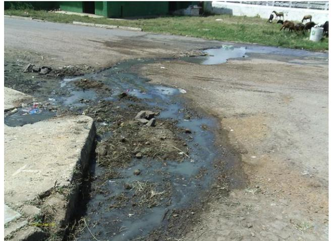
**Foto 58** - Lançamento de esgoto a céu aberto em ponto com cobertura do sistema: Rua Gonçalo Lira.
