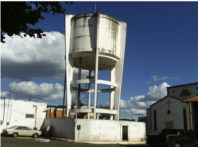
**Foto 16** - REL-19 (Centro): pára-raio, identificação apagada, pintura deteriorada.
