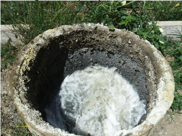
**Foto 97** - Reator UASB-03: caixa de passagem do efluente sem tampa.
