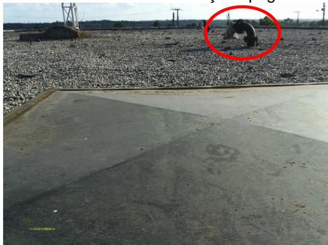
**Foto 35** - RAP-10: tampa de inspeção em processo de corrosão e tubulação de ventilação com tela de proteção.
