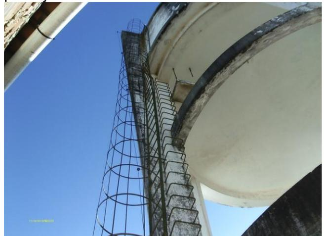
**Foto 17** - REL-19 (Centro): escada de acesso em processo de corrosão.
