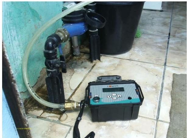
**Foto 39** - Aparelho de medição contínua de pressão *datalogger* instalado no endereço Av. Fco Júlio Filizola, 1093 - Centro.
