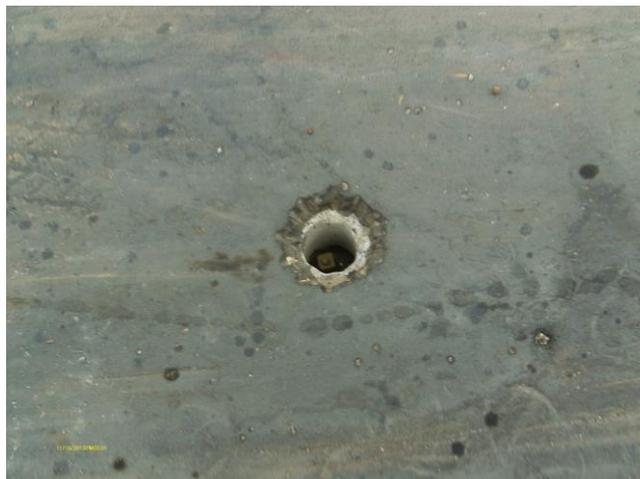
**Foto 51** - Registro de descarga na rede de distribuição localizado na Rua Fco Sabino da Costa (encoberta pelo asfalto).
