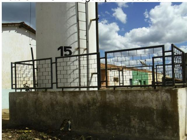
**Foto 10 - TAU-15: identificação, pintura do muro deteriorada.**
