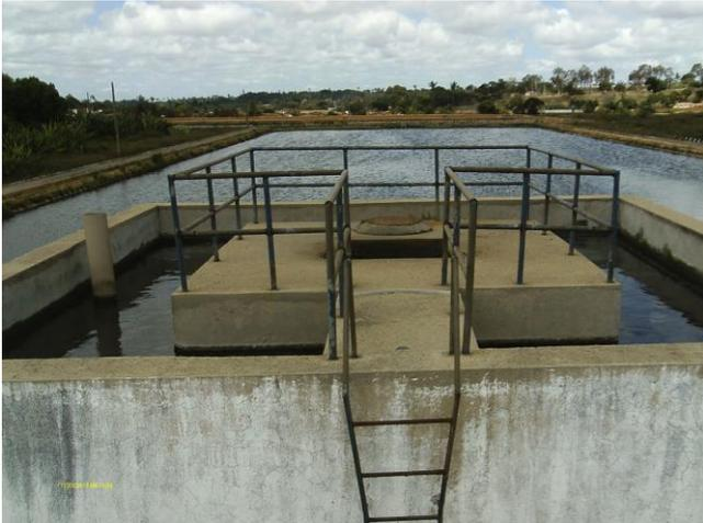
**Foto 95** - Reator UASB-02: escada de acesso, guarda corpo e passarelas.
