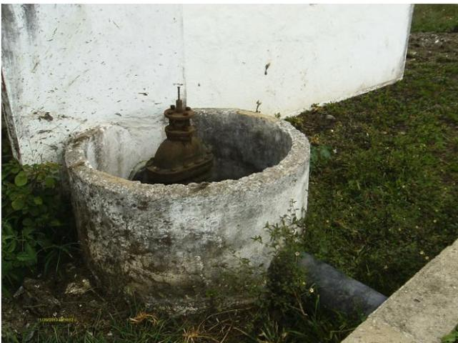
**Foto 93** - Reator UASB-01: tubulação e registro da descarga de fundo.
