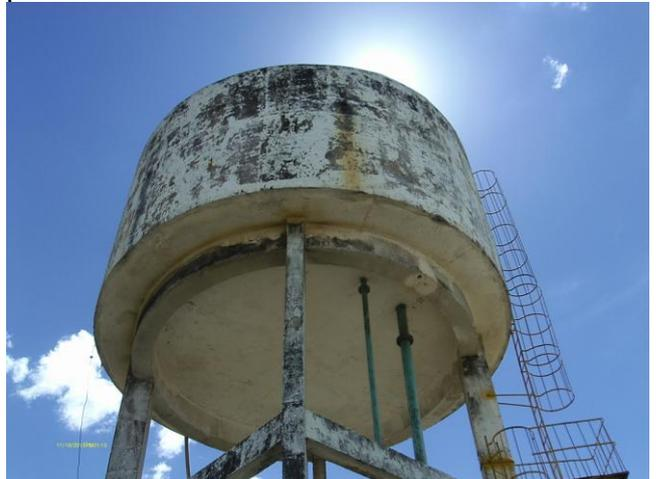
**Foto 27** - REL-21 (Inhuçu): pintura deteriorada, identificação apagada e escada de acesso em processo de corrosão, ausência de guarda-corpo na cobertura.
