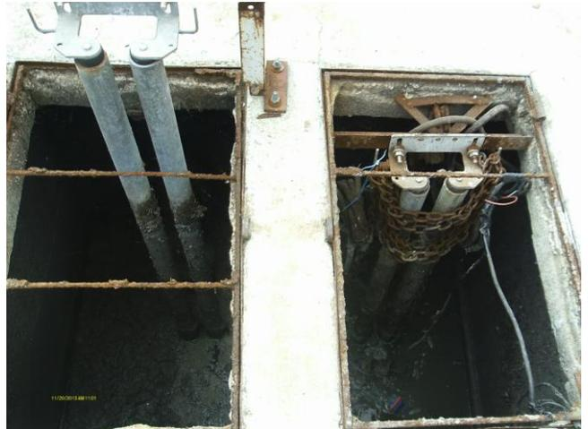
**Foto 60** - EEE-01: bombas submersas e ausência de tampa no poço de sucção.
