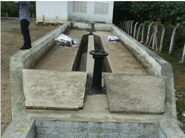
**Foto 73** - EEE-03: tratamento preliminar com gradeamento, caixa de areia e Calha Parshall.
