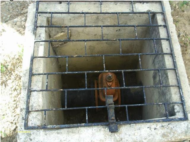
**Foto 20** - REL-19 (Centro): caixa de passagem com grade de proteção.
