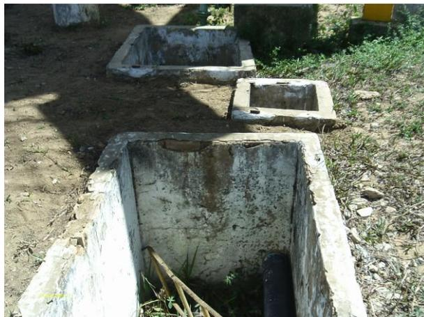
**Foto 31** - REL-21 (Inhuçu): caixas dos registros e do macromedidor sem tampa ou grade de proteção.
