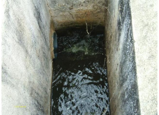
**Foto 102** - Saída do efluente da lagoa de maturação para o corpo receptor.
