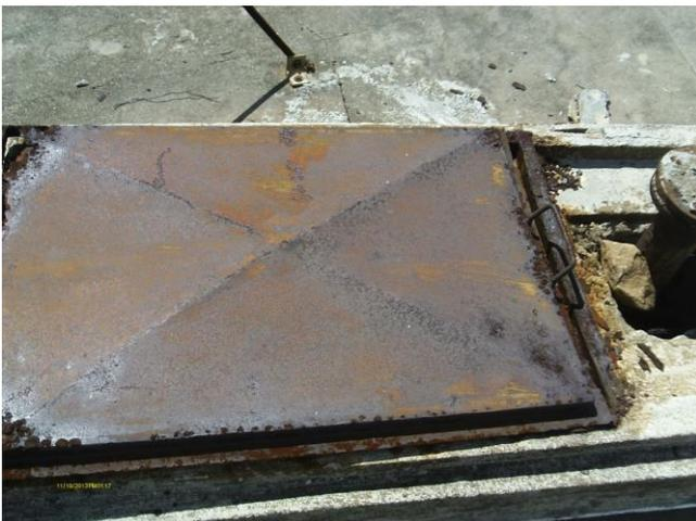
**Foto 28** - REL-21 (Inhuçu): tampa de inspeção corrida.
