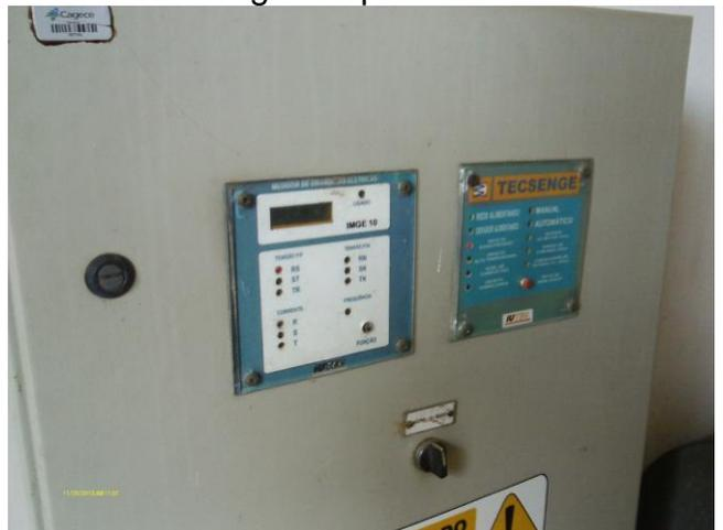
**Foto 64** - EEE-01: quadro de comando do grupo gerador de energia elétrica.
