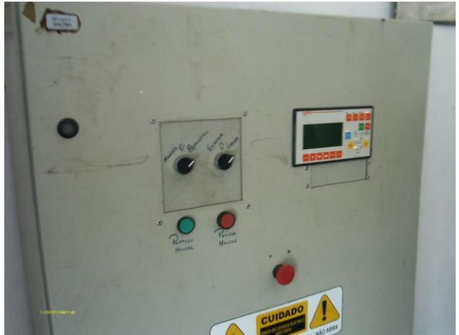
**Foto 78** - EEE-03: quadro de comando do grupo gerador de energia elétrica.
