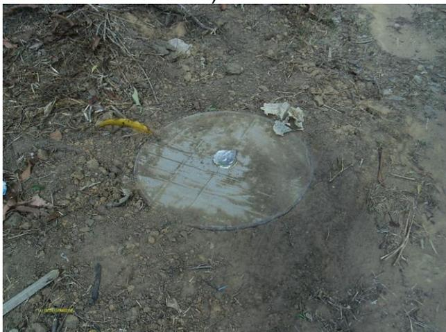
**Foto 50** - Registro de descarga na rede de distribuição localizado na Estrada Sítio Jussara.
