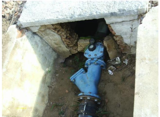
**Foto 15** - REL-18 (Fórum): caixa do medidor proporcional sem tampa ou grade de proteção.
