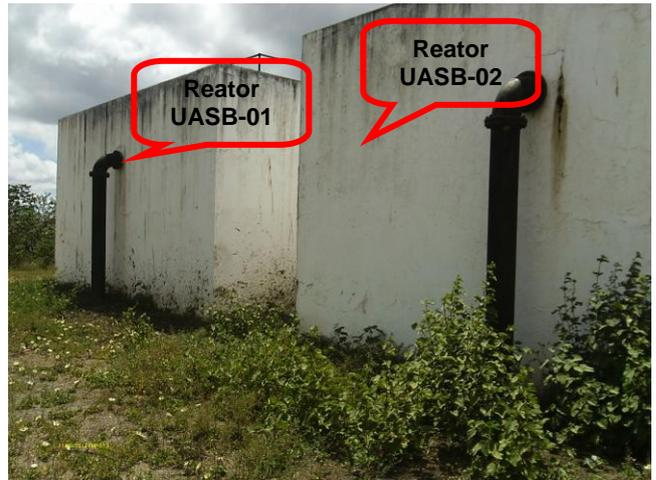
**Foto 90** - Reatores UASB 01 e 02: ausência de identificação, pintura deteriorada e tubulação de entrada do efluente.
