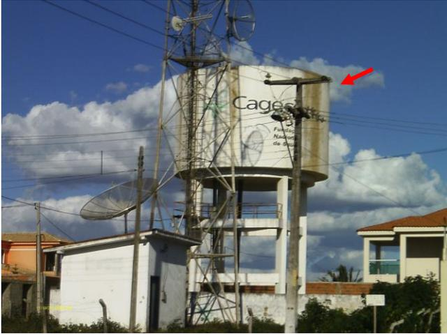
**Foto 12** - REL-18 (Fórum): ausência de identificação e pintura deteriorada.
