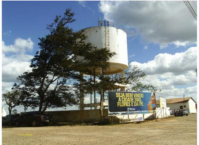
**Foto 21** - REL-20 (Cruzeiro): pára raio, escada de acesso em processo de corrosão, identificação apagada e pintura deteriorada.
