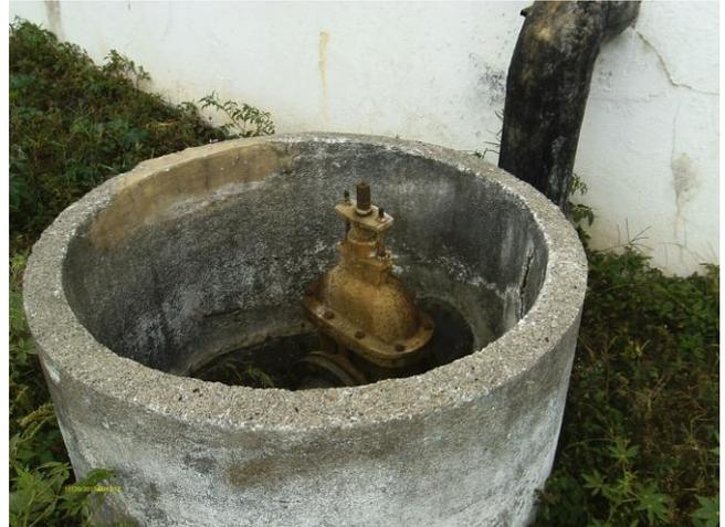
**Foto 96** - Reator UASB-02: descarga de fundo.
