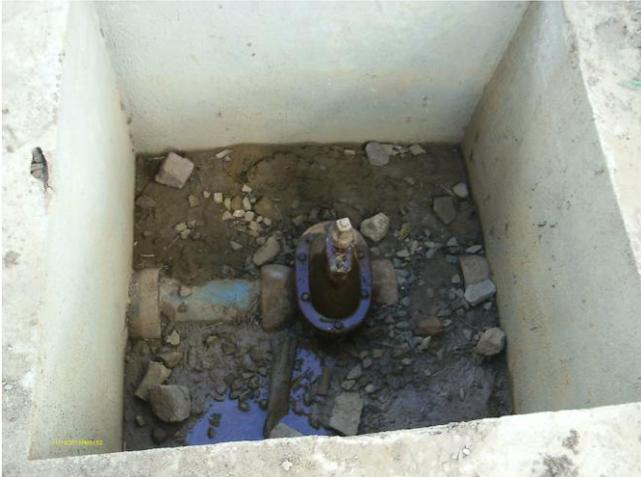
**Foto 24** - Caixa do registro sem grade de proteção e vazamento no registro.
