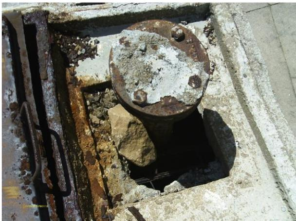
**Foto 30** - REL-21 (Inhuçu): tubulação de ventilação danificada.
