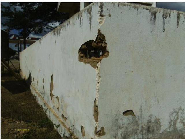
**Foto 22** - REL-20 (Cruzeiro): muro que delimita a área do reservatório danificado.
