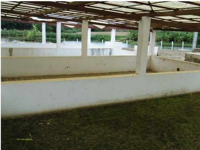
**Foto 21** - Leitões de secagem do sistema de reúso das águas de lavagem dos filtros (desativado).
