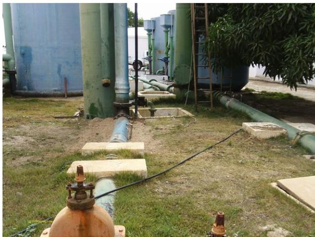
**Foto 6** - ETA: tubulação que será utilizada para os pré-filtros.
