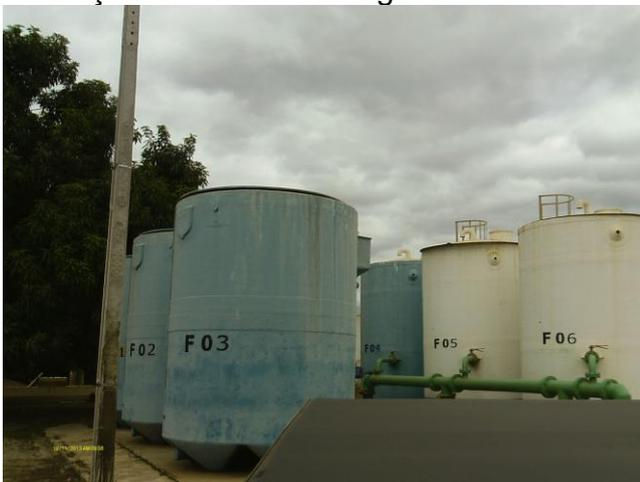
**Foto 9** - Filtração: identificação e vista lateral dos filtros F-01, F-02, F-03, F-04, F-05 e F-06.
