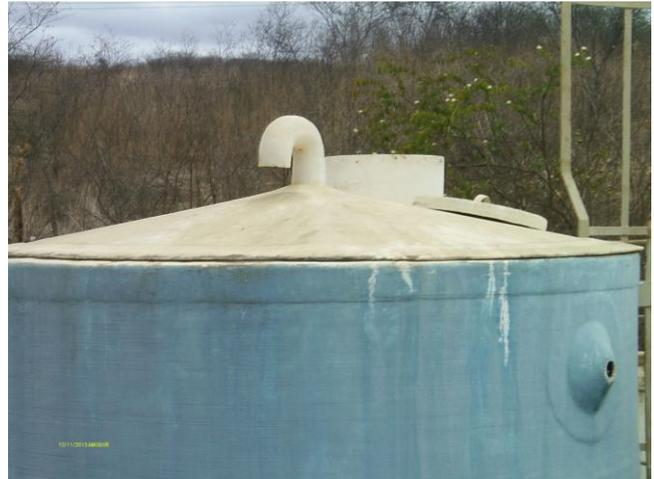
**Foto 14** - Filtração: tampa do filtro F-04 e calha de saída de água.
