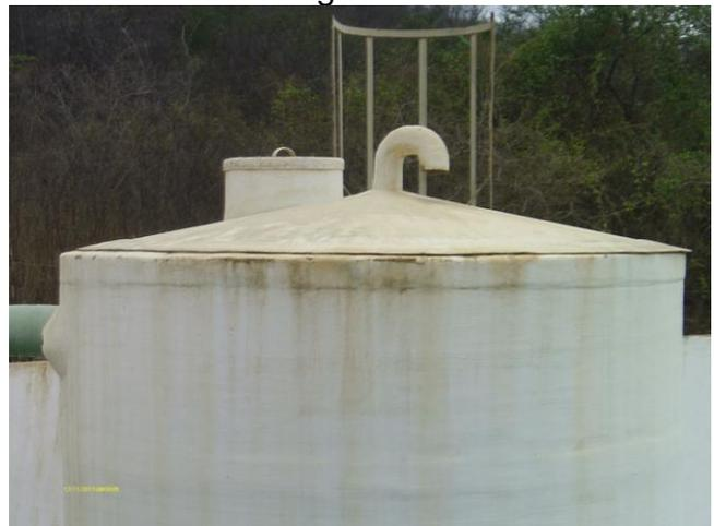
**Foto 16** - Filtração: tampa do filtro F-06 e calha de saída de água.
