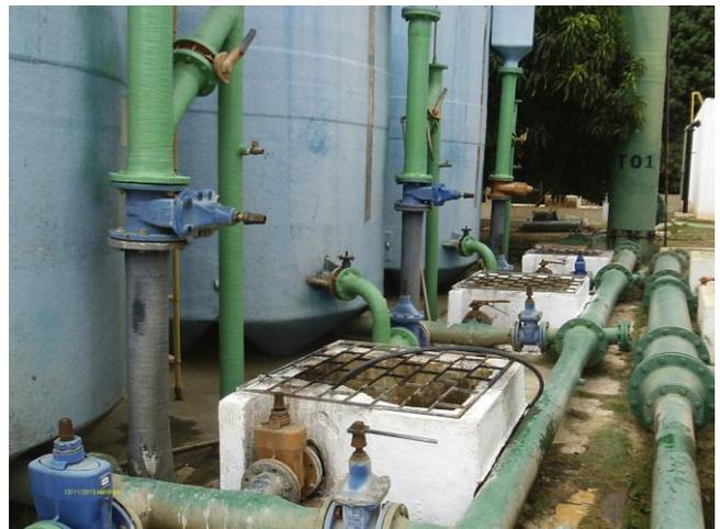
**Foto 10** - Filtração: tubulações e registros dos filtros F-01, F-02, F-03.
