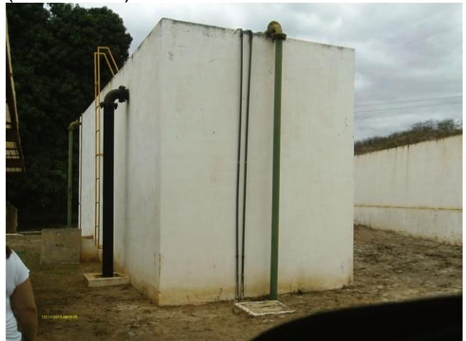
**Foto 22** - Decantador do sistema de reúso de águas de lavagem dos filtros (desativado).
