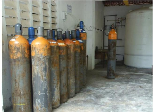
**Foto 26** - Casa de química: cilindros de cloro gasoso armazenados.
