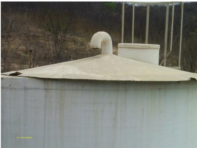
**Foto 15** - Filtração: tampa do filtro F-05 e calha de saída de água.
