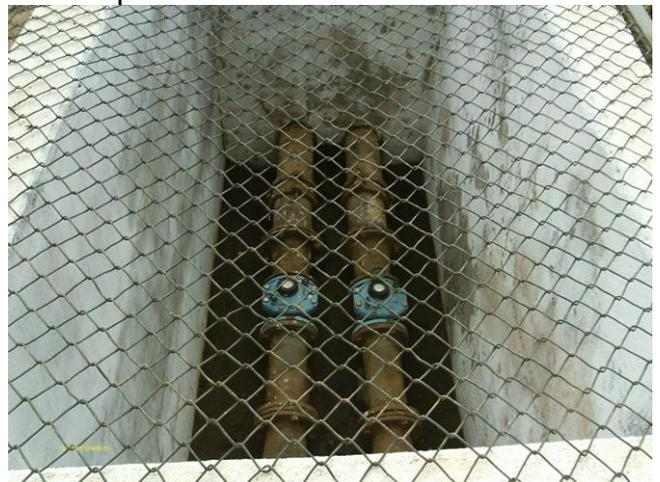
**Foto 70** - Medidores proporcionais instalados na saída dos reservatórios RAP-01 e RAP-03.
