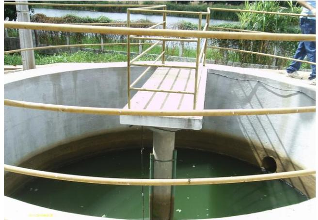
**Foto 20** - Tanque de equalização do sistema de reúso das águas de lavagem dos filtros (desativado).
