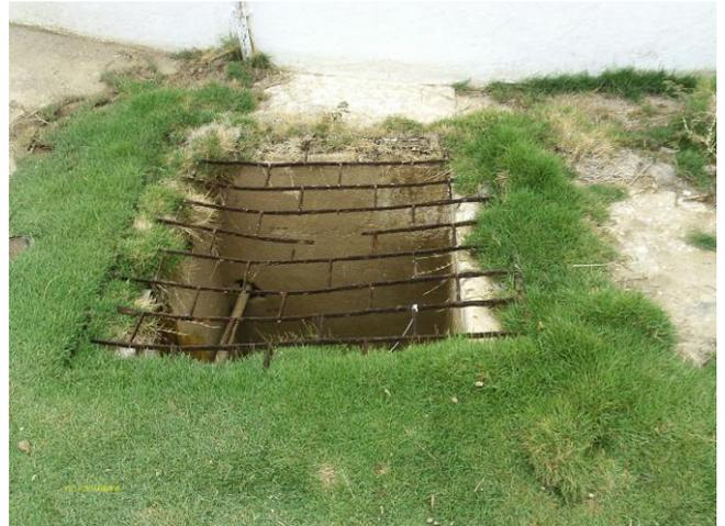
**Foto 68** - Caixa de inspeção com tampa corrida próximo ao RAP-01.
