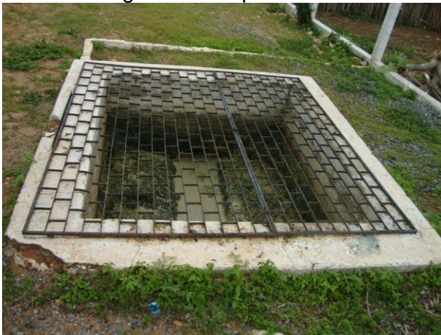
Foto 45 – Caixa da lavagem dos filtros.
