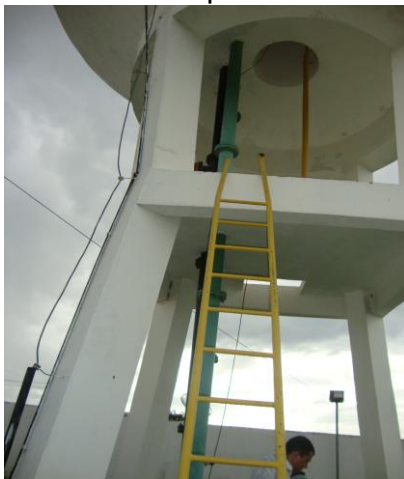
Foto 66 – REL-02: com escada de acesso.
