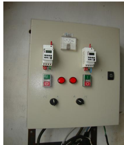
Foto 55 – Quadro de comando do booster-01.
