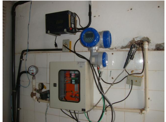
Foto 48 – Medidor eletromagnético de água tratada no interior da ETA.
