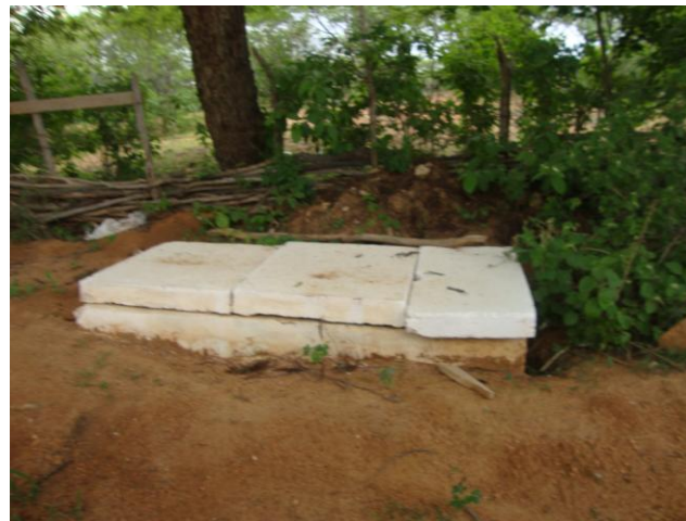
Foto 36 – Caixa de ventosa instalada na adutora de água bruta.
