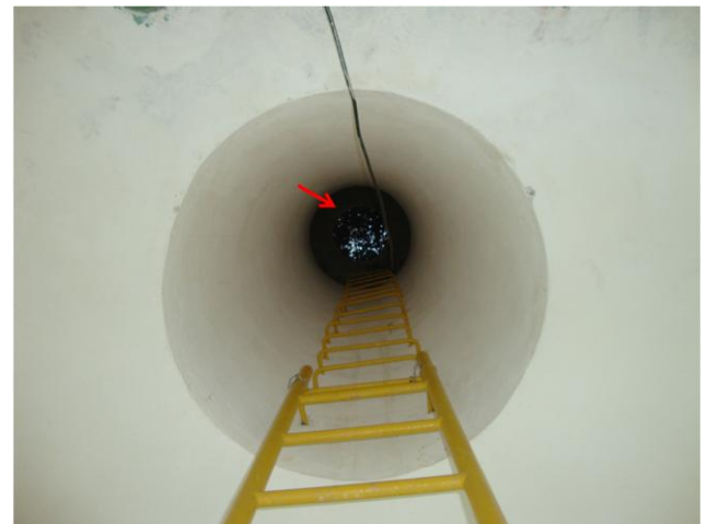
Foto 67 – REL-02: tampa de inspeção e abertura inferior sem tela ou grade.
