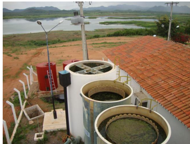
Foto 13 – Vista superior dos flotofiltros e floculadores.
