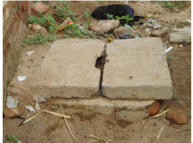
Foto 83 – Registro de descarga na Rua Jesuíta Adeodato.
