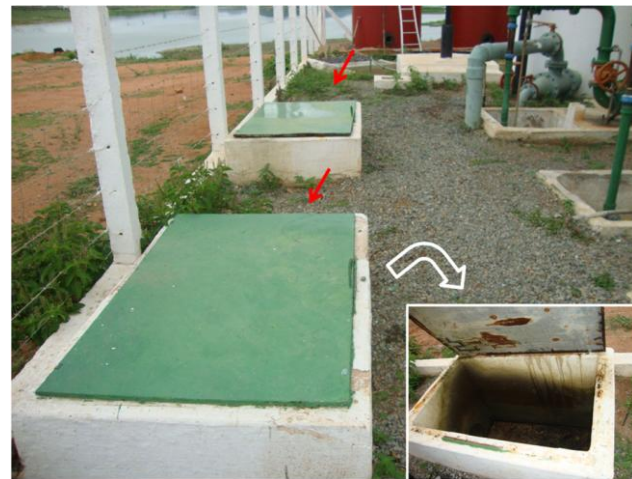
Foto 15 – Descargas dos filtros F-01 e F-02.
