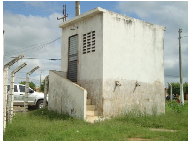
Foto 53 – Casa de abrigo do booster-01.
