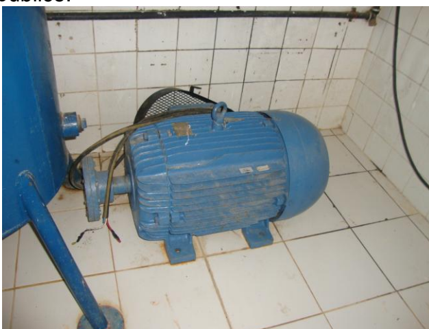
Foto 5 – Bomba reserva da captação.
