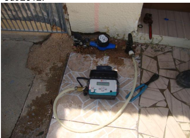
Foto 74 – Medição de pressão na Rua Julieta Alves Timbó, s/n.
