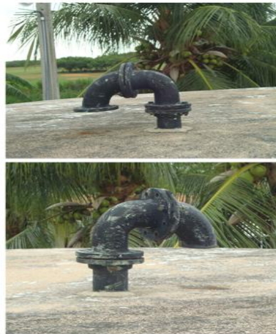
Foto 59 – RAP-01: tubulações de ventilação sem tela de proteção.
