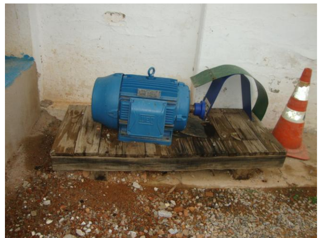
Foto 51 – Bomba reserva da da EEAT-01.
