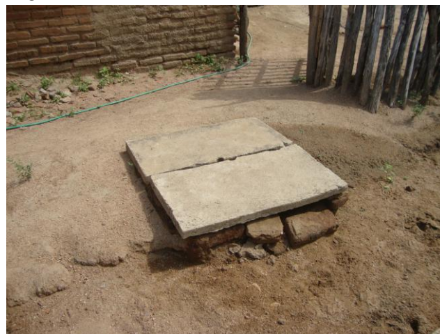
Foto 81 – Registro de descarga na Rua Monte Azul.
