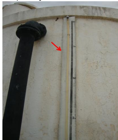
Foto 61 – RAP-01 e RAP-02: medidor de nível.
