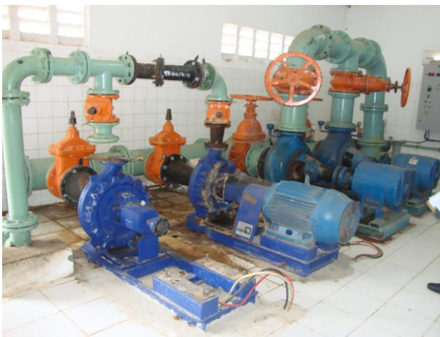
Foto 50 – Conjuntos moto-bombas das elevatórias EEAT-01 e EELF-01.
