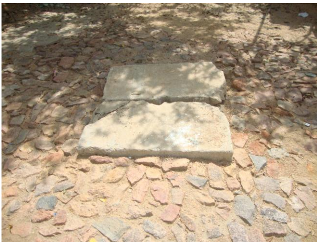
Foto 86 – Registro de descarga na Rua Marechal Deodoro.
