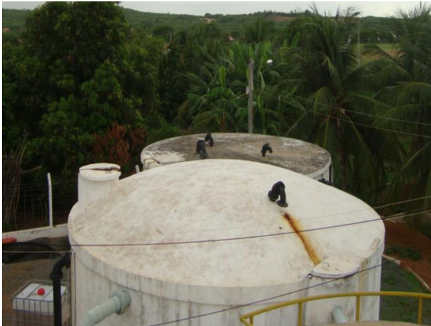
Foto 58 – Vista da cobertura dos RAP-01 e RAP-02.
