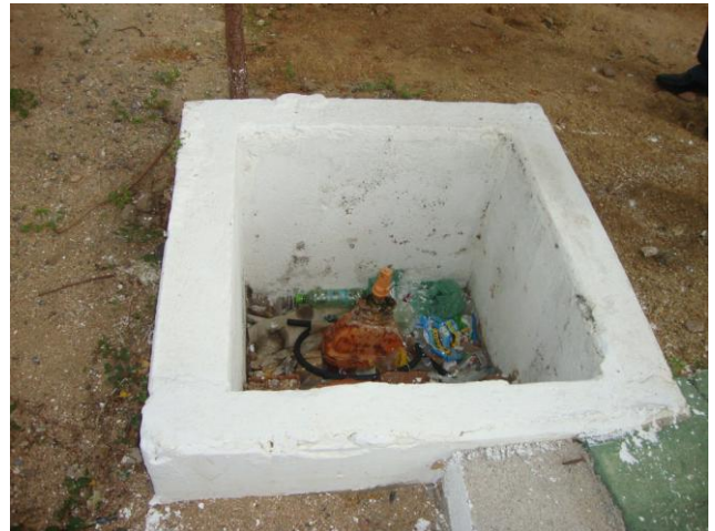
Foto 44 – Caixa de registro instalada na adutora de água tratada próximo ao REL-01.
