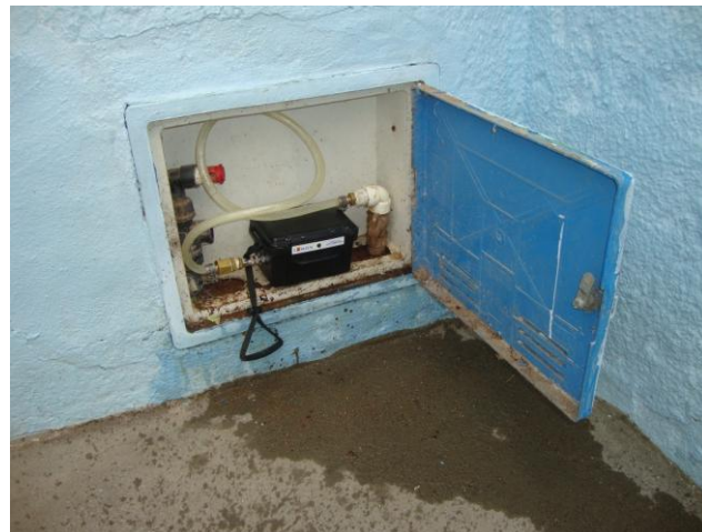
Foto 79 – Medição de pressão com instalação às 15:00h do dia 20/01/14 e retirada às 15:00h do dia 21/01/14, com aparelho datalogger na Rua Dr. José Borges, nº 51.
