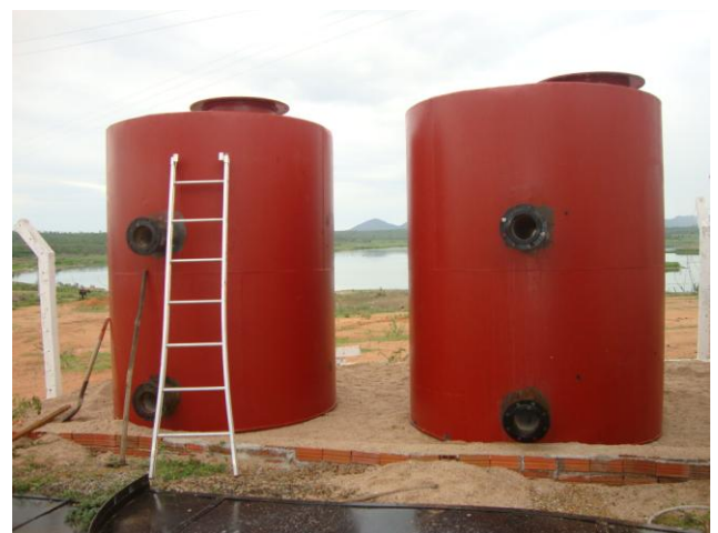
Foto 11 – 2 (dois) filtros de pressão em processo de implantação.
