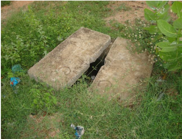
Foto 41 – Caixa de registro instalada na adutora de água tratada próximo ao REL-02.
