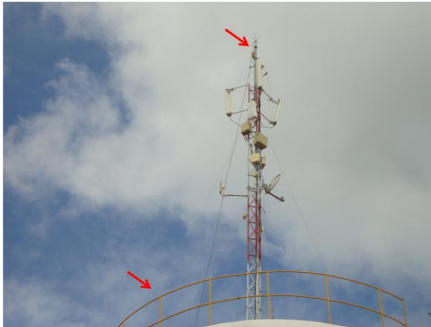
Foto 64 – REL-01: guarda-corpos, sinalizador noturno e para-raios.
