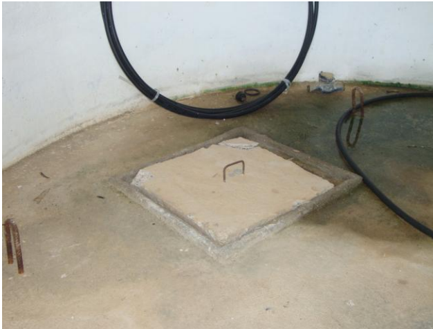
Foto 70 – REL-03: tampa de inspeção.
