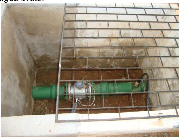
Foto 37 – Macromedidor de água bruta na chegada da ETA.
