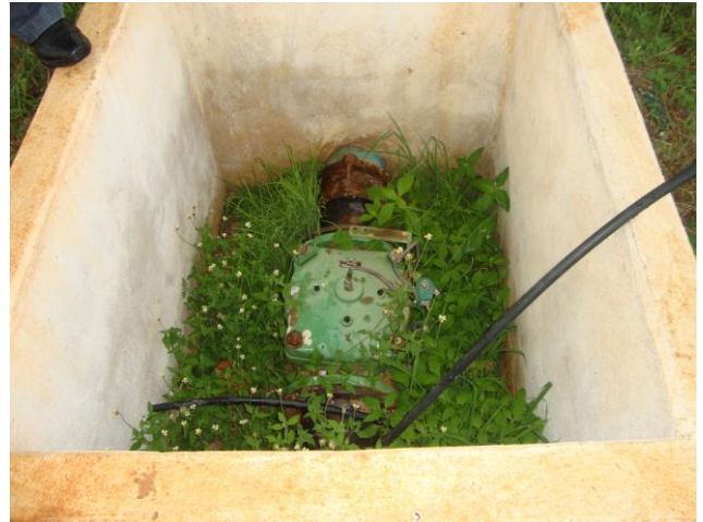
Foto 42 – Caixa de controle na saída do REL-01.
