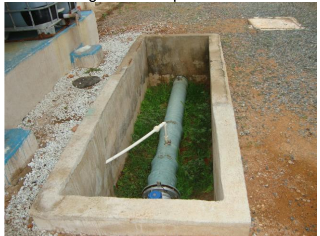
Foto 46 – Caixa do macromedidor de água tratada na saída da ETA.
