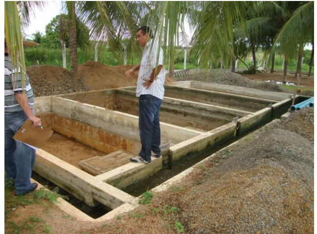
Foto 19 – Leito de secagem em implantação.
