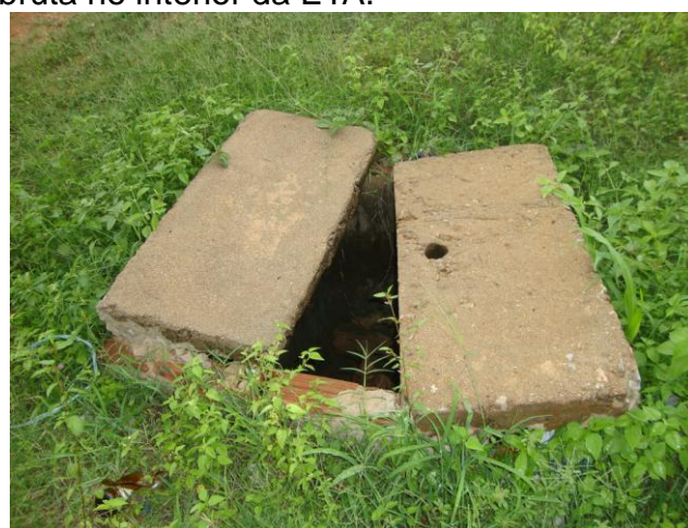
Foto 40 – Caixa de registro instalado na adutora de água tratada próximo ao REL-02.
