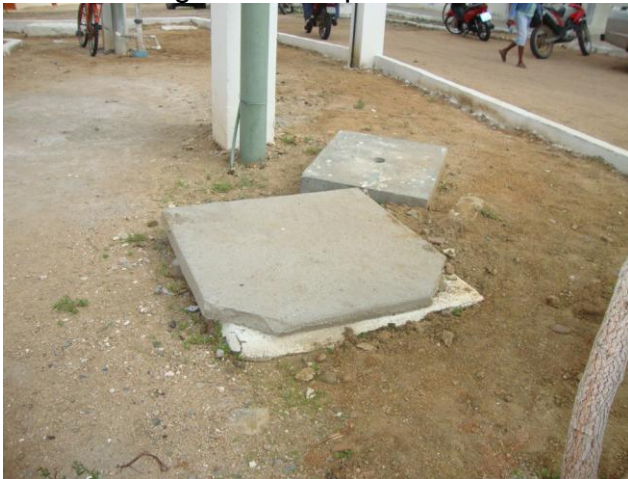
Foto 43 – Caixa de registro instalada na adutora de água tratada próximo ao REL-01.
