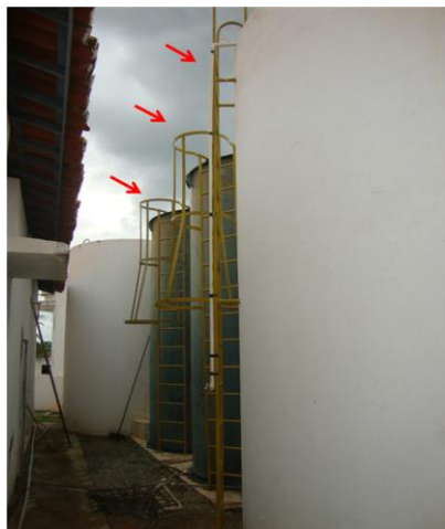
Foto 14 – Flotofiltros e floculadores com escada de acesso.
