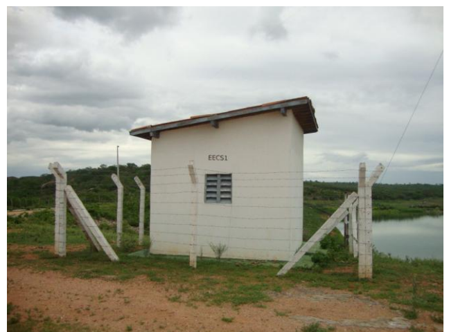
Foto 6 – Casa de abrigo do quadro de comando da EECS-01.
