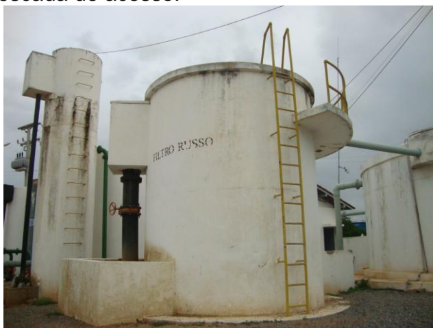
Foto 16 – Vista do filtro russo ascendente e da torre de nível.
