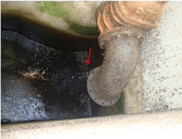
Foto 18 – Filtro Russo com vazamento no registro.
