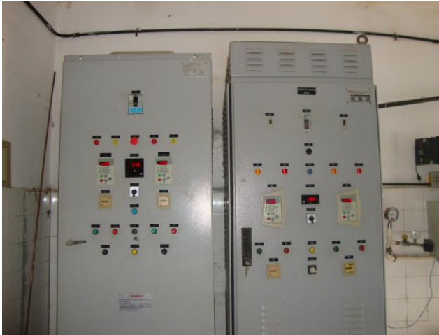
Foto 52 – Quadros de comando da EEAT-01 e EELF-01.
