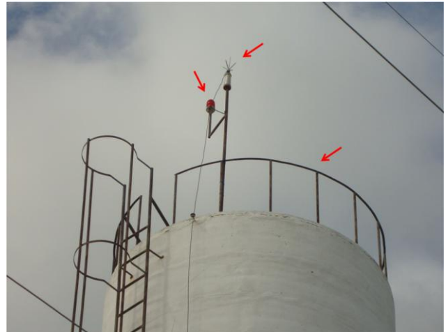
Foto 71 – REL-03: guarda-corpos, sinalizador noturno e para-raios.
