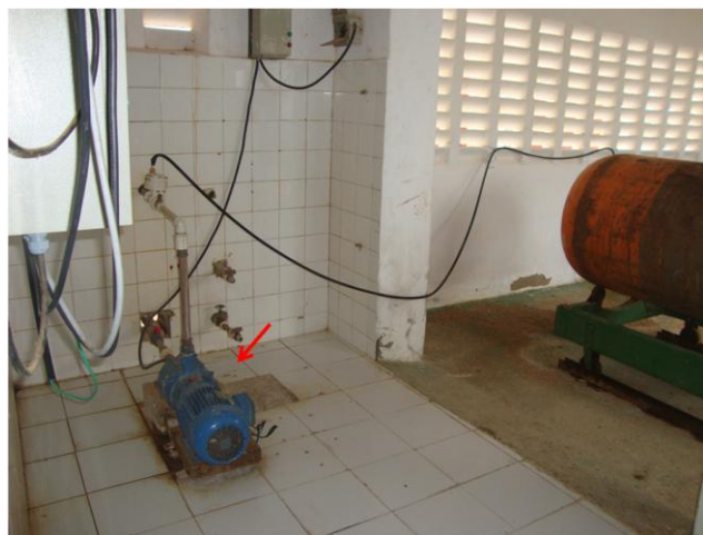
Foto 26 – Bomba dosadora do cloro gasoso.
