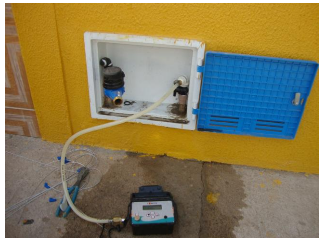
Foto 73 – Medição de pressão na Rua Franklin Cavalcante, s/n.
