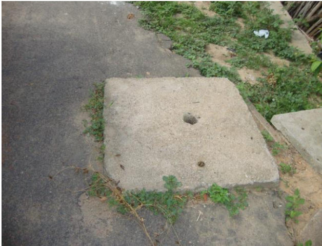
Foto 82 – Registro de descarga na Rua Dr. José Rangel Borges.
