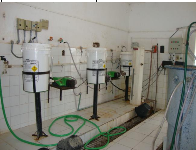
Foto 22 – Tanques dosadores de PAC e polímetro.
