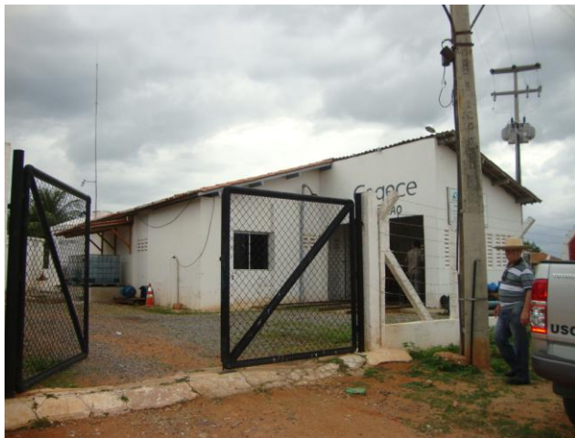
Foto 8 – Vista externa da ETA.
