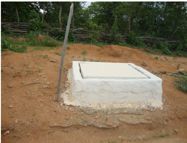
Foto 35 – Caixa de descarga na adutora de água bruta.
