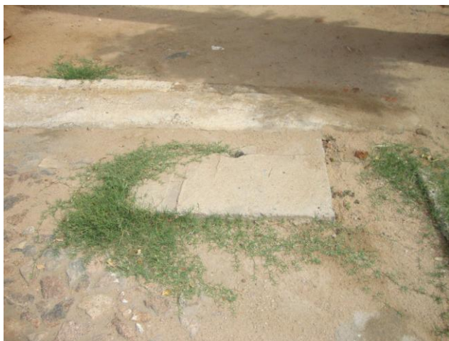
Foto 80 – Registro de descarga na Rua Campo São Cristóvão.
