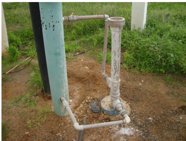
Foto 24 – Clorador de pastilha no REL-02.
