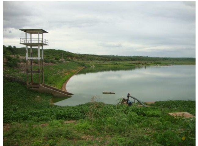
Foto 2 – Área destinada a captação.
