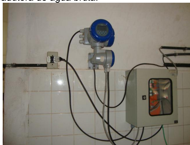
Foto 38 – Medidor eletromagnético de água bruta no interior da ETA.
