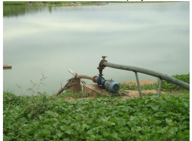
Foto 4 – Moto-bomba da captação.
