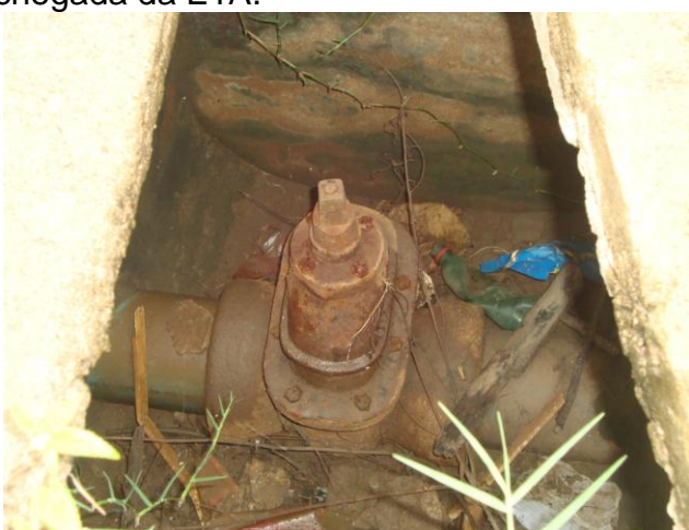
Foto 39 – Registro instalado na adutora de água tratada próximo ao REL-02.
