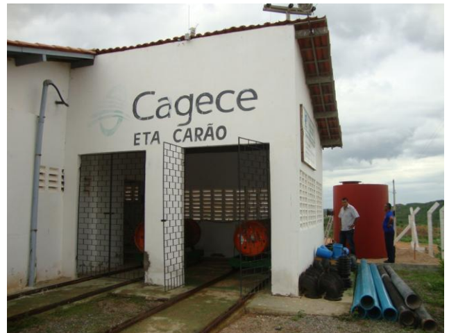
Foto 9 – Vista interna da ETA.
