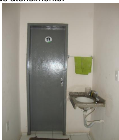
Foto 91 – Instalações sanitárias disponíveis para funcionários e usuários.
