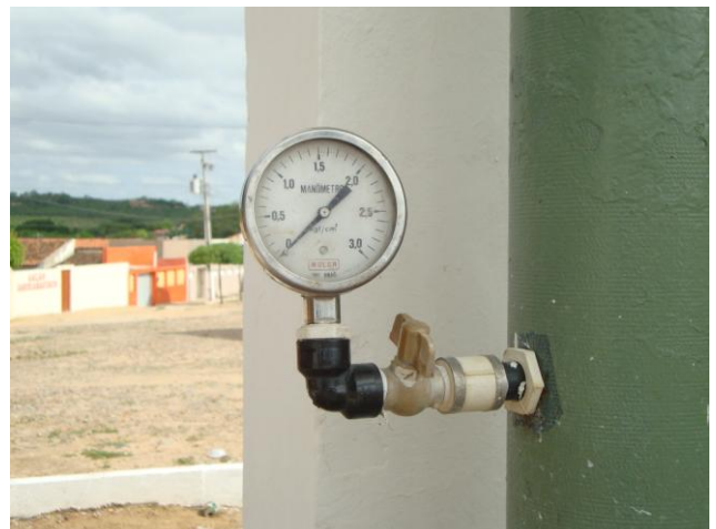
Foto 63 – REL-01: medidor de nível.
