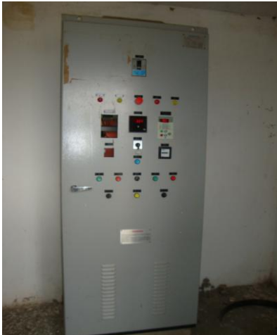
Foto 7 – Quadro de comando da EECS-01.
