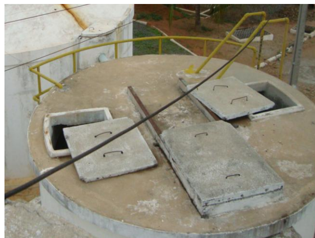
Foto 17 – Vista superior do filtro russo ascendente.
