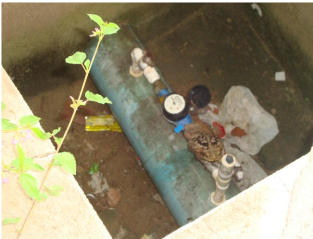
Foto 49 – Macromedidor de água tratada na saída do REL-02.
