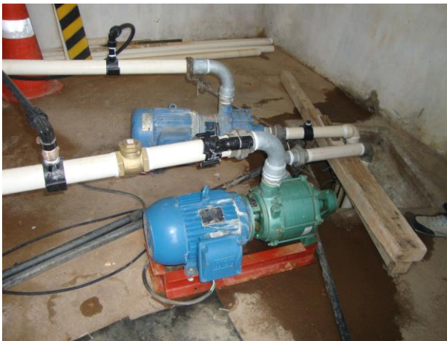
Foto 54 – Conjunto moto-bomba do booster-01.
