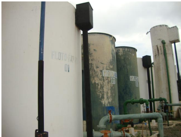
Foto 12 – Vista dos flotofiltros e floculadores.
