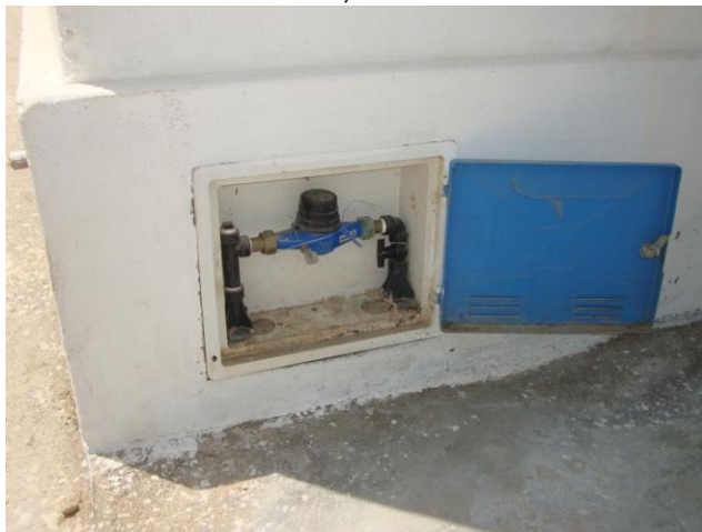
Foto 78 – Medição de pressão na Rua Monte Azul nº 235.
