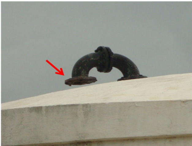
Foto 60 – RAP-02: tubulação de ventilação sem tela de proteção.
