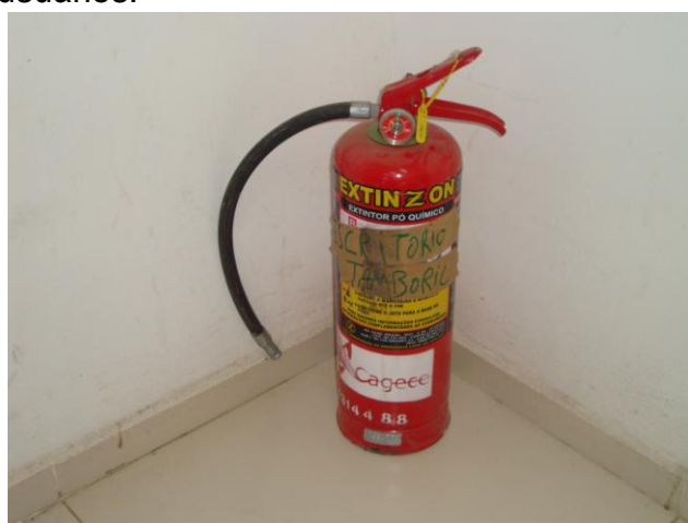
Foto 92 – Extintor de incêndio da loja de atendimento com validade até ago/2014.
