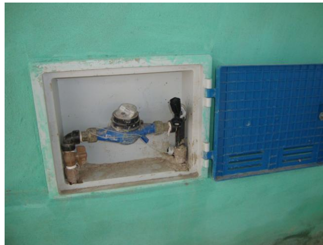
Foto 77 – Medição de pressão na Rua Monte Azul nº 243.
