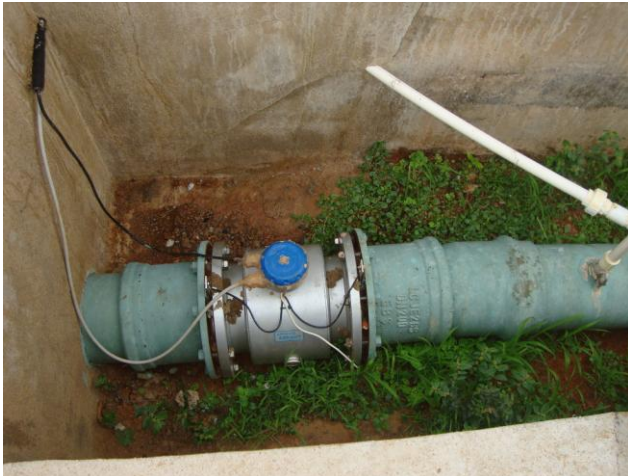
Foto 47 – Macromedidor de água tratada na saída da ETA.
