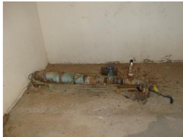
Foto 8 – PT-03: tubulação de recalque.
