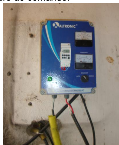
Foto 12 – PT-04: quadro de comando.
