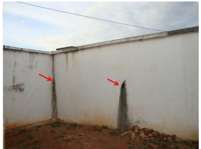
Foto 39 – Infiltrações na parede do RAP-01.
