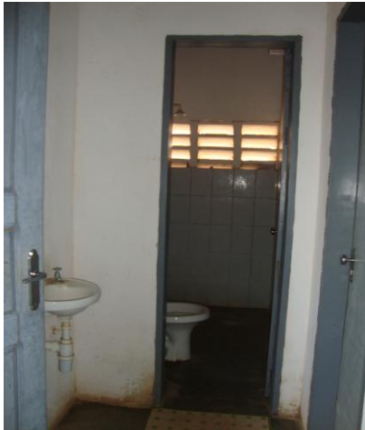
Foto 64 – Instalações sanitárias disponíveis para funcionários e usuários.
