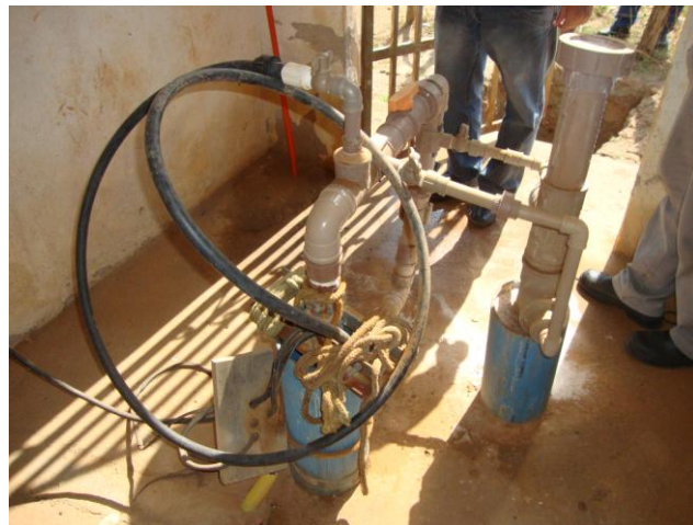
Foto 14 – PT-06: tubulação de recalque com clorador de pastilha.
