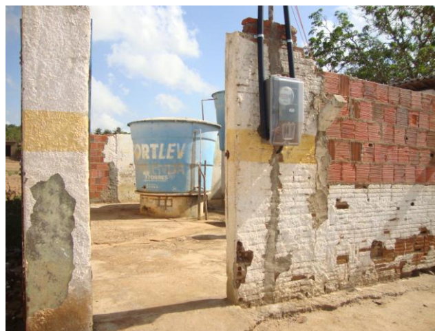
Foto 16 – Poço do Chafariz: casa de abrigo do poço, quadro de comando e ausência de identificação.
