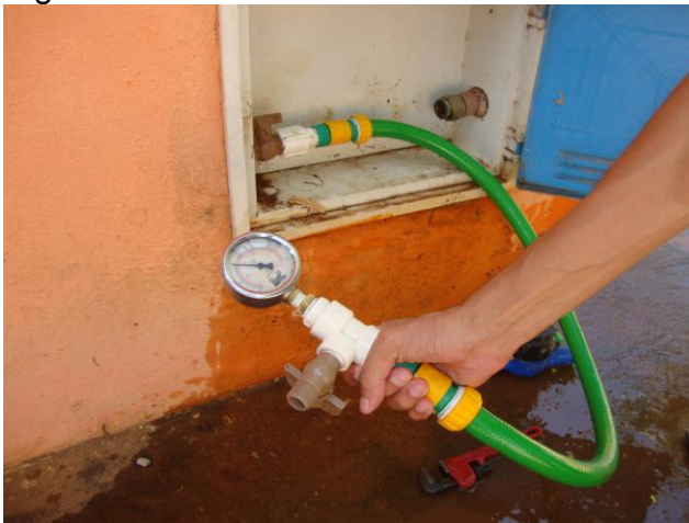
Foto 49 – Medição de pressão na Rua Vicente Torres de Oliveira, FNS-433, Centro.
