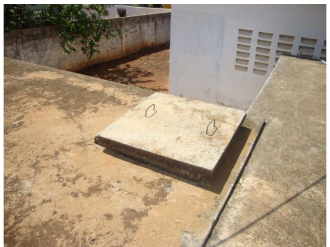
Foto 41 – Tampa de inspeção do RAP-01.
