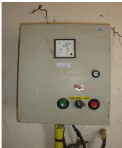
Foto 9 – PT-03: quadro de comando.
