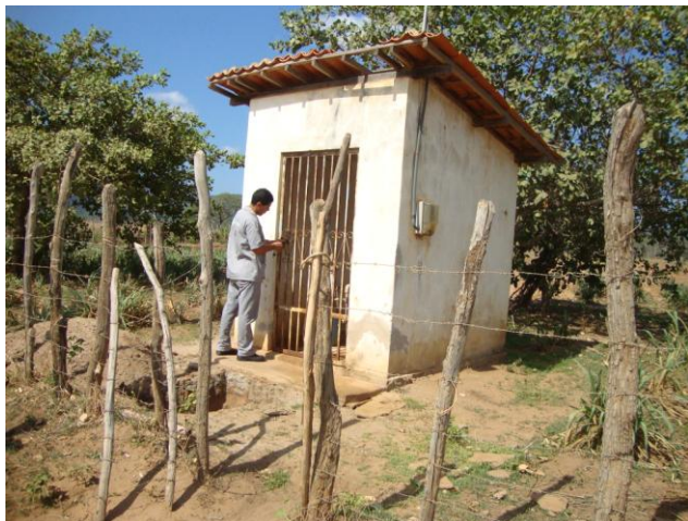
Foto 13 – PT-06: casa de abrigo do poço, quadro de comando e ausência de identificação.
