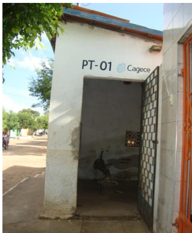
Foto 1 – PT-01: casa de abrigo do poço e do quadro de comando.
