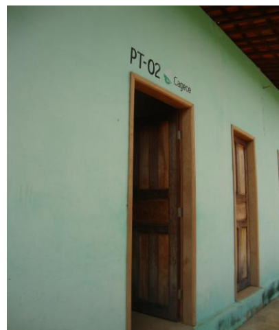
Foto 4 – PT-02: casa de abrigo do poço e do quadro de comando.
