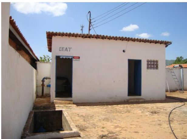
Foto 35 – Prédio de abrigo das elevatórias EEAT-01 e EEAT-02 com identificação incompleta.
