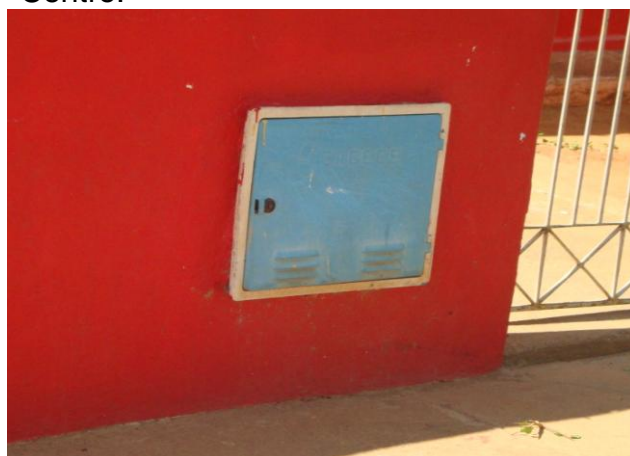
Foto 52 – Medição de pressão na Rua Pinto Basto, s/n – Centro (saída da ETA).
