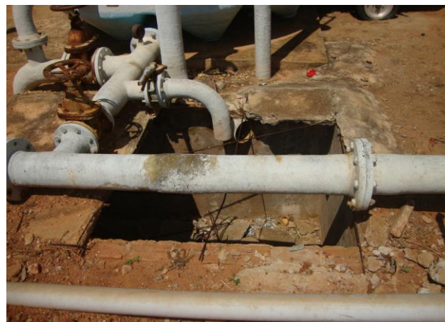
Foto 34 – Caixa de registro desativada na área do tratamento sem tampa ou grade de proteção.
