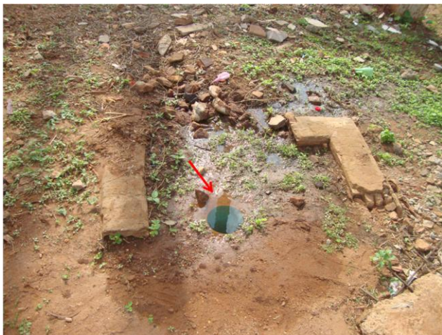
Foto 31 – Registro sem caixa instalada na adutora de água tratada na área do REL-01, sem tampa ou grade de proteção.
