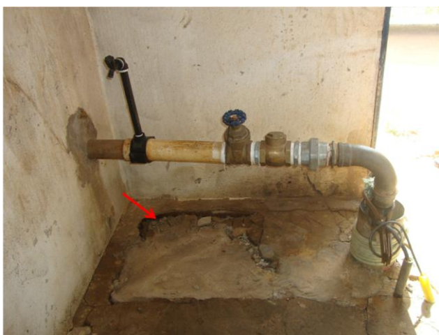
Foto 11 – PT-04: tubulação de recalque e piso com estrutura danificada.
