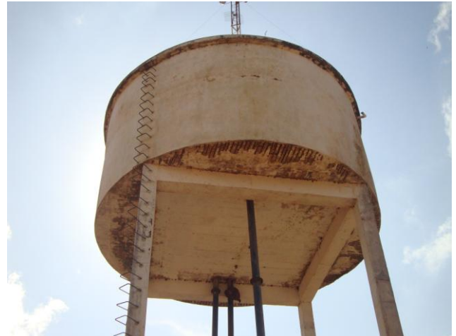
Foto 43 – REL-01: Pintura e reboco deteriorados, armadura exposta e infiltração na laje.
