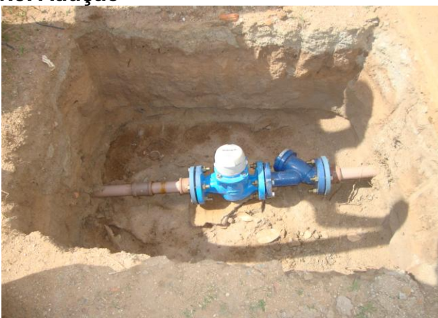
Foto 29 – Macromedidor de água bruta na saída do PT-06, sem tampa ou grade de proteção.
