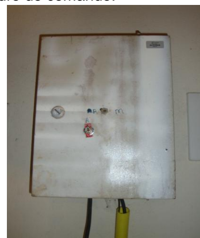
Foto 6 – PT-02: quadro de comando.
