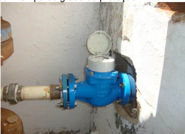
Foto 33 – Macromedidor de água tratada na saída do tratamento.
