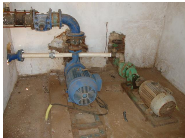
Foto 36 – Conjuntos moto-bombas das elevatórias EEAT-01 e EEAT-02.
