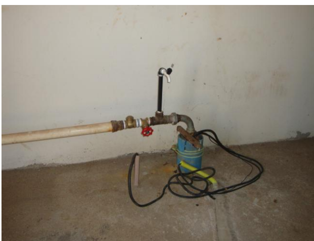
Foto 5 – PT-02: tubulação de recalque.
