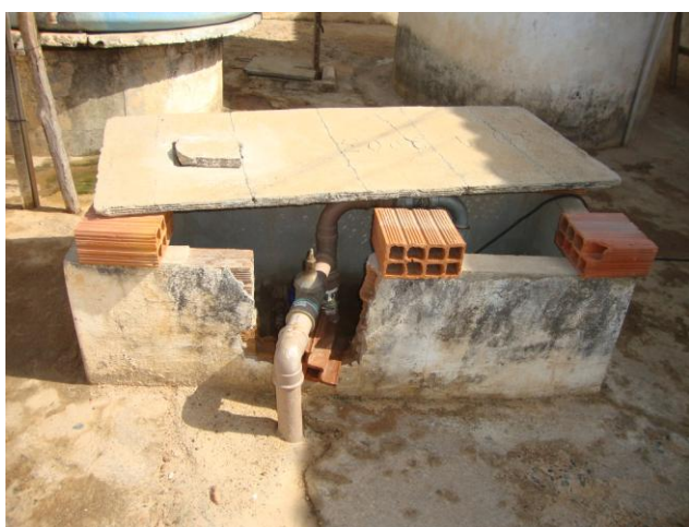
Foto 17 – Poço do Chafariz: tubulação de recalque.
