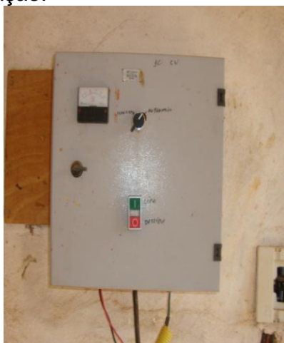
Foto 15 – PT-06: quadro de comando.
