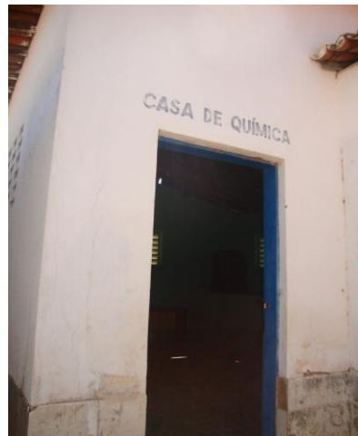
Foto 20 – Vista da casa de química.
