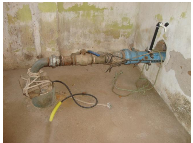
Foto 2 – PT-01: tubulação de recalque.
