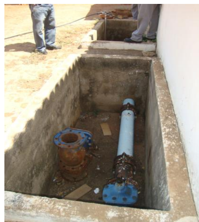
Foto 30 – Caixa de registro instalada na adutora de água tratada na área do tratamento, sem tampa ou grade de proteção.
