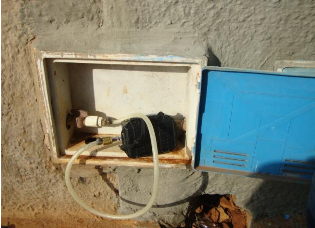
Foto 53 – Medição de pressão com instalação às 16:30h do dia 22/01/14 e retirada às 16:30h do dia 23/01/14, com aparelho datalogger na Rua Borete Morão, nº 85.
