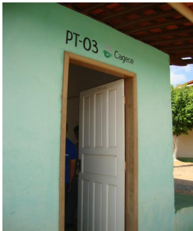
Foto 7 – PT-03: casa de abrigo do poço e do quadro de comando.
