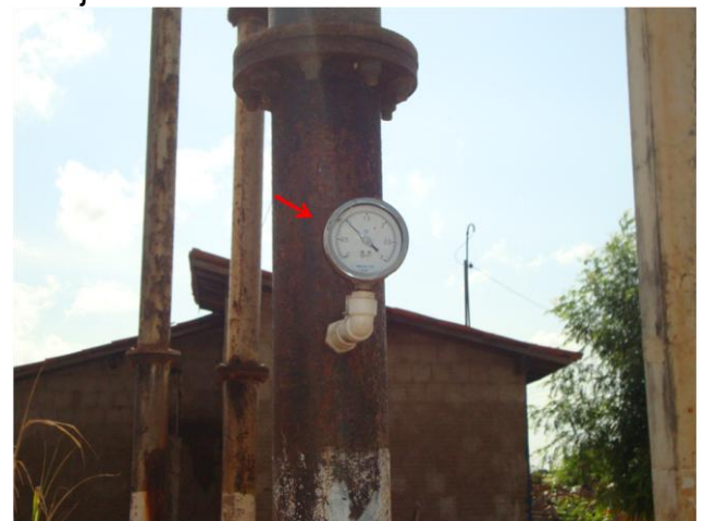
Foto 45 – RAP-01: medidor de nível.
