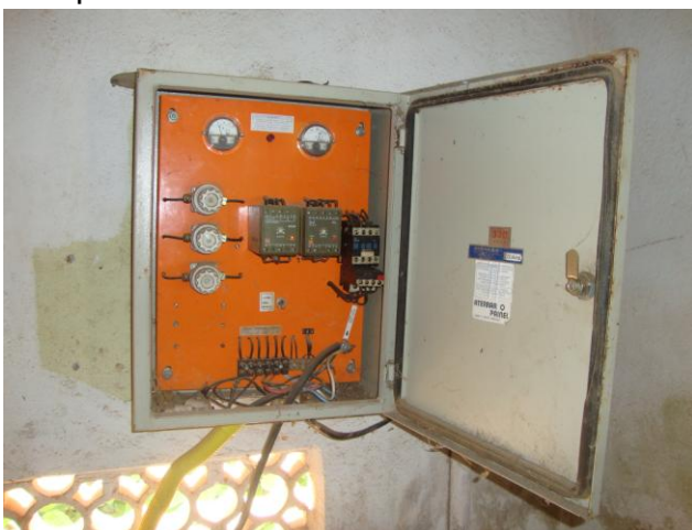
Foto 3 – PT-01: quadro de comando.
