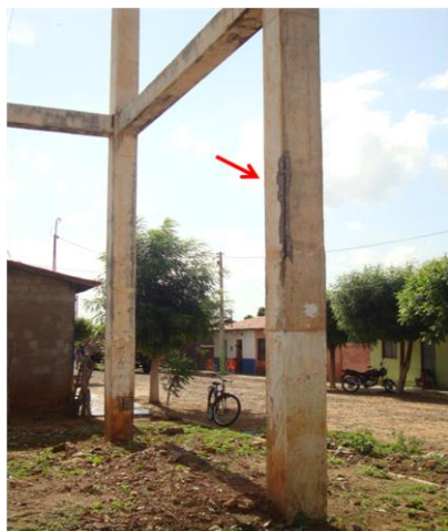
Foto 44 – REL-01: armadura exposta.
