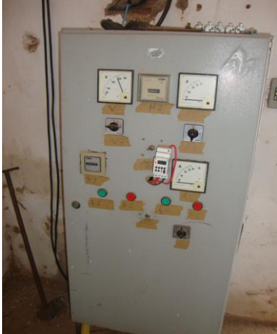
Foto 37 – Quadro de comando das EEAT-01 e EEAT-02.
