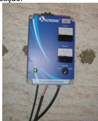
Foto 18 – Poço do Chafariz: quadro de comando.
