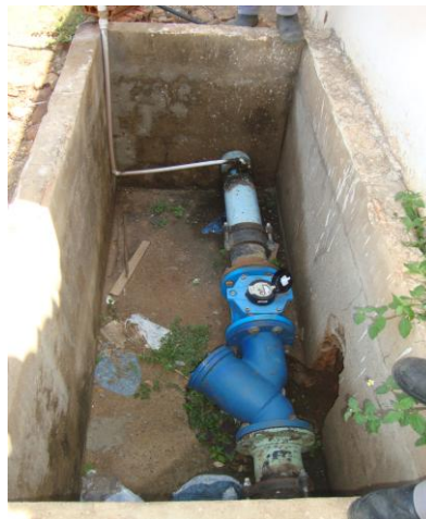
Foto 32 – Macromedidor de água tratada na saída do tratamento.
