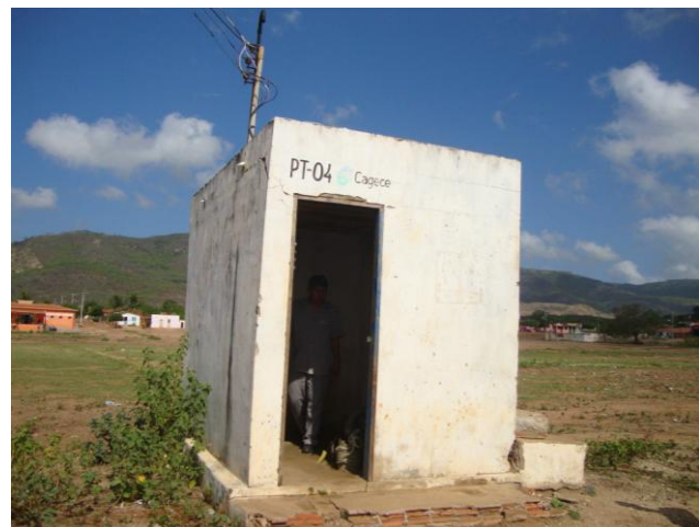
Foto 10 – PT-04: casa de abrigo do poço e do quadro de comando.
