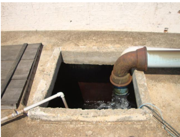
Foto 40 – Tampa de inspeção do RAP-01.
