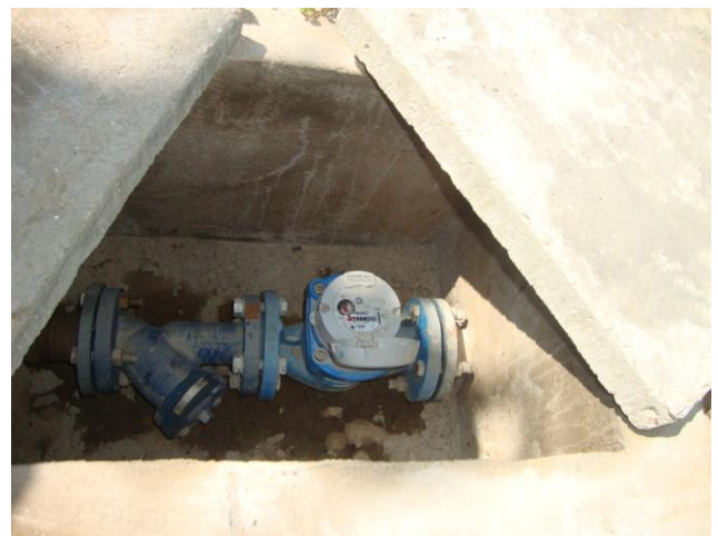
Foto 23 – Caixa do macromedidor de água bruta na saída do PT-04.
