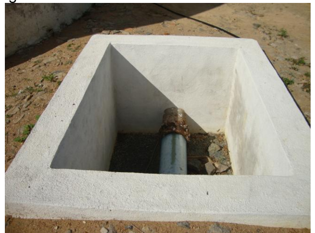
Foto 29 – Caixa de estação pitométrica de água tratada na entrada da ETA.
