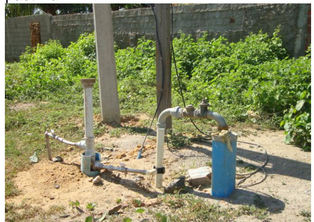
Foto 6 – PT-06: vista geral com clorador de pastilha.
