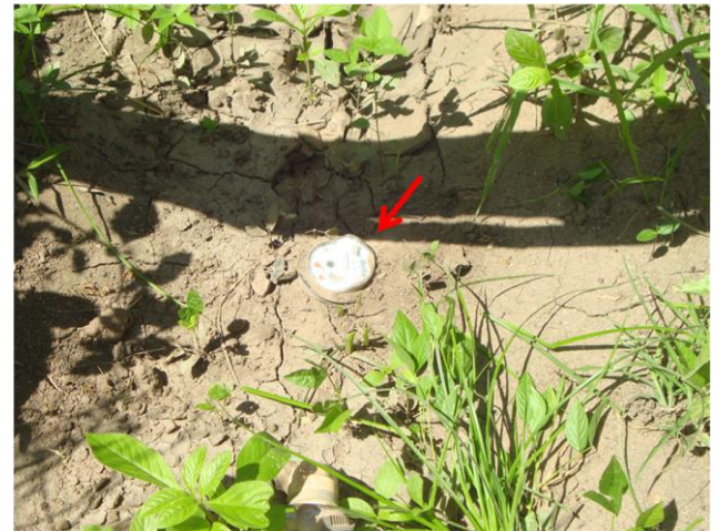
Foto 33 – Macromedidor de água bruta na saída do PR-01.
