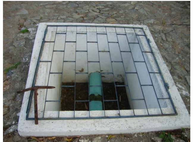
Foto 27 – Caixa de estação pitométrica de água bruta na entrada da ETA.
