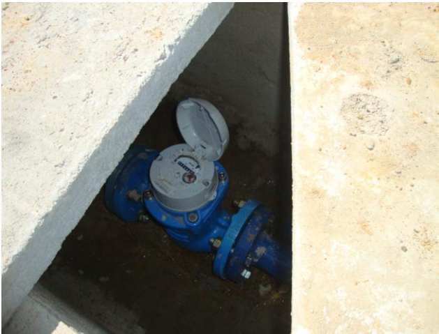
Foto 26 – Caixa do macromedidor de água bruta na saída do PT-08.
