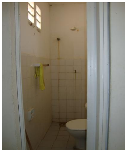
Foto 62 – Instalações sanitárias disponíveis para funcionários e usuários.
