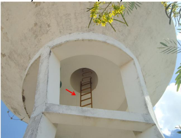
Foto 44 – REL-01: escada de acesso.
