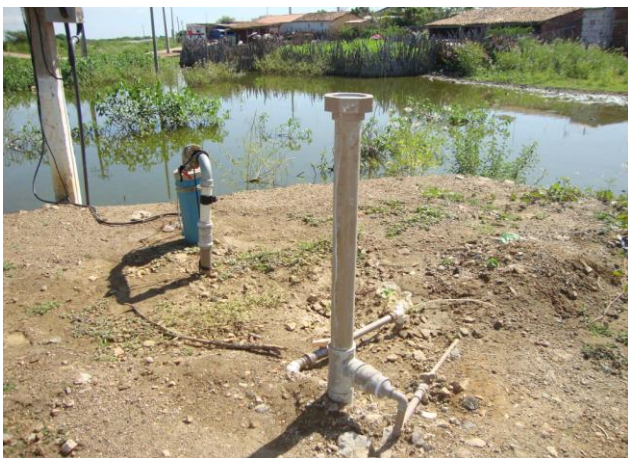
Foto 5 – PT-05: próximo a área alagada por águas pluviais e águas servidas oriundas das residências.
