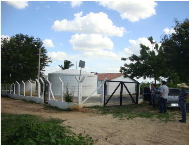
Foto 12 – Vista externa da ETA.
