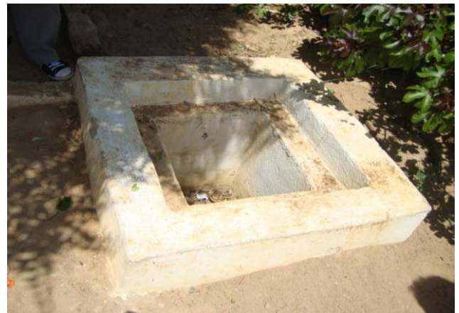
Foto 56 – Registro de descarga na Rua Julieta Alves Timbó.
