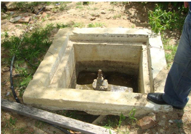
Foto 55 – Registro de descarga na Rua João José de Castro (próximo a ETA).
