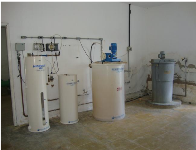
Foto 14 – Dosador de cloro parado e produtos químicos.
