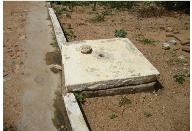
Foto 54 – Registro de descarga na Rua Travessa Livino Teixeira – Poço Escuro.
