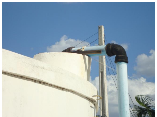
Foto 41 – RAP-01: com tampa de inspeção.
