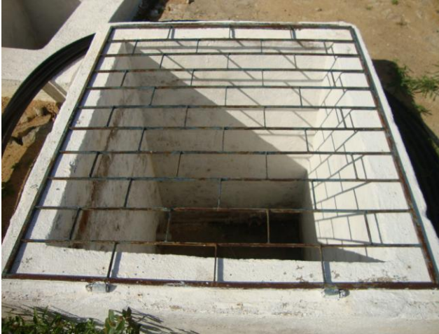
Foto 30 – Caixa de descarga de água tratada na entrada da ETA.
