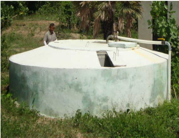
Foto 36 – Vista do Poço de Reunião PR-01.
