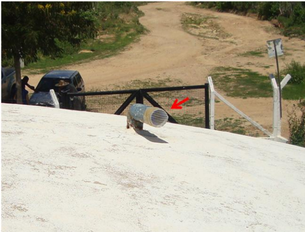
Foto 42 – RAP-01: tubulações de ventilação com tela de proteção.
