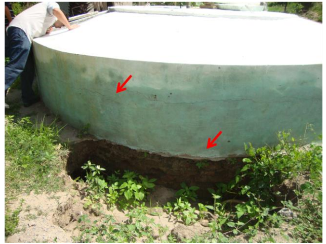
Foto 37 – PR-01 com erosão e rachaduras na parede lateral.
