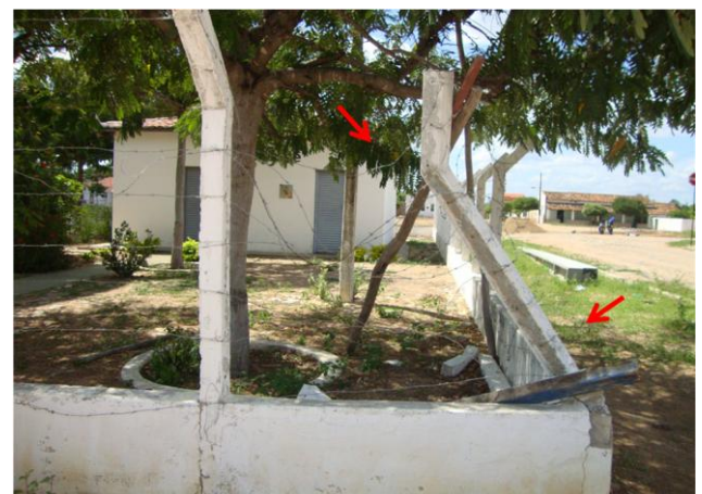
Foto 58 – Vista externa do escritório/loja de atendimento com cerca danificada.
