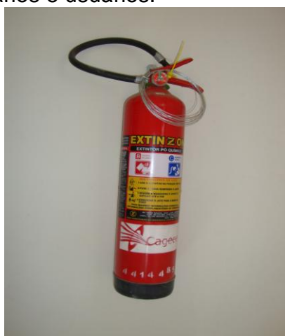
Foto 63 – Extintor de incêndio da loja de atendimento com validade até ago/2014.
