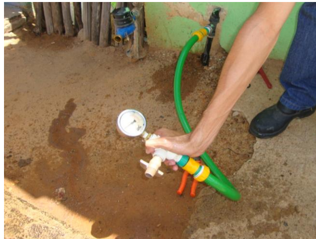
Foto 50 – Medição de pressão na Rua Julieta Alves Timbó, s/n.
