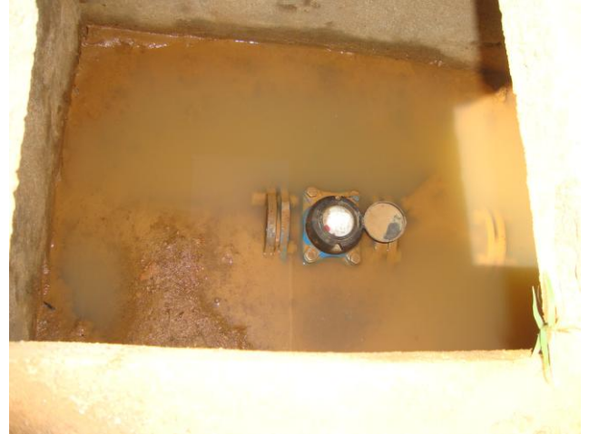
Foto 25 – Caixa do macromedidor de água bruta na saída do PT-06 e PT-07.
