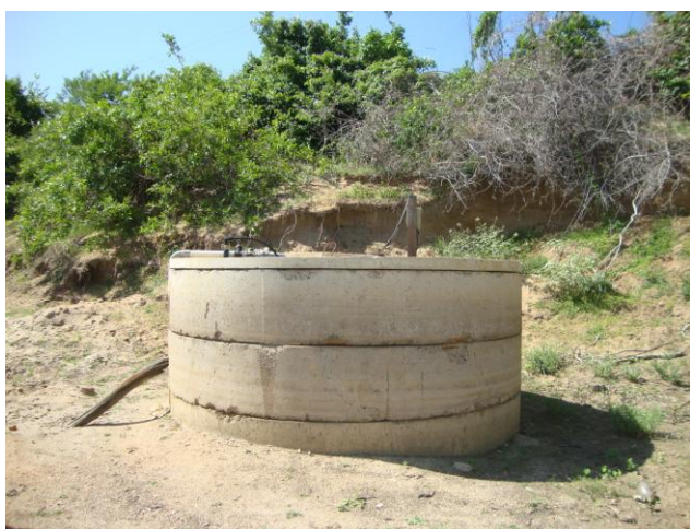
Foto 11 – PA-02: vista geral.
