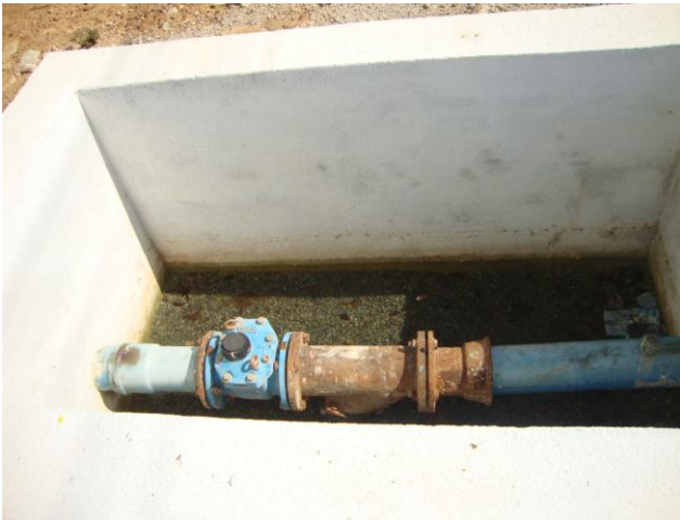
Foto 32 – Macromedidor de água tratada na saída do REL-01.
