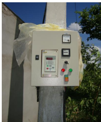
Foto 10 – PA-01: quadro de comando.
