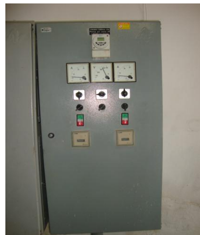
Foto 35 – Quadro de comando da EEAT-01.
