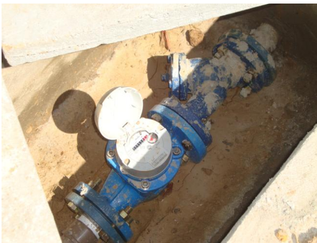
Foto 22 – Caixa do macromedidor de água bruta na saída do PT-03.
