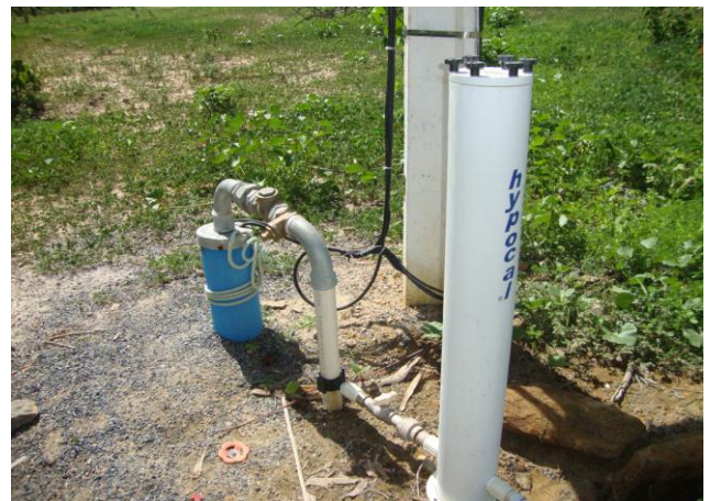
Foto 4 – PT-04: vista geral com clorador de pastilha.
