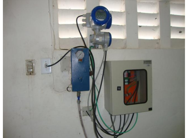
Foto 31 – Medidor eletromagnético de água tratada no interior da ETA.
