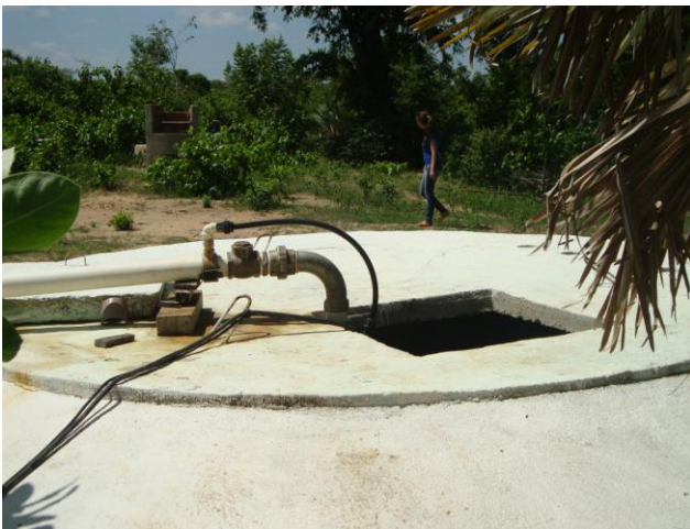
Foto 38 – PR-01 sem tampa de inspeção.
