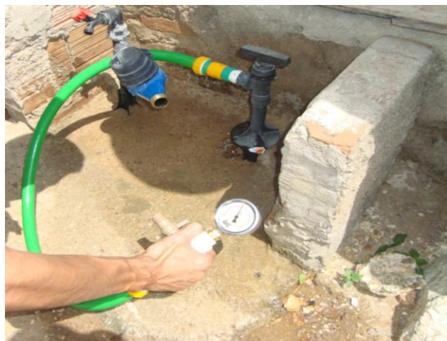
Foto 48 – Medição de pressão na Travessa Livino Teixeira, nº22.
