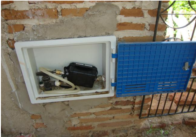
Foto 53 – Medição de pressão com instalação às 14:30h do dia 21/01/14 e retirada às 14:30h do dia 22/01/14, com aparelho datalogger na Rua Ciro Otávio, nº 446.
