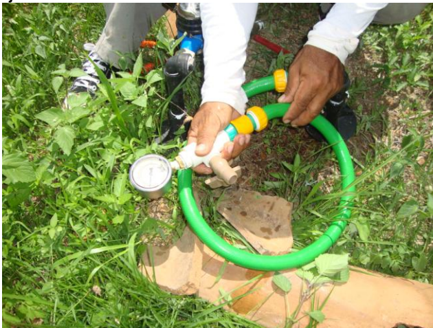
Foto 49 – Medição de pressão na Rua João José de Castro, s/n.
