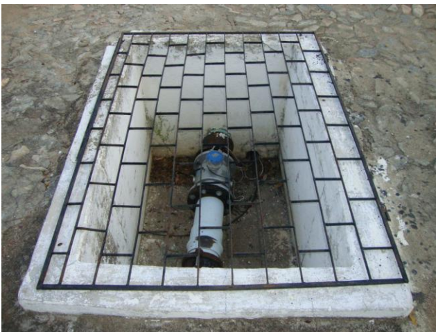
Foto 28 – Caixa do macromedidor de água bruta na entrada da ETA.
