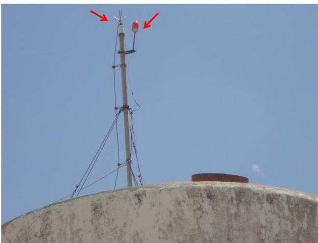
Foto 46 – REL-01: para-raios e sinalizador noturno.
