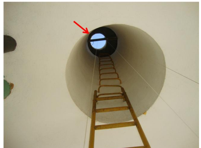
Foto 45 – REL-01: tampa de inspeção e abertura inferior sem tela ou grade.
