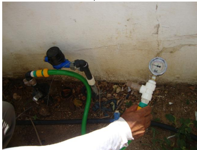
Foto 52 – Medição de pressão na Av. João Pereira Torres (Posto Poty).
