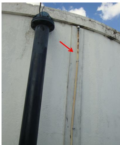
Foto 40 – RAP-01: medidor de nível.
