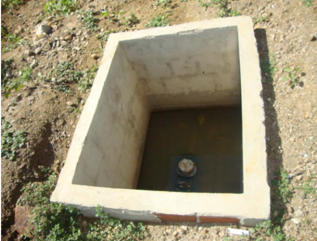
Foto 24 – Caixa do macromedidor de água bruta na saída do PT-05.
