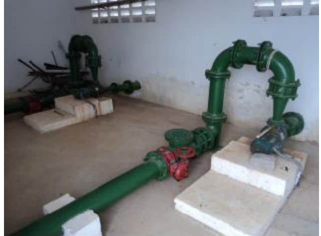
Foto 4 – EEAB-01: conjunto moto-bomba.
