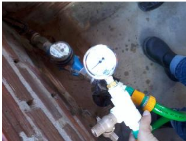
Foto 52 – RDA: medição instantânea de pressão na Rua Irmã Moraes, 1082.
