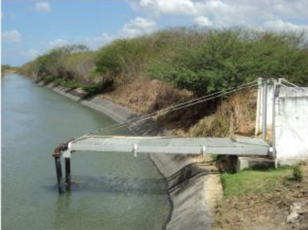
Foto 1 – Canal do Trabalhador: vista geral da captação.
