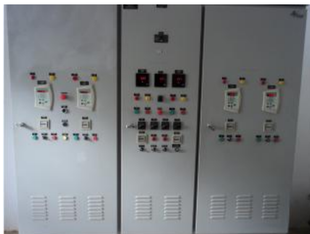
Foto 37 – EEAT-01 e EELF-01: quadro de comando.
