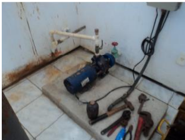
Foto 18 – Casa de química: bomba na casa de cloro gasoso.
