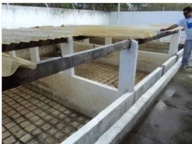
Foto 27 – ETA: leitos de secagem.
