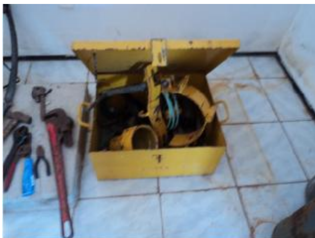
Foto 19 – Casa de química: KIT de emergência dentro da casa de cloro gasoso.
