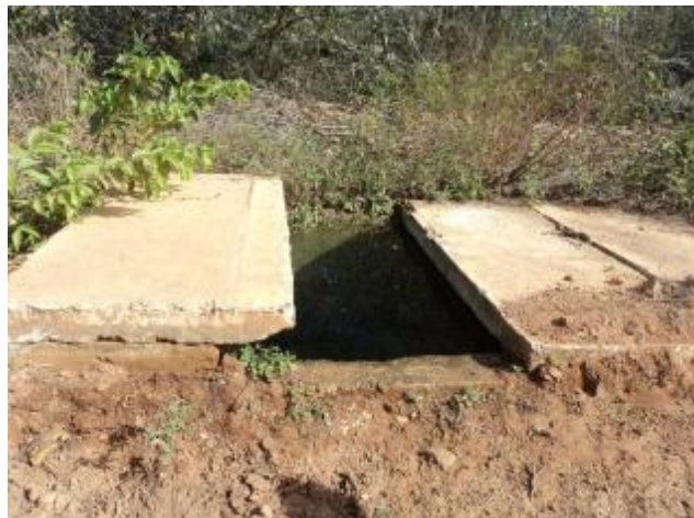
Foto 32 – AAT: caixa de ventosa com acúmulo de água (1).
