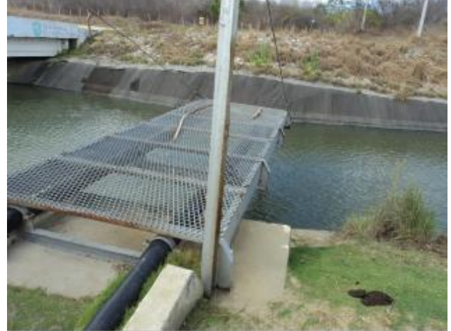
Foto 2 – Canal do Trabalhador: vista geral da captação.
