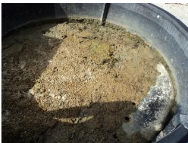
Foto 9 – Floculador: bandejas com presença de materiais sólidos.
