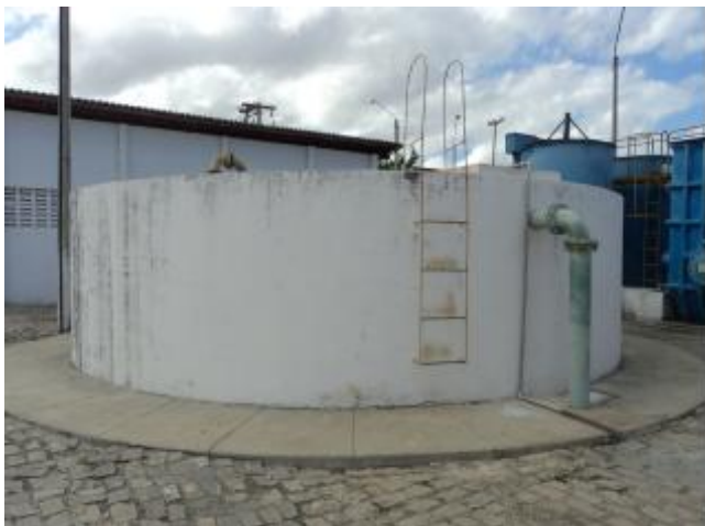
Foto 39 – RAP-01: escada e ausência de identificação.
