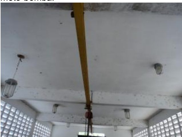
Foto 38 – EEAT-01 e EELF-01: sem iluminação.
