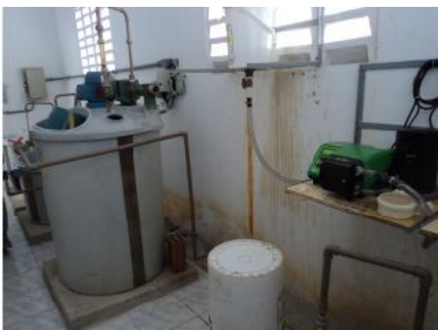
Foto 15 – Casa de química: tanques dosadores.
