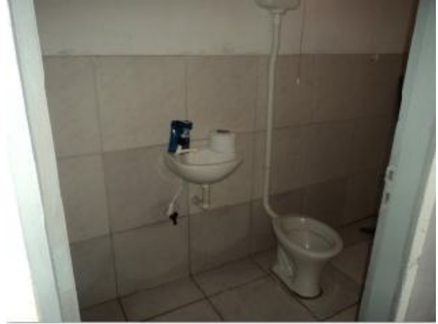
Foto 58 – Loja de atendimento: instalações sanitárias.
