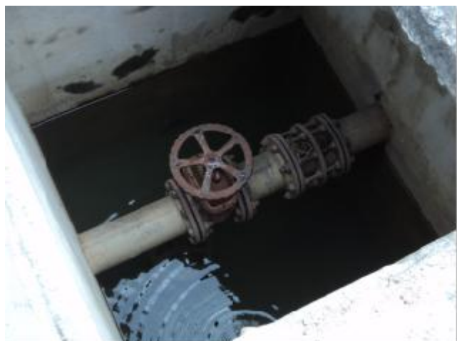
Foto 41 – RAP-01: registro com vazamento.
