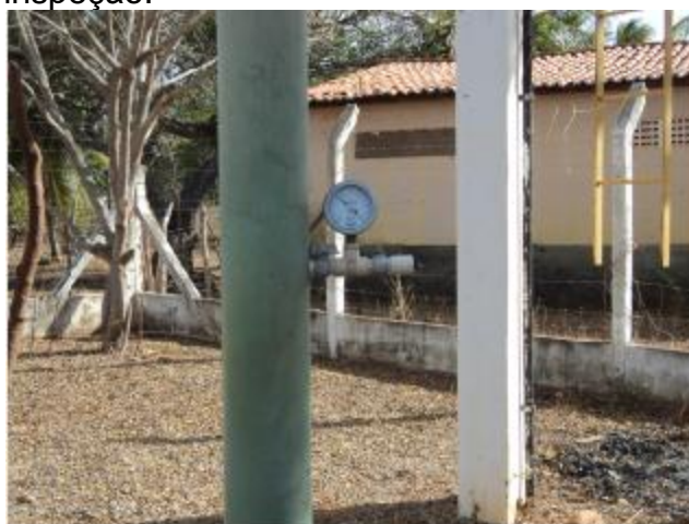
Foto 48 – REL-01: medidor de nível.
