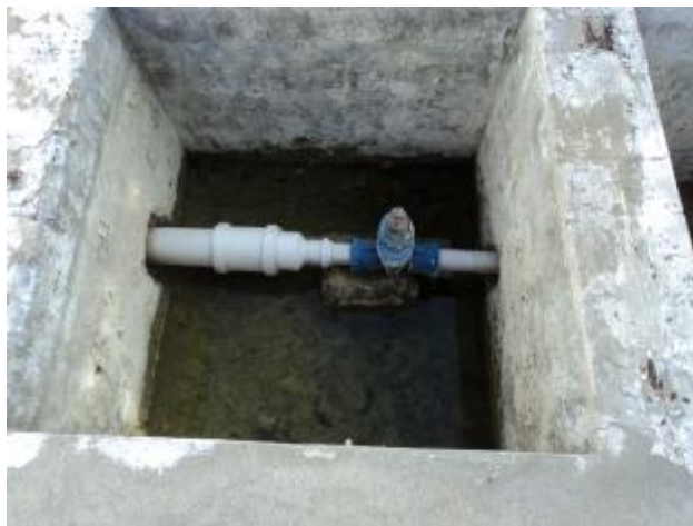
Foto 30 – ETA: caixa do registro com acúmulo de água e sem grade de proteção.
