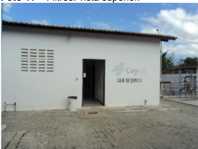
Foto 13 – Casa de química: área de acesso.
