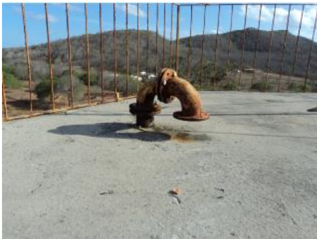
Foto 45 – REL-01: tubulação de ventilação sem tela de proteção.
