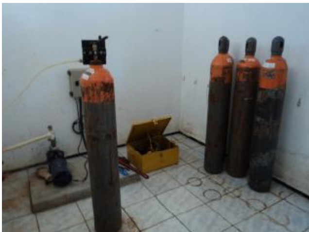
Foto 17 – Casa de química: cloro gasoso.
