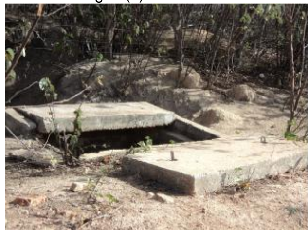
Foto 34 – AAT: caixa de registro.
