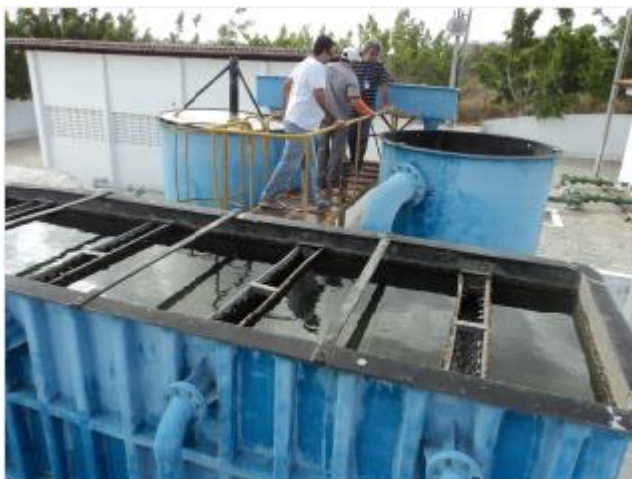
Foto 8 – ETA: vista superior do floculador hidráulico e do decantador laminar.
