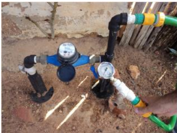
Foto 51 – RDA: medição instantânea de pressão na Rua do Jatobá, SMS 28.
