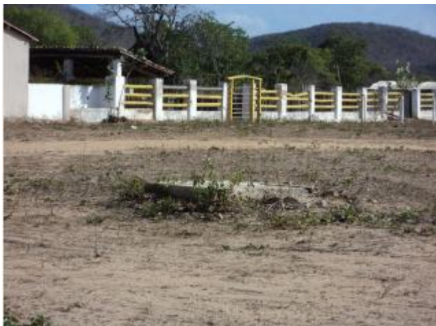
Foto 35 – AAT: caixa de ventosa.
