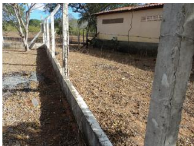
Foto 43 – REL-01: cerca danificada.
