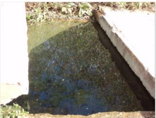
Foto 33 – AAT: caixa de ventosa com acúmulo de água (2).
