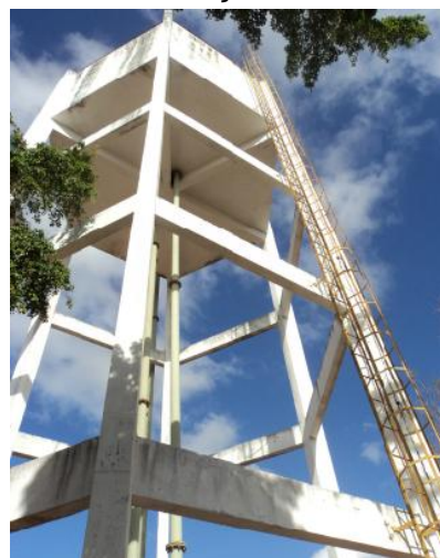
Foto 44 – REL-01: escada e guarda-corpo.
