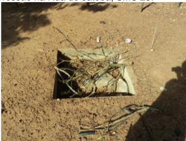
Foto 53 – RDA: registro de descarga na Rua do Jatobá, SMS 28.
