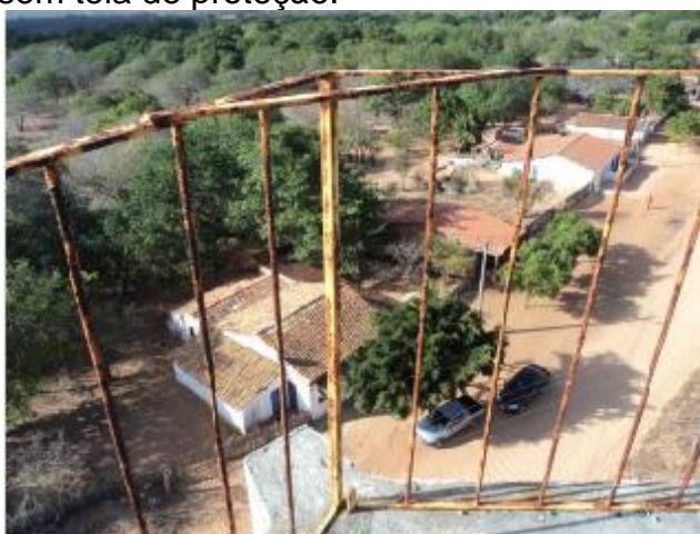
Foto 47 – REL-01: guarda-corpo da laje de cobertura em processo de corrosão.
