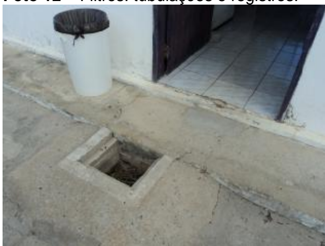
Foto 14 – Casa de química: caixa na entrada da casa de química sem tampa ou grade de proteção.
