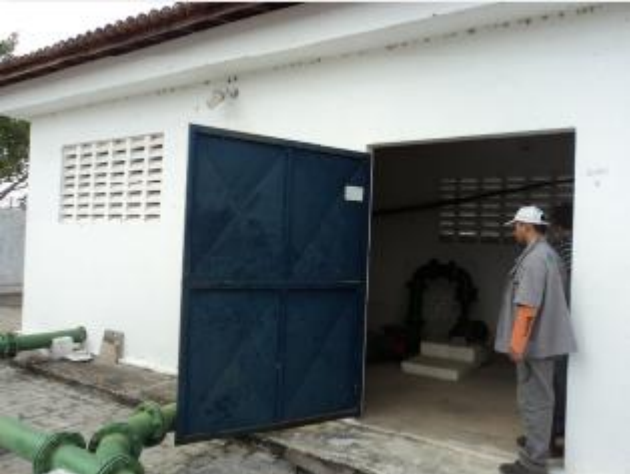
Foto 3 – EEAB-01: casa de abrigo.
