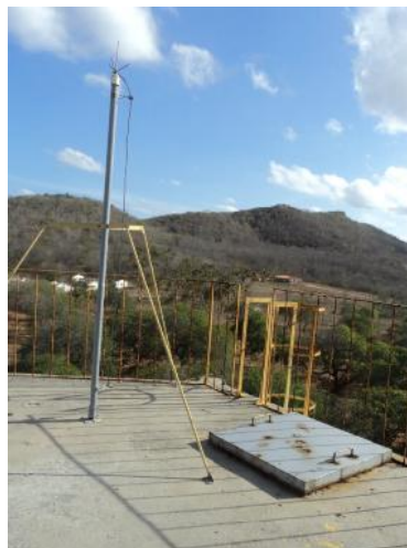
Foto 46 – REL-01: para-raios e tampa de inspeção.
