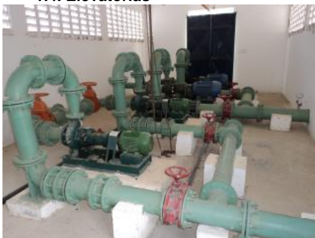
Foto 36 – EEAT-01 e EELF-01: conjunto moto-bomba.
