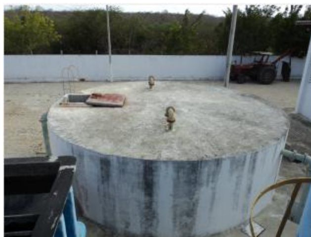
Foto 40 – RAP-01: tampa de inspeção em processo de corrosão e tubulações de ventilação sem tela de proteção.
