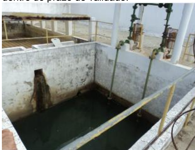
Foto 26 – ETA: tanque de retrolavagem dos filtros desativado.
