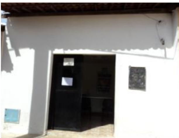
Foto 55 – Loja de atendimento: vista externa.
