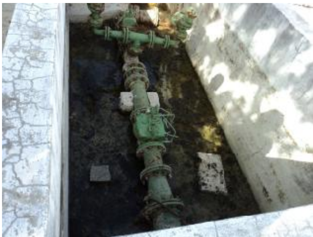
Foto 29 – ETA: caixa de ventosa e válvula de retenção com acúmulo de água e sem grade de proteção.
