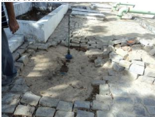
Foto 28 – ETA: registro sem caixa de proteção.
