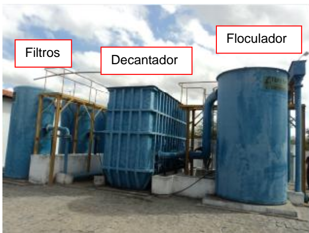
Foto 7 – ETA: vista geral do tratamento.
