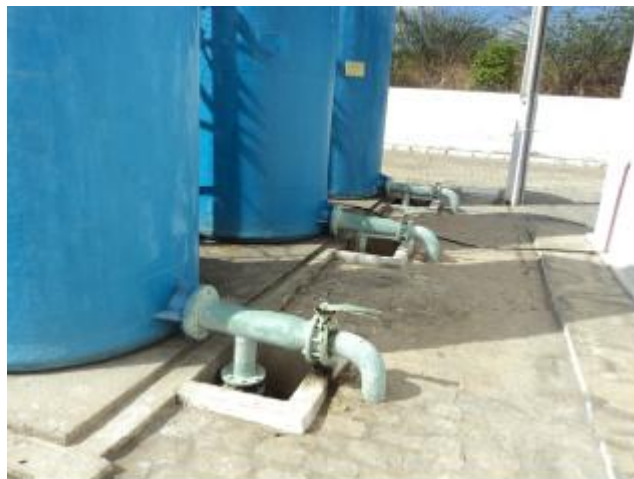
Foto 12 – Filtros: tubulações e registros.
