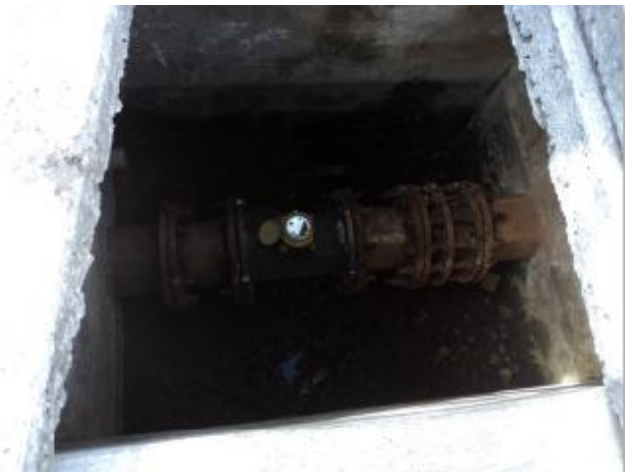
Foto 31 – AAT: macromedidor sem funcionar.
