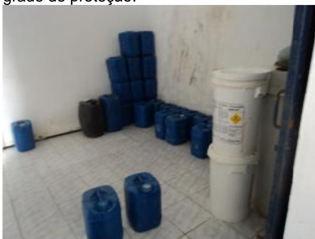
Foto 16 – Casa de química: armazenamento de produtos químicos.
