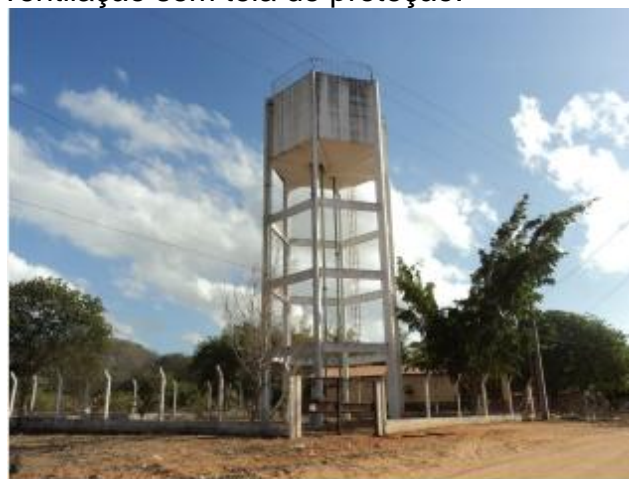
Foto 42 – REL-01: área de acesso e ausência de identificação.
