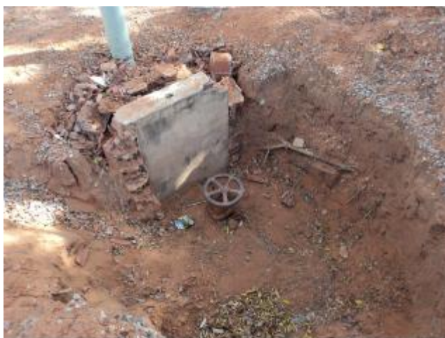
Foto 49 – REL-01: registro sem caixa.
