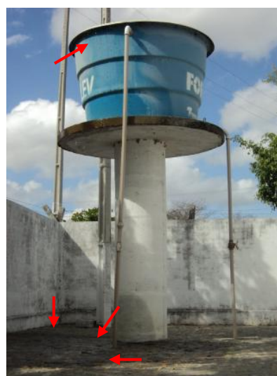
Foto 50 – Caixa d'água: ausência de controle de nível e transbordamento.
