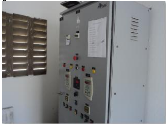
Foto 30 – EEE-03: quadro de comando das bombas.
