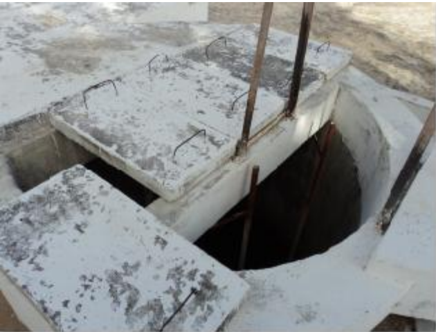
Foto 29 – EEE-03: poço de sucção sem tampa sem o cesto para reter os materiais sólidos.
