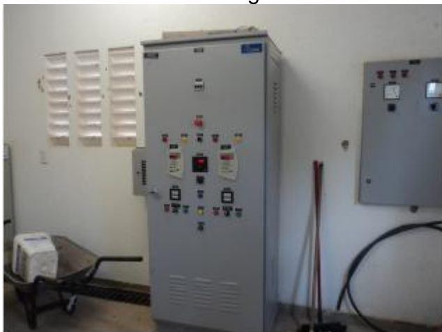
Foto 61 – EEE-12: quadro de comando das bombas.
