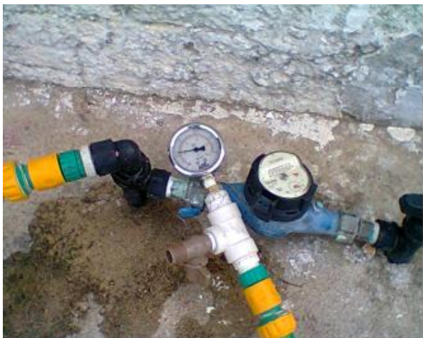
Foto 9 – RDA: medição instantânea de pressão na Rua Luíza Távora, 1087 – Autódromo.
