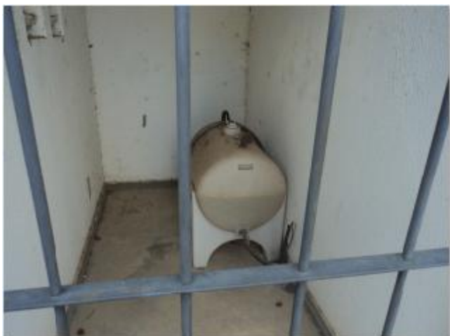
Foto 63 – EEE-12: combustível do grupo gerador de energia.
