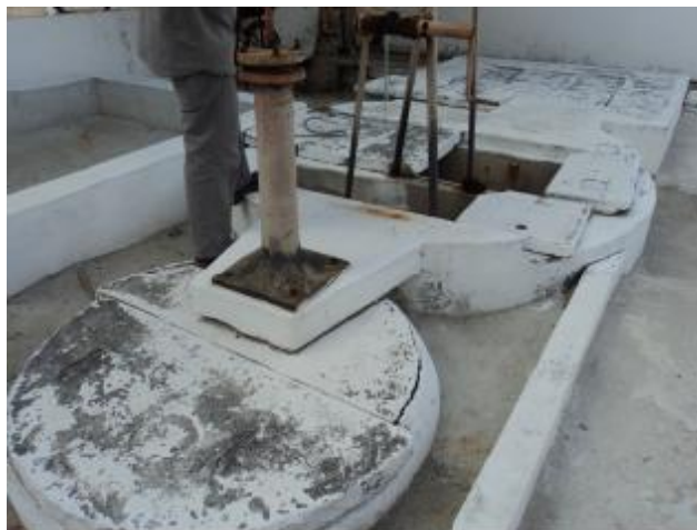
Foto 34 – EEE-07: vista geral do tratamento.
