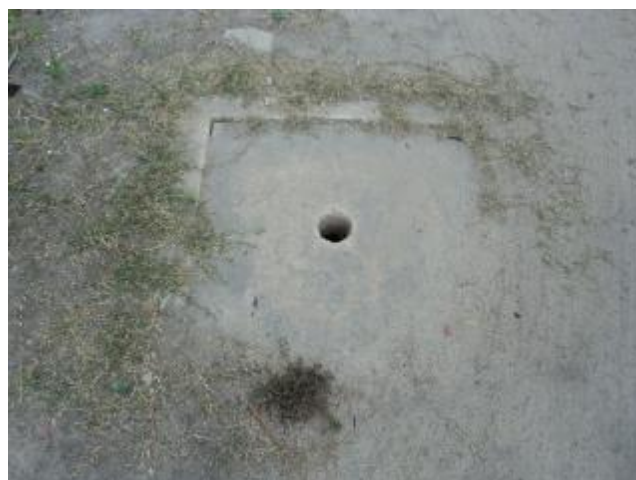
Foto 14 – RDA: registro de descarga na Rua Pernambuco – Parque Havaí.
