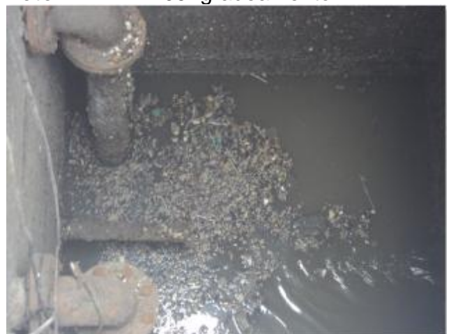
Foto 44 – EEE-09: vista interna do poço de sucção.
