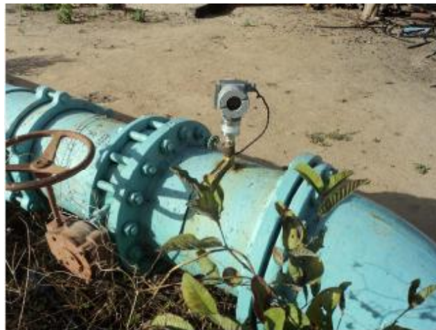
Foto 2 – AAT: medidor de vazão.
