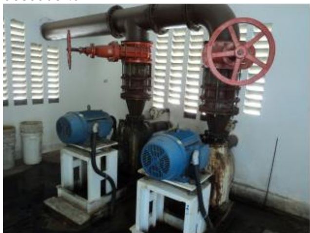
Foto 54 – EEE-10: conjunto moto-bomba.
