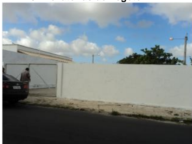
Foto 19 – EEE-02: vista externa-muro sem identificação.
