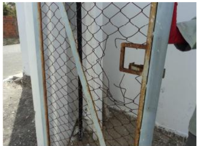
Foto 32 – EEE-03: portão danificado.
