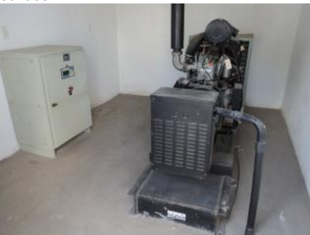
Foto 31 – EEE-03: grupo gerador de energia parado-bateria furtada.
