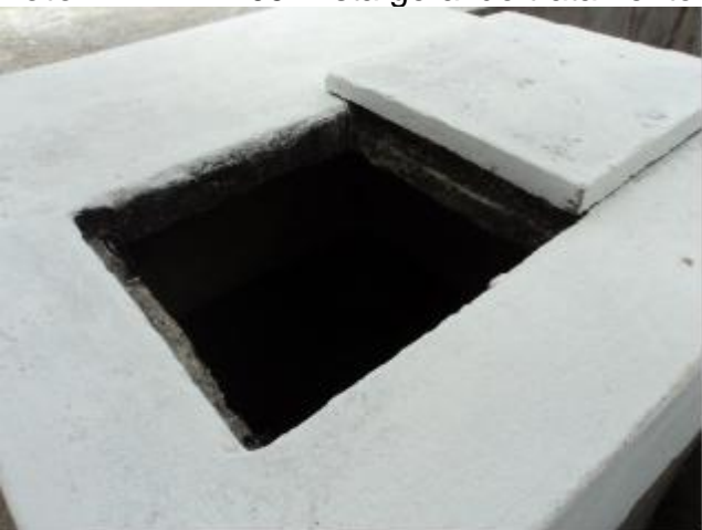
Foto 43 – EEE-09: poço de sucção descoberto-tampa pesada para o fechamento do poço.
