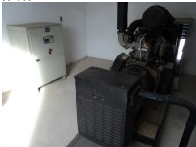
Foto 24 – EEE-02: grupo gerador de energia sem bateria e combustível para funcionar.
