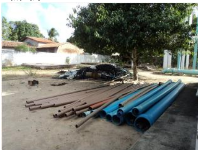
Foto 72 – Almoxarifado: armazenamento de tubulações ao ar livre.
