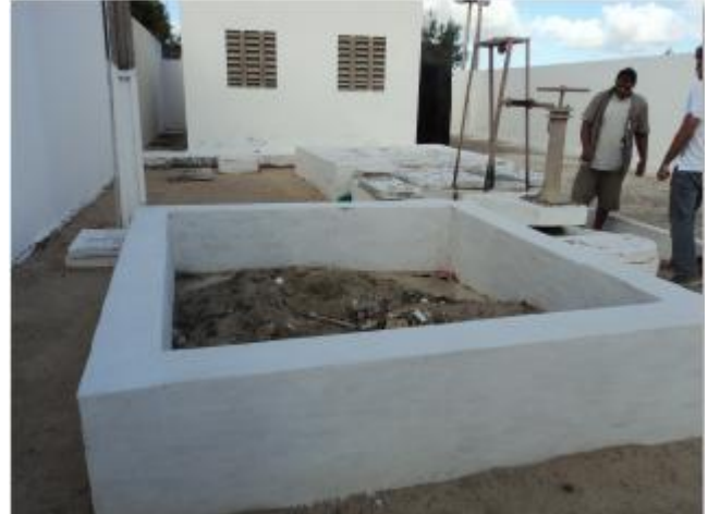
Foto 28 – EEE-03: leito de secagem e vista geral do tratamento.
