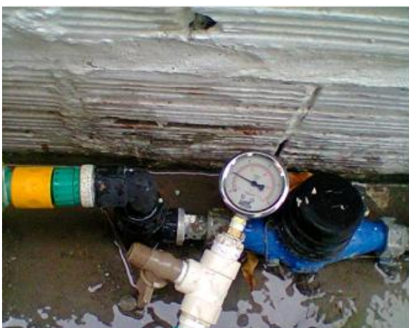
Foto 11 – RDA: medição instantânea de pressão na Rua Francisco Oliveira de Almeida, 1294 – Amador.
