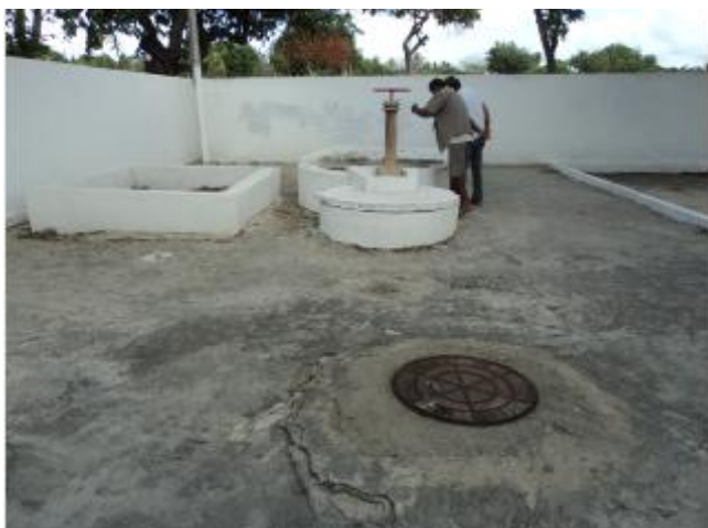
Foto 21 – EEE-02: vista geral do tratamento.
