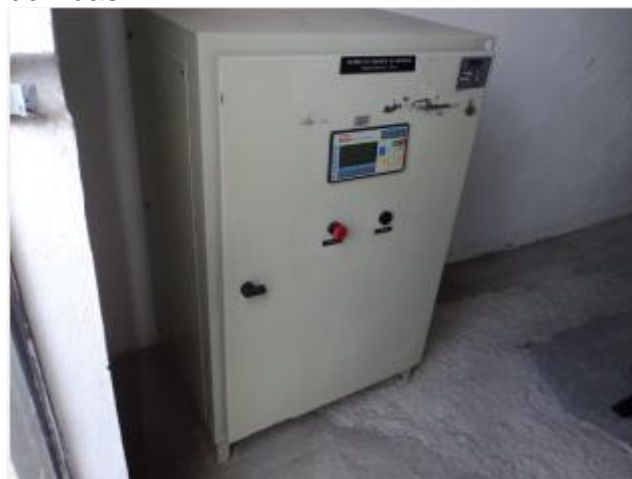
Foto 48 – EEE-09: quadro de comando do grupo gerador de energia.
