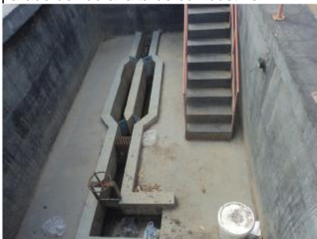
Foto 59 – EEE-12: vista geral do tratamento.
