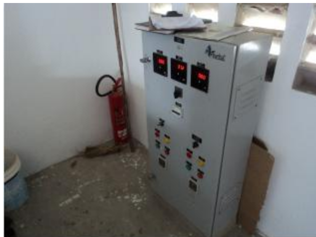
Foto 46 – EEE-09: quadro de comando das bombas.
