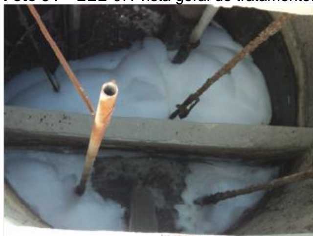
Foto 36 – EEE-07: vista interna do poço de sucção sem cesto para reter os materiais sólidos.
