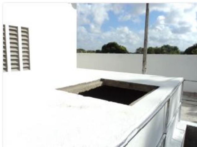
Foto 52 – EEE-10: poço de sucção descoberto.
