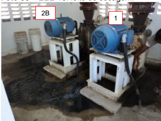
Foto 55 – EEE-10: conjunto moto-bomba - 1 com vazamento e 2B parado.
