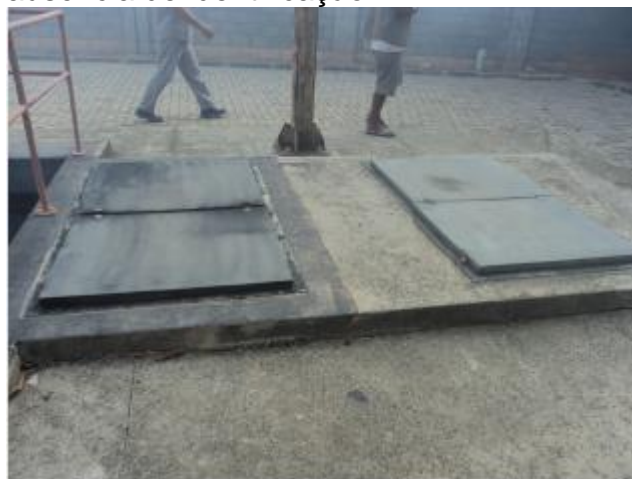
Foto 60 – EEE-12: poço de sucção fechado.
