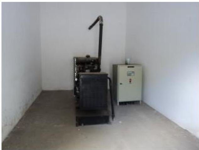
Foto 57 – EEE-10: grupo gerador de energia parado devido a falta de combustível.
