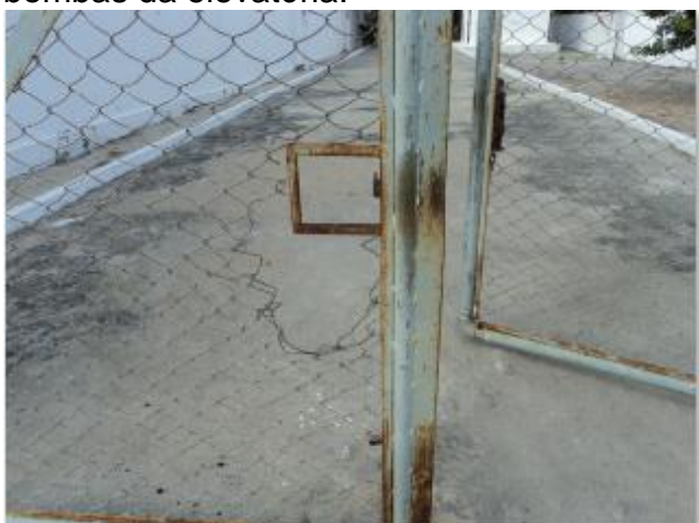
Foto 25 – EEE-02: portão danificado.
