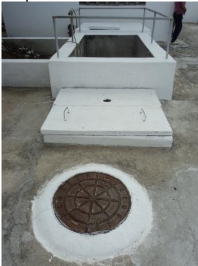
Foto 41 – EEE-09: vista geral do tratamento.
