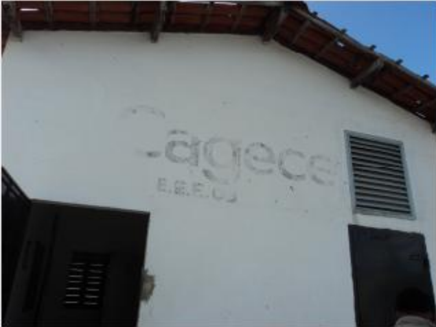
Foto 27 – EEE-03: identificação apagada.
