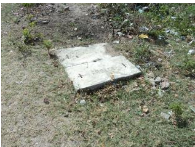
Foto 13 – RDA: registro de descarga na Rua Beira Rio – Urucunema.
