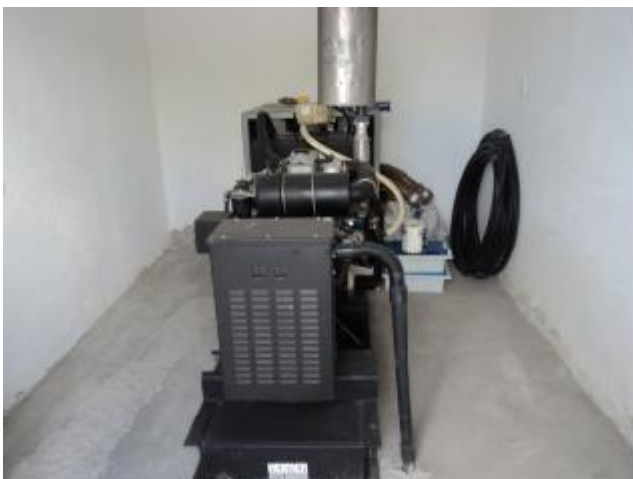
Foto 47 – EEE-09: grupo gerador de energia sem combustível para funcionar.
