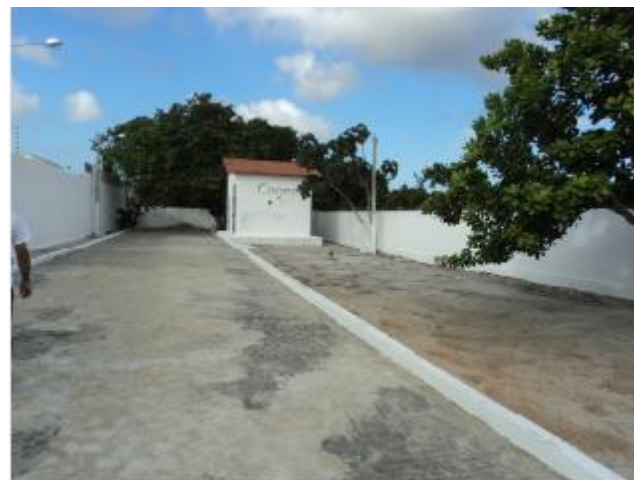
Foto 20 – EEE-02: vista da área interna.
