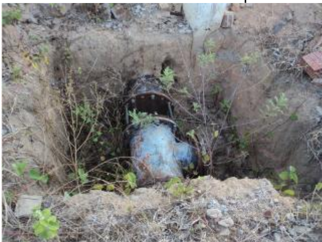
Foto 3 – AAT: antiga tubulação de entrada do REL-01 (desativado) sem caixa.
