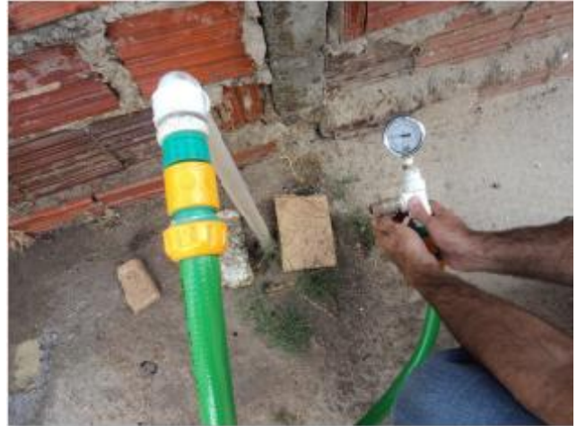
Foto 6 – RDA: medição instantânea de pressão na Rua Guajará, SMS 54 – Lagoinha.
