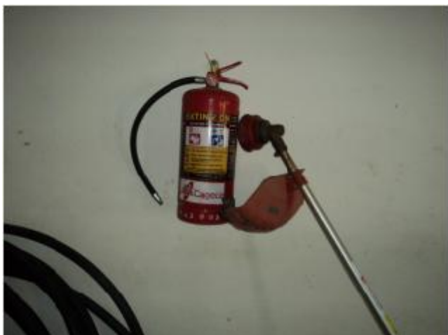
Foto 74 – Almojarifado: extintor de incêndio dentro do prazo de validade.
