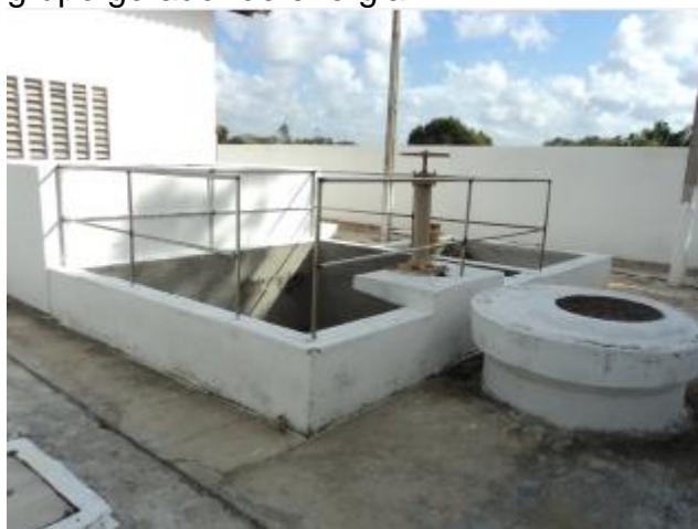
Foto 50 – EEE-10: vista geral do tratamento.
