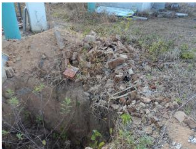
Foto 4 – AAT: resíduos provenientes da caixa da antiga tubulação do REL-01.
