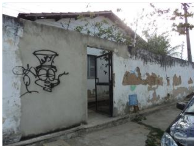
Foto 69 – Almoxarifado: vista externa.
