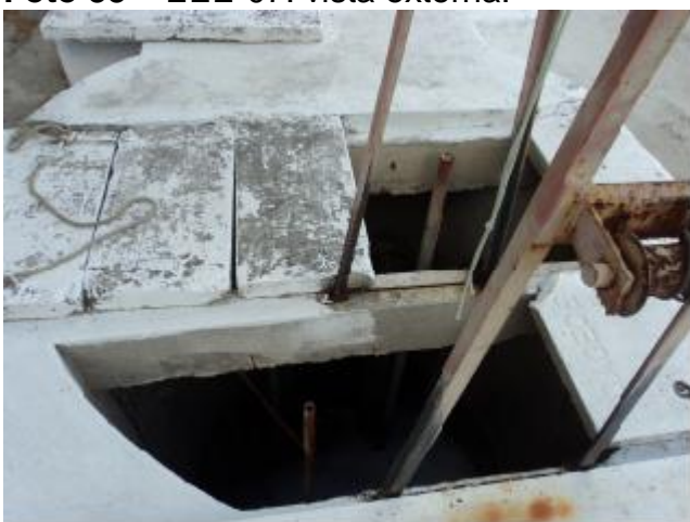
Foto 35 – EEE-07: poço de sucção sem tampa e sem o cesto para reter os materiais sólidos.
