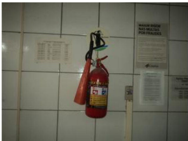
Foto 68 – Loja de atendimento: extintor de incêndio.
