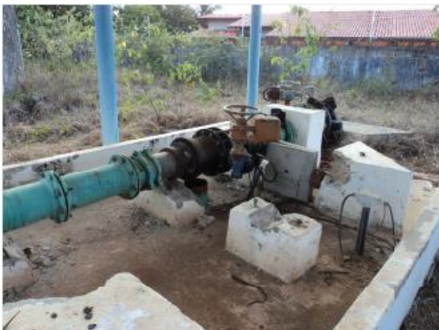
Foto 1 – AAT: válvula redutora de pressão.
