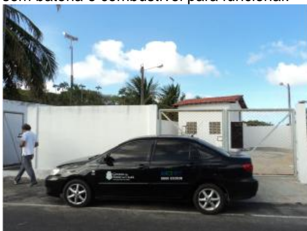
Foto 26 – EEE-03: vista externa.
