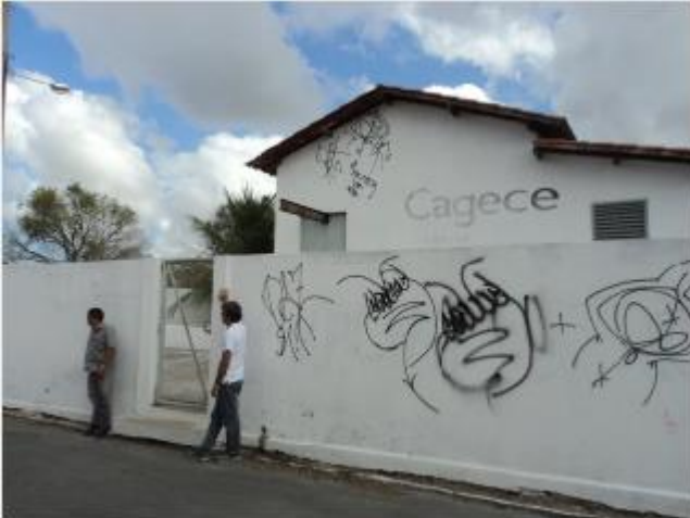
Foto 39 – EEE-09: vista externa – pintura deteriorada por vandalos.
