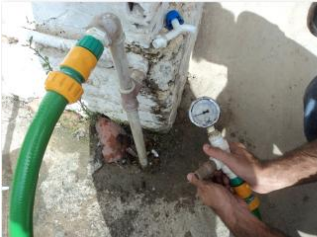
Foto 5 – RDA: medição instantânea de pressão na Rua Pernambuco – Parque Havaí.
