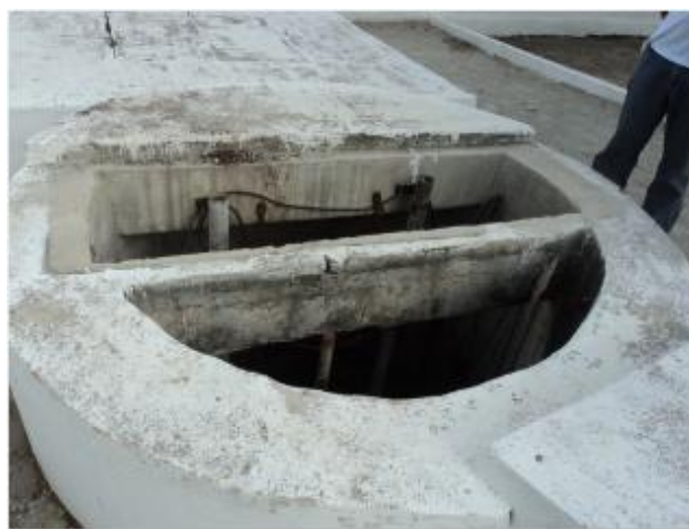
Foto 22 – EEE-02: poço de sucção sem tampa e sem o cesto para reter os materiais sólidos.
