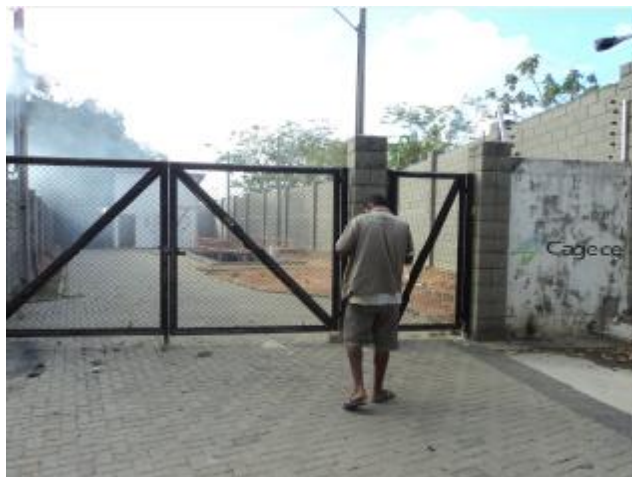
Foto 58 – EEE-12: entrada da elevatória e ausência de identificação.
