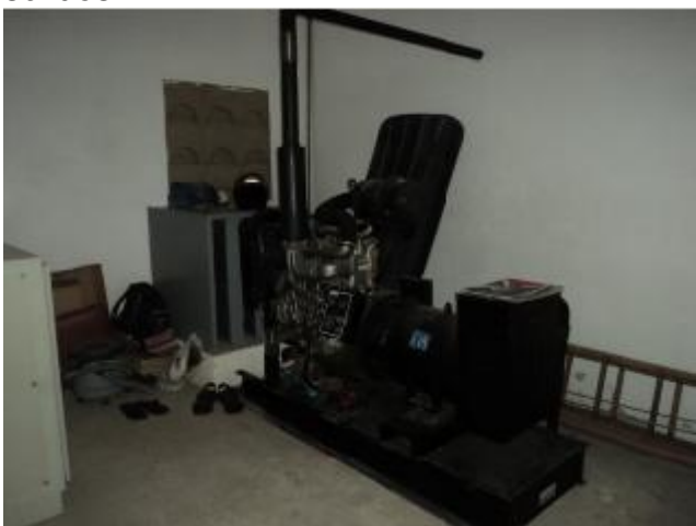
Foto 37 – EEE-07: grupo gerador de energia parado.
