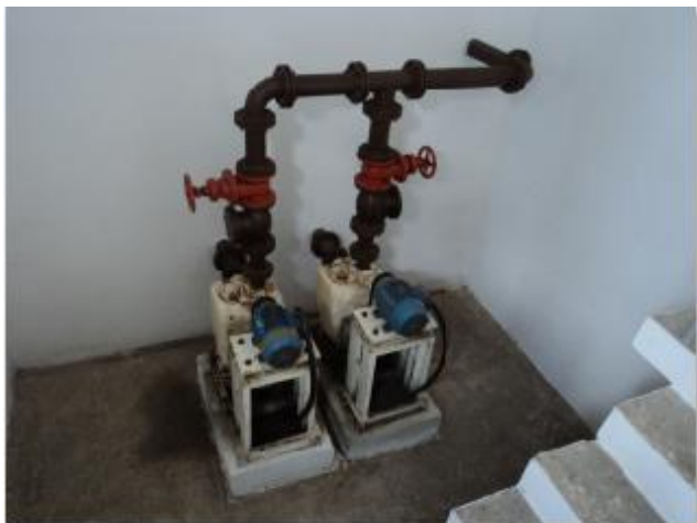
Foto 45 – EEE-09: conjunto moto-bomba.
