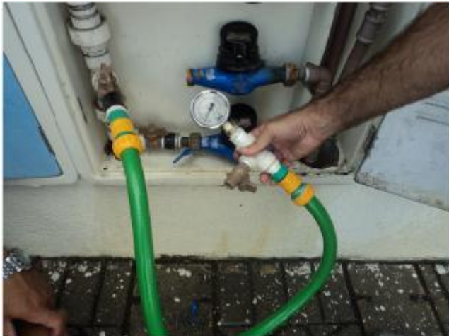
Foto 7 – RDA: medição instantânea de pressão na Av. Eusébio de Queiroz, 30 – Centro.
