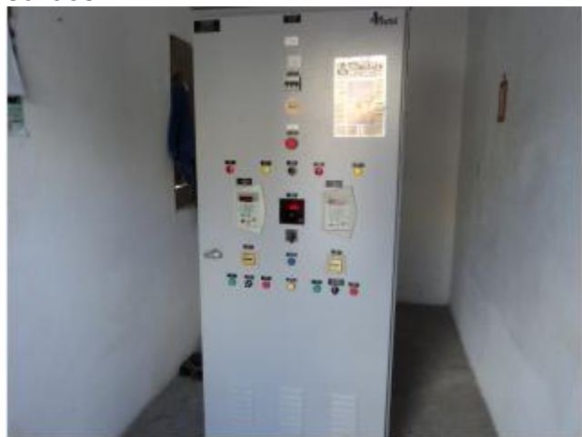
Foto 38 – EEE-07: quadro de comando das bombas.
