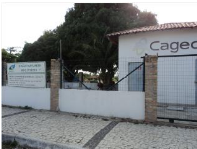
Foto 33 – EEE-07: vista externa.
