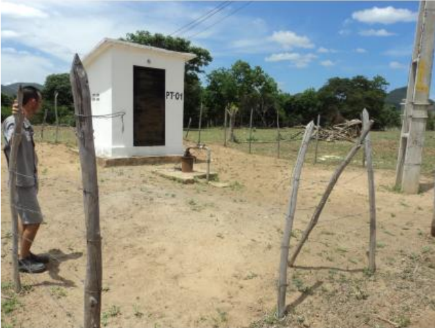
Foto 1 – PT-01: área de acesso ao poço sem iluminação para trabalhos noturnos.
