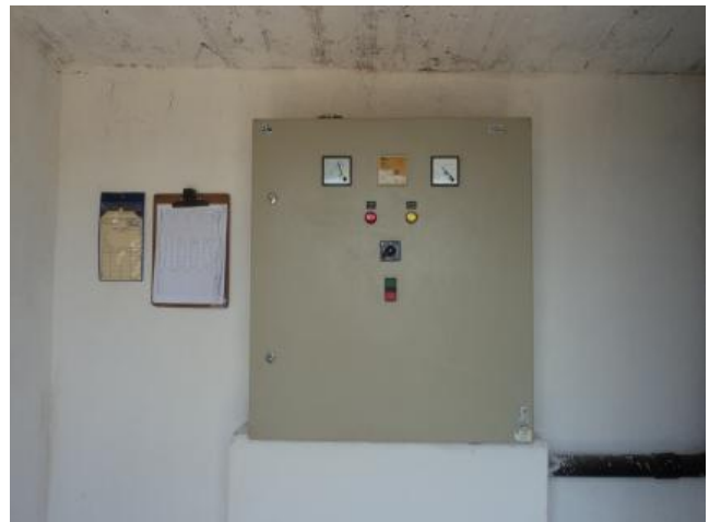
Foto 4 – PT-01: quadro de comando.
