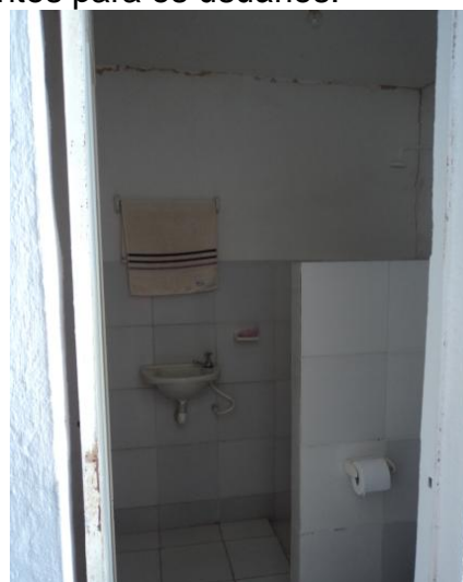
Foto 35 – Loja de atendimento: instalações sanitárias.
