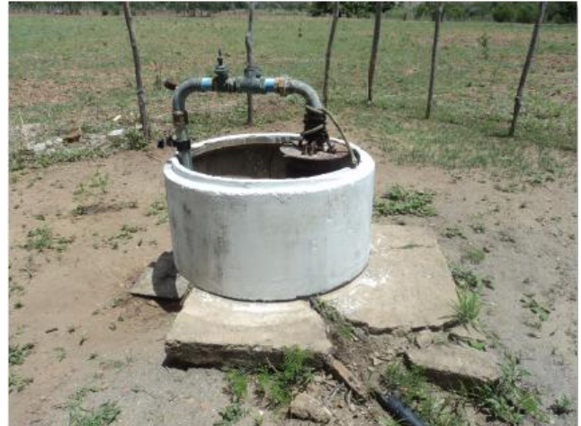
Foto 6 – PT-02: laje de proteção.
