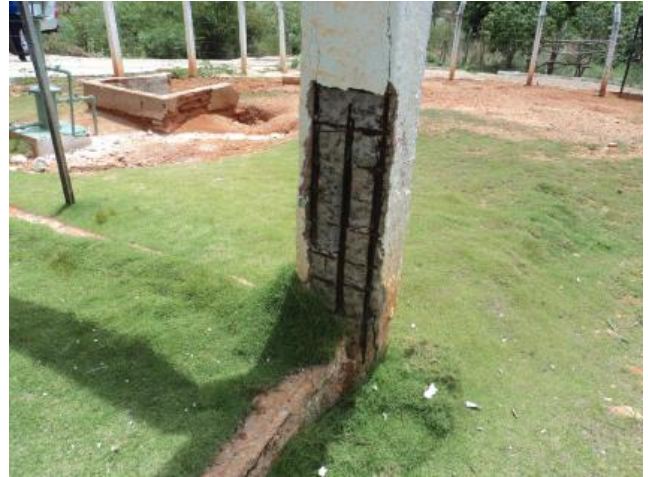
Foto 23 – REL-01: armadura exposta.
