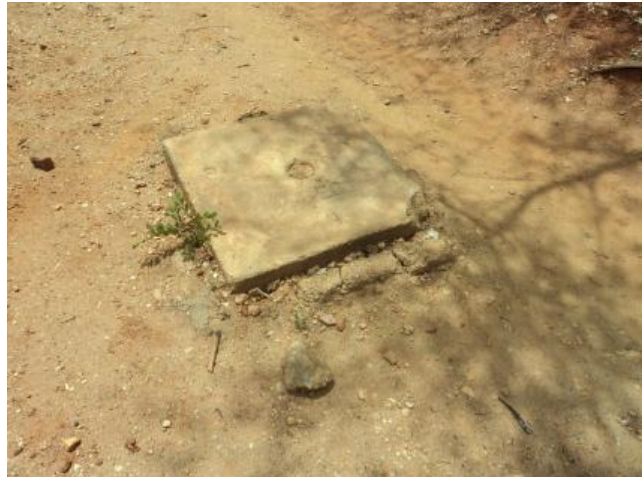
Foto 31 – Rede de distribuição: registro de descarga na Rua do Comércio, 134.
