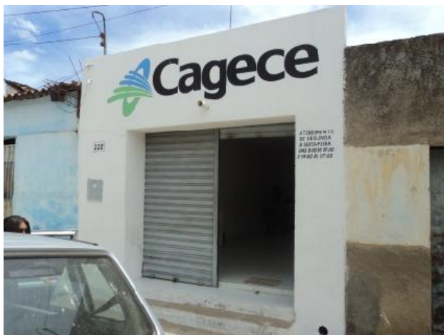
Foto 32 – Loja de atendimento: vista externa.
