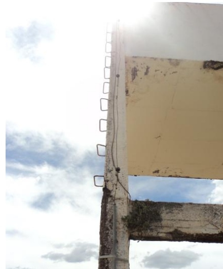
Foto 25 – REL-01: escada de acesso sem guarda-corpo.
