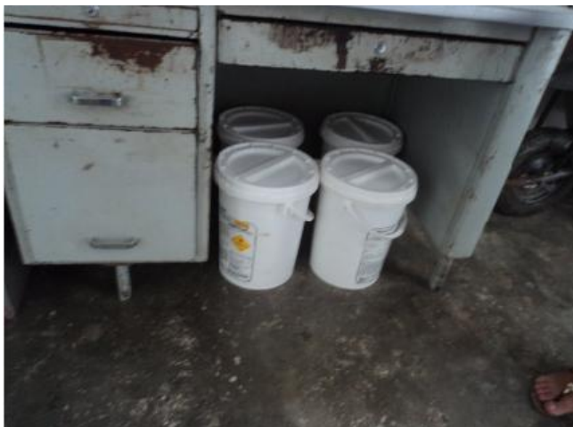
Foto 11 – Tratamento: armazenamento de hipoclorito.
