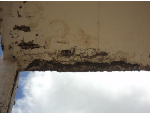
Foto 24 – REL-01: estrutura deteriorada com vazamento.
