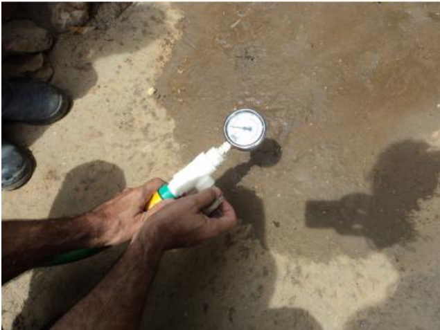
Foto 28 – Rede de distribuição: medição instantânea de pressão no Sítio Juá, FNS 21.
