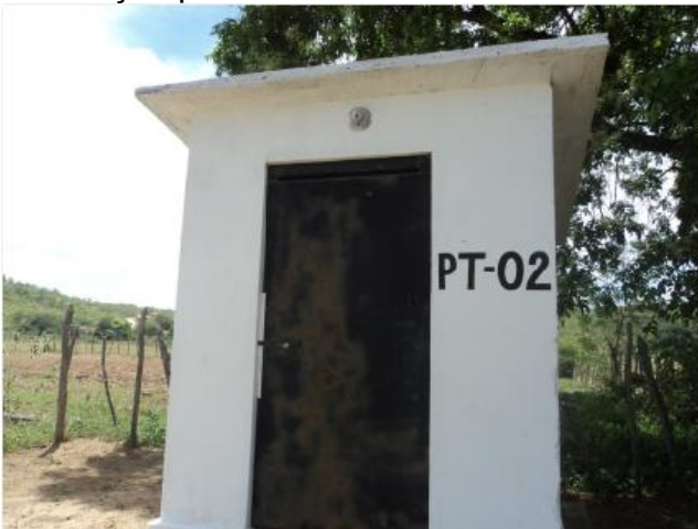
Foto 7 – PT-02: casa de abrigo do quadro de comando com identificação.
