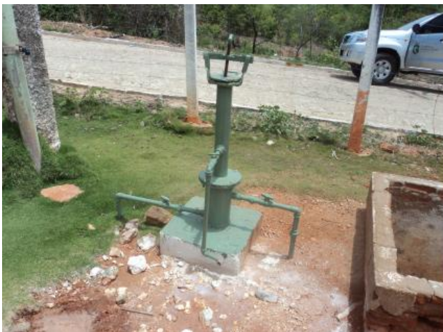
Foto 9 – Tratamento: clorador de pastilha.
