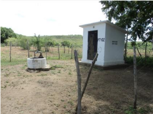
Foto 5 – PT-02: área de acesso sem iluminação para trabalhos noturnos.
