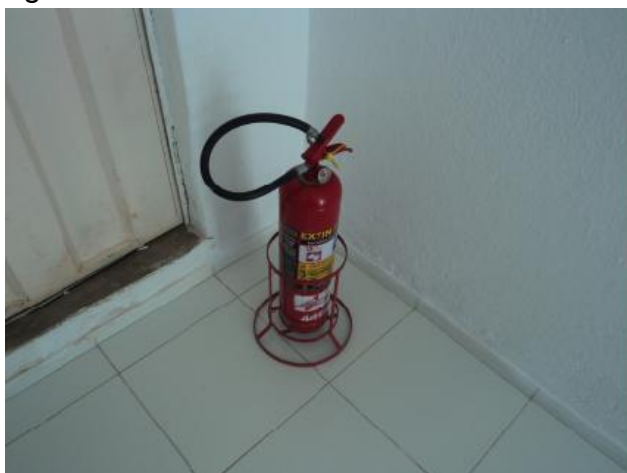
Foto 36 – Loja de atendimento: extintor de incêndio.
