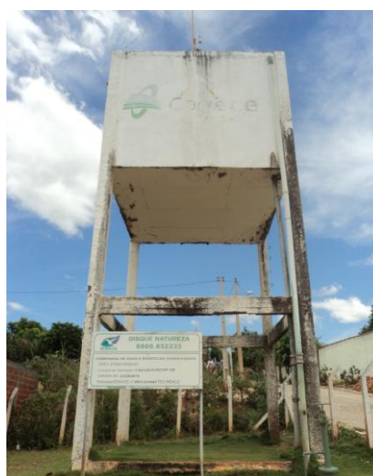
Foto 21 – REL-01: pintura deteriorada e identificação apagada.
