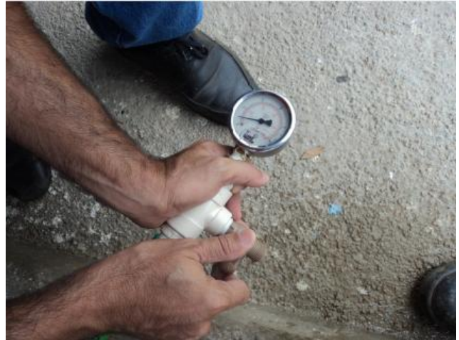
Foto 29 – Rede de distribuição: medição instantânea de pressão na Rua do Comércio, 134.
