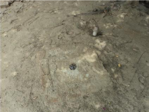
Foto 30 – Rede de distribuição: registro de descarga no Sítio Juá, FNS 21.
