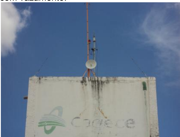
Foto 26 – REL-01: para-raios e sinalização noturna
