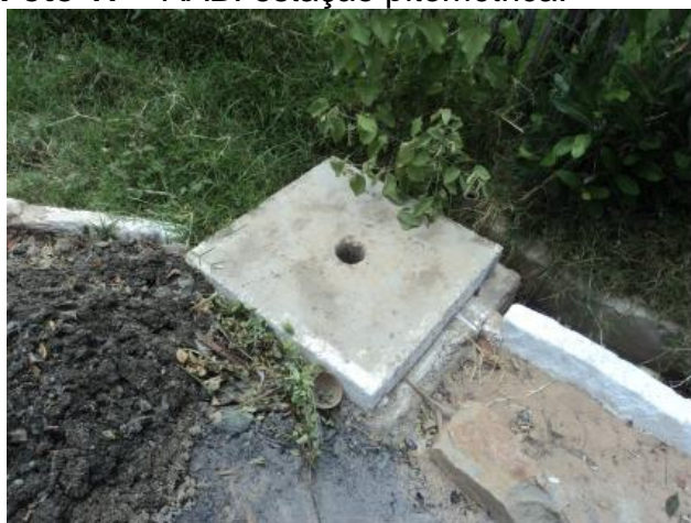
Foto 19 – AAB: ventosa instalada na Estrada Sítio Juá II.
