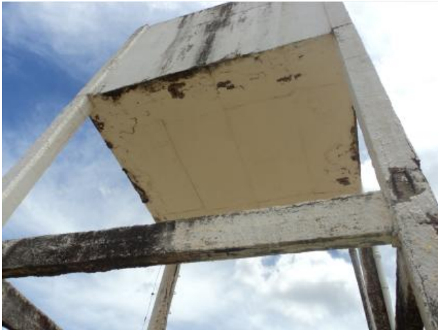
Foto 22 – REL-01: estrutura com vazamento.
