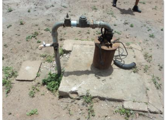
Foto 2 – PT-01: laje de proteção.
