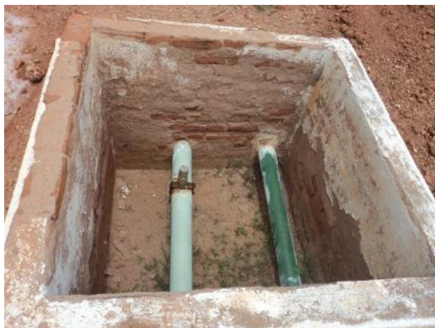
Foto 17 – AAB: estação pitométrica.
