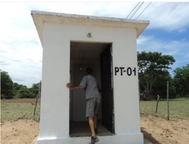
Foto 3 – PT-01: casa de abrigo do quadro de comando com identificação.
