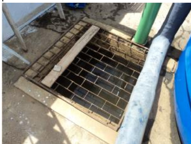
Foto 62 – ETA: caixa de registro com água devido a caixa de recepção das águas de descarga e lavagem.
