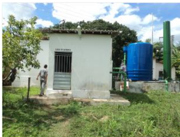
Foto 43 – ETA: vista geral do tratamento.
