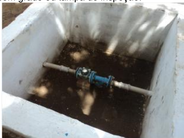
Foto 69 – AAT: macromedidor sem tampa ou grade de proteção.
