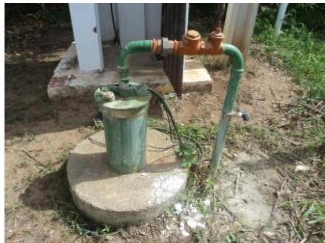
Foto 24 – PT-03: laje de proteção.
