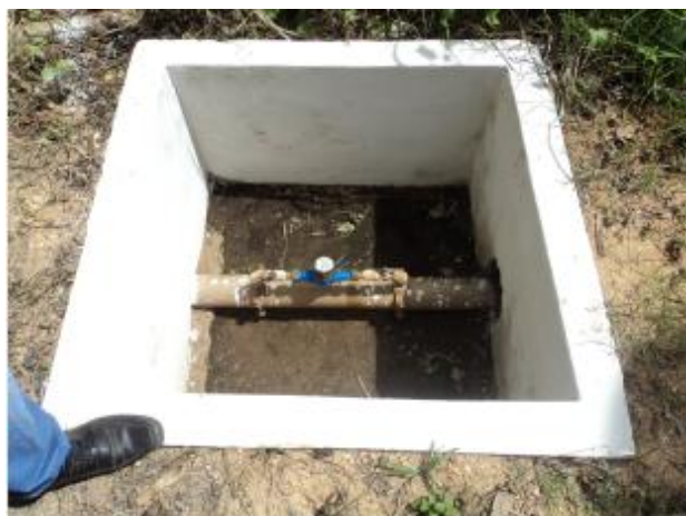
Foto 68 – AAB: caixa do medidor sem grade ou tampa de inspeção.
