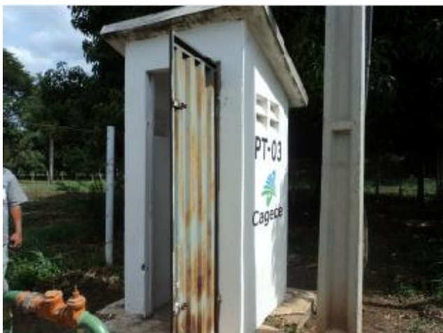
Foto 23 – PT-03: casa de abrigo do QC com identificação.
