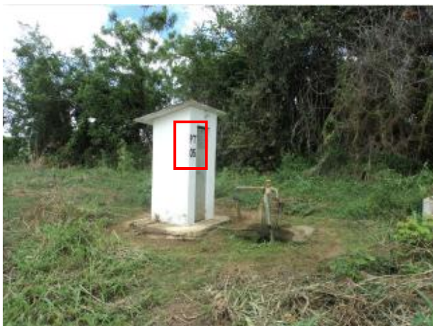
Foto 31 – PT-05: casa de abrigo do QC com identificação e ausência de iluminação para trabalhos noturnos.
