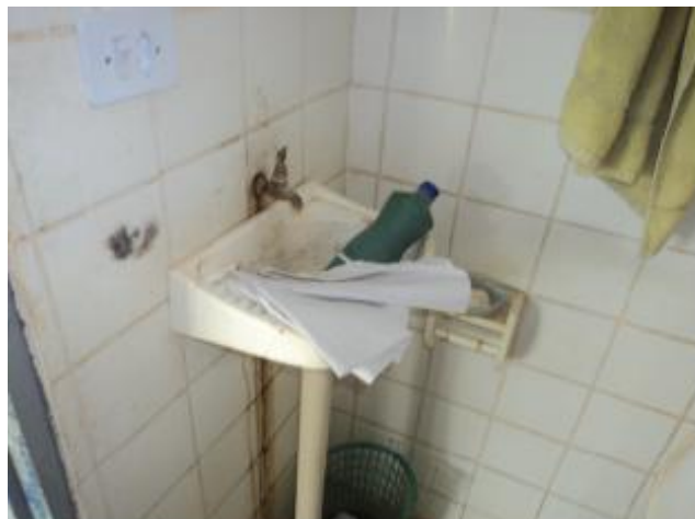
Foto 66 – ETA: condições das instalações sanitárias.
