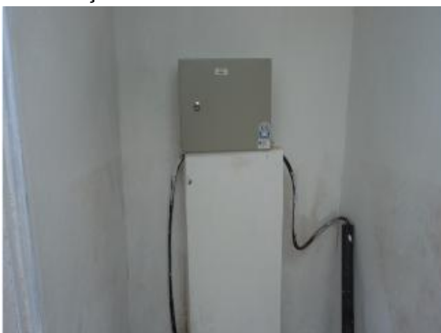
Foto 25 – PT-03: quadro de comando sem horímetro.
