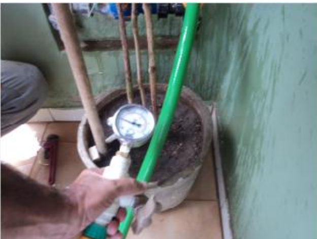
Foto 93 – RDA: medição instantânea de pressão na R. da Independência, 321 – Nova Esperança.
