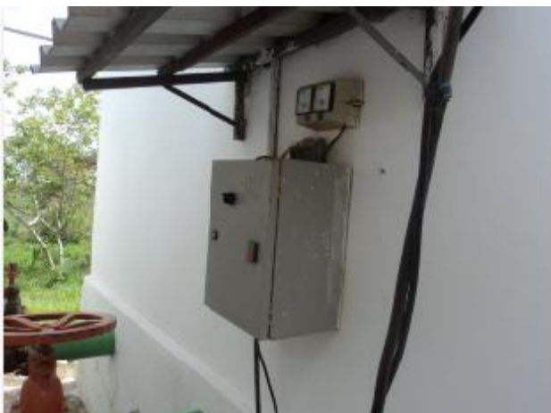
Foto 75 – EEAT-02: quadro de comando sem horímetro e sem identificação da elevatória.
