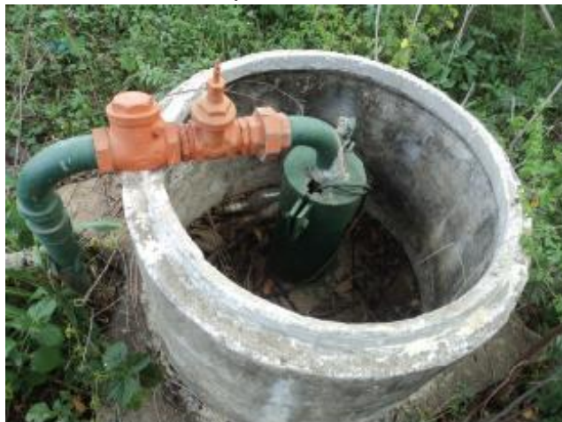
Foto 38 – PT-07 (desativado): laje de proteção.
