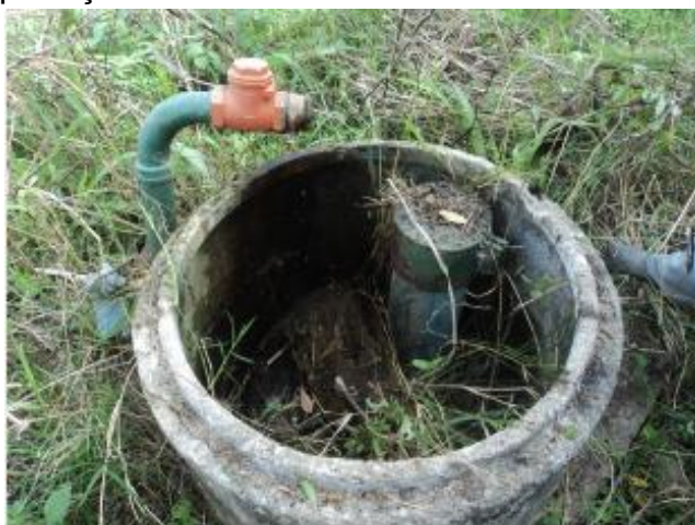
Foto 40 – PT-08 (desativado): tubulação de retorno da adutora com vazamento.
