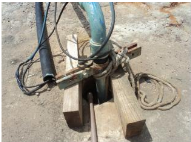
Foto 77 – EEAT-03: estrutura do reservatório com abertura de entrada da tubulação sem acabamento adequado.
