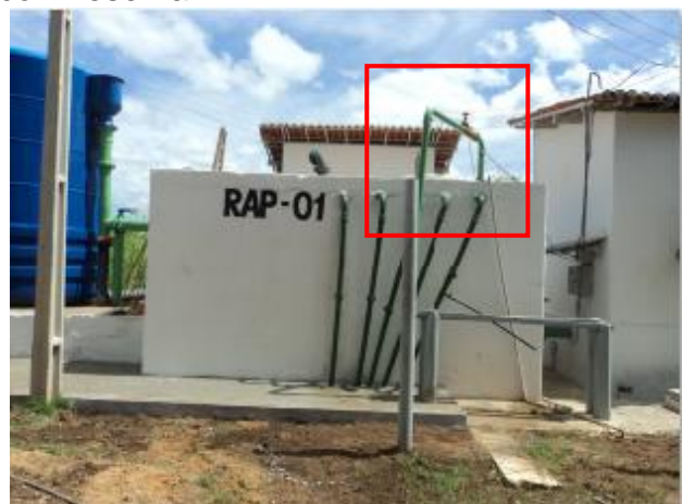
Foto 74 – EEAT-02: tubulação do conjunto moto-bomba que recalca água do RAP-01 para a RDA.
