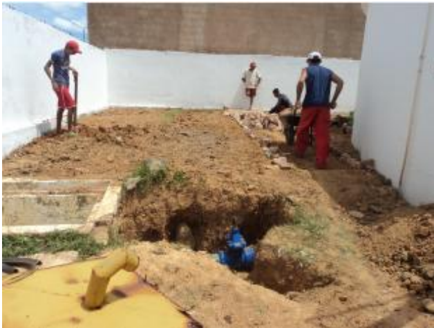
Foto 87 – RAP-02: registro sem caixa e área do reservatório em reforma.
