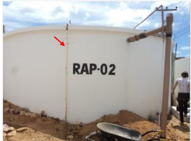
Foto 82 – RAP-02: medido de nível e identificação.
