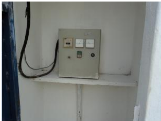
Foto 36 – PT-06: quadro de comando.
