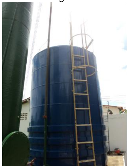
Foto 45 – Filtro: escada de acesso com guarda corpo.
