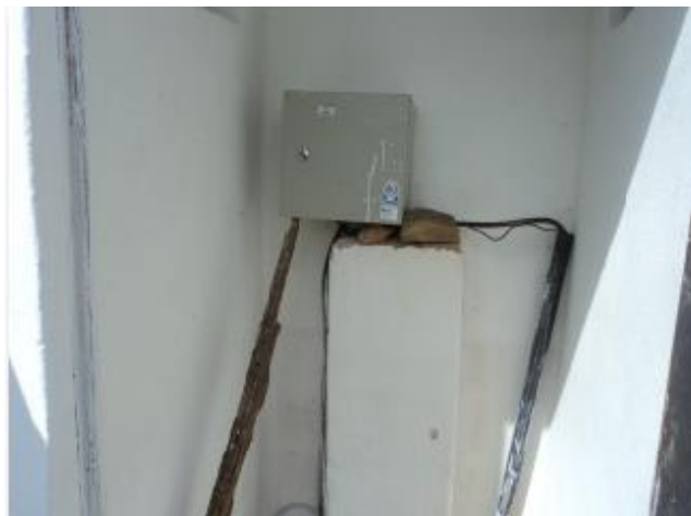
Foto 30 – PT-04: quadro de comando sem fixação na parede e sem horímetro.
