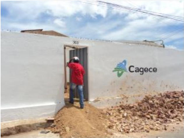
Foto 81 – RAP-02: área de acesso – materiais de construção devido a reforma da área do reservatório.
