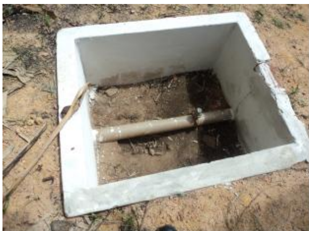
Foto 67 – AAB: caixa da estação pitométrica sem grade ou tampa de inspeção.
