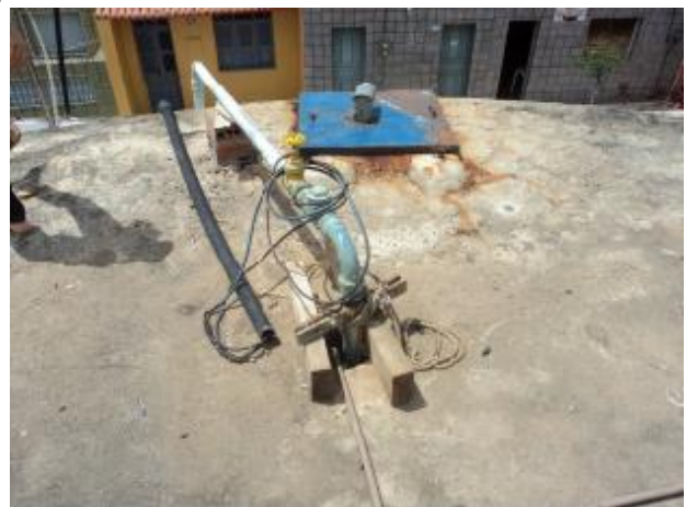
Foto 76 – EEAT-03: tubulação do conjunto moto-bomba que recalca água do RAP-02 para a RDA.
