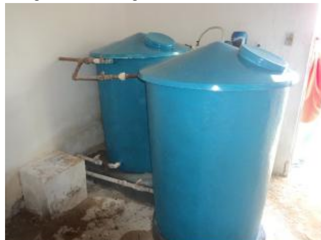
Foto 50 – Casa de química: tanques dosadores.
