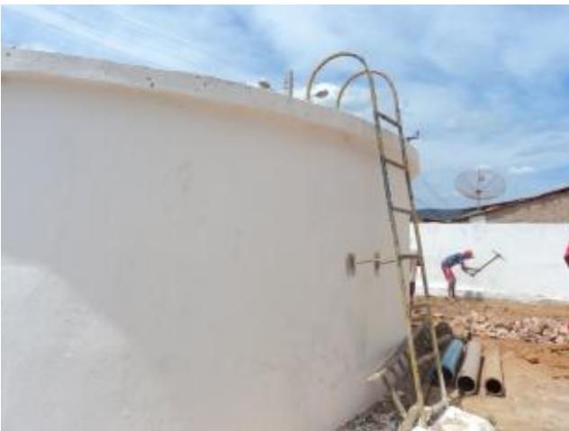
Foto 83 – RAP-02: escada de acesso necessitando de pintura.
