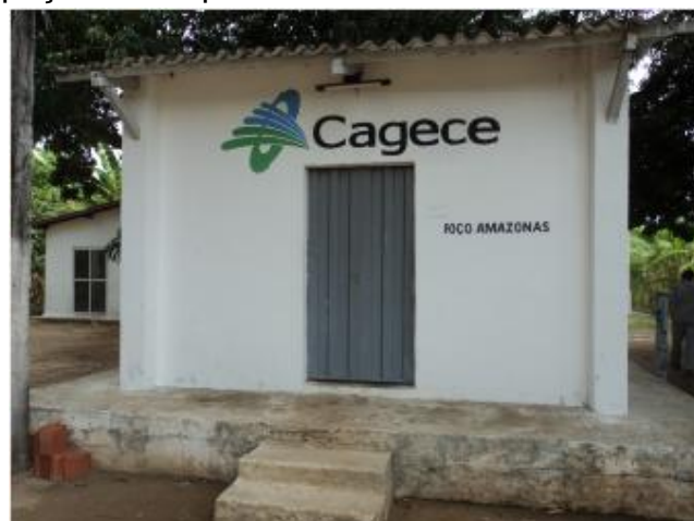
Foto 10 – PA-01: acesso ao poço e identificação.
