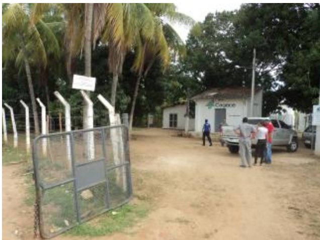
Foto 41 – ETA: vista geral.
