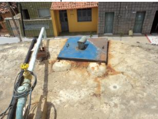
Foto 85 – RAP-02: tampa de inspeção em processo de corrosão.
