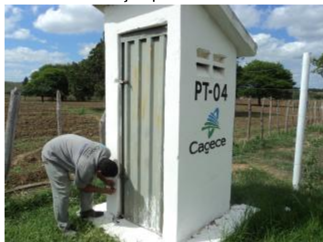
Foto 28 – PT-04: casa de abrigo do QC com identificação.
