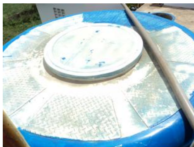
Foto 46 – Filtro: tampa adequada.
