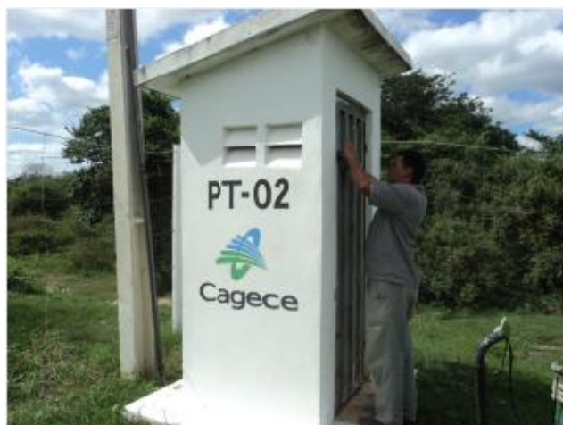
Foto 18 – PT-02: casa de abrigo do QC com identificação.
