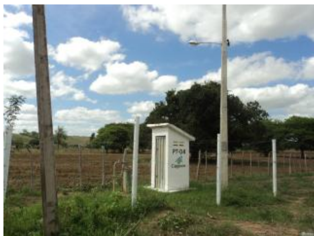
Foto 26 – PT-04: vista geral – área de acesso e iluminação para trabalhos noturnos.
