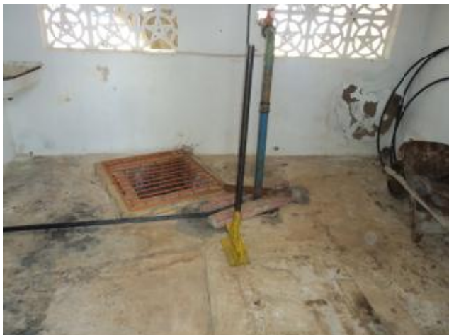
Foto 11 – PA-01: vista geral e tubulação de recalque.
