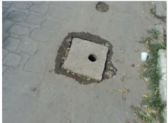
Foto 98 – RDA: registro de descarga na R. Manoel Pinheiro de Almeida - Centro.
