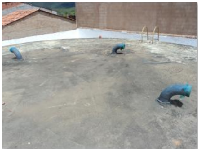
Foto 84 – RAP-02: tubulações de ventilação com tela de proteção.
