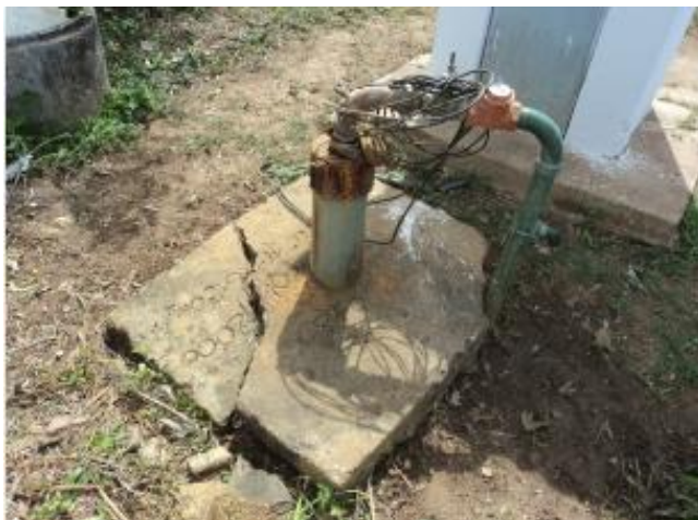
Foto 35 – PT-06: laje de proteção rachada.
