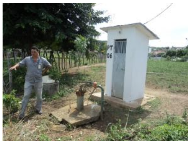
Foto 34 – PT-06: casa de abrigo do QC com identificação e ausência de iluminação para trabalhos noturnos.
