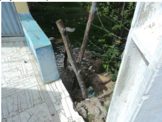
Foto 9 – Captação: área de acesso aos poços inadequada.
