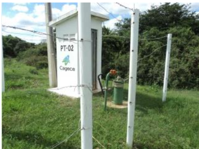
Foto 17 – PT-02: ausência de portão.
