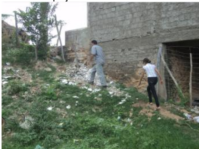
Foto 7 – Captação: área de acesso aos poços inadequada.
