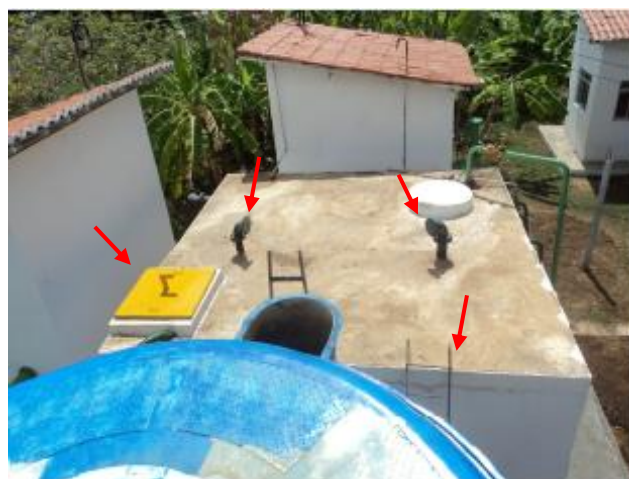
Foto 80 – RAP-01: tampa de inspeção, tubulações de ventilação com tela de proteção e escada de acesso.
