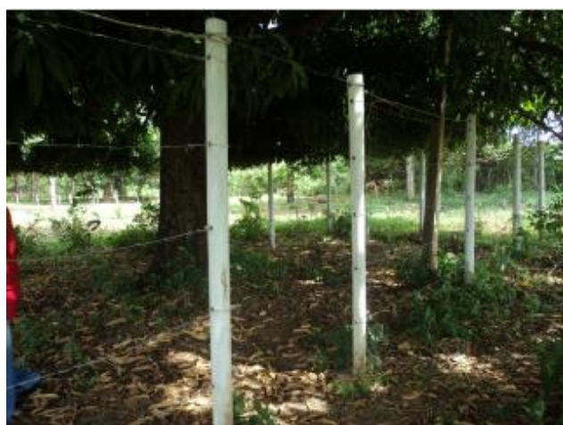
Foto 22 – PT-03: ausência de portão.
