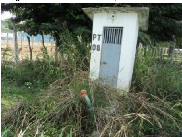
Foto 39 – PT-08 (desativado): área de acesso, casa de abrigo do QC com identificação.
