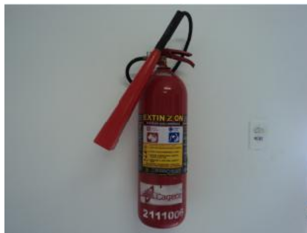
Foto 108 – Loja de atendimento: extintor de incêndio.
