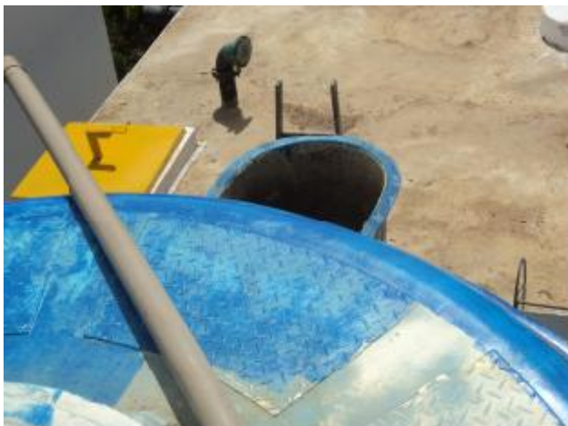
Foto 47 – Filtro: calha de saída da água sem tampa.
