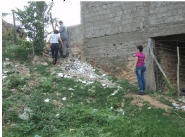
Foto 8 – Captação: área de acesso aos poços inadequada.
