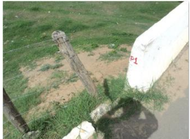
Foto 2 – Captação: área de acesso aos poços inadequada.
