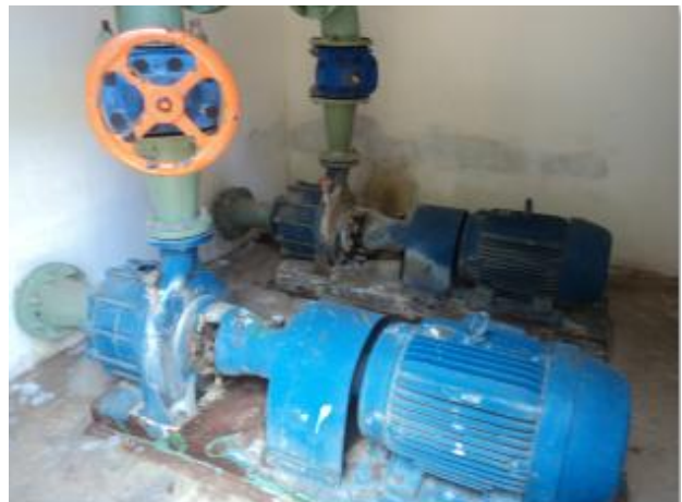
Foto 72 – EEAT-01: conjunto moto-bomba com reserva.
