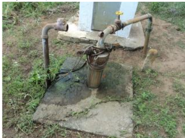
Foto 32 – PT-05: laje de proteção e tubulação de retorno da adutora com vazamento.
