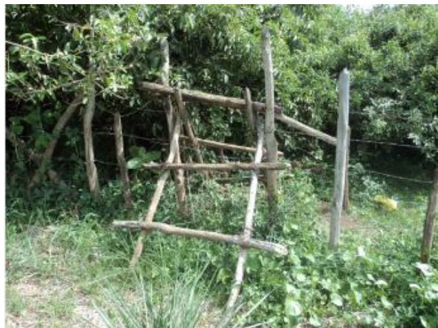
Foto 6 – Captação: obstáculo na área de acesso aos poços.
