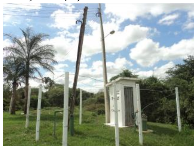
Foto 16 – PT-02: vista geral – área de acesso e iluminação para trabalhos noturnos.
