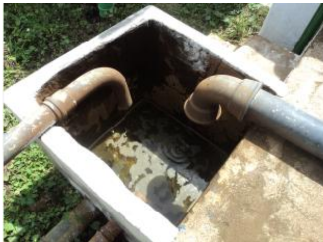
Foto 48 – Filtro: caixa para as águas de lavagem e descarga.
