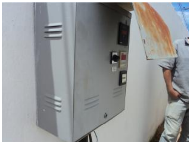
Foto 78 – EEAT-03: quadro de comando sem identificação da elevatória.
