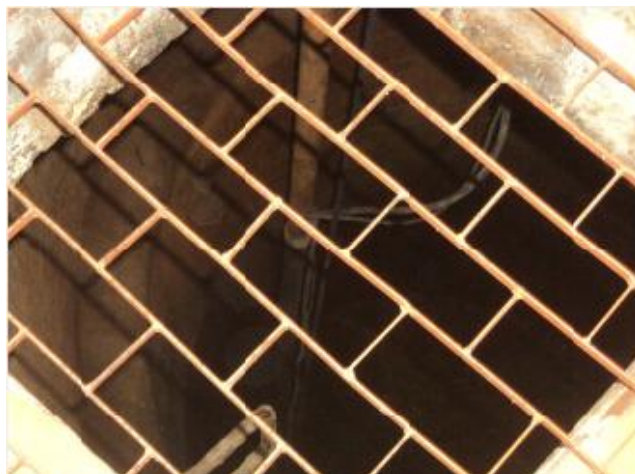
Foto 12 – PA-01: vista interna.
