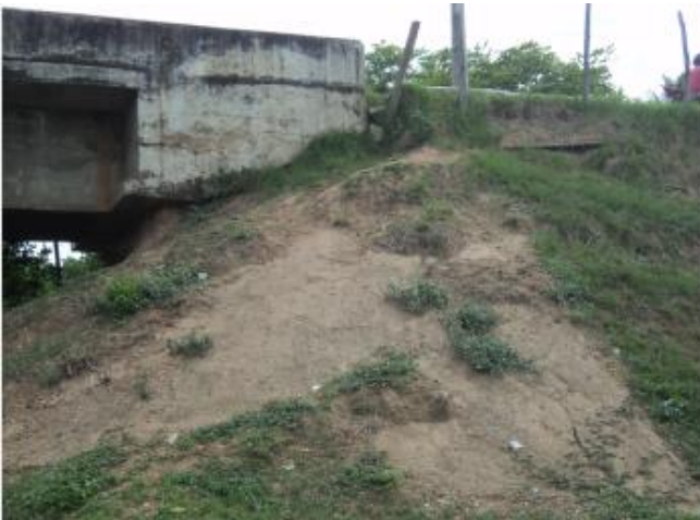
Foto 3 – Captação: área de acesso aos poços inadequada.
