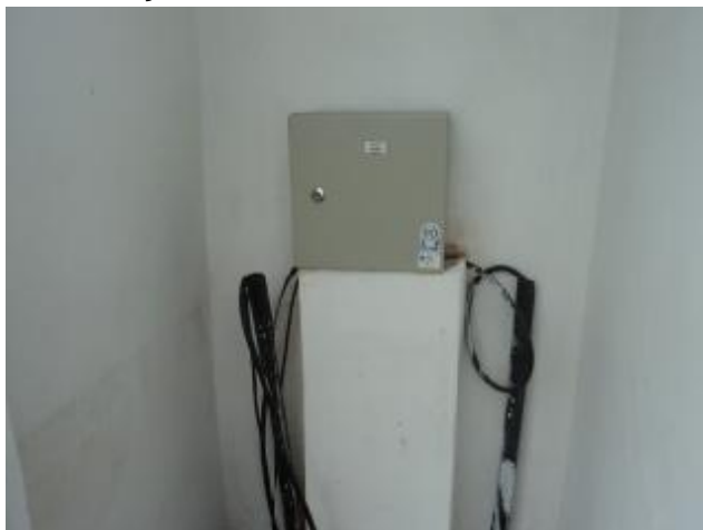
Foto 20 – PT-02: quadro de comando sem horímetro.
