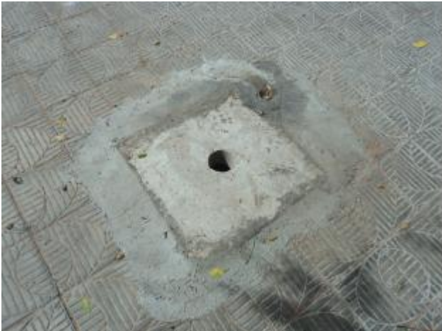
Foto 97 – RDA: registro de descarga na R. Antônio Fernandes Lima - Centro.
