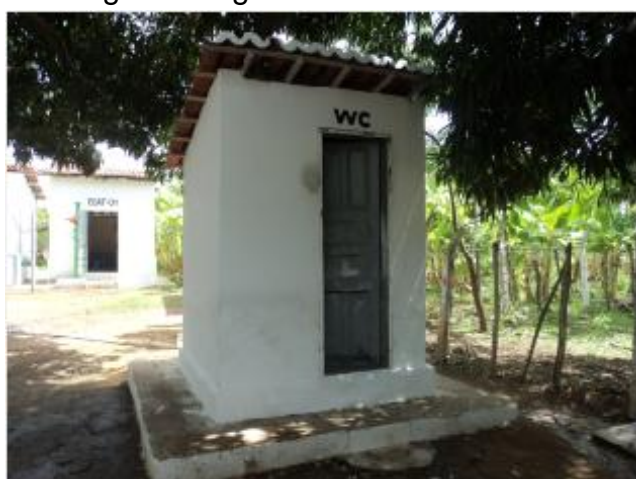
Foto 64 – ETA: instalações sanitárias para os peradores.
