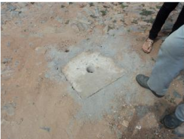
Foto 95 – RDA: registro de descarga na R. Maria Aurineide Pinheiro – Boa Vista.
