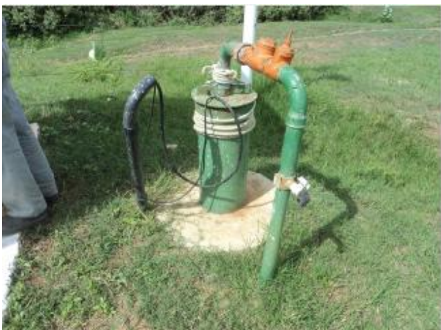
Foto 19 – PT-02: laje de proteção.
