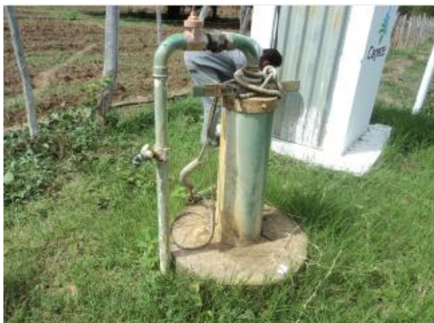
Foto 29 – PT-04: laje de proteção.
