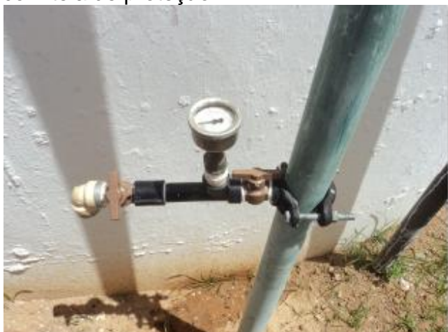
Foto 86 – RAP-02: medidor de nível.
