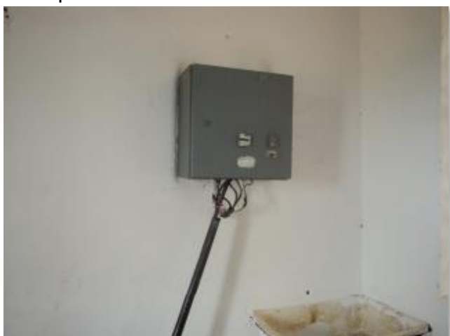
Foto 13 – PA-01: quadro de comando.
