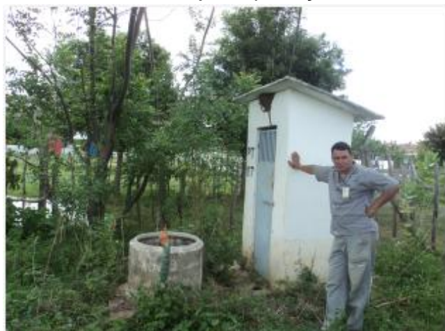
Foto 37 – PT-07 (desativado): casa de abrigo do QC com identificação.
