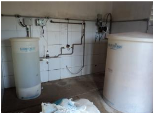
Foto 53 – Fábrica de cloro: tanques de cloro.
