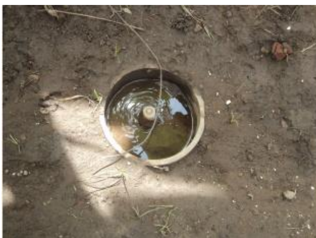
Foto 63 – ETA: registro com vazamento.
