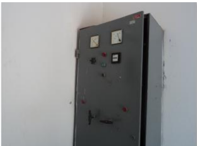
Foto 73 – EEAT-01: quadro de comando.
