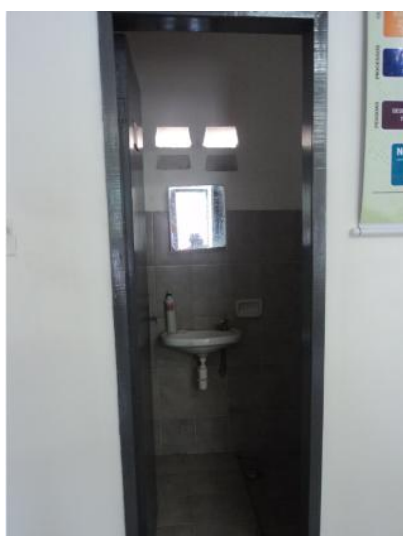
Foto 107 – Loja de atendimento: instalações sanitárias.
