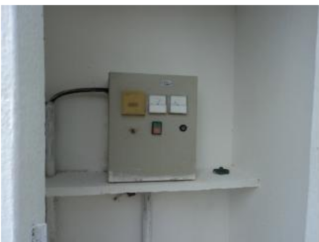
Foto 33 – PT-05: quadro de comando.
