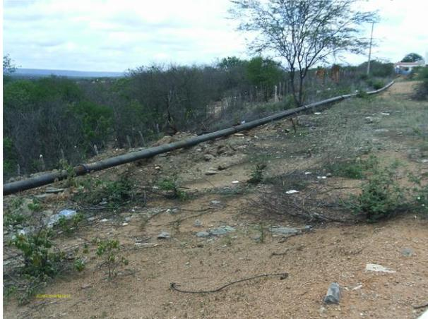
**Foto 24** - Trecho da AAB construída em caráter emergencial. Foto tirada no dia 5/2/14.
