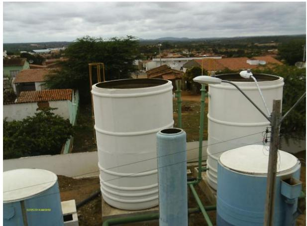
**Foto 7** - ETA: vista superior dos decantadores (sem tampa), filtros e torre de nível.
