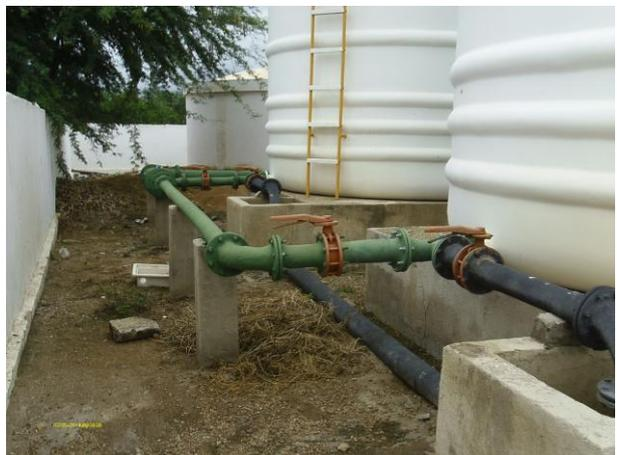
**Foto 9** - ETA: tubulações e registros dos decantadores.
