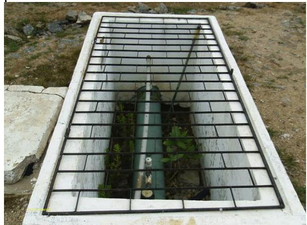
**Foto 37** - Caixa de inspeção com grade de proteção.
