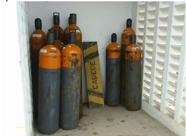
**Foto 17** - Casa de química: área de armazenamento dos cilindros de cloro gasoso.
