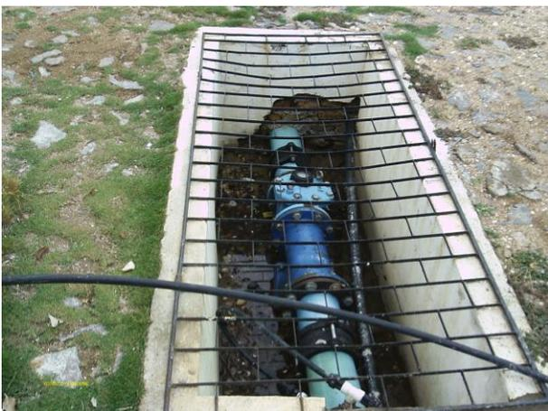
**Foto 38** - Caixa de inspeção com grade de proteção.
