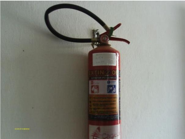
**Foto 31 - EEAT-01:** Extintor de incêndio dentro do prazo de validade da recarga.
