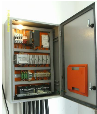
Foto 20 – RAP-11: quadro de automação do controle de nível.
