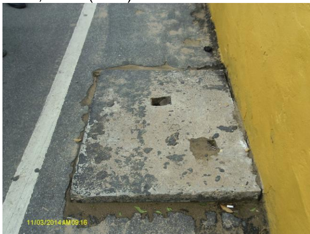
Foto 36 – Registro de descarga na Av. São Vicente.
