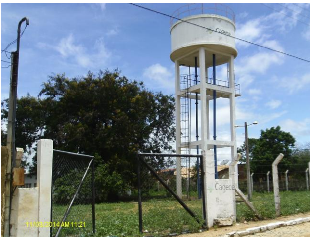
Foto 21 – REL-24: vista geral e acesso principal.
