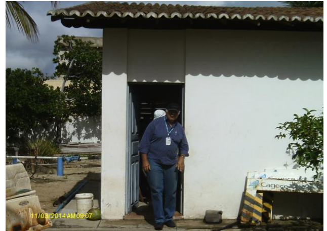
Foto 2 – PT-01: casa de abrigo do poço e do quadro de comando.
