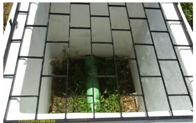
Foto 5 – Caixa de estação pitométrica na adutora de água tratada na área do RAP-11, com grade de proteção.
