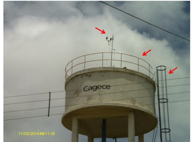
Foto 24 – REL-24: gaiola protetora na escada de acesso e na laje de cobertura e pára-raios e sinalização noturna.
