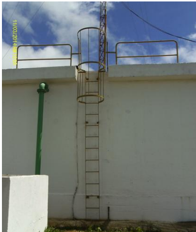
Foto 13 – RAP-11: gaiola protetora na escada de acesso.
