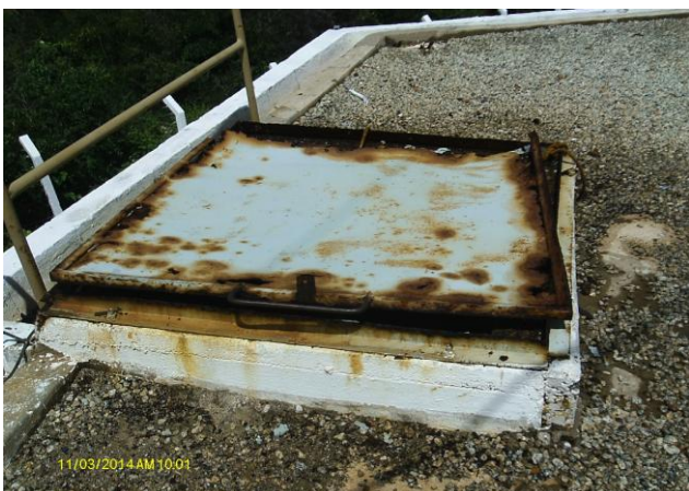
Foto 15 – RAP-11: tampa de inspeção em processo de oxidação.
