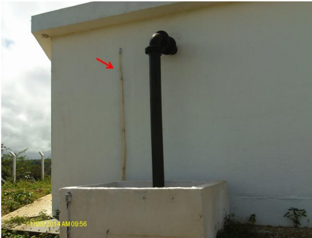
Foto 17 – RAP-11: medidor de nível e descarga.
