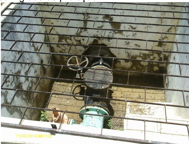
Foto 10 – Caixa de registro na adutora de água tratada na área do REL-24, com grade de proteção.
