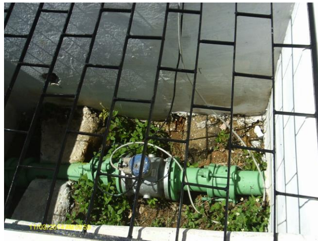
Foto 7 – Macromedidor de água tratada na chegada do RAP-11.
