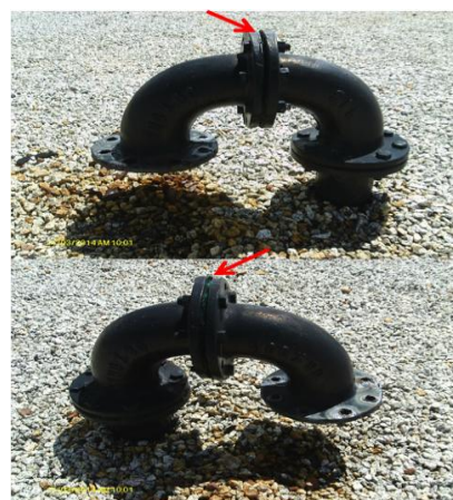
Foto 16 – RAP: tubulações de ventilação com tela de proteção.
