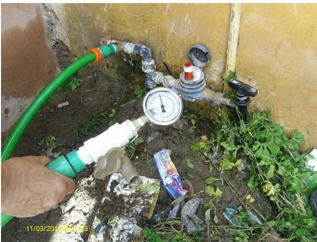
Foto 30 – Medição de pressão na Rua São Luíz, nº 170 – São Luíz.
