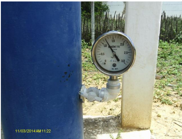
Foto 25 – REL-24: medidor de nível.
