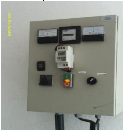
Foto 3 – PT-01: quadro de comando.
