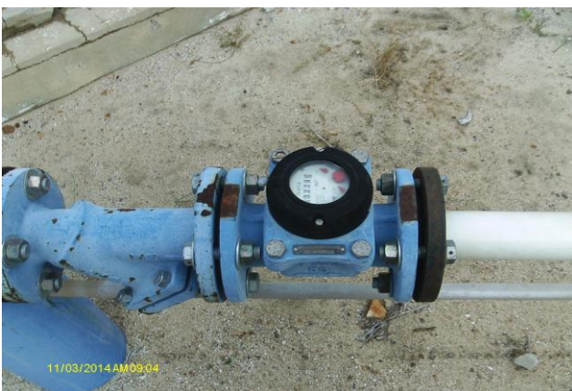
Foto 4 – Macromedidor de água tratada na saída do PT-01.
