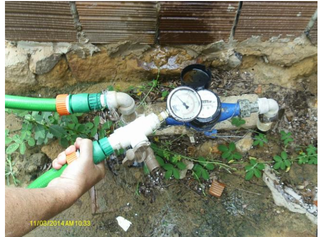
Foto 29 – Medição de pressão na Rua SDO, s/n – Cruzeiro – Praça Portal do Sol.
