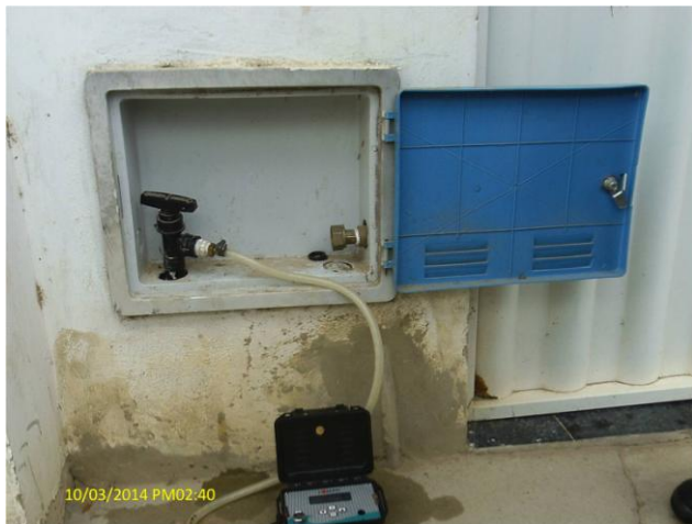
Foto 34 – Medição de pressão com instalação às 15:00h do dia 10/03/14 e retirada às 15:00h do dia 11/03/14, com aparelho datalogger na Rua Manoel Leitão Veras, nº 80 (SMS) - Cruzeiro.
