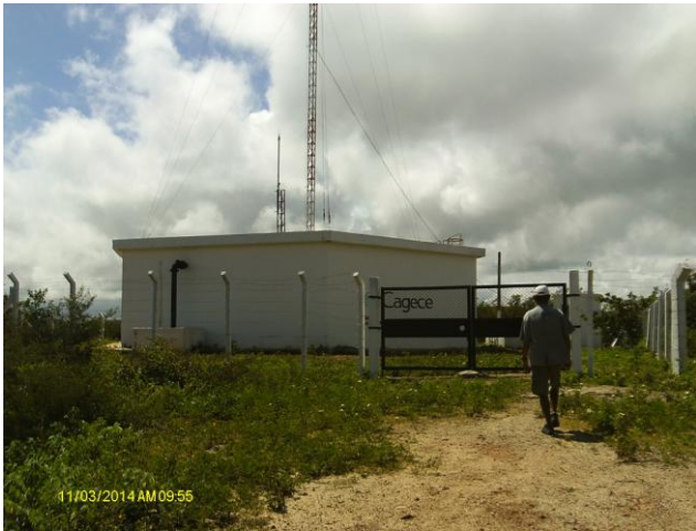
Foto 11 – RAP-11: vista geral e acesso principal.
