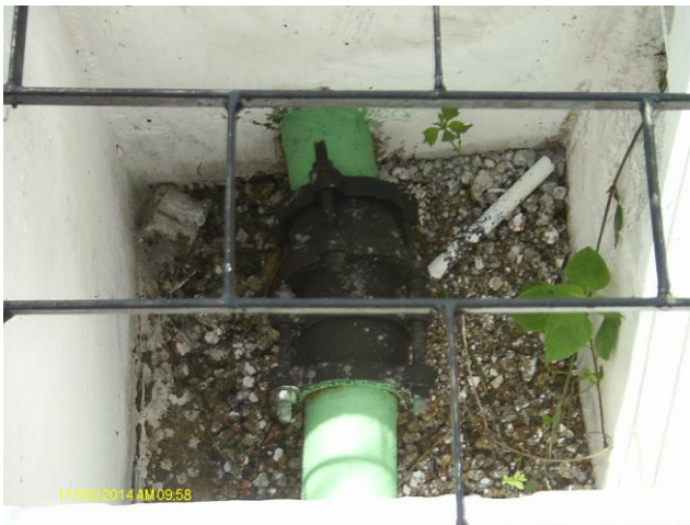
Foto 6 – Caixa de estação pitométrica na adutora de água tratada na área do RAP-11, com grade de proteção.
