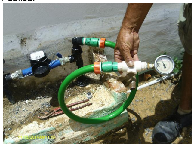
Foto 33 – Medição de pressão na Rua SDO, nº 1.430 – Cajuir.
