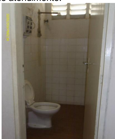
Foto 43 – Instalações sanitárias disponíveis para funcionários e usuários.
