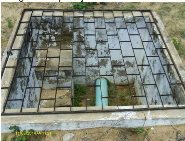
Foto 8 – Caixa de estação pitométrica na adutora de água tratada na área do REL-24, com grade de proteção.
