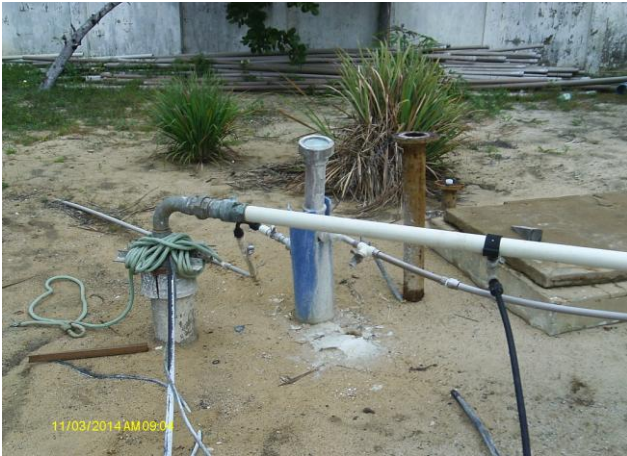
Foto 1 – PT-01: tubulação de recalque com clorador de pastilha.
