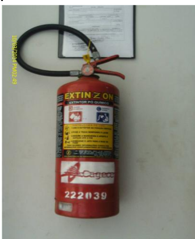
Foto 44 – Extintor de incêndio da loja de atendimento com validade até dez/2014.
