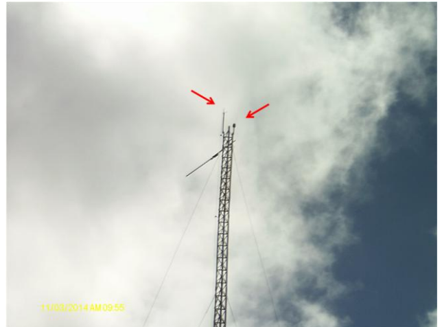
Foto 18 – RAP-11: pára-raios e sinalizador noturno.
