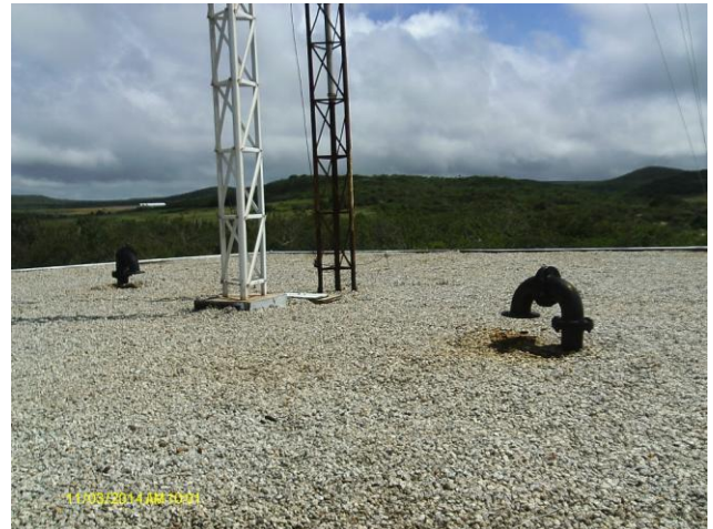
Foto 14 – RAP-11: lastro de brita na laje superior.
