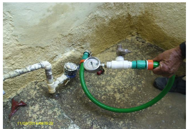
Foto 27 – Medição de pressão na Rua Major Felinto, s/n – Centro.
