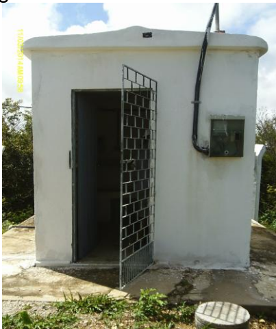
Foto 19 – RAP-11: casa da estação de automação do controle de nível.
