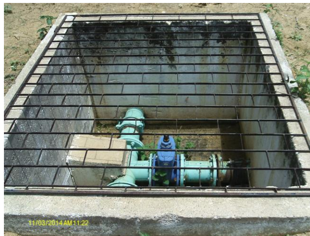
Foto 9 – Caixa de registro na adutora de água tratada na área do REL-24, com grade de proteção.
