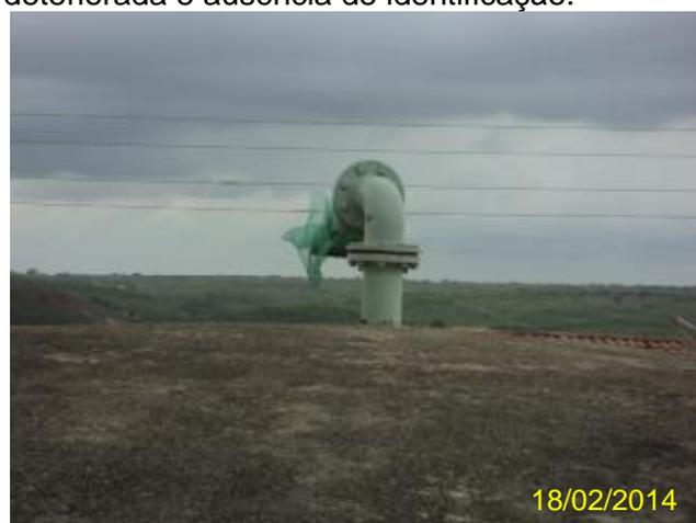
**Foto 91** – RAP-03: tubulação de ventilação com tela de proteção.
