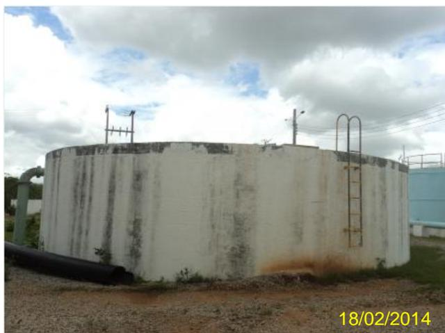
**Foto 82** – RAP-01: escada de acesso, pintura deteriorada e ausência de identificação.
