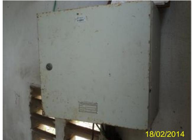
Foto 66 – EERD-01: quadro de comando sem horímetro.
