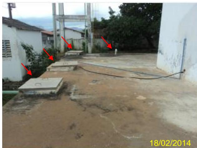
**Foto 105** – RSE-02: tampas de inspeção e tubulação de ventilação.
