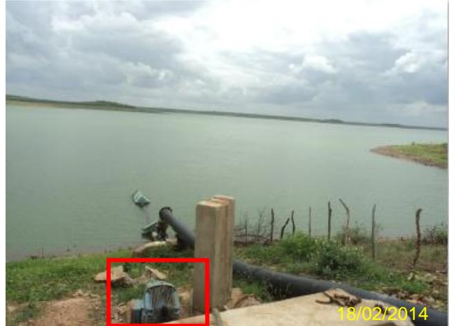
**Foto 6** – EEAB-01: conjunto moto-bomba reserva armazenado ao ar livre próximo a captação.
