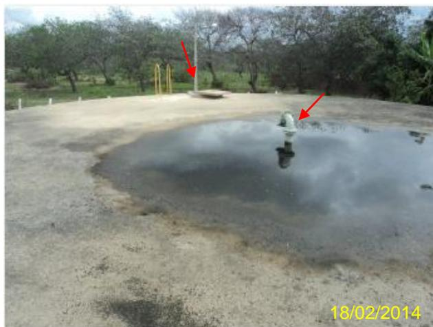
**Foto 87** – RAP-02: cobertura inadequada com acúmulo de água, tampa de inspeção e tubulação de ventilação com tela de proteção.
