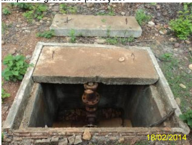
**Foto 45** – AAT: caixa de ventosa instalada sem tampa.
