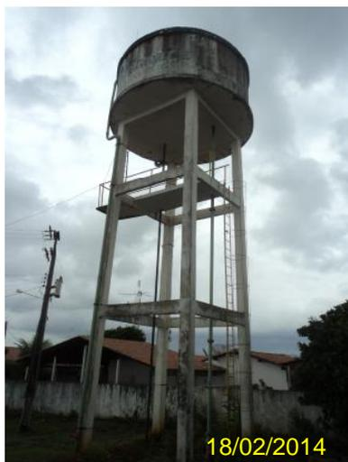
**Foto 98** – REL-02: escada de acesso, pintura deteriorada, ausência de identificação .
