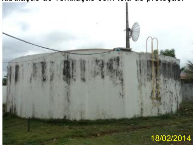
**Foto 89** – RAP-03: escada de acesso, pintura deteriorada e ausência de identificação.
