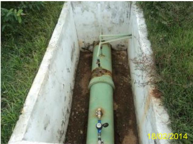
**Foto 43** – AAT: medidor na área da ETA sem tampa ou grade de proteção.
