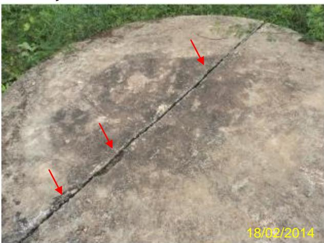
**Foto 108** – RSE-03: fissuras na cobertura do reservatório.
