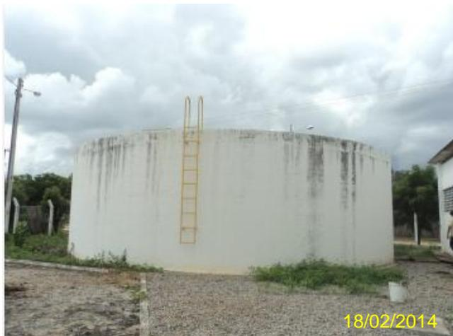
**Foto 86** – RAP-02: escada de acesso, pintura deteriorada e ausência de identificação.
