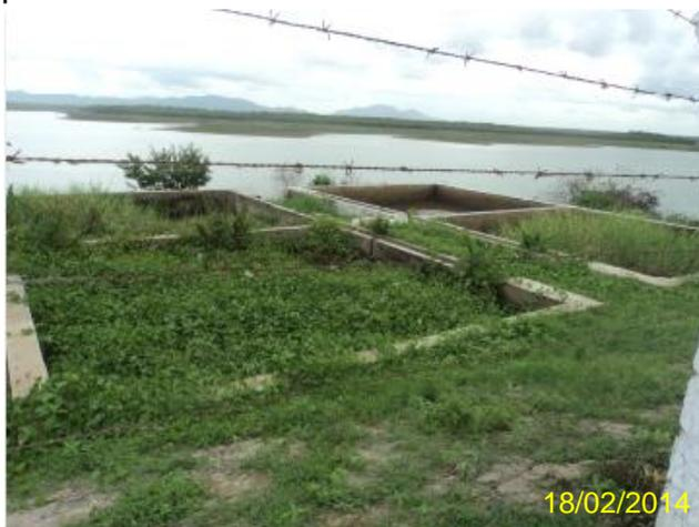
**Foto 39** – ETA: leitos de secagem para os rejeitos da lavagem dos filtros – sem manutenção.
