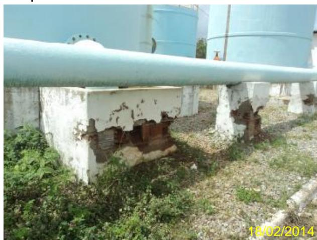
**Foto 26** – Filtração: base de apoio para as tubulações com estrutura deteriorada.
