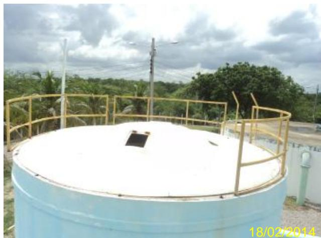
**Foto 24** – Filtro 4: abertura de inspeção sem tampa.
