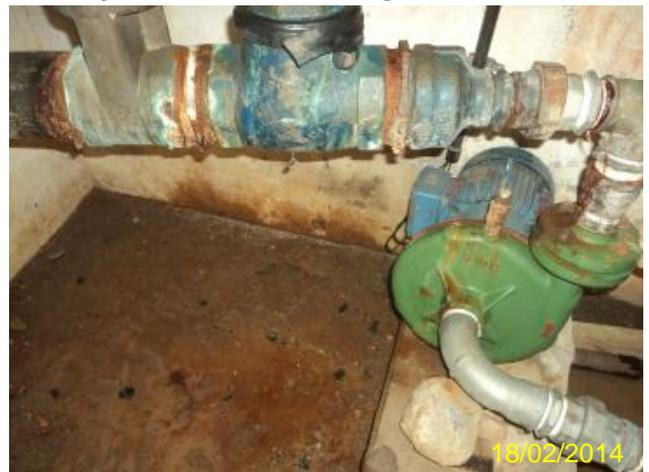
Foto 70 – EERD-02: vazamento no conjunto moto-bomba.
