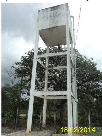
**Foto 100** – REL-09: pintura deteriorada e ausência de identificação.
