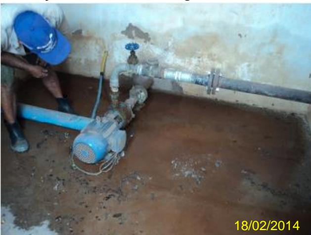
**Foto 79** – EERD-04: conjunto moto-bomba com vazamento.
