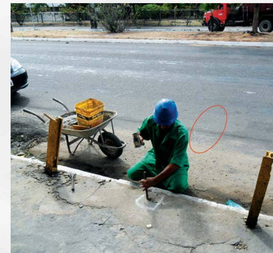
Figura 8 - Técnico da Contratada da Cegás em operação – retirada de parte do piso da calçada para preparação da base para instalação da tacha de sinalização.
