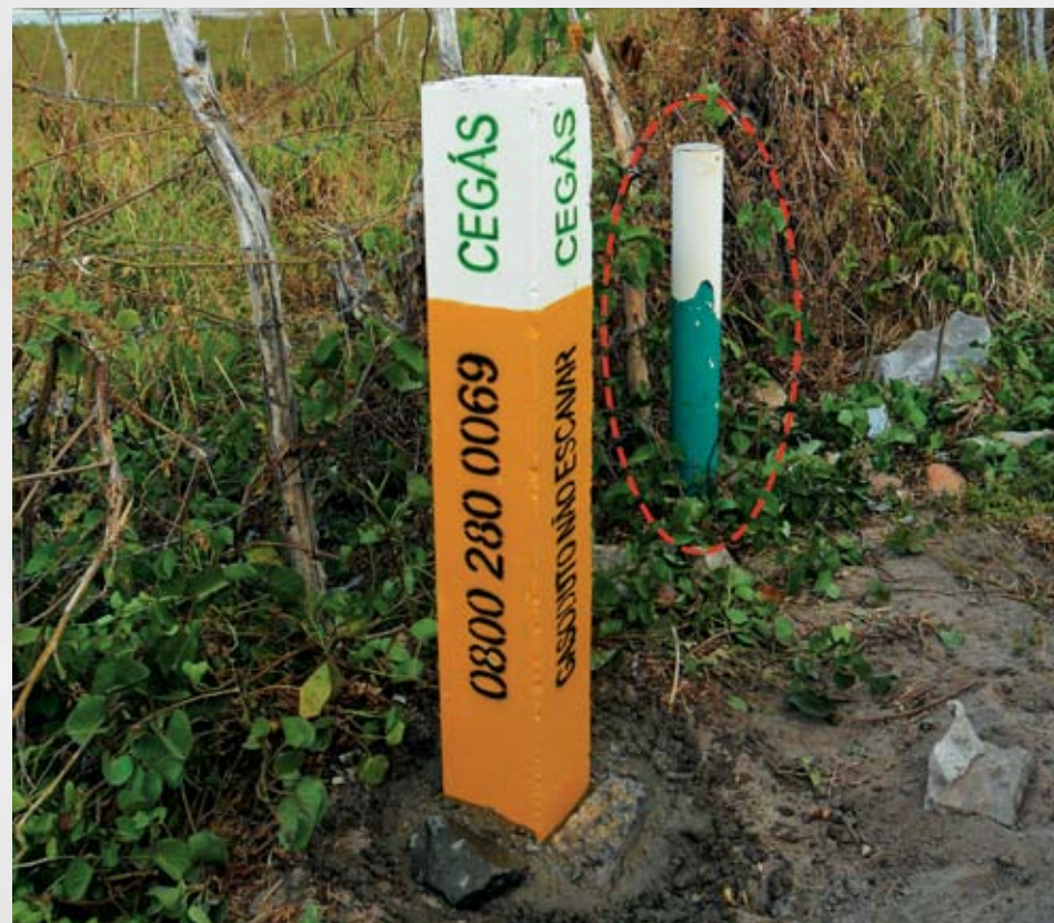
a. Marco de sinalização devidamente instalado.
