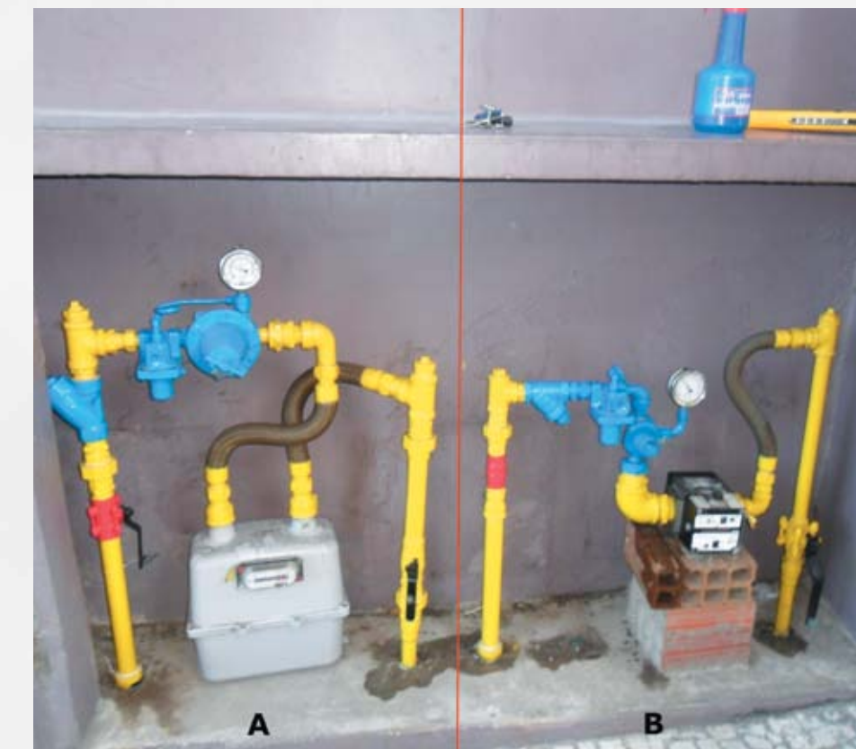
Figura 7 - CRMs das Unidades Usuárias do Segmento Comercial visitadas, localizadas em Fortaleza. (Lado (a): Hotel; Lado (b): Restaurante do Hotel).
