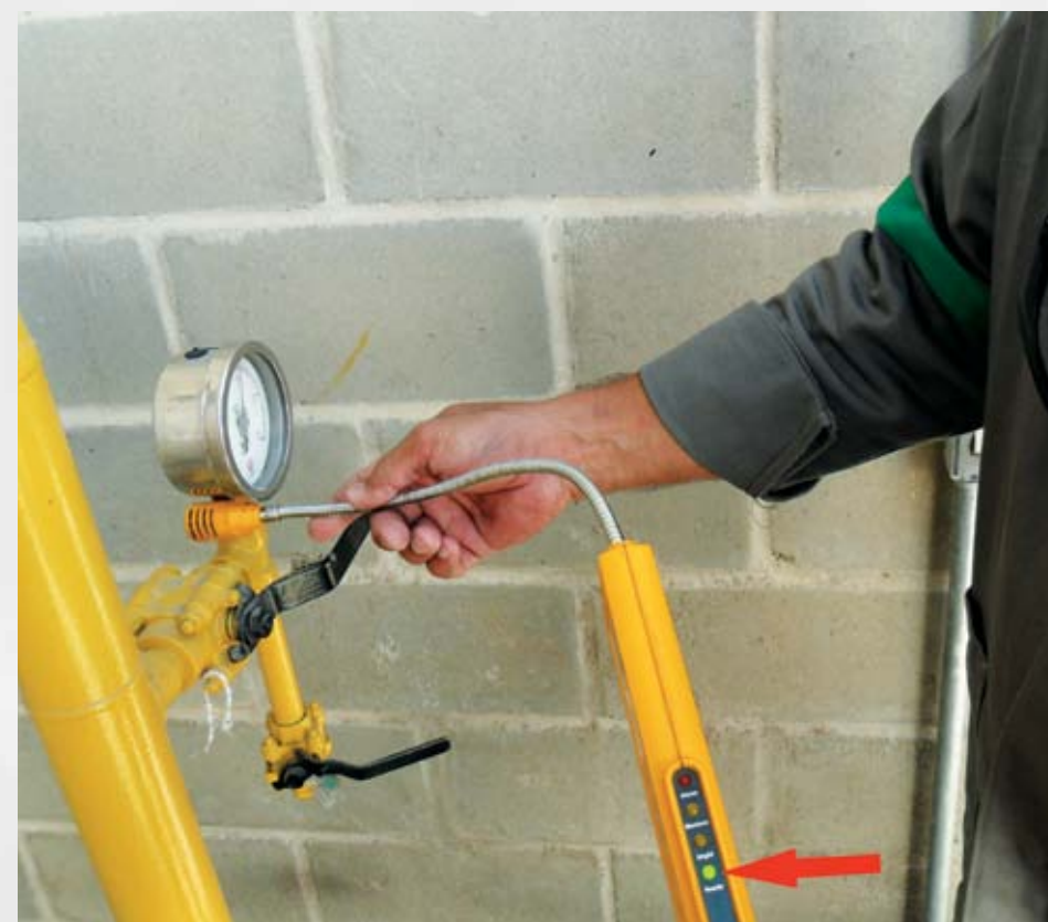
b. Verificação sobre o 2º ponto do CRM que originou o vazamento.
