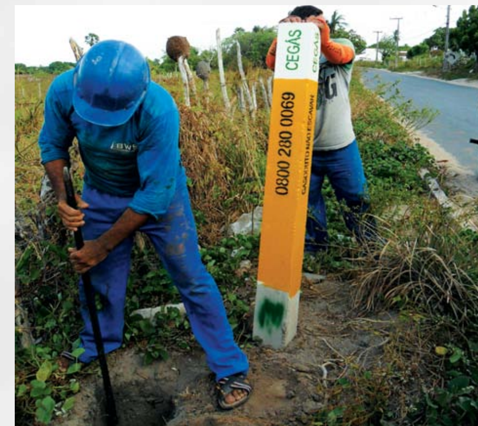
a. Técnico da Contratada da Cegás em operação – escavação de área
