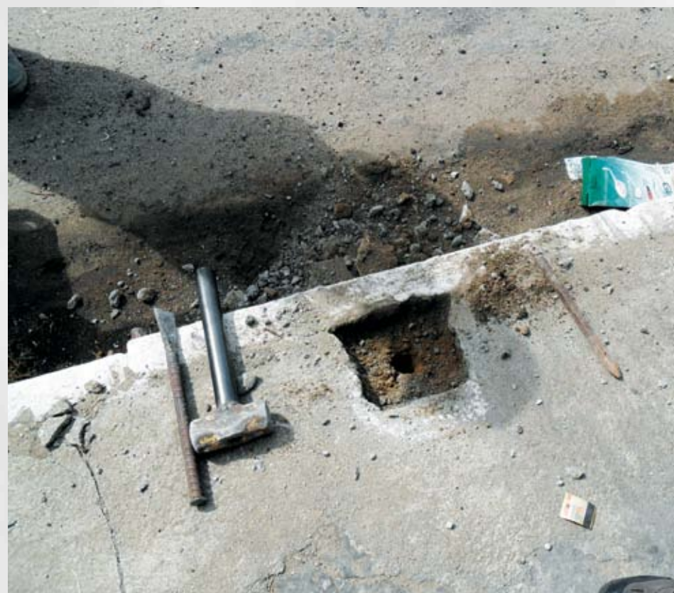
Figura 9a - Vista da área da calçada parcialmente demolida, para fixação da tacha de sinalização.
