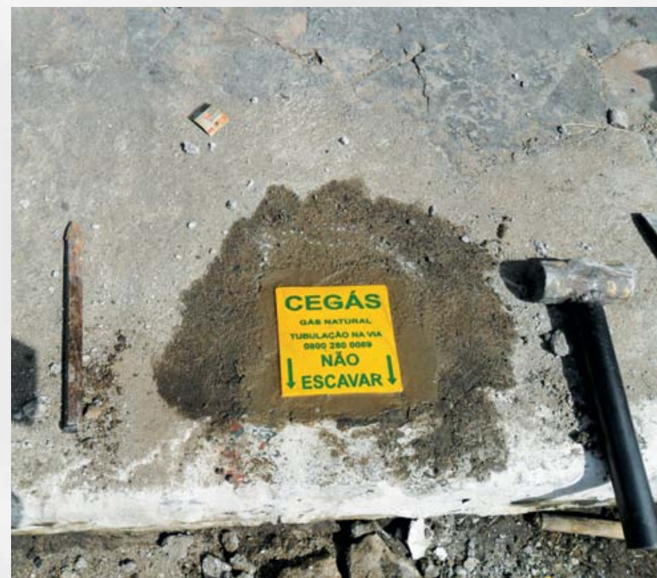
Figura 9b - Tacha de sinalização devidamente instalada na calçada da zona urbana.
