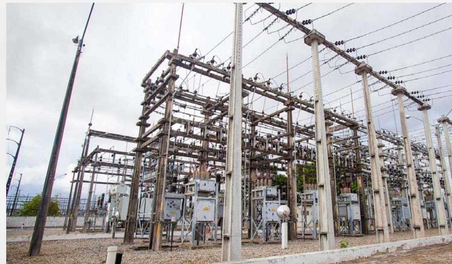
Figura 1 - Subestação da Coelce
