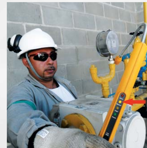
b. Utilização do GAS TRAC na verificação do nível do 1º vazamento localizado – acionamento do LED amarelo na primeira medição.
