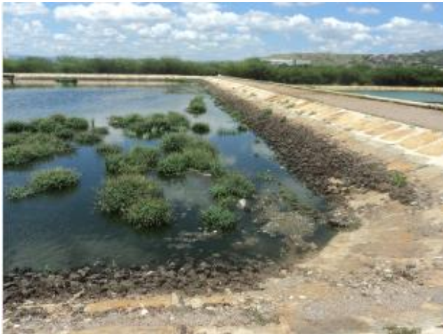
Foto 9 – Vista geral da lagoa anaeróbia 1.
