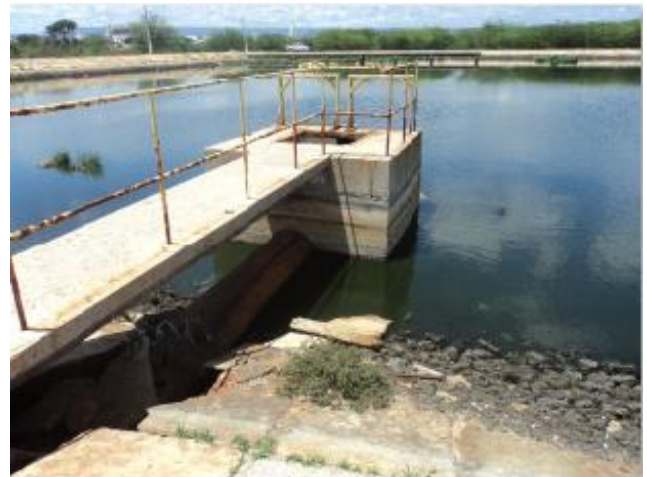
Foto 10 – Estrutura de saída de esgoto na lagoa anaeróbia 1.
