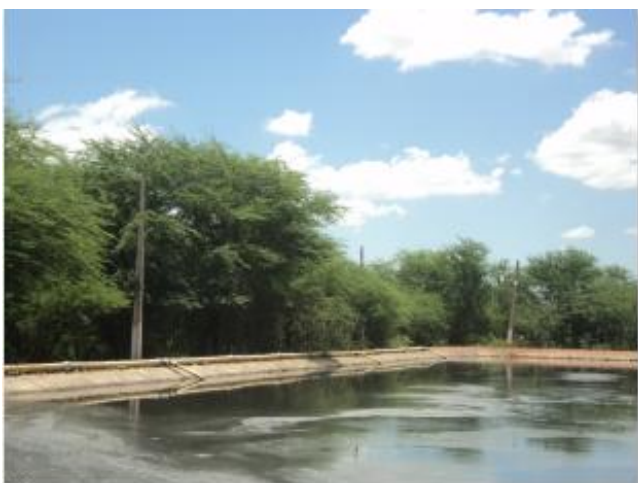
Foto 11 – Postes de iluminação da ETE.
