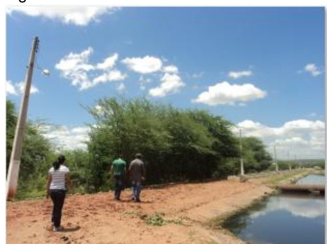
Foto 12 – Postes de iluminação da ETE.
