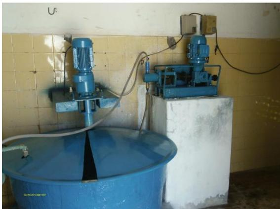
**Foto 10 - ETA: bomba dosadora e tanque de dosagem.**
