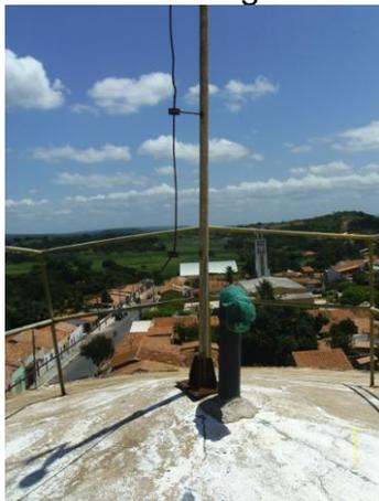
**Foto 33** - REL-01: tubulação de ventilação com tela de proteção.
