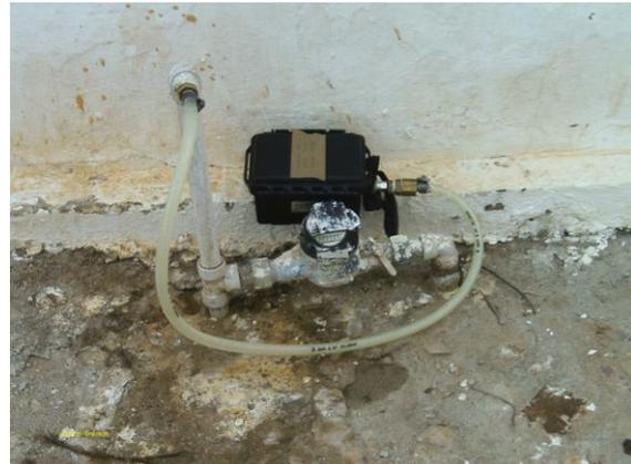
**Foto 47** - Equipamento de medição contínua de pressão (*datalogger*) instalado na Av. Pe Ibiapina, 512 - CAGECE.
