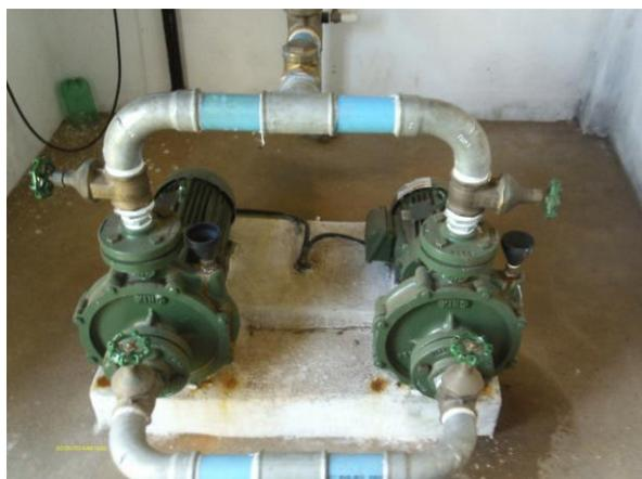
**Foto 23** - *Booster*: conjunto motobomba com reserva instalado.
