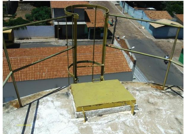
**Foto 32** - REL-01: tampa de inspeção e guarda-corpo na laje de cobertura.
