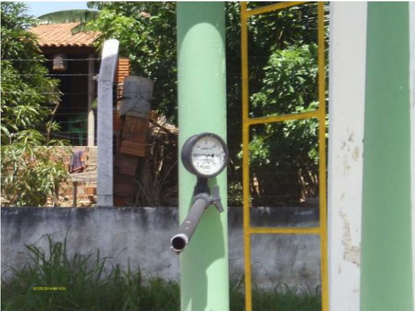
**Foto 43** - REL-02: medidor de nível.
