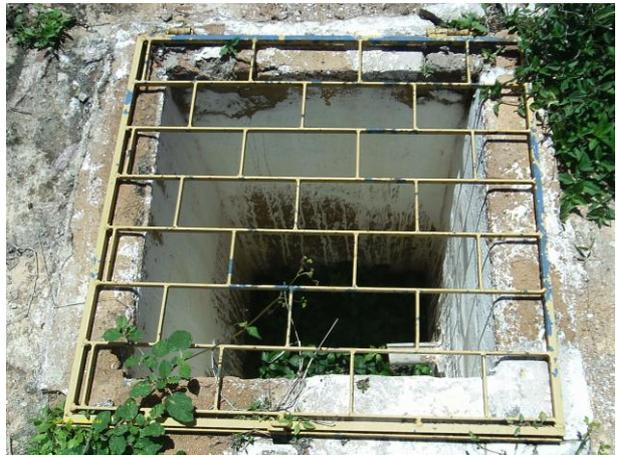
**Foto 38 - REL-01: caixa de inspeção da descarga de fundo.**
