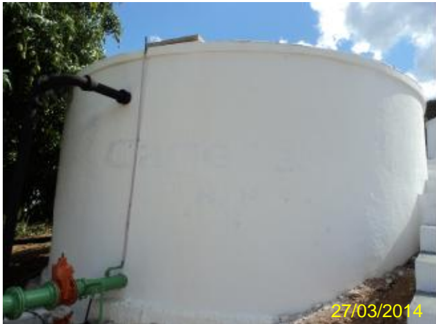
Foto 40 – RAP-03: medidor de nível e ausência de identificação.
