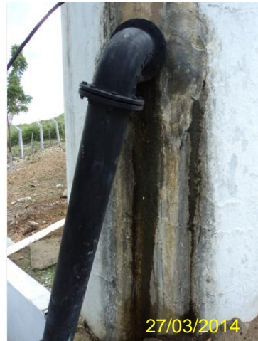
Foto 10 – F1: tubulação de saída com vazamento.
