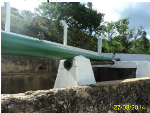
Foto 24 – AAB: estação pitométrica na área da captação.
