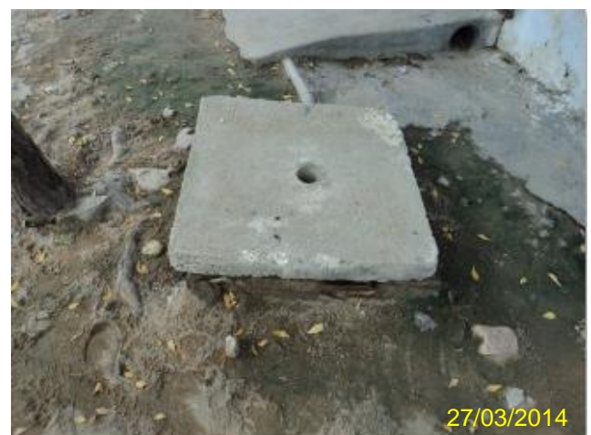
Foto 51 – RDA: registro de descarga na R. José Bezerra – Nossa Senhora do Rosário.
