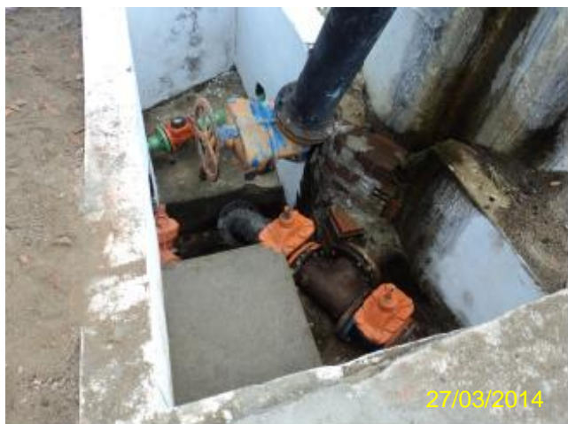
Foto 11 – F1: tubulações e registros.
