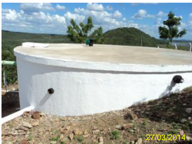
Foto 36 – RAP-01: ausência de identificação.
