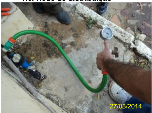
Foto 44 – RDA: medição instantânea de pressão na R. Nila Barreto, SMS 263 – Nossa Senhora do Rosário (Escritório do DNOCS).
