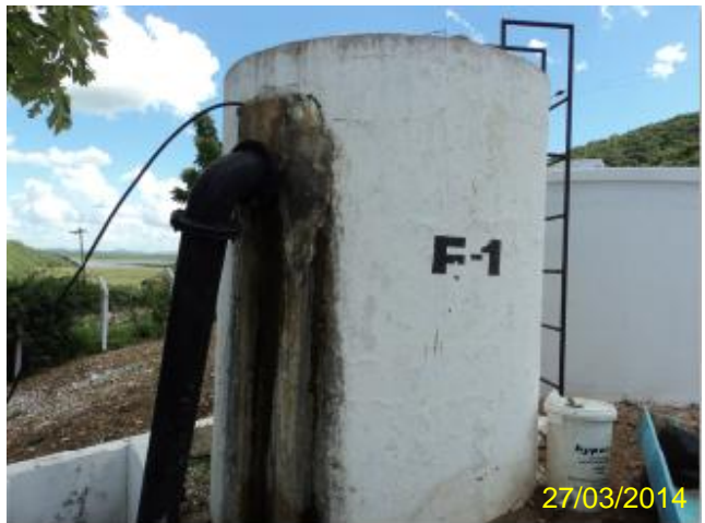
Foto 8 – F1: identificação e pintura deteriorada.
