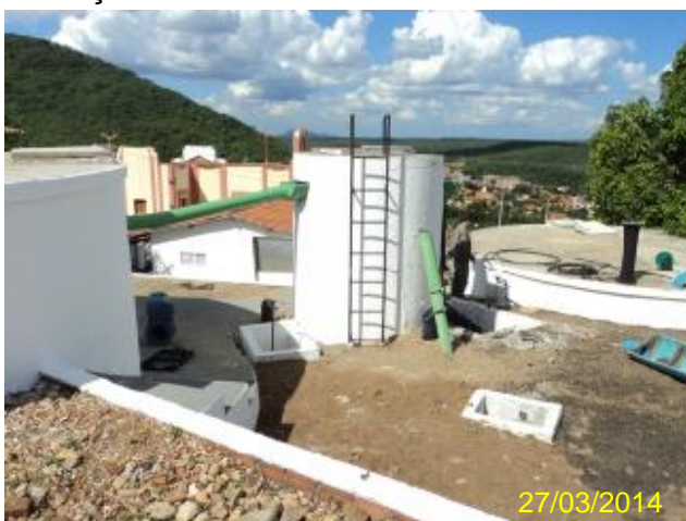
Foto 14 – F2: escada de acesso.
