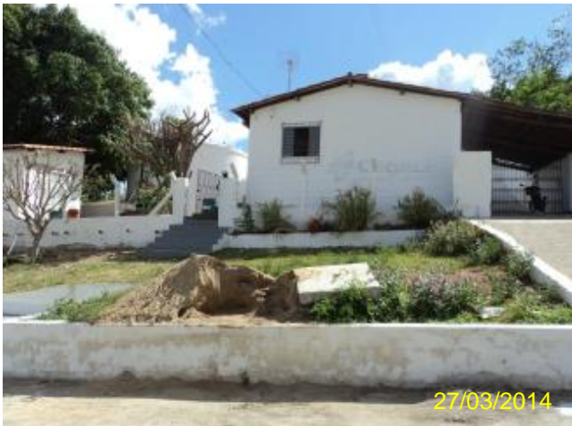
Foto 5 – ETA: sem identificação adequada.
