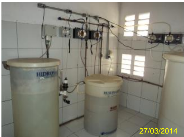
Foto 17 – Casa de química: tanques de dosagem.
