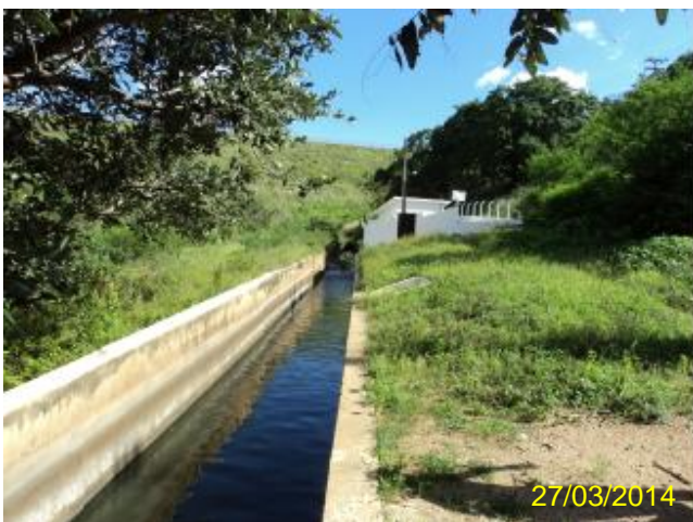
Foto 3 – Canal para o Rio Curu: vista geral.
