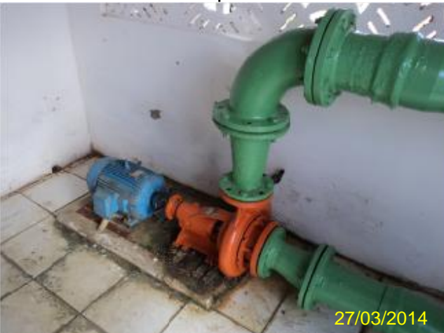
Foto 32 – EELF-01: conjunto moto-bomba sem reserva.
