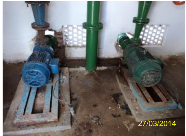
Foto 29 – EEPR-01: conjunto moto-bomba com reserva.
