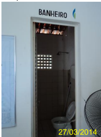
Foto 59 – Loja de atendimento: instalações sanitárias .
