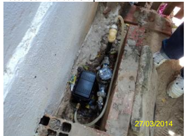
Foto 49 – RDA: medição contínua de pressão na R. Nila Barreto – Nossa Senhora do Rosário.
