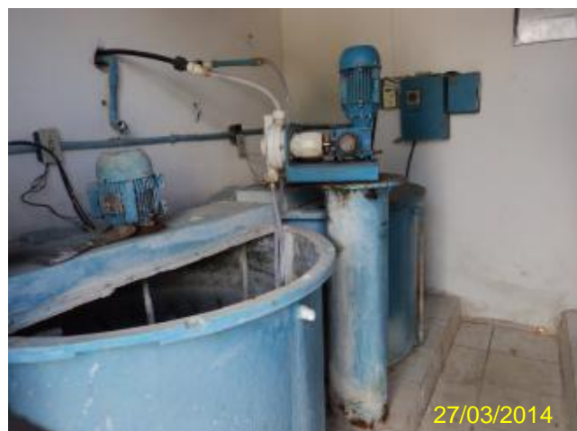
Foto 15 – Casa de química: tanques de dosagem.
