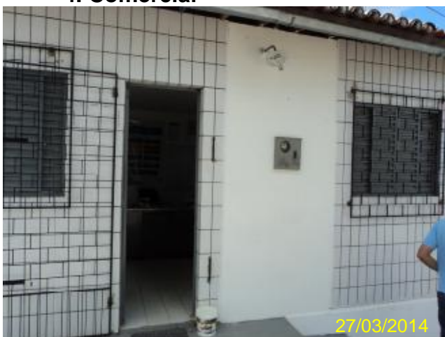
Foto 55 – Loja de atendimento: vista externa.
