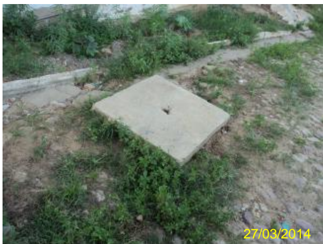
Foto 52 – RDA: registro de descarga na R. Filomeno Barbosa Oliveira.
