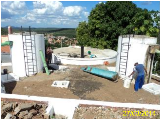
Foto 7 – ETA: vista geral.
