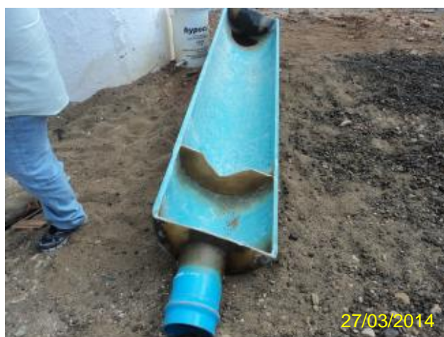
Foto 12 – F1: calha para substituição da tubulação.
