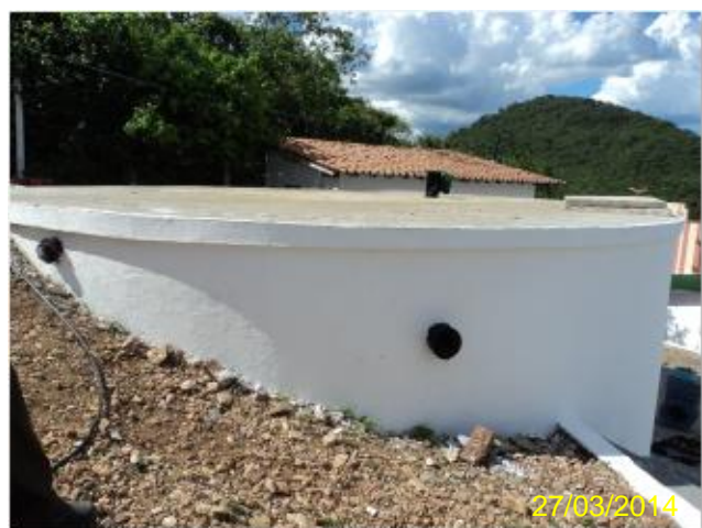
Foto 38 – RAP-02: ausência de identificação.
