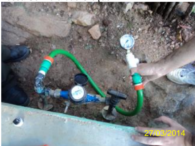
Foto 48 – RDA: medição instantânea de pressão na R. Nila Barreto, 139 – Nossa Senhora do Rosário.
