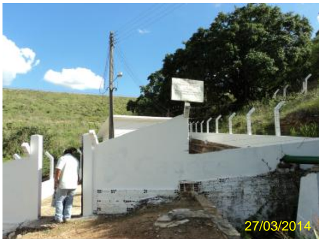
Foto 1 – Captação: área de acesso.
