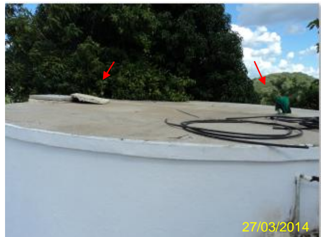
Foto 41 – RAP-03: tampa de inspeção e tubulação de ventilação com tela de proteção.
