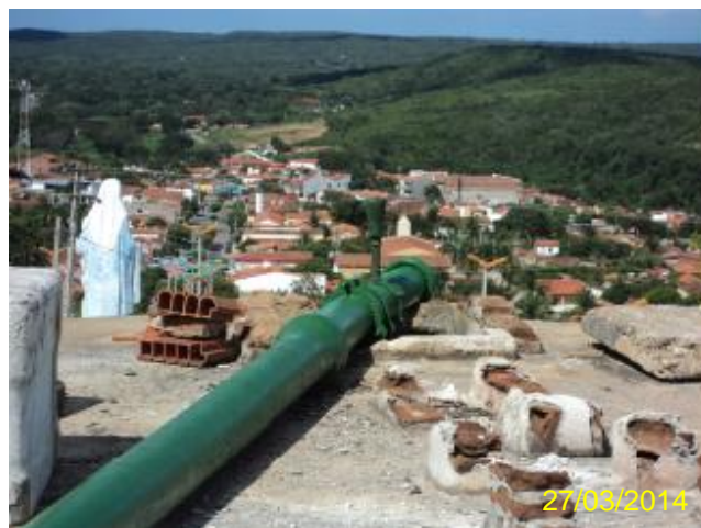
Foto 25 – AAB: ventosa na área da ETA.
