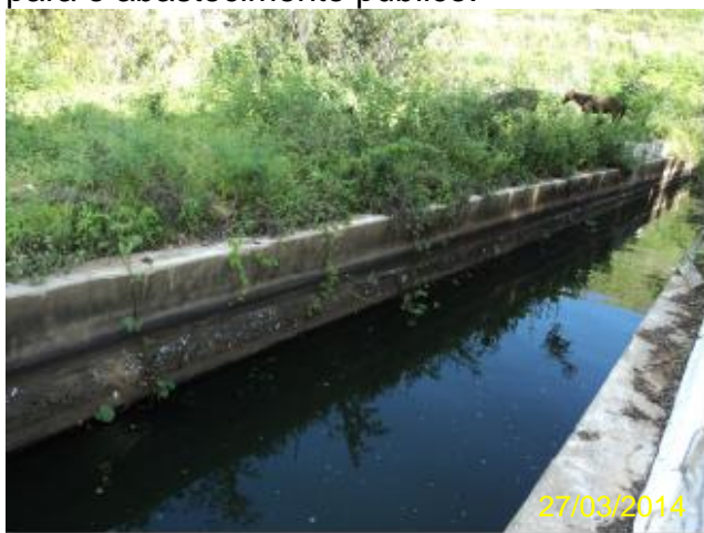
Foto 4 – Canal para o Rio Curu: vista geral.
