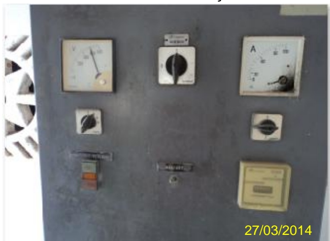
Foto 33 – EELF-01: quadro de comando com amperímetro quebrado.
