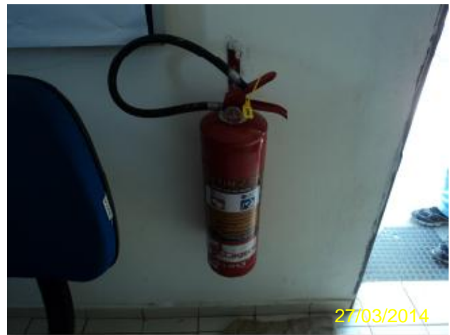
Foto 60 – Loja de atendimento: extintor de incêndio.
