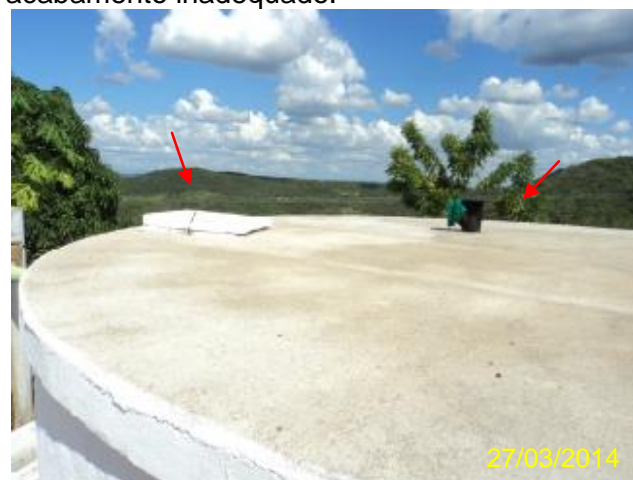
Foto 37 – RAP-01: tampa de inspeção e tubulação de ventilação com tela de proteção..
