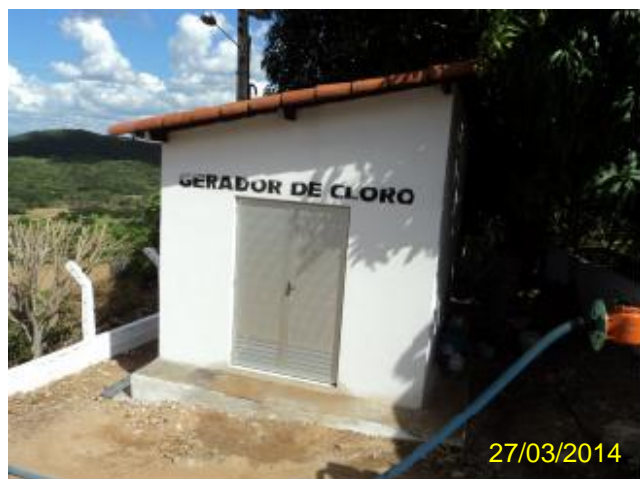
Foto 16 – Casa de química: fábrica de cloro.
