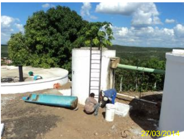
Foto 9 – F1: escada de acesso.
