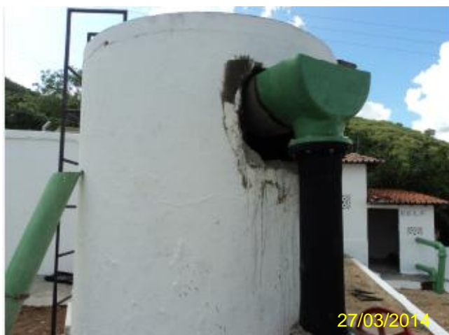
Foto 13 – F2: manutenção – substituição da calha.
