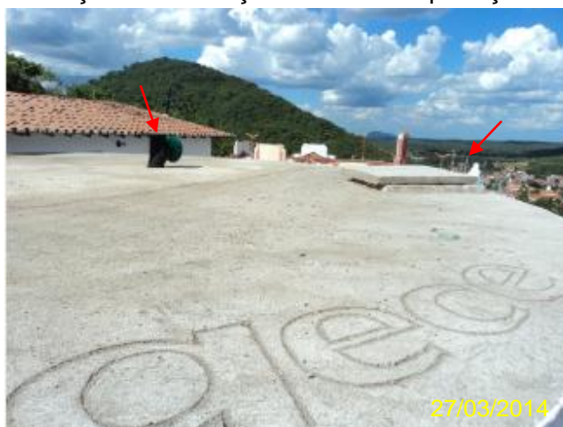
Foto 39 – RAP-01: tubulação de ventilação com tela de proteção e tampa de inspeção.
