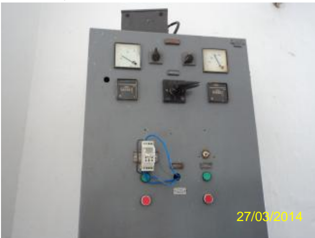
Foto 30 – EEPR-01: quadro de comando.
