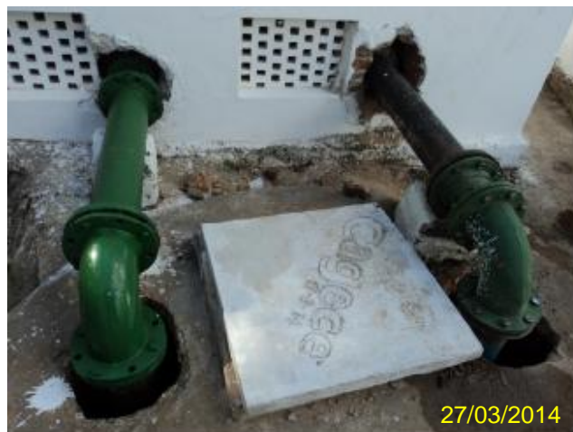
Foto 35 – PRE-01: tampa de inspeção e entrada da tubulação da EEPR-01 com acabamento inadequado.
