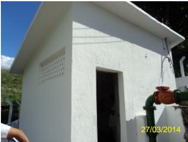
Foto 28 – EEPR-01: ausência de identificação.
