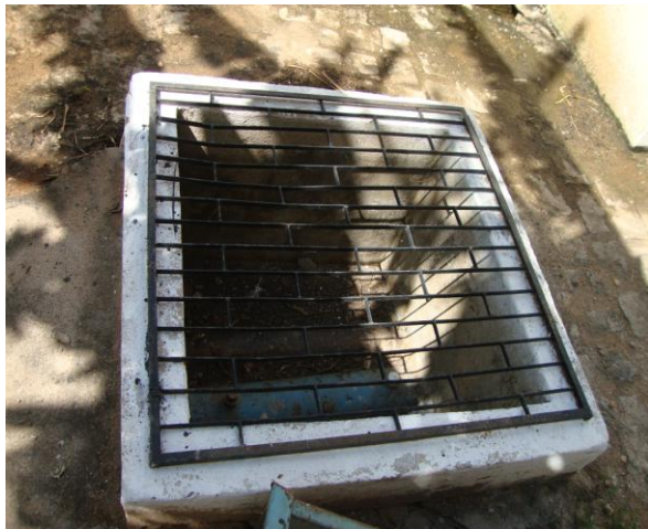
Foto 37 – Caixa de inspeção da estação pitométrica de água tratada no interior da ETA.
