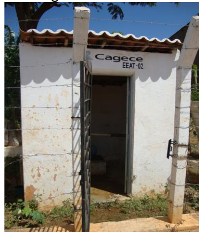
Foto 43 – Vista externa da casa de abrigo da EERD-02 e do quadro de comando.
