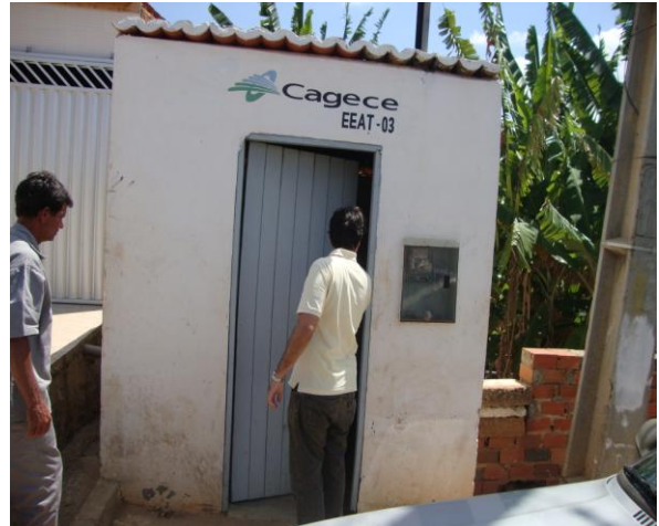
Foto 47 – Vista externa da casa de abrigo da EERD-03 e do quadro de comando.
