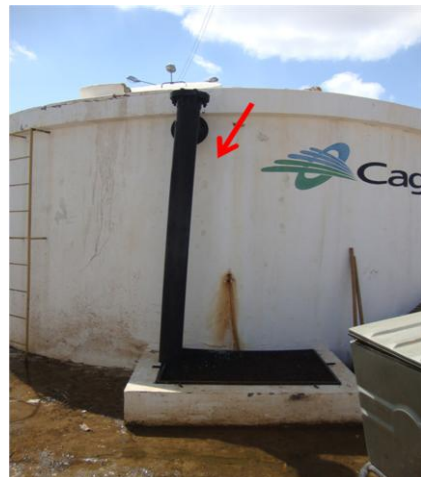
Foto 64 – RAP-01: tubulação para descarga de fundo.
