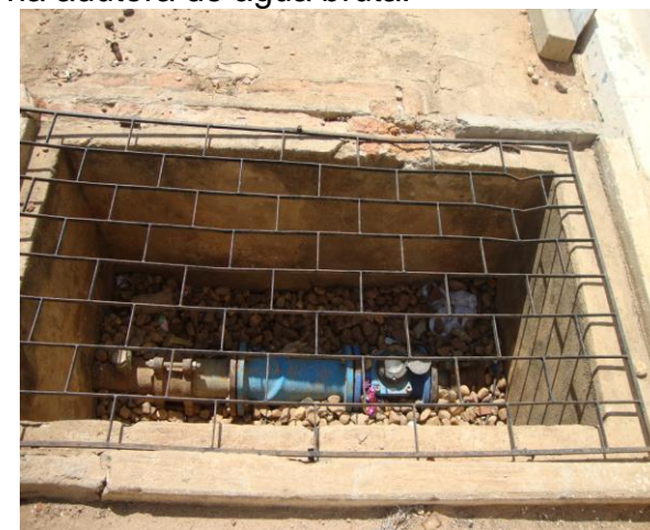
Foto 33 – Macromedidor de água bruta na entrada da ETA.
