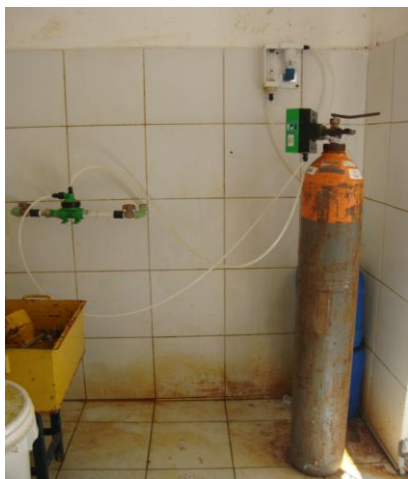
Foto 18 – Dosador de cloro gasoso.
