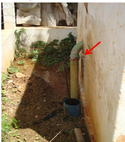
Foto 44 – Tubulação com vazamento na EERD-02.
