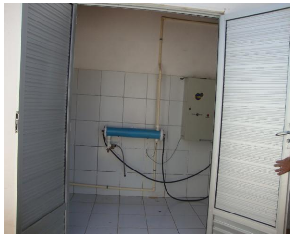
Foto 15 – Vista interna da fábrica de cloro.
