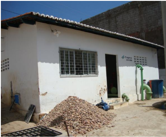
Foto 40 – Vista externa da casa de abrigo da EEAT-01 e EELF-01.
