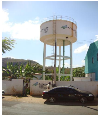
Foto 72 – Vista do REL-01 (desativado).
