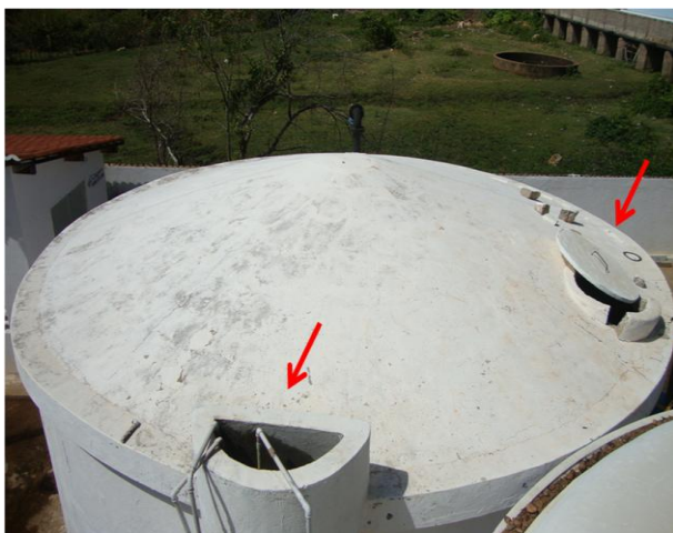
Foto 61 – Vista superior do RAP-01.
