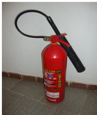
Foto 95 – Extintor de incêndio da loja de atendimento com validade até jun/2017.
