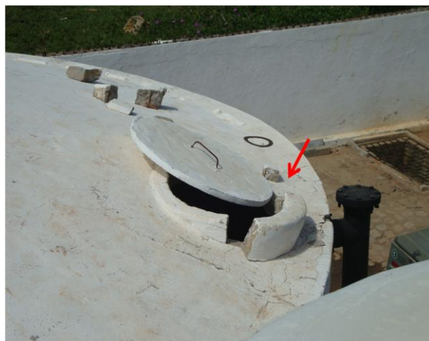
Foto 62 – RAP-01: com abertura danificada.
