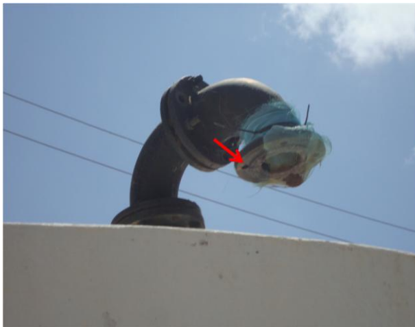
Foto 63 – RAP-01: tubulação de ventilação com tela de vedação danificada.
