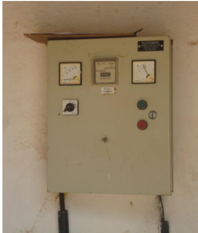
Foto 46 – Quadro de comando da EERD-02.
