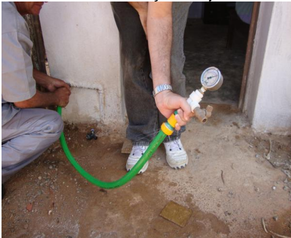
Foto 76 – Medição de pressão no Sítio Baião, nº 75.
