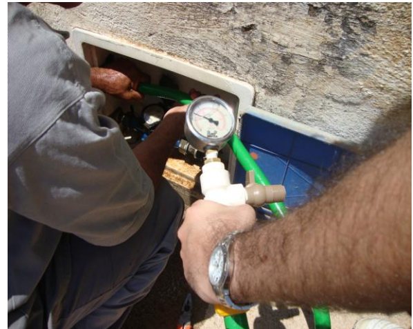
Foto 77 – Medição de pressão na Av. João Terceiro de Sousa (Ao lado da sec.de cultura) – Centro.
