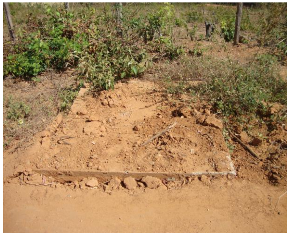
Foto 29 – Caixa de ventosa instalada na adutora de água bruta.
