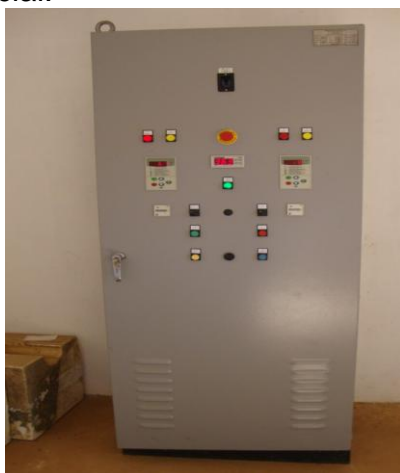
Foto 5 – Quadro de comando da captação superficial.
