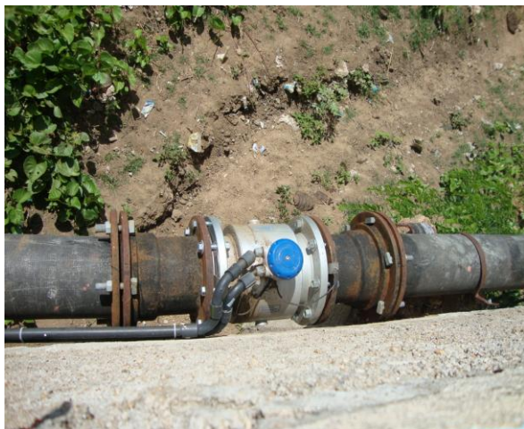
Foto 39 – Macromedidor de água tratada na saída da ETA.
