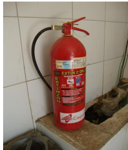
Foto 55 – Extintor de incêndio das EEAT-01 e EELF-01 com validade até jun/2017.
