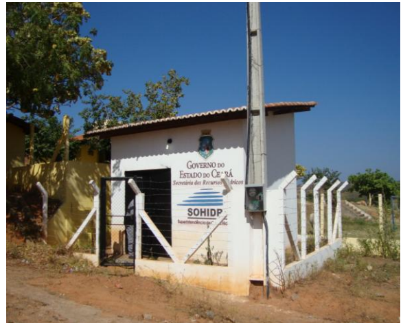
Foto 4 – Casa de abrigo do quadro de comando da captação superficial.
