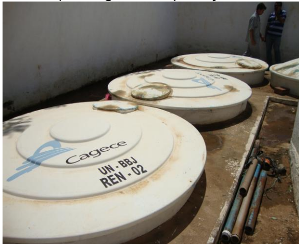
Foto 71 – Reservatórios REN-02, REN-03 e REN-01.
