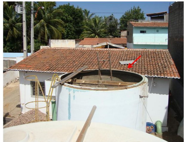
Foto 9 – Vista superior do filtro de fluxo ascendente 01 com tampa aberta.
