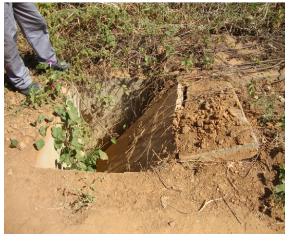
Foto 30 – Caixa de ventosa danificada instalada na adutora de água bruta.
