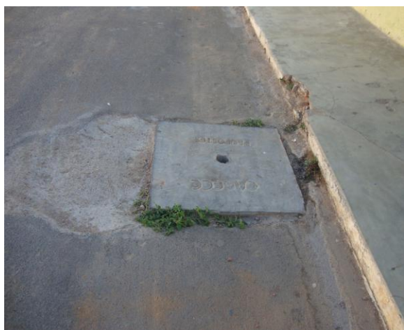
Foto 84 – Registro de descarga na Rua Nel. Queiros, nº 117.
