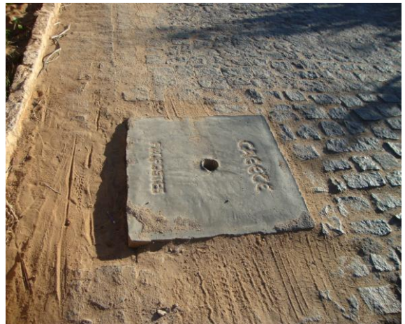
Foto 87 – Registro de descarga na Av. Manoel Raimundo Cavalcante, s/n.
