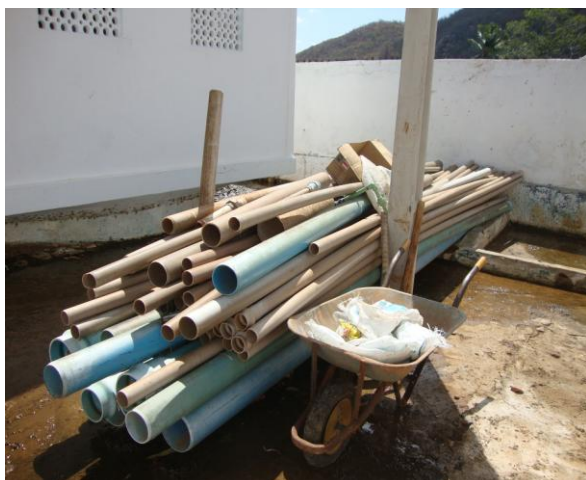
Foto 28 – Tubulação armazenada de forma inadequadamente, na área da ETA.
