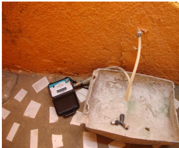
Foto 81 – Medição de pressão com instalação às 15:40 h do dia 16/09/13 e retirada às 15:40h do dia 17/09/13, com aparelho datalogger na Av. Santos Dumont, nº 507 – Centro.
