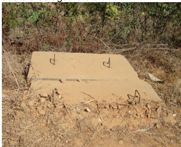
Foto 31 – Caixa de descarga instalada na adutora de água bruta.
