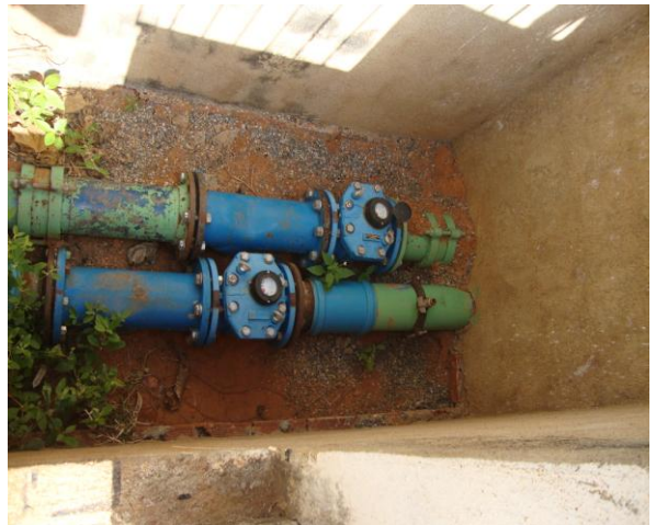
Foto 38 – Macromedidores de água tratada na saída do RAP-02.
