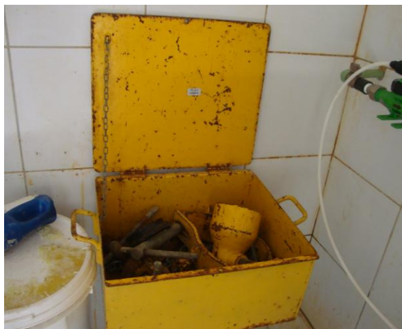
Foto 20 – Kit de emergência para cloro gasoso.
