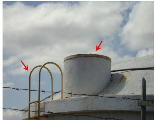
Foto 66 – RAP-02: com escada e tampa vedada adequadamente.
