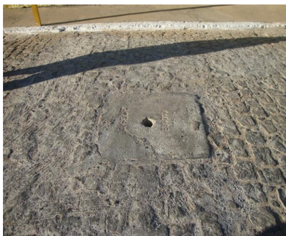
Foto 85 – Registro de descarga na Rua Pe. Miguel Xavier, s/n.
