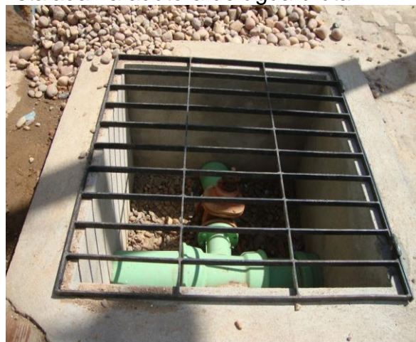
Foto 32 – Caixa de registro com grade na adutora de água bruta no interior da ETA.
