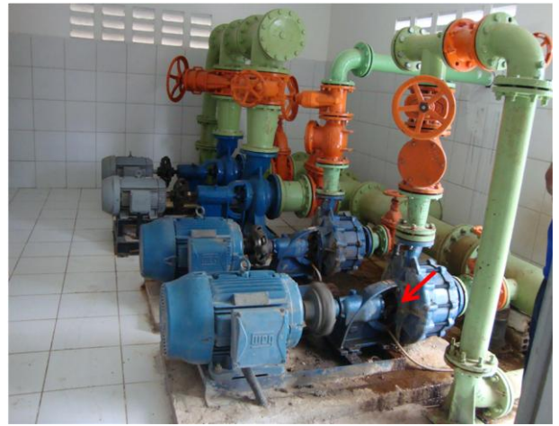
Foto 41 – Conjunto motor-bomba das elevatórias EEAT-01 e EELF-01, com problemas na gaxeta da EEAT-01.
