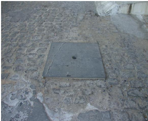
Foto 86 – Registro de descarga na Rua Manoel Mourão, nº 559.
