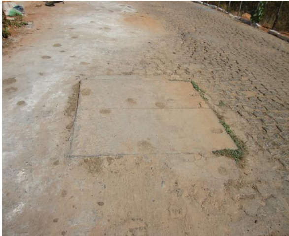
Foto 35 – Descarga instalada na adutora de água tratada.
