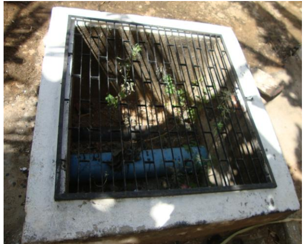
Foto 36 – Caixa de inspeção da estação pitométrica de água tratada no interior da ETA.
