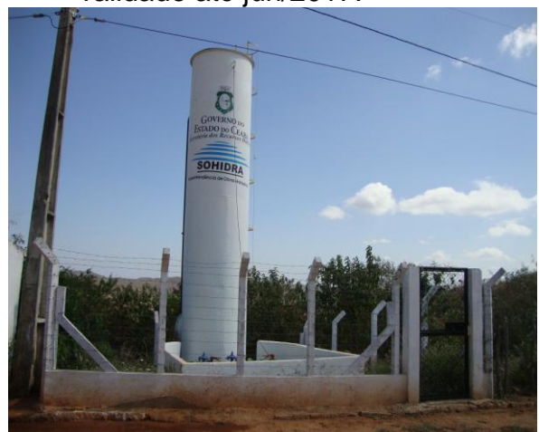
Foto 57 – Torre de equilíbrio de água tratada.
