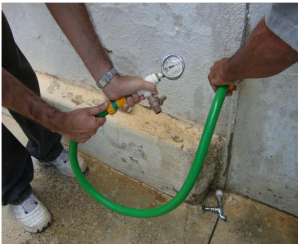
Foto 78 – Medição de pressão na Rua Severo Holanda (Creche Pingo de Gente) – Centro.
