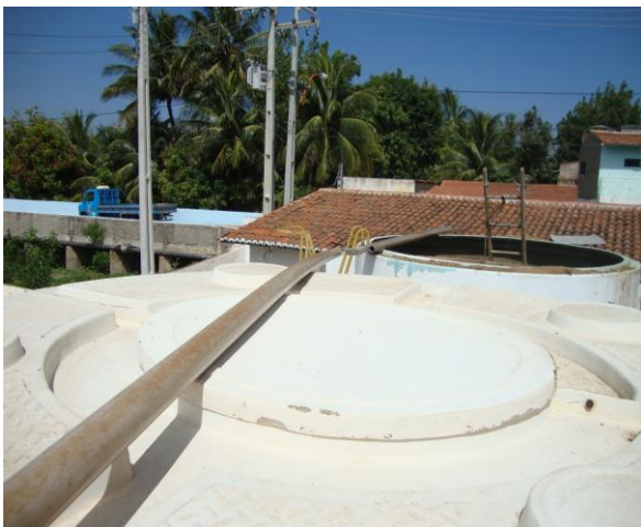
Foto 10 – Vista superior do filtro de fluxo ascendente 02 com tampa.
