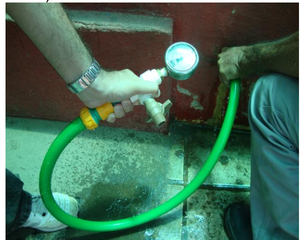
Foto 79 – Medição de pressão na Rua Coronel Porto (Rodoviária) – Centro.
