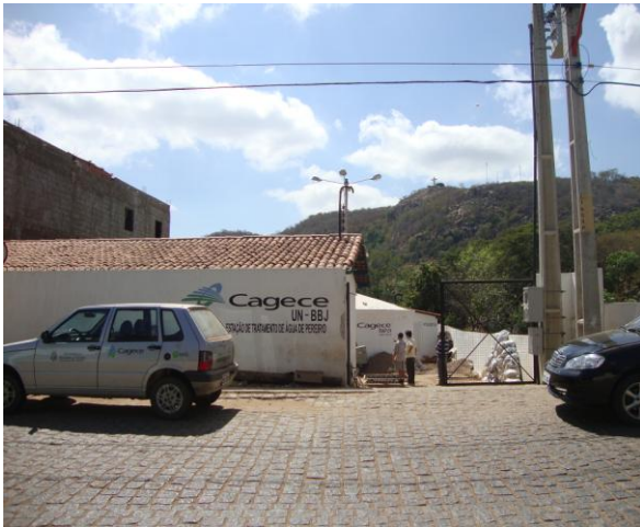
Foto 6 – Vista externa da ETA.
