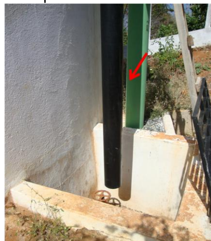
Foto 68 – RAP-02: tubulação para descarga de fundo.
