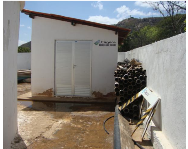
Foto 13 – Vista externa da fábrica de cloro.
