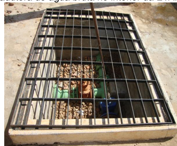
Foto 34 – Caixa de registro com grade na adutora de água bruta no interior da ETA.
