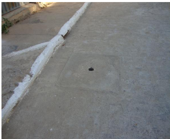
Foto 82 – Registro de descarga na Rua Odílio Silva, nº 174
