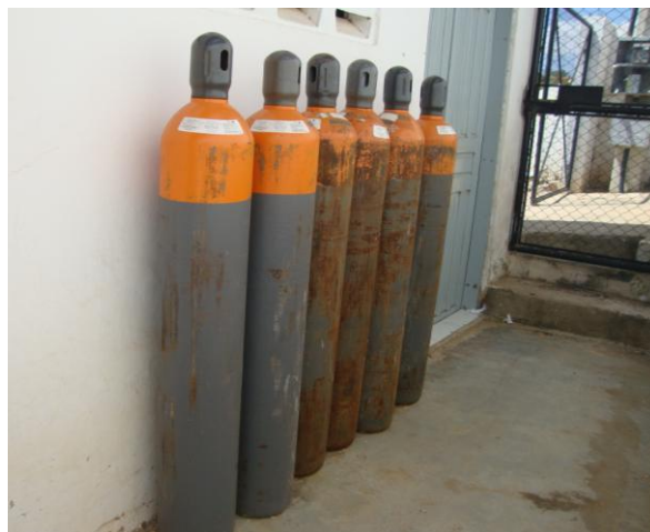
Foto 19 – Cilindros de cloro gasoso.
