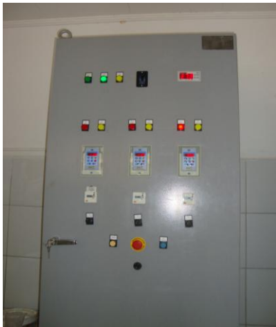
Foto 42 – Quadro de comando das EEAT-01 e EELF-01.
