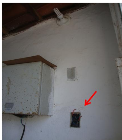
Foto 50 – Elevatória EERD-03 sem dispositivo de liga/desliga.
