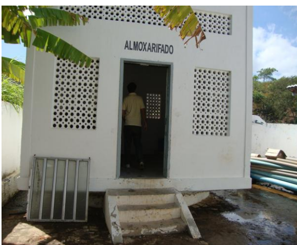
Foto 16 – Vista externa do almoxarifado de produtos químicos.
