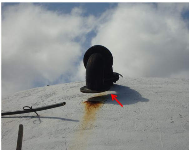
Foto 67 – RAP-02: tubulação de ventilação sem tela de vedação.
