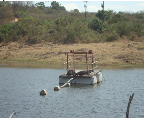
Foto 3 – Flutuante da captação superficial.
