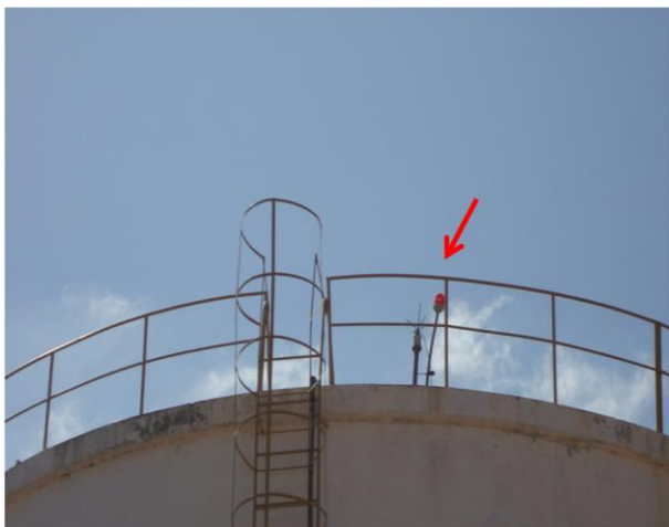
Foto 73 – REL-01: com existência de guarda-corpo na laje, para-raios e sinalizador noturno.
