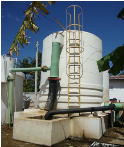
Foto 8 – Vista frontal do filtro de fluxo ascendente 02.
