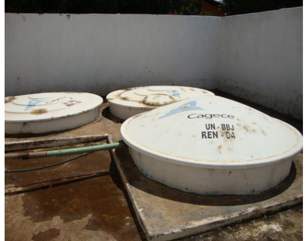
Foto 70 – Reservatórios REN-04, REN-01 e REN-03.
