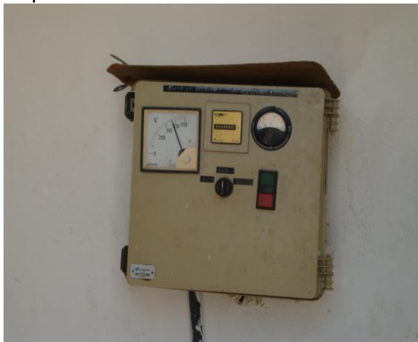
Foto 54 – Quadro de comando da EERD-05.
