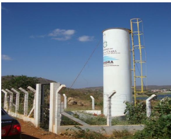
Foto 56 – Torre de equilíbrio de água bruta, próximo a captação.
