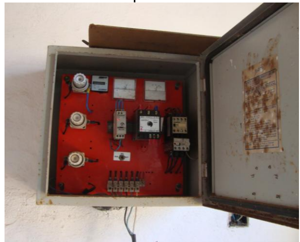
Foto 49 – Quadro de comando da EERD-03.
