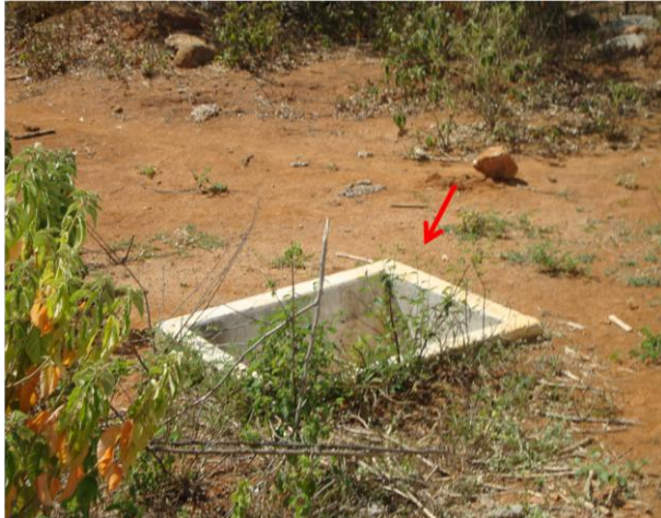
Foto 69 – RAP-02: caixa de descarga sem tampa ou grade de proteção.
