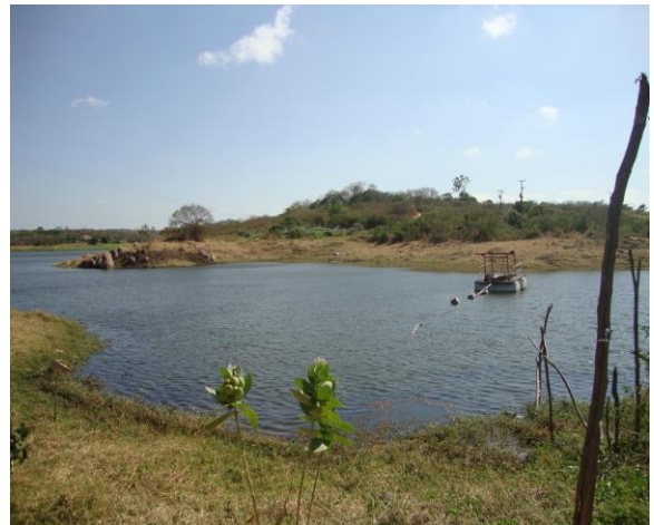
Foto 2 – Vista da captação do Açude Adauto Bezerra.
