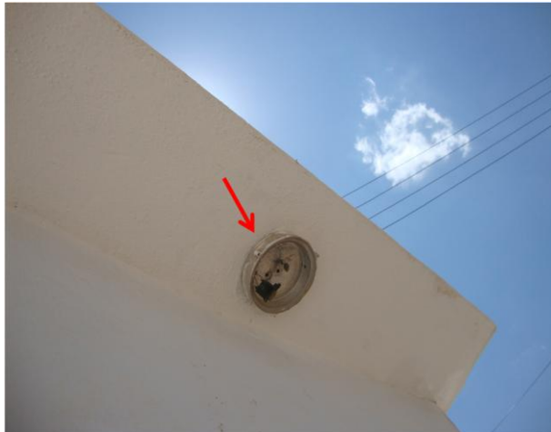
Foto 52 – Luminária da EERD-05 está sem lâmpada.
