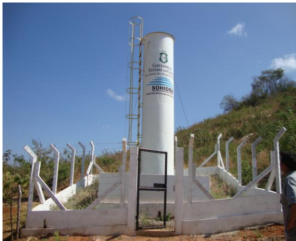
Foto 58 – Torre de equilíbrio de água tratada.
