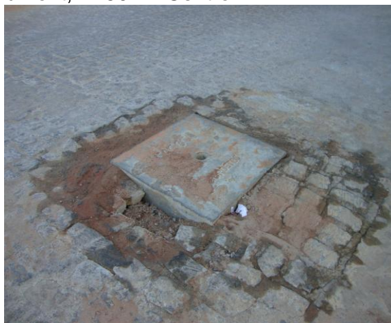
Foto 83 – Registro de descarga na Av. João Holanda, nº 59.
