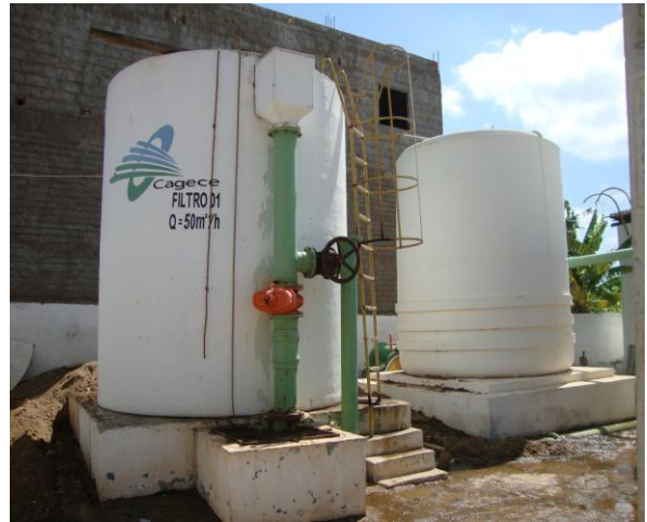
Foto 7 – Vista frontal dos filtros de fluxo ascendente 01 e 02.
