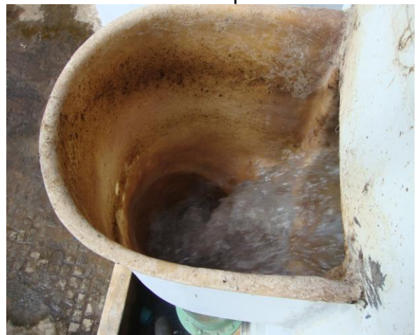
Foto 11 – Vista superior do efluente de água tratada do filtro 02.
