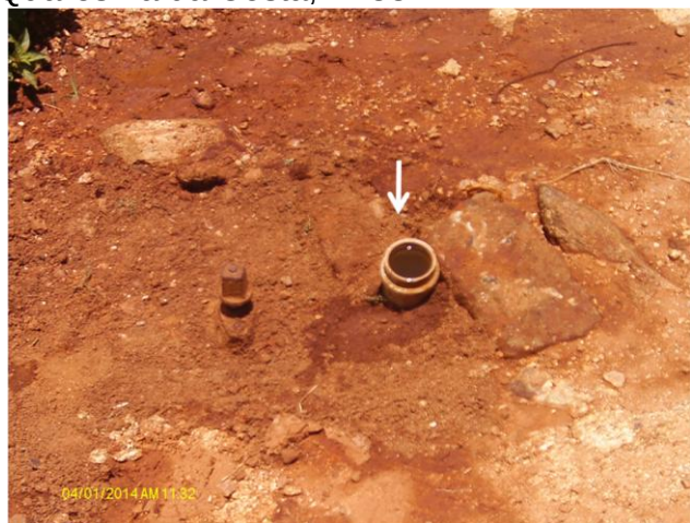
Foto 54 – Registro de descarga na Rua Francisco Pereira de Araújo, nº 84.
