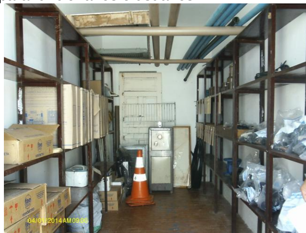
Foto 62 – Vista interna do almoxarifado.
