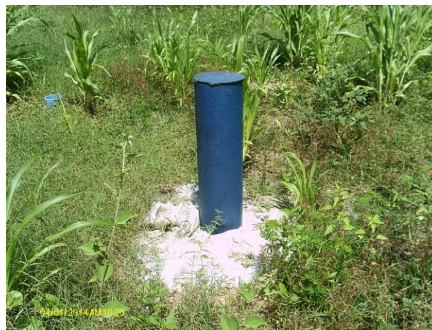
Foto 8 – PT: poço a ser implantado próximo ao PA-02.
