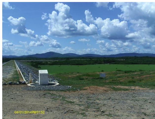
Foto 12 – Nova adutora em processo de implantação.
