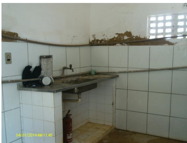
Foto 17 – Vista interna da casa de química.
