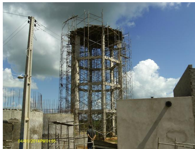
Foto 14 – Nova ETA em processo de implantação próxima a adutora.
