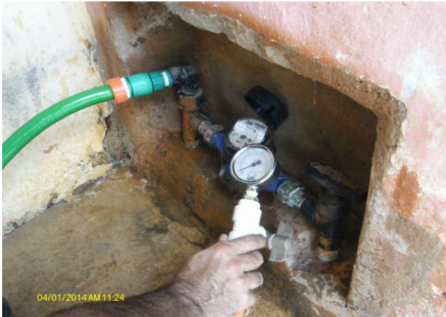
Foto 46 – Medição de pressão na Rua João Nunes, s/n.
