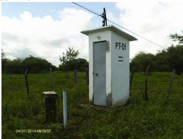
Foto 9 – PT-01 (desativado): poço e casa de abrigo do quadro de comando.
