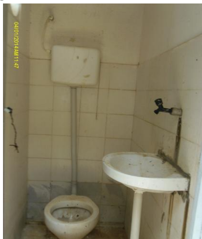
Foto 21 – Instalações sanitárias disponíveis para funcionários na casa de química.
