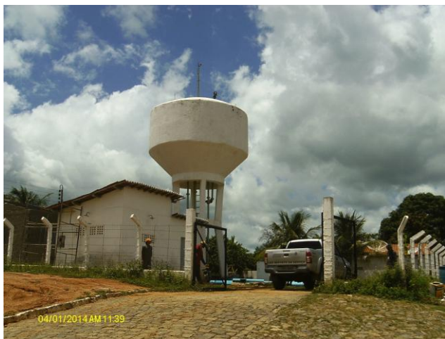
Foto 35 – Vista do acesso ao REL-01.
