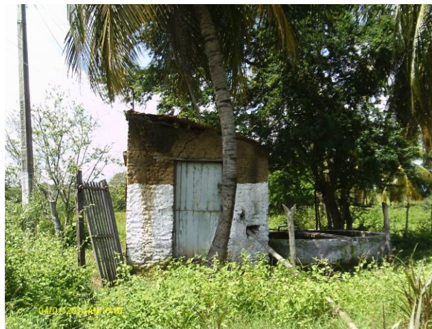
Foto 4 – PA-02: poço emergencial e casa de abrigo do quadro de comando.
