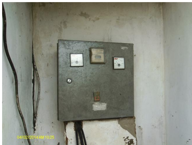
Foto 13 – PT-04: quadro de comando.
