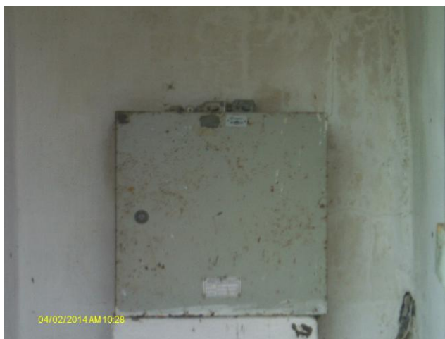
Foto 11 – PT-03: quadro de comando.
