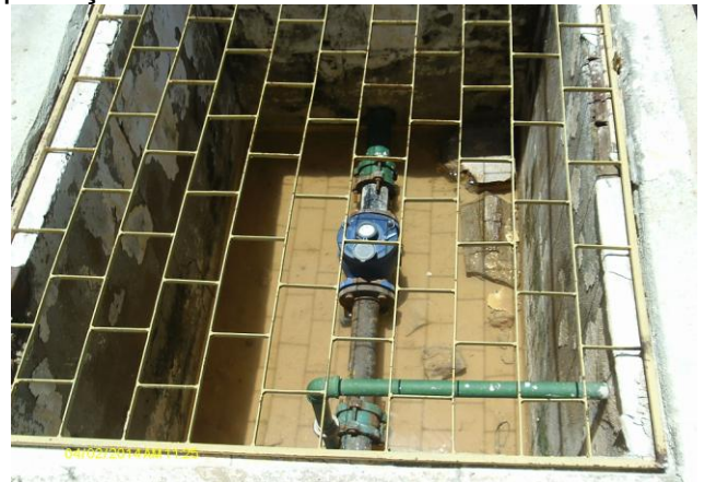
Foto 45 – Macromedidor de água tratada na entrada do REL-01.
