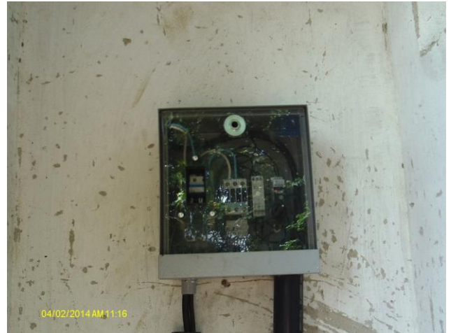
Foto 26 – PT-08: quadro de comando.
