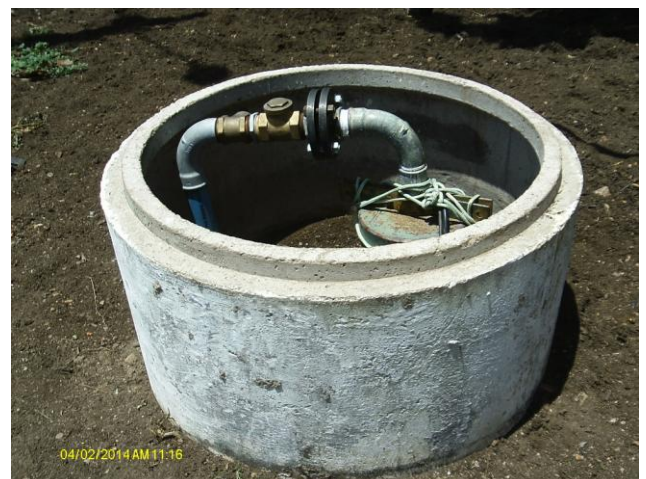
Foto 24 – PT-08: tubulação de recalque.
