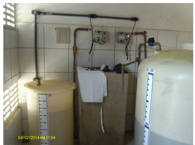
Foto 29 – Vista interna da fábrica de cloro.
