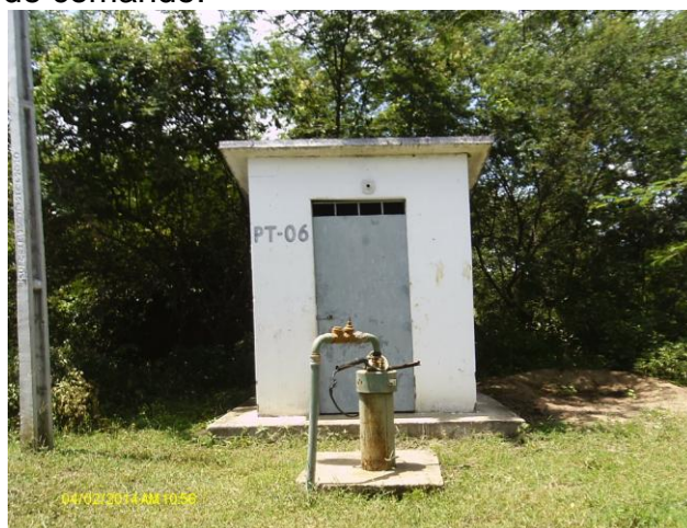
Foto 18 – PT-06: poço e casa de abrigo do quadro de comando.
