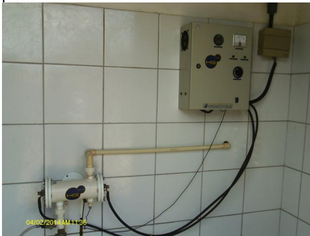
Foto 32 – Vista interna da fábrica de cloro.
