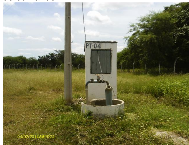
Foto 12 – PT-04: poço e casa de abrigo do quadro de comando.
