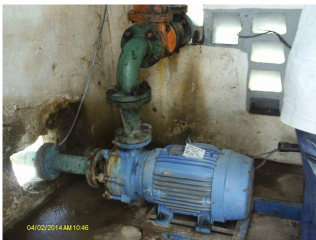
Foto 5 – PA-01: elevatória EEPA-01.
