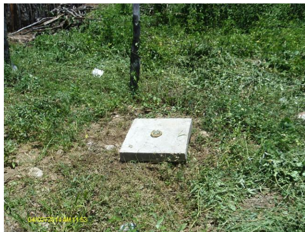
Foto 55 – Registro de descarga na Rua Manuel Alves.
