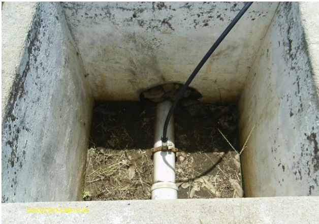
Foto 42 – Caixa de estação pitométrica na área da captação, sem tampa ou grade de proteção.
