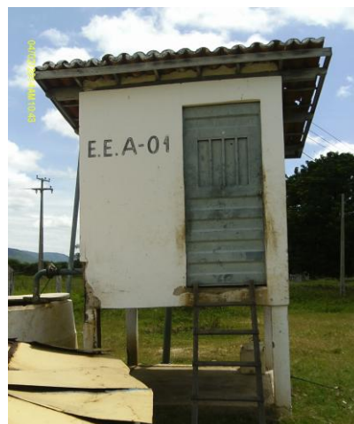
Foto 4 – PA-01: casa de abrigo.
