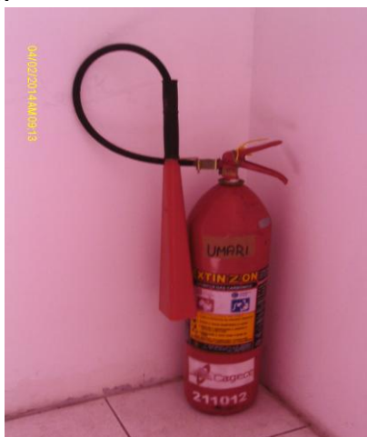
Foto 61 – Extintor de incêndio da casa de química está dentro do prazo, com data de vencimento em set/2014.
