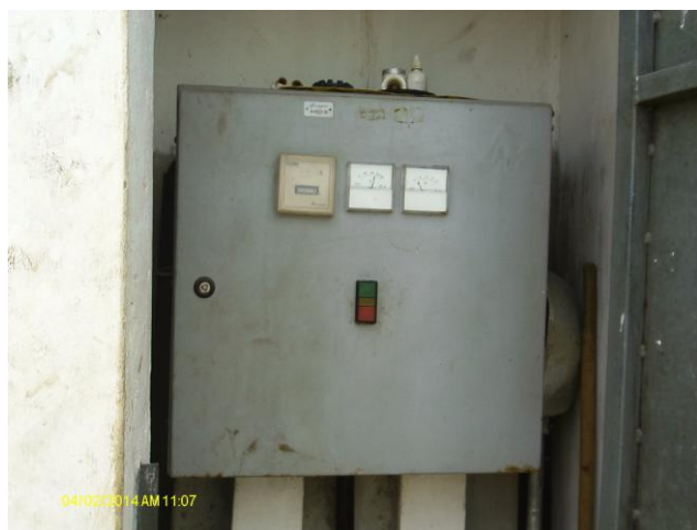
Foto 17 – PT-05: quadro de comando.
