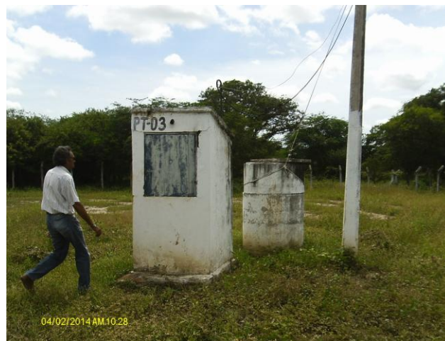
Foto 10 – PT-03: casa de abrigo do quadro de comando.
