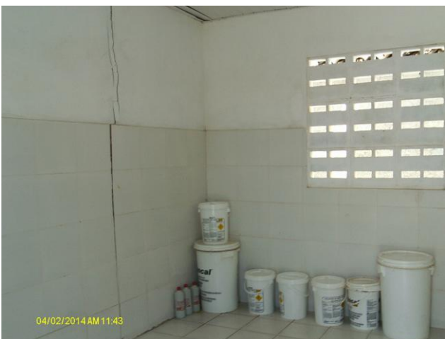
Foto 34 – Armazenamento de produtos químicos.
