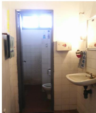
Foto 60 – Instalações sanitárias disponíveis para funcionários e usuários.
