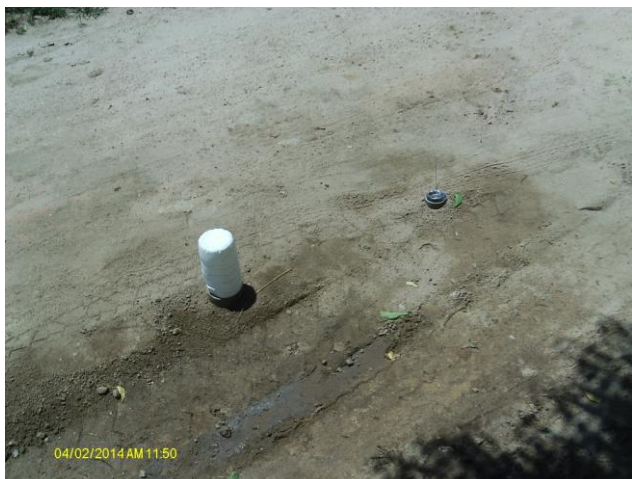
Foto 54 – Registro de descarga na Rua das Flores.
