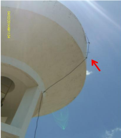
Foto 48 – REL-01: fio de controle encostado do reservatório.
