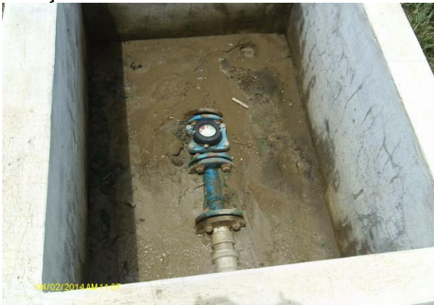
Foto 44 – Macromedidor de água tratada na saída do PT-05, sem tampa ou grade de proteção.
