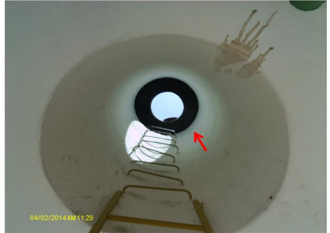
Foto 49 – REL-01: sem tampa de inspeção.
