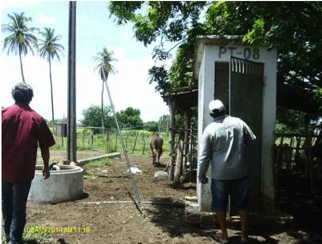
Foto 25 – PT-08: poço e casa de abrigo do quadro de comando.
