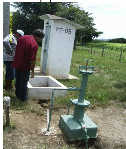
Foto 41 – Clorador de pastilha instalado na saída do poço PT-05.
