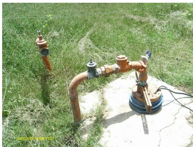
Foto 15 – PT-05: tubulação de recalque.
