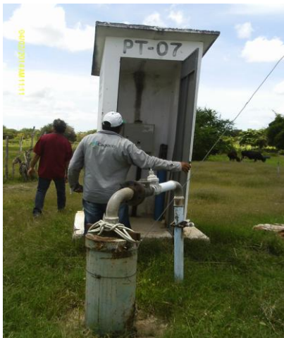
Foto 21 – PT-07: poço e casa de abrigo do quadro de comando.
