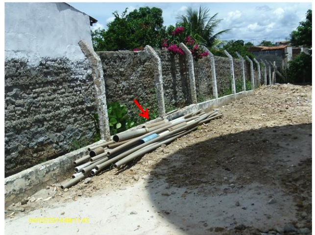
Foto 51 – REL-01: armazenamento inadequado de materiais, e a céu aberto.
