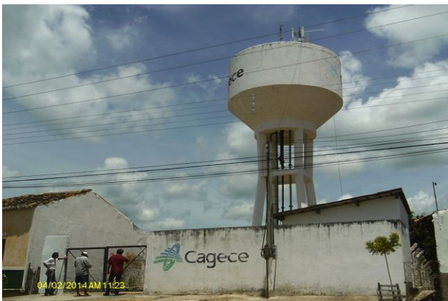
Foto 46 – Vista externa do REL-01.
