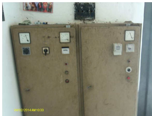
Foto 6 – PA-01: quadro de comando.
