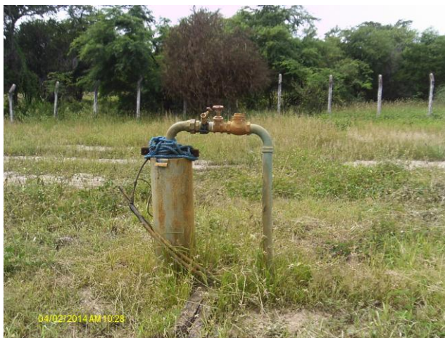
Foto 9 – PT-03: tubulação de recalque.
