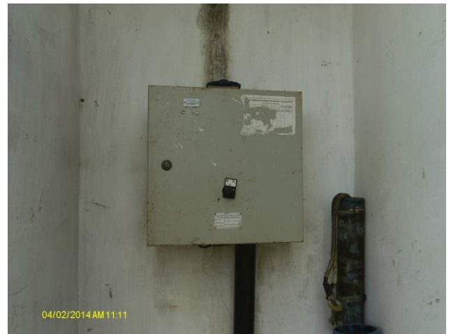
Foto 22 – PT-07: quadro de comando.
