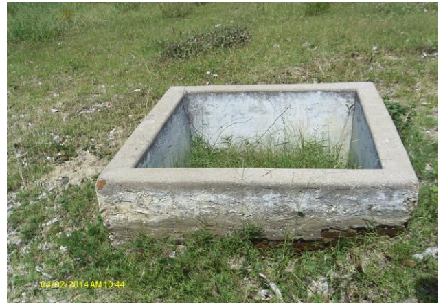
Foto 43 – Caixa de inspeção na área do tratamento, sem tampa ou grade de proteção.
