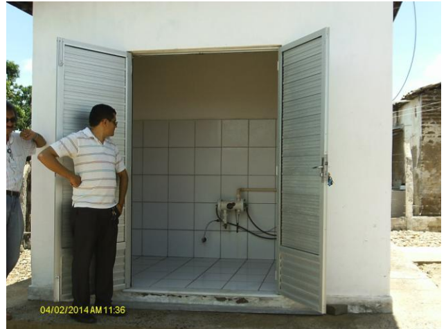
Foto 31 – Vista lateral da fábrica de cloro.
