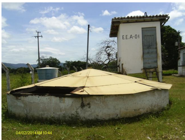
Foto 3 – PA-01: vista geral.
