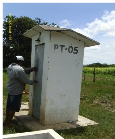
Foto 16 – PT-05: casa de abrigo do quadro de comando.
