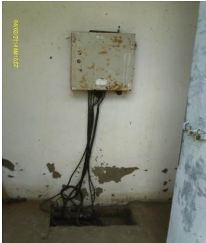
Foto 19 – PT-06: quadro de comando.
