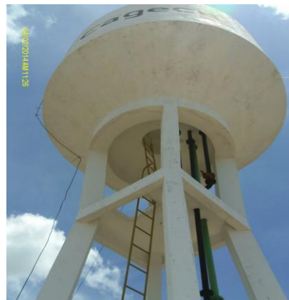
Foto 47 – REL-01: falta guarda-corpo (gaiola de proteção) na escada de acesso.
