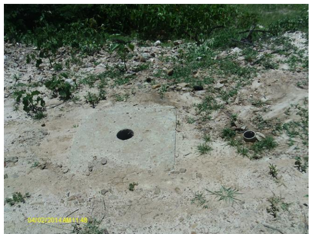
Foto 53 – Registro de descarga na Rua Nova dos Aquinos.
