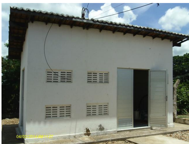
Foto 28 – Vista externa da fábrica de cloro.
