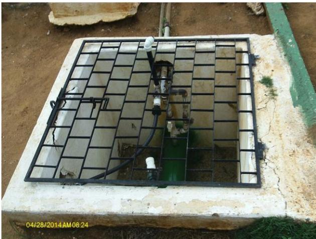
**Foto 33** – Caixa de estação pitométrica na área da ETA, com grade de proteção.
