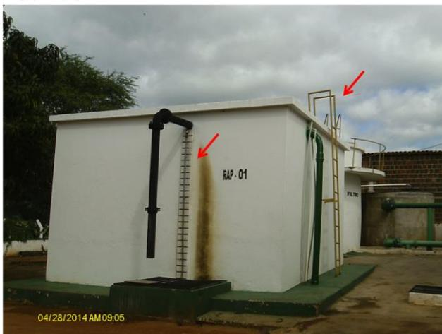
**Foto 47** – RAP-01: com escada de acesso e medidor de nível.
