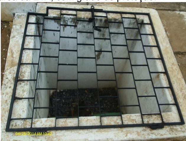
**Foto 35** – Caixa de estação inspeção na área do REL-01, com grade de proteção.
