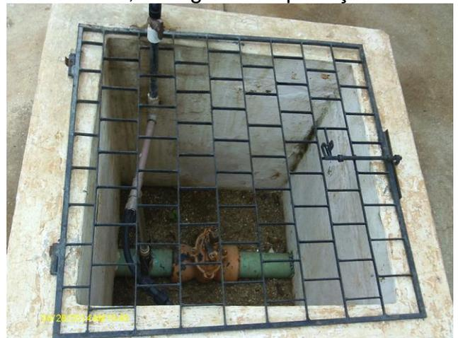
**Foto 34** – Caixa de estação pitométrica na área do REL-01, com grade de proteção.
