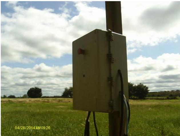
**Foto 15 – Dispositivo de controle dos poços.**
