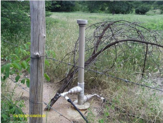
**Foto 25** – Clorador de pastilha na saída do poço PT-06.
