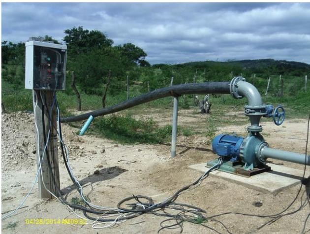
**Foto 39** – Estação elevatória de água bruta dos reservatórios de reunião.
