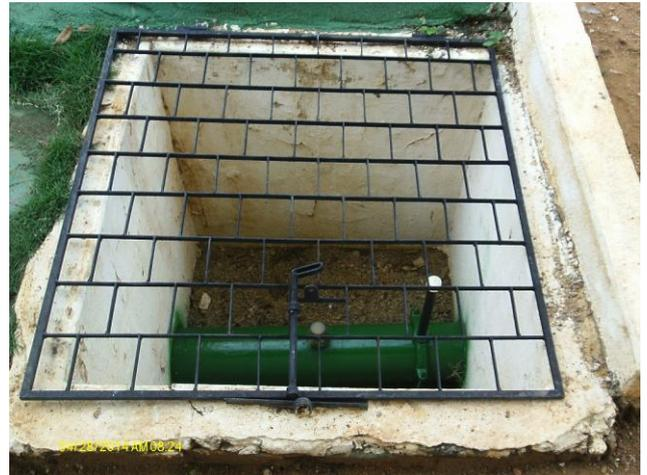
**Foto 32** – Caixa de estação pitométrica na área da ETA, com grade de proteção.
