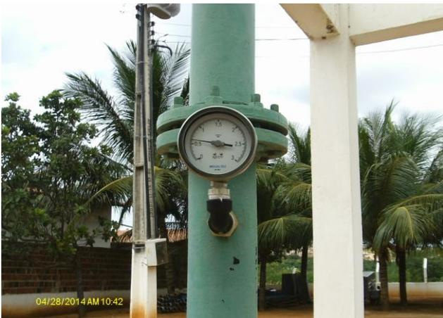
**Foto 51** – REL-01: medidor de nível.
