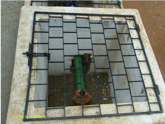
**Foto 37** – Caixa de estação pitométrica na área do REL-01, com grade de proteção.
