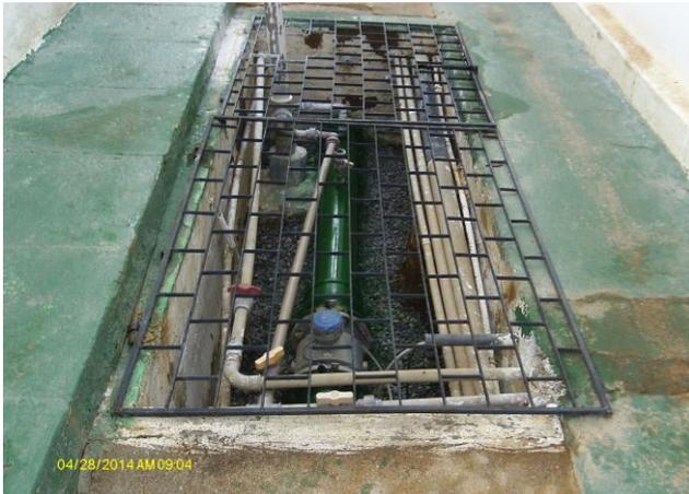
**Foto 31** – Macromedidor de água bruta na chegada da ETA.
