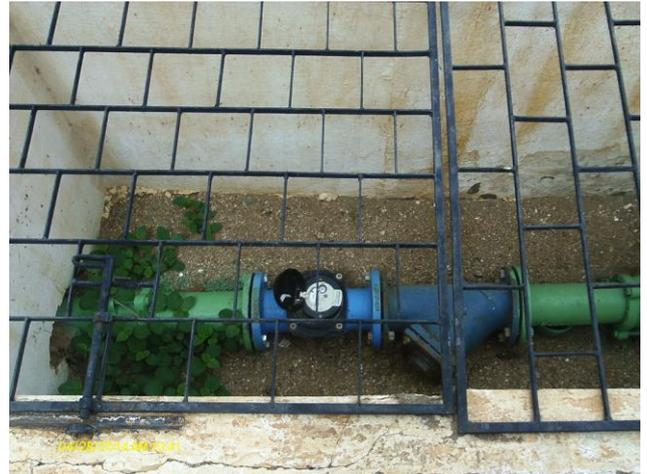
**Foto 38** – Macromedidor de água tratada na saída do REL-01.
