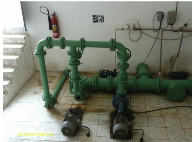
**Foto 40** – Estação elevatória EEAT-01 identificada.
