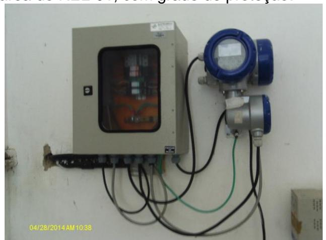
**Foto 36** – Medidor eletromagnético de água tratada instalado no interior da casa de abrigo da EEAT-01.
