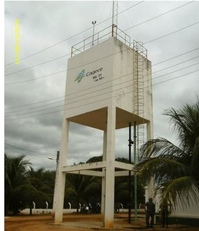
**Foto 50** – REL-01: com identificação, gaiola protetora na escada de acesso e na laje superior.
