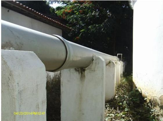
**Foto 13** - ETA: tubulação para sistema de tratamento das águas de lavagem dos filtros.
