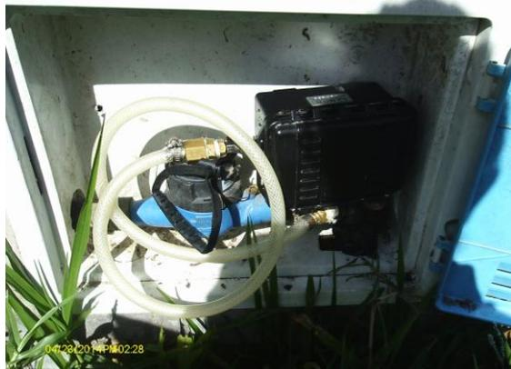
**Foto 44** - Equipamento de medição contínua de pressão (*datalogger*) instalado no endereço: Rua Clóvis de Castro, S/N.
