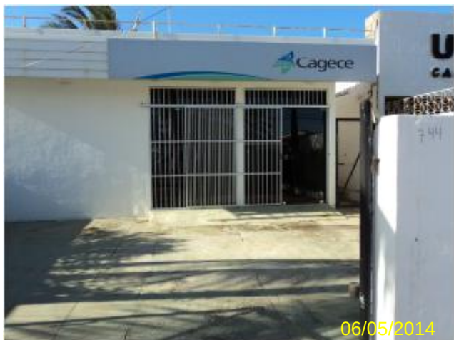
Foto 67 – Loja de atendimento: vista externa.
