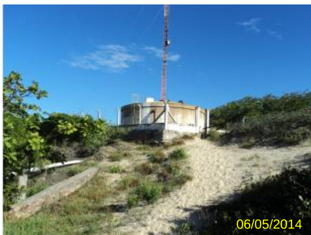
Foto 58 – RAP-02: área de acesso ao reservatório.
