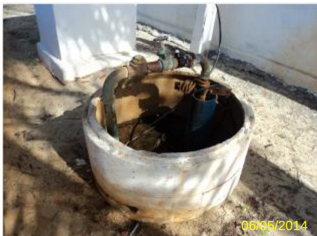
Foto 11 – PT-04: laje de proteção.
