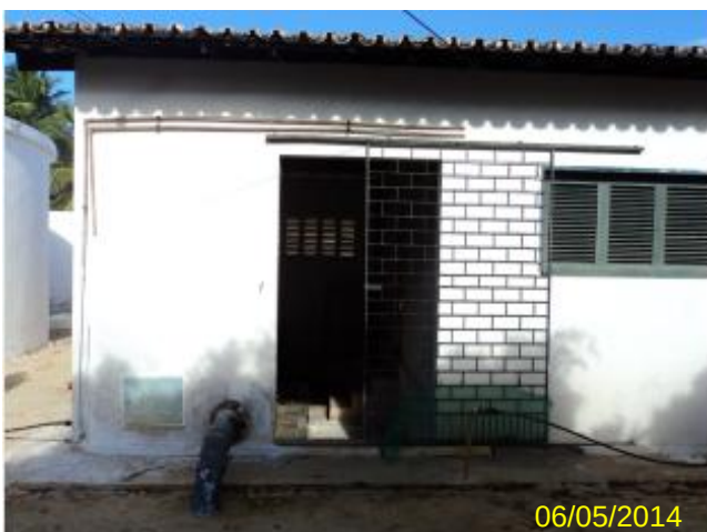
Foto 36 – Casa de química: área de acesso.
