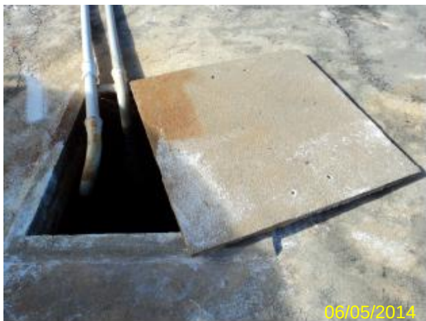
Foto 55 – RAP-01: tampa inspeção – tubulação da entrada de água bruta dos poços PT-03 e PT-04.
