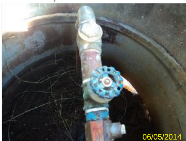
Foto 20 – PT-06: vista interna da proteção do poço.
