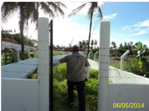
Foto 1 – PT-01: delimitação e ausência de identificação.
