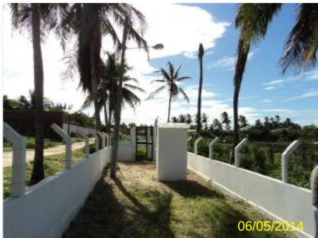
Foto 5 – PT-02: área de acesso, iluminação para trabalhos noturnos e ausência de identificação.
