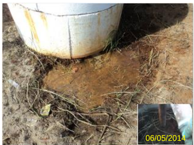
Foto 21 – PT-06: vazamento.
