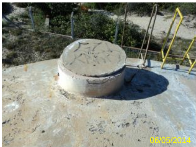
Foto 62 – RAP-02: tampa de inspeção.
