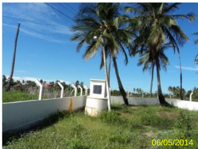
Foto 18 – PT-06: área de acesso e ausência de identificação.
