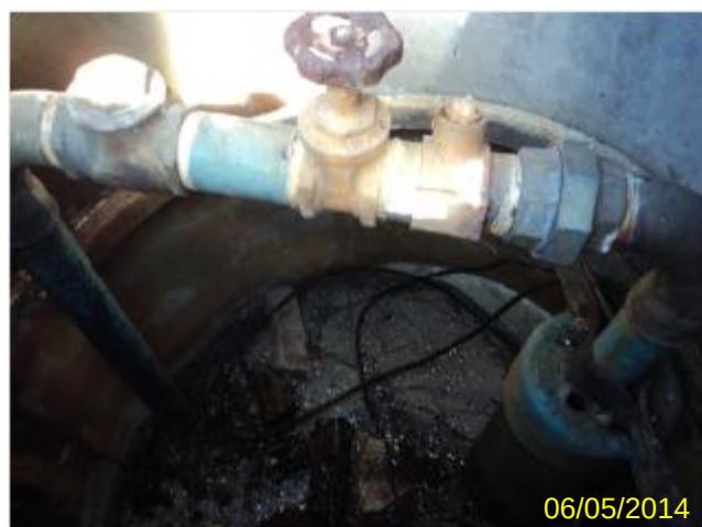
Foto 16 – PT-05: tubulação e registro.
