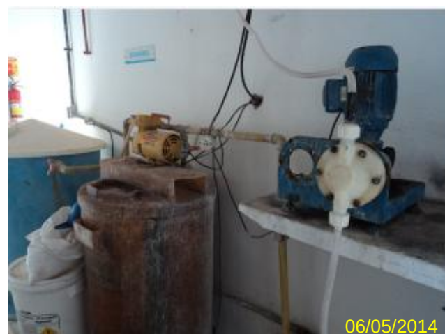
Foto 37 – Casa de química: dosador de polifosfato parado.
