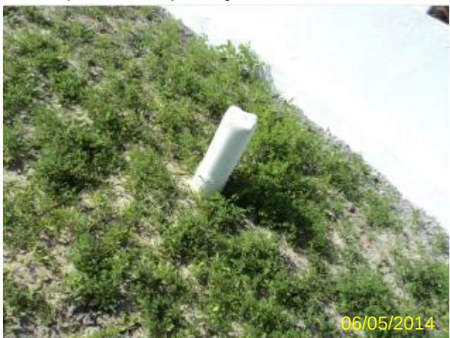
Foto 25 – Poço desativado 3: condições adequadas de proteção.
