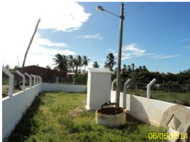
Foto 2 – PT-01: vista geral – iluminação para trabalhos noturnos.
