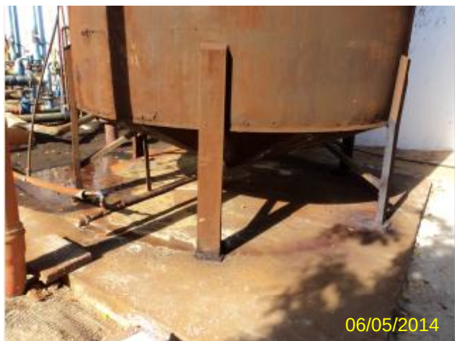
Foto 28 – Aerador e torre de nível: processo de corrosão e ausência de escada de acesso.
