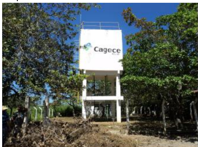
Foto 20 – REL-03: área de acesso, identificação e guarda-corpo na laje de cobertura.
