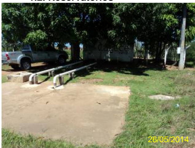
Foto 6 – REN-01: vista geral – ausência de identificação e delimitação da área.
