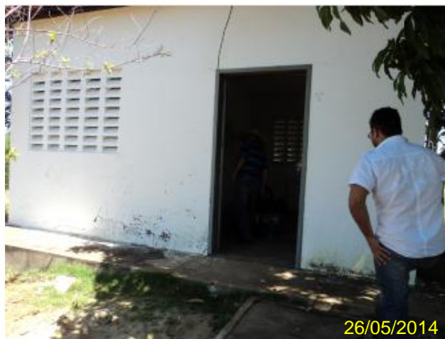
Foto 2 – EEAT-02: casa da elevatória.
