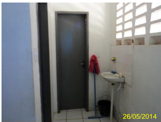
Foto 46 – Loja de atendimento: instalações sanitárias.
