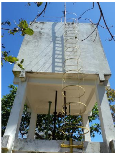
Foto 22 – REL-03: escada de acesso com guarda corpo.
