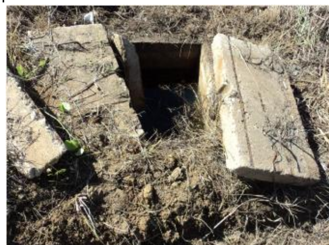
Foto 38 – RDA: registro de descarga a Av. Porfírio de Araújo.
