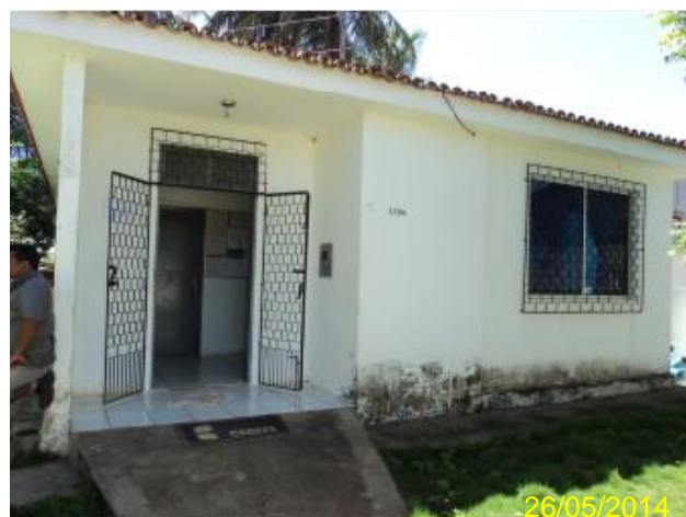
Foto 43 – Loja de atendimento: vista externa.
