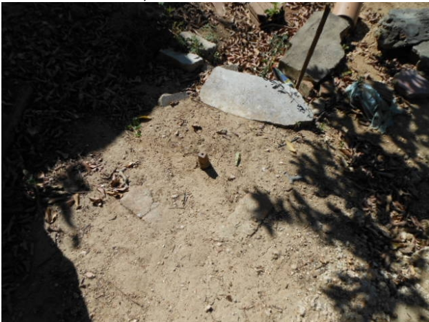
Foto 43 - Registro de descarga localizado na Travessa Sinval Leitão, 206, sem caixa de proteção.
