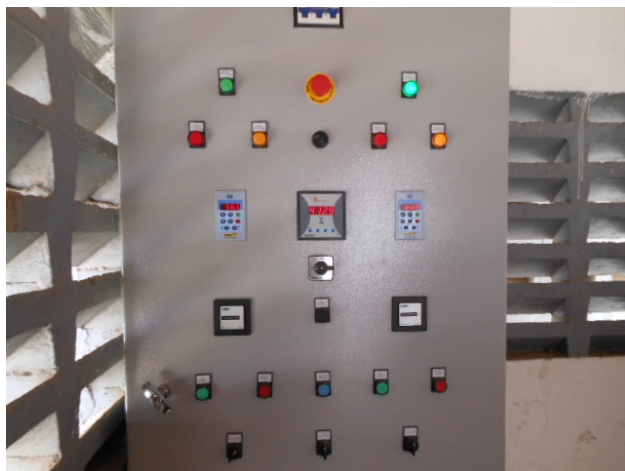
Foto 24 - Elevatória: quadro de comando da EEAT-01.
