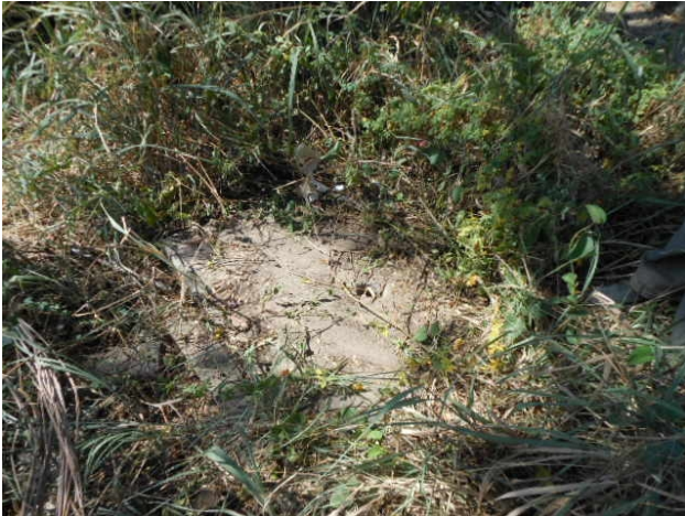
Foto 39 - Registro de descarga localizado na Rodovia CE-060, 566.
