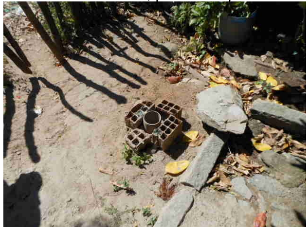
Foto 44 - Registro de descarga localizado na Rua Maria de Jesus, 52, sem caixa de proteção.
