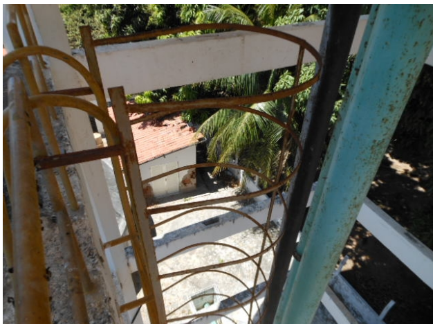
Foto 33 - REL-01: escada de acesso comprometida pela ferrugem.
