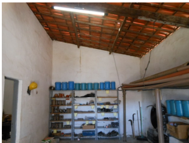
Foto 58 - Vista interna do almoxarifado com iluminação.
