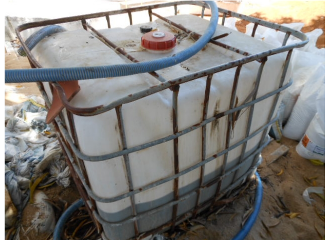
Foto 20 - ETA: tanque de armazenamento do PAC.
