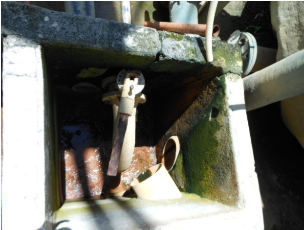
Foto 7 - Filtração: ausência de vedação dos registros de descarga dos filtros.
