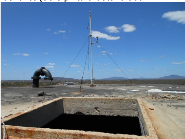
Foto 31 - REL-01: ausência de tampa de inspeção e de sinalização noturna.
