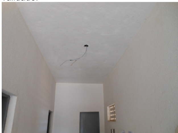
Foto 49 - Escritório/loja de atendimento: fiação exposta e ausência de luminária no corredor.
