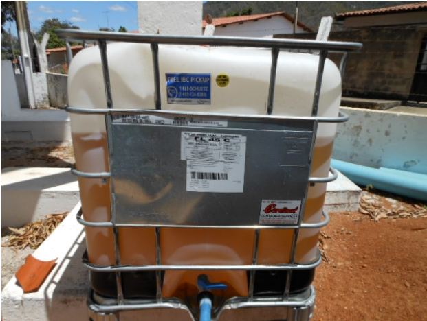
Foto 19 - ETA: tanque de armazenamento de polímero.
