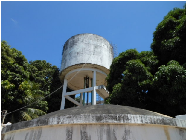
Foto 29 - REL-01 e RAP-01: ausência de identificação e pintura deteriorada.
