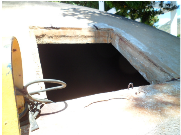
Foto 28 - RAP-01: ausência de tampa de inspeção.
