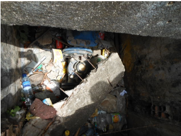
Foto 21 - Adução: macromedidor na entrada da ETA.
