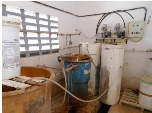
Foto 10 - Casa de Química: tanque dosador de polímero e flúor.
