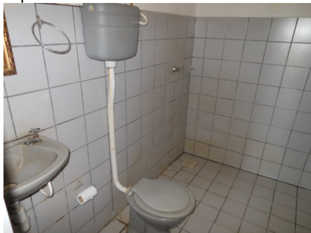
Foto 48 - Instalações sanitárias disponíveis para funcionários e usuários.
