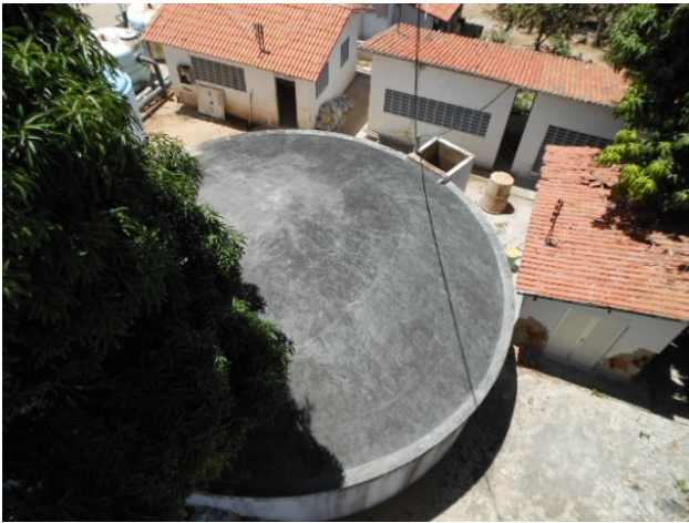
Foto 27 - RAP-01: ausência de tubulação de ventilação e de tampa de inspeção no extravasor.
