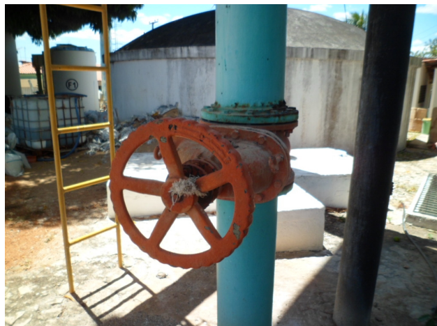
Foto 34 - REL-01: ausência de dispositivo medidor de nível.
