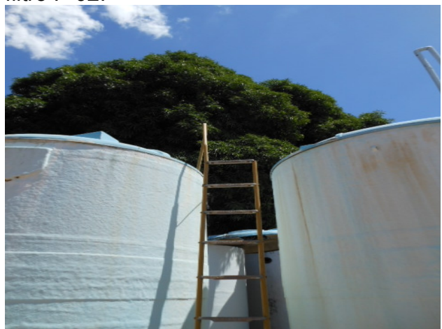
Foto 6 - Filtração: escada de acesso aos F-03 e F-04 comprometida por corrosão.
