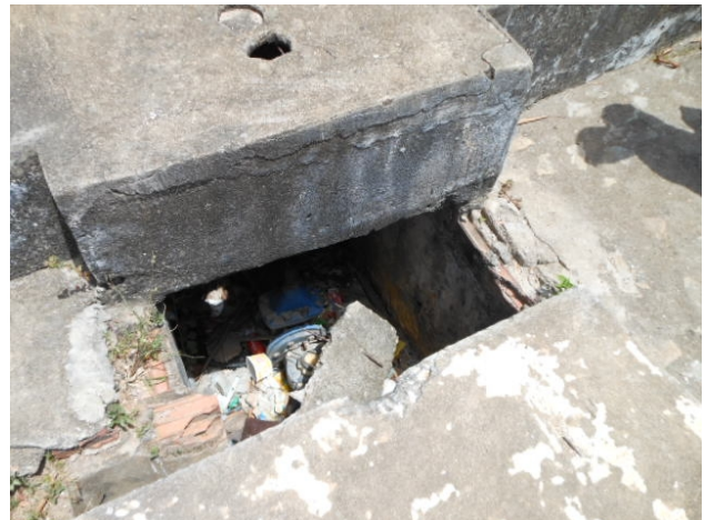
Foto 22 - Adução: caixa de registro com tampa quebrada.
