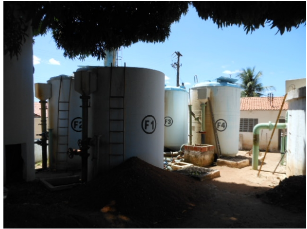
Foto 2 - Filtração: filtros F-01, F-02, F-03 e F-04 identificados.
