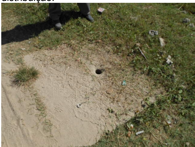
Foto 37 - Registro de descarga localizado na Rua Maria do Carmo, 362.
