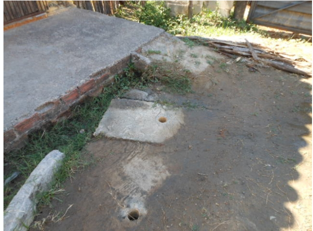
Foto 40 - Registro de descarga localizado na Rua 4 (Quatro), 25.
