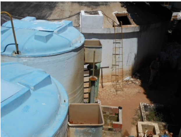
Foto 3 - Filtração: calha de saída da água do F-01, F-02, F-03 e F-04 sem tampa.
