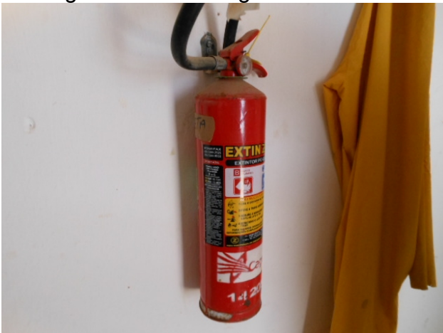
Foto 9 - Casa de Química: extintor de incêndio dentro do prazo de validade.
