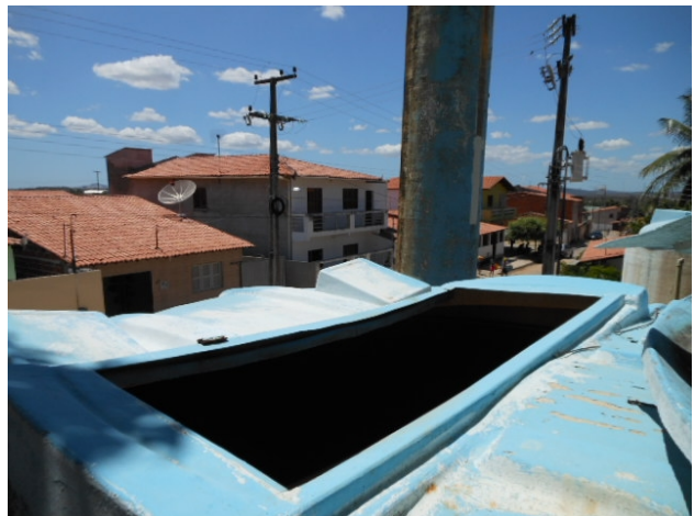
Foto 4 - Filtração: ausência de tampa do filtro F-02.
