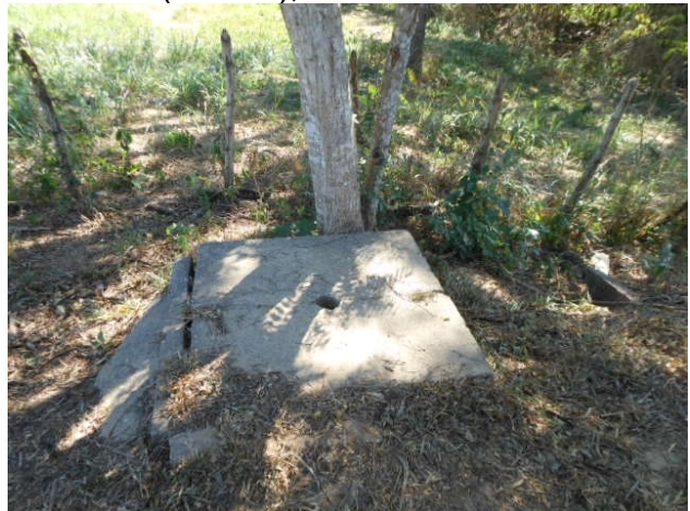
Foto 42 - Registro de descarga localizado na Rua Sinval Leitão, próximo a ponte.
