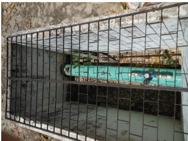
Foto 35 - RDA: macromedidor na rede de distribuição.
