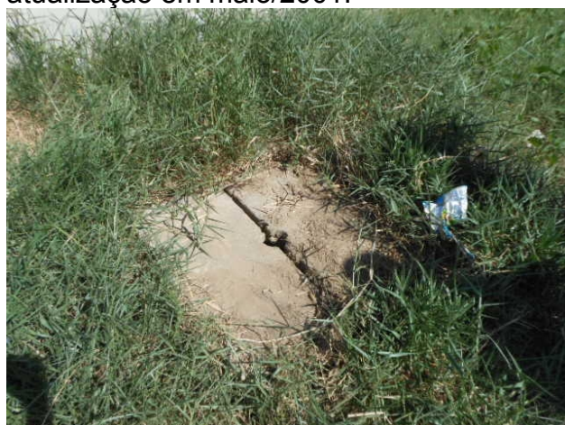
Foto 38 - Registro de descarga localizado na Rodovia CE-060, próximo a delegacia.
