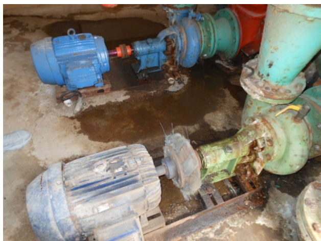
Foto 25 - Elevatória: conjunto motor-bomba e reserva da EEAT-01.
