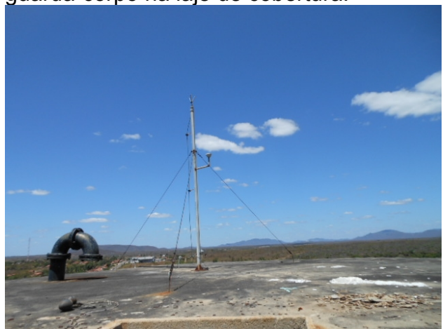
Foto 32 - REL-01: tubulação de ventilação com tela de proteção e pára-raios.
