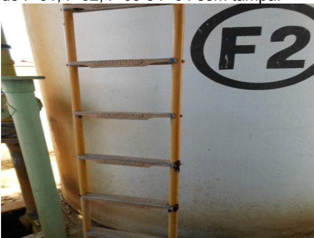
Foto 5 - Filtração: escada de acesso do F-02 apresenta corrosão.
