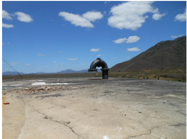
Foto 30 - REL-01: ausência de guarda-corpo na laje de cobertura.
