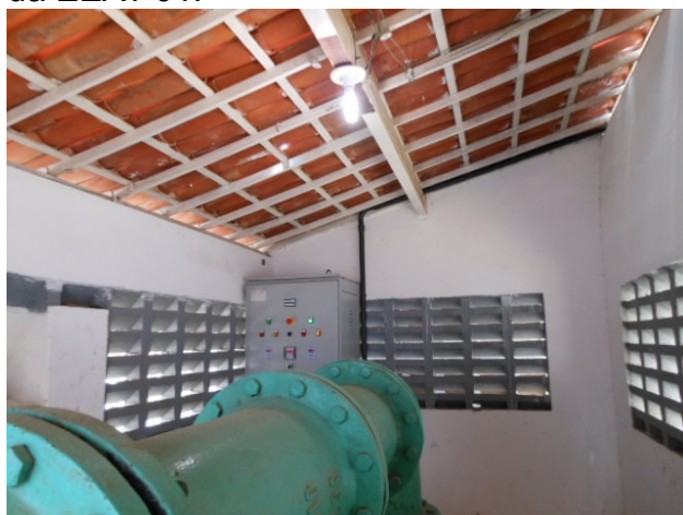
Foto 26 - Elevatória: iluminação no prédio de abrigo da EEAT-01.
