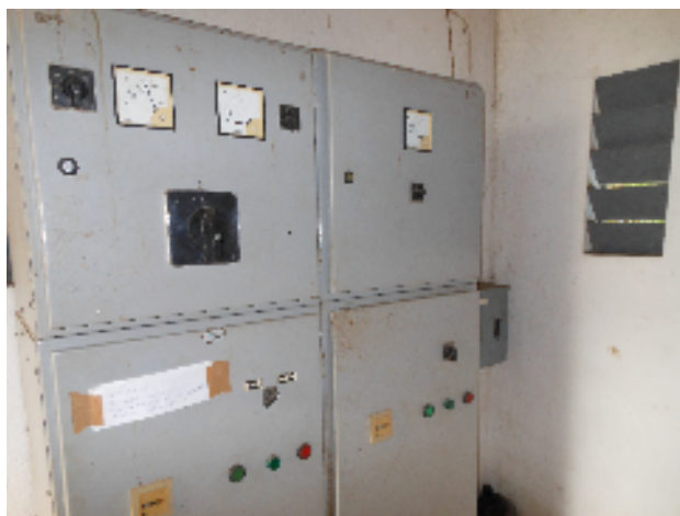
Foto 29 - Elevatória: Quadro de comando da EEAT-02.
