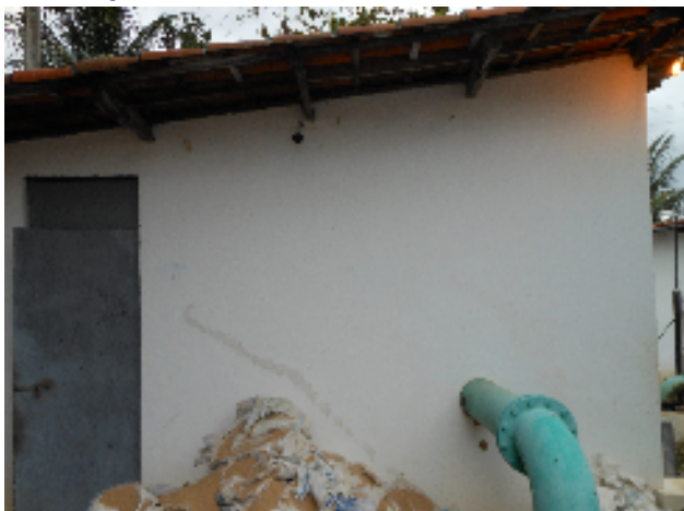
Foto 24 - Elevatória: Ausência de identificação na EELF-01.
