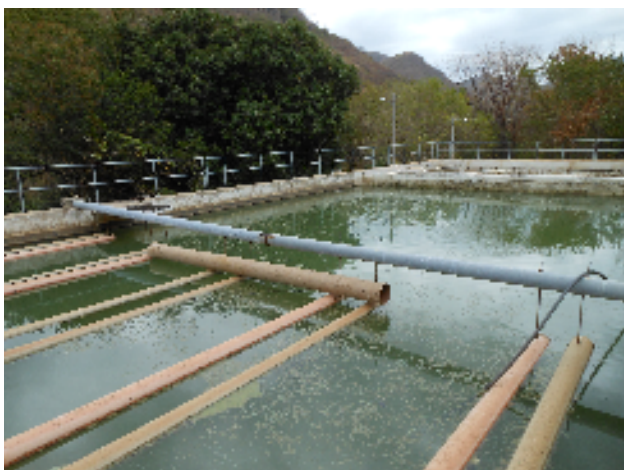
Foto 6 - Vista do Decantador.
