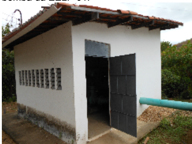
Foto 27 - Elevatória: Ausência de identificação na EEAT-02.
