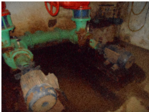
Foto 25 - Elevatória: Conjunto Motor-bomba da EELF-01.
