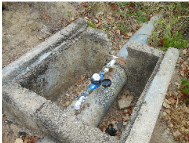
Foto 31 - Adução: Ausência de tampa ou grade no macromedidor.
