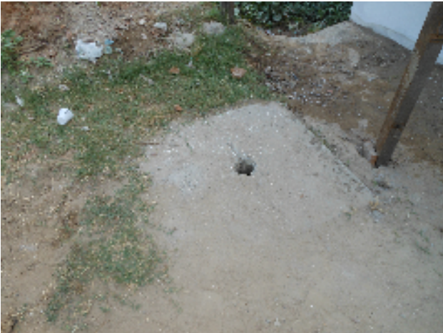
Foto 40 - Rede de distribuição: Registro de descarga localizado na Rua Senhor do Bonfim.
