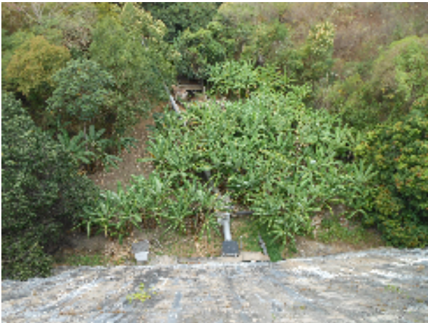
Foto 3 - Vista da adutora da COGERH na saída do Açude.
