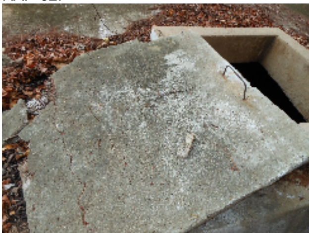
Foto 34 - Reservatório: Tapa de inspeção do RAP-02 danificada.
