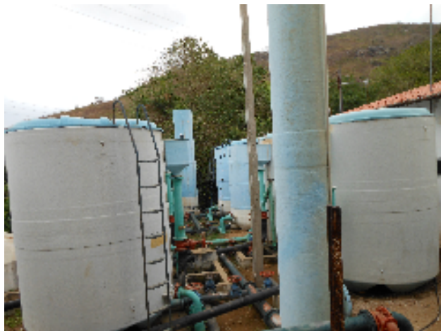
Foto 11 - Filtração: Vista parcial dos filtros e torre de nível.
