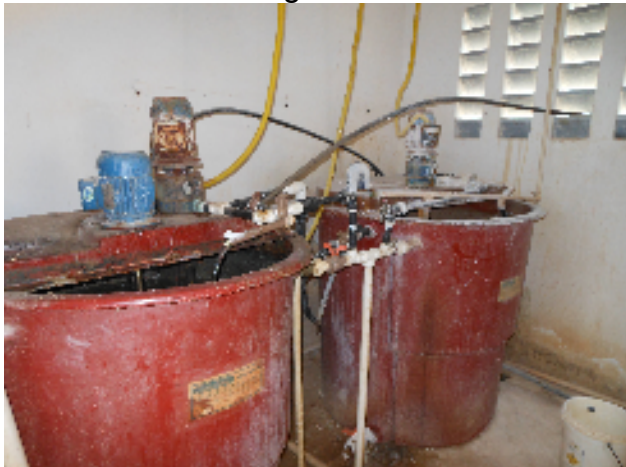
Foto 12 - Casa de Química: Tanque dosador de produtos químicos.
