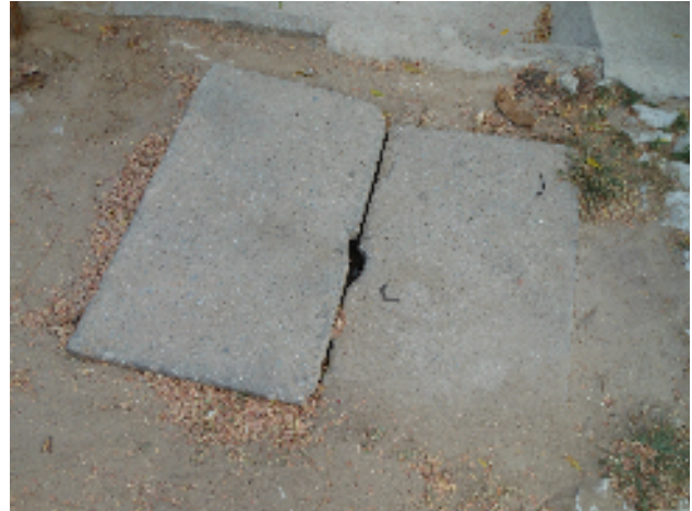
Foto 47 - Rede de distribuição: Registro de descarga localizado na Rua José Eduardo Franco.
