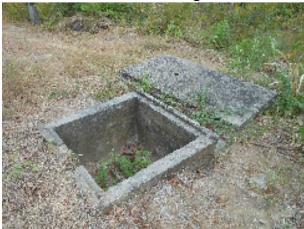
Foto 30 - Adução: Ausência de tampa na caixa de registro.
