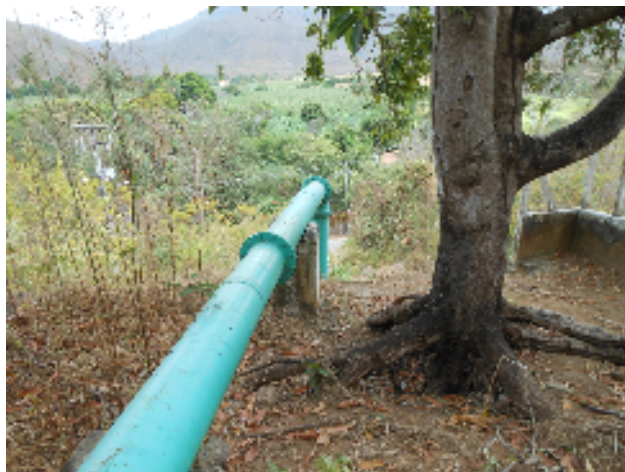
Foto 33 - Reservatório: Ausência de cerca no RAP-02.
