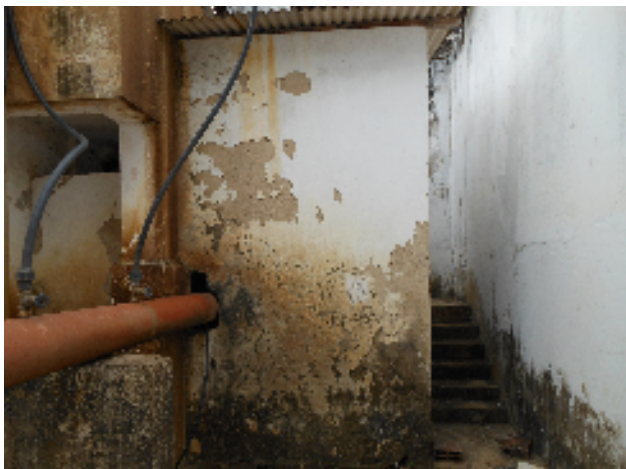
Foto 22 - Elevatória: Ausência de identificação e pintura deteriorada na EEAT-01.
