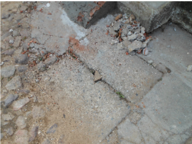
Foto 42 - Rede de distribuição: Registro de descarga localizado na Rua Antônio de Lima.
