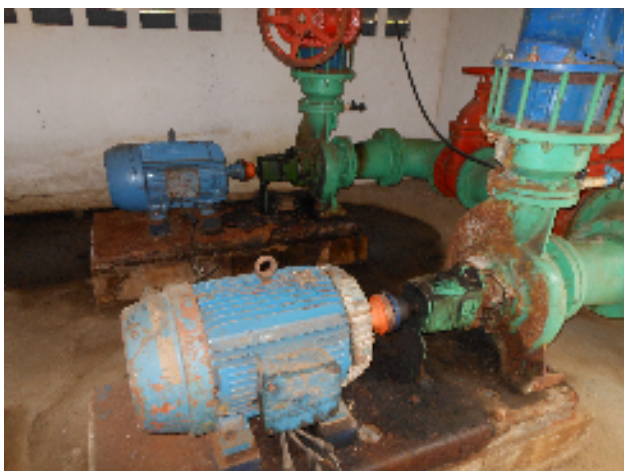
Foto 28 - Elevatória: Bomba reserva da EEAT-02 em manutenção.
