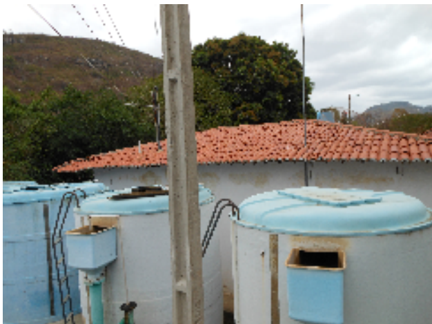
Foto 10 - Filtração: Ausência de tampa na calha de saída da água em todo os filtros.
