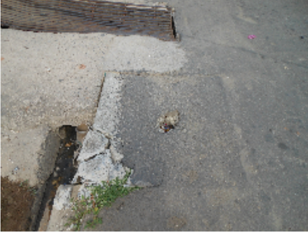
Foto 44 - Rede de distribuição: Registro de descarga localizado na Rua Santos Dumont.
