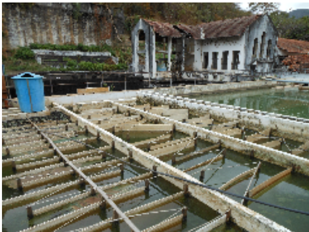
Foto 4 - Floculador com chicanas.
