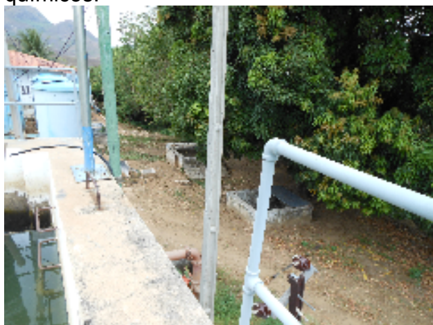
Foto 7 - Decantador: Ausência de guarda-corpo.
