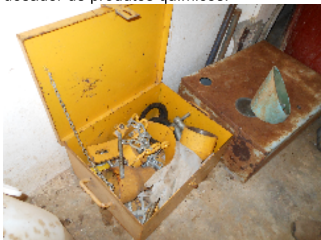
Foto 15 - Depósito: Kit de emergência do cloro gasoso.
