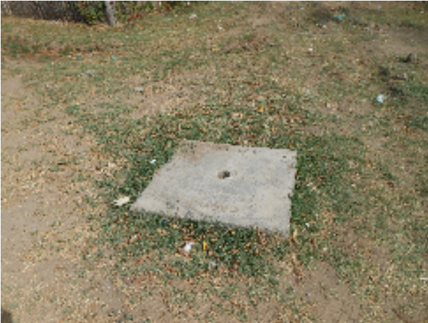
Foto 46 - Rede de distribuição: Registro de descarga localizado na Rua Vicente do Vale Meira.
