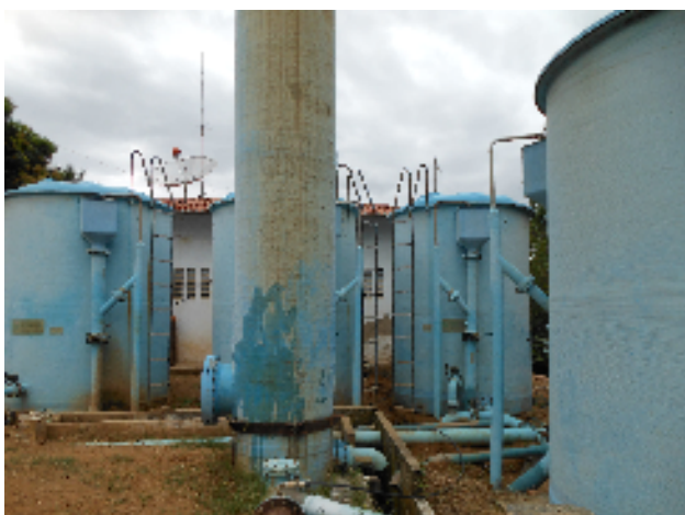
Foto 8 - Filtração: Vista parcial dos filtros F-09, F-10, F-12 e torre de nível.
