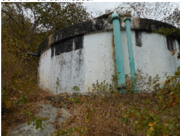
Foto 36 - Reservatório: Pintura deteriorada e ausência de tubulação de ventilação.
