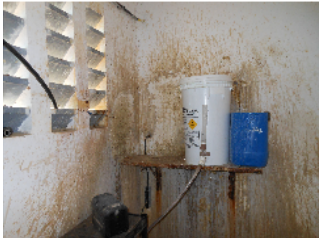
Foto 13 - Casa de Química: Tanque dosador de produtos químicos.
