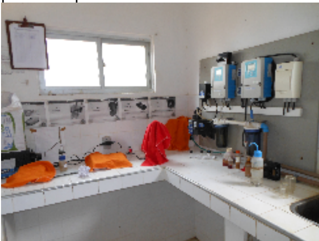
Foto 18 - Vista parcial do Laboratório.
