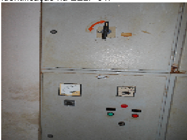
Foto 26 - Elevatória: Quadro de comando da EELF-01.
