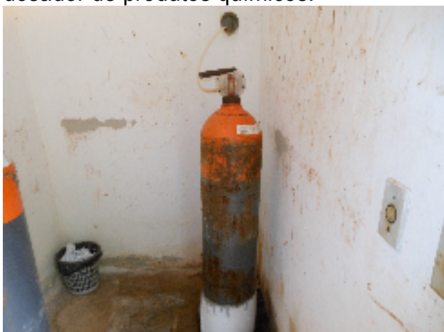
Foto 14 - Casa de Química: Local de acondicionamento do cloro gasoso.
