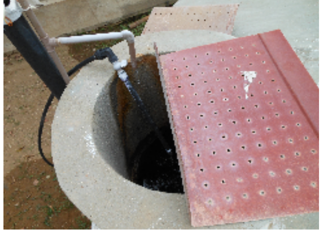
Foto 39 - Reservatório: Tampa de inspeção inadequada.
