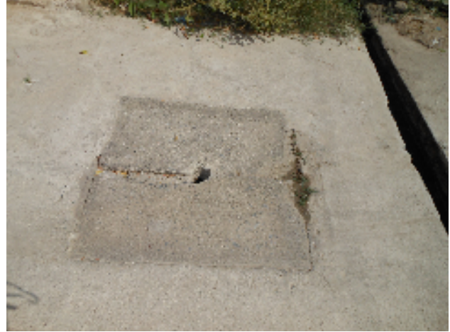
Foto 45 - Rede de distribuição: Registro de descarga localizado na Rua Oiteiro 1.
