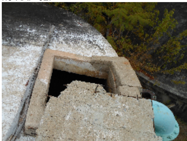
Foto 35 - Reservatório: Tapa de inspeção danificada no RAP-02.
