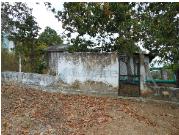
Foto 32 - Ausência de identificação no RAP-02.
