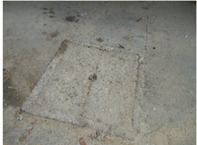
Foto 41 - Rede de distribuição: Registro de descarga localizado na Rua Lurdugero Guilherme.
