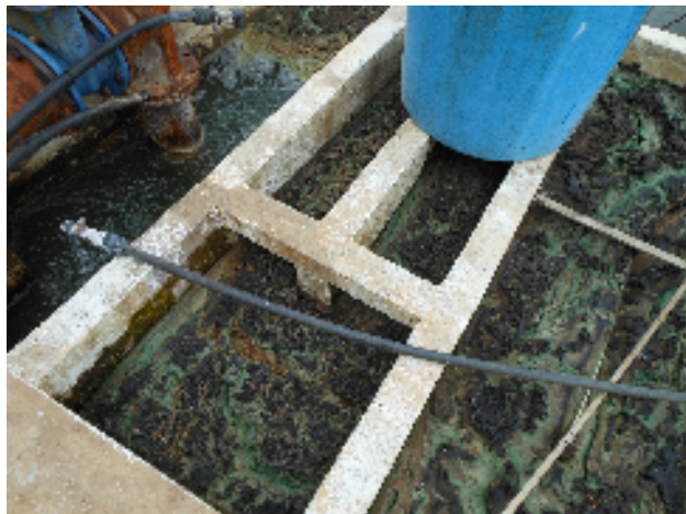
Foto 5 - Floculador: Aplicação de produtos químicos.
