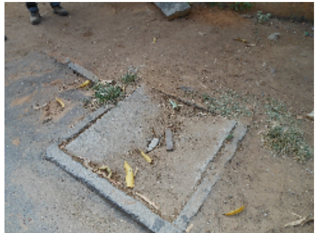
Foto 43 - Rede de distribuição: Registro de descarga localizado na Rua Edilson Madeiros.
