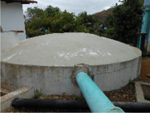
Foto 38 - Reservatório: Ausência de identificação no RSE-01.
