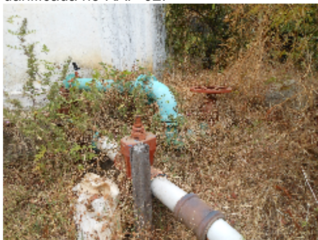
Foto 37 - Reservatório: Ausência de medidor de nível.
