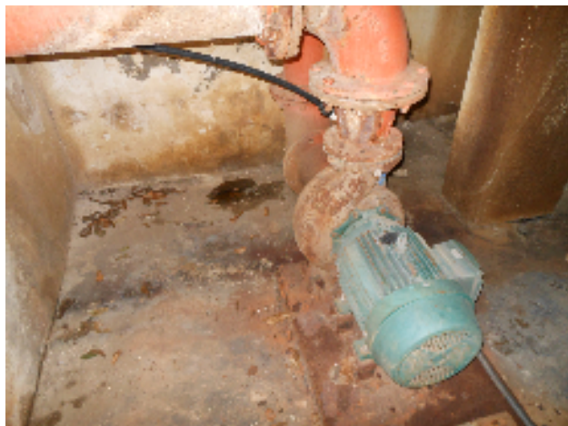
Foto 23 - Elevatória: Ausência de bomba reserva na EEAT-01.
