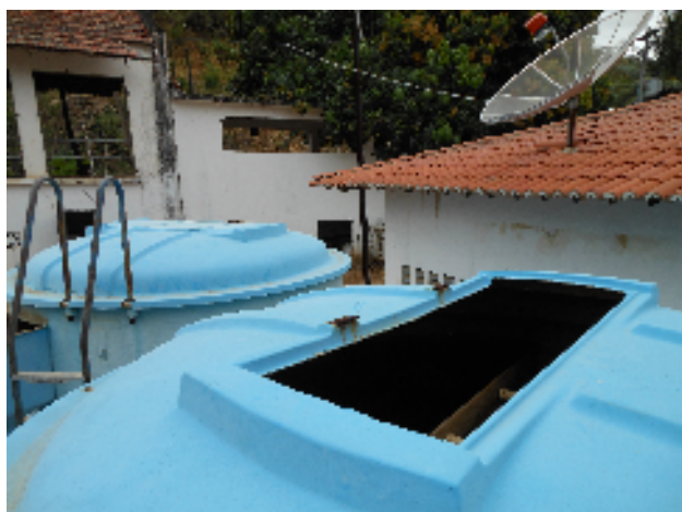
Foto 9 - Filtração: Ausência de tampa no F-10.
