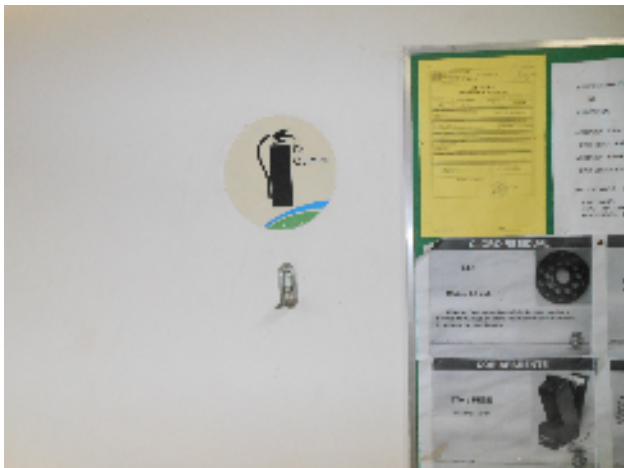
Foto 52 - Ausência de extintor de incêndio.
