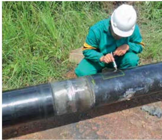
Figura 5 - Inspeção visual após soldagem
