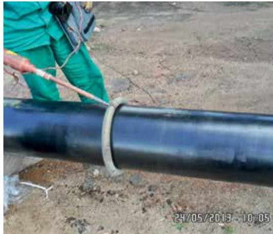
Figura 7 - Inspeção do revestimento externo com o aparelho "holiday detector"
