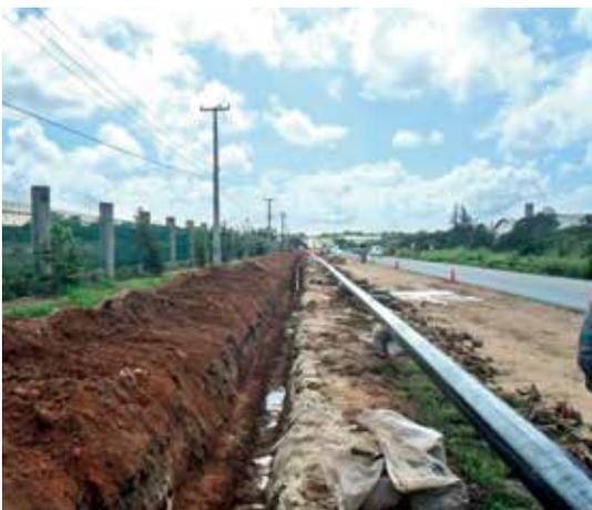
Figura 8 - Dutos soldados aguardando posicionamento na vala
