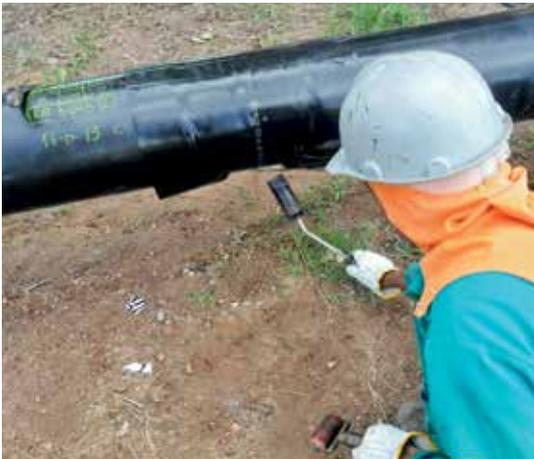
Figura 6 - Fixação do revestimento externo para proteção da junta soldada
