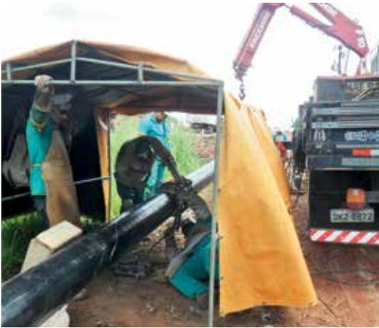
Figura 4 - Execução de soldagem
