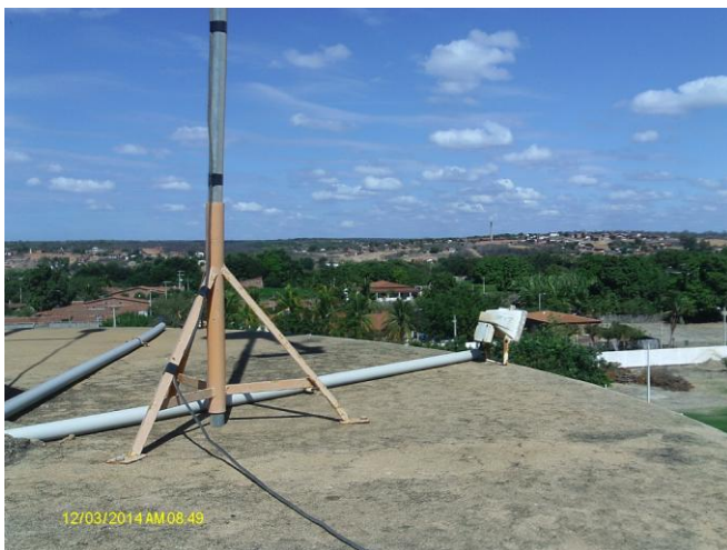
Foto 6 - Laje de cobertura do REL-01 sem guarda-corpos.
