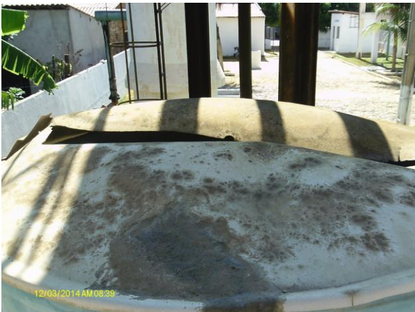
Foto 16 - RAP-01: cobertura danificada.
