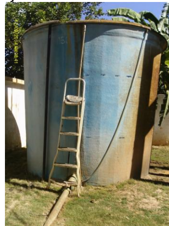
Foto 17 - RAP-01: sem identificação e pintura deteriorada.
