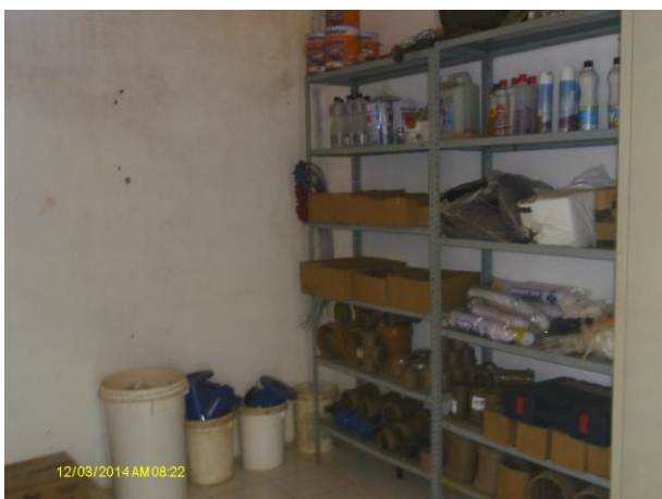
Foto 10 - Almojarifado: ausência de extintor de incêndio.
