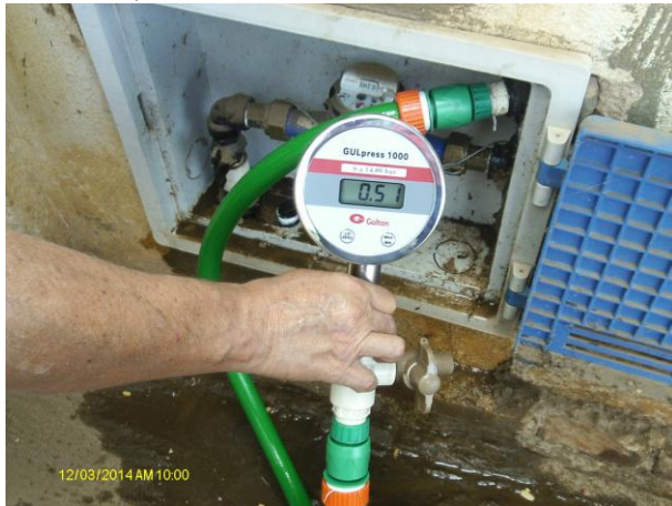
Foto 3 - Medição instantânea de pressão na rede de distribuição: Rua Raimundo Alves Maia, 2841.
