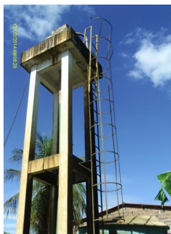
Foto 11 - Aerador: pintura deteriorada, ausência de identificação, escada danificada, enferrujada e sem fixação.
