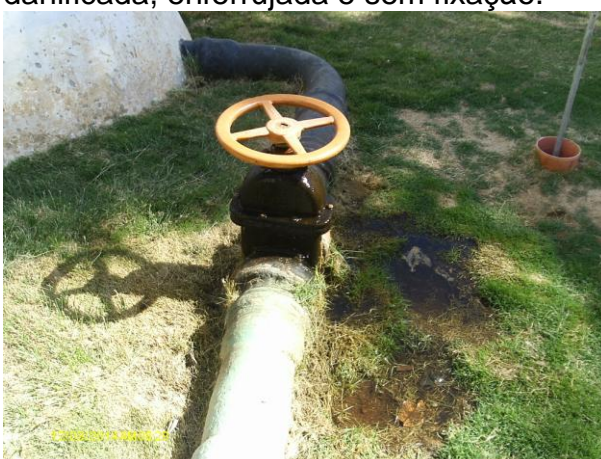
Foto 13 - Vazamento no registro do filtro F-01.
