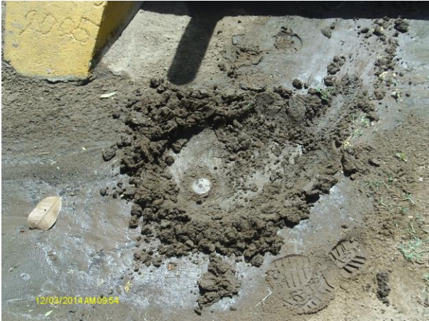
Foto 14 - Registro de descarga soterrado - Rua Raimundo Alves Maia.
