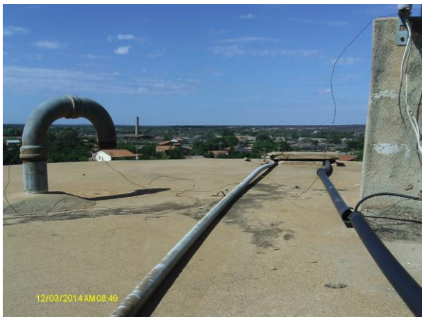
Foto 20 - REL-01: tubulação de ventilação sem tela de proteção.
