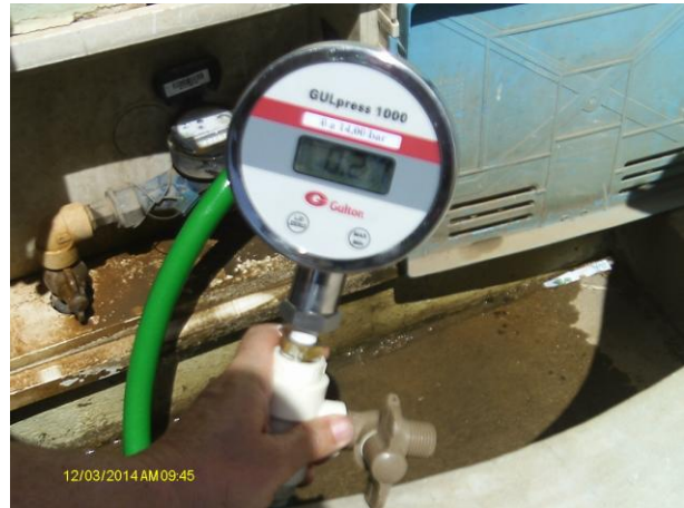
Foto 2 - Medição instantânea de pressão na rede de distribuição: Rua José Alves, 2160.
