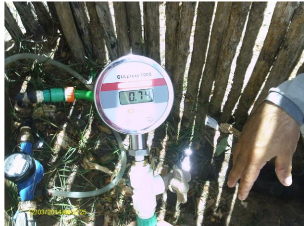
Foto 4 - Medição instantânea de pressão na rede de distribuição: Rua Antônio Sabino, 985.
