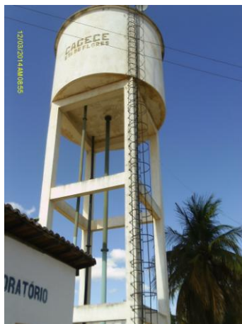
Foto 18 - REL-01: pintura deteriorada.
