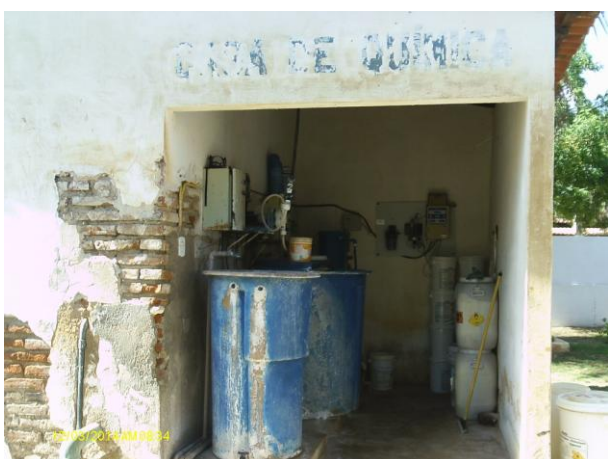
Foto 12 - Casa de química: identificação apagada, pintura e reboco deteriorados.
