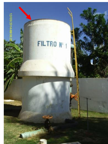
Foto 7 – Filtro F-01 sem tampa.
