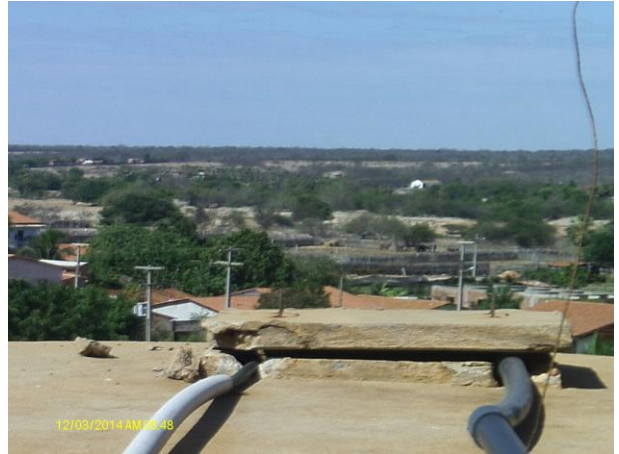
Foto 15 - REL-01: tampa de inspeção sem vedação.
