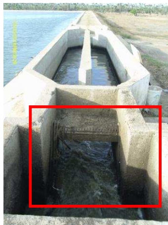
Foto 23 - ETE Russas: gradeamento com defeito.
