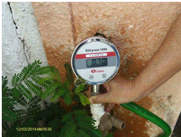
Foto 2 - Medição instantânea de pressão na rede de distribuição: Av. Gonçalves, 367.
