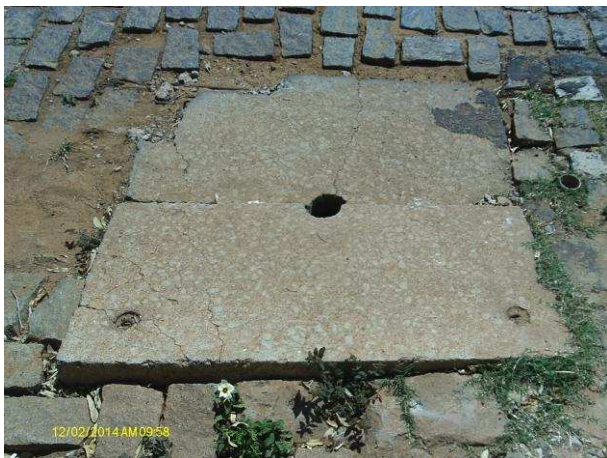
Foto 24 - Registro de descarga com tampa danificada: Rua Araibu, 1390.
