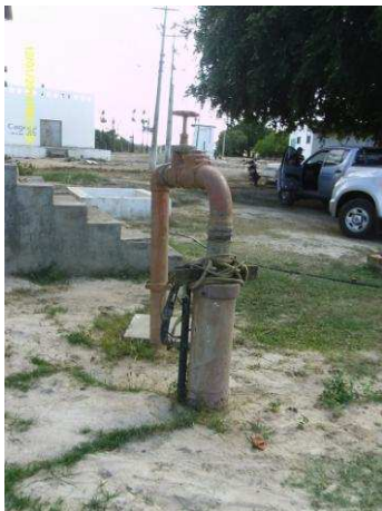
Foto 12 - PT-19: sem identificação.
