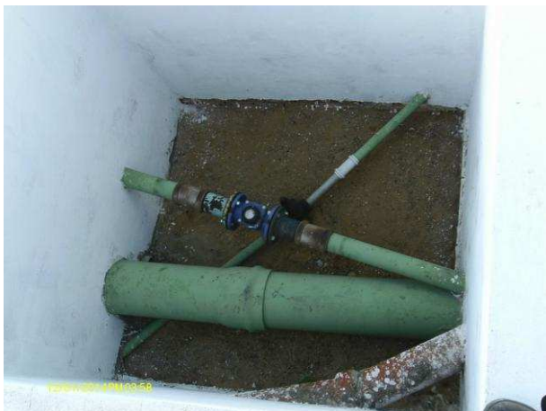
Foto 16 - Caixa do macromedidor de saída sem tampa ou grade de proteção.
