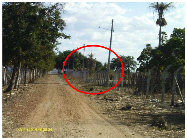
Foto 13 - Captação superficial: cerca danificada.
