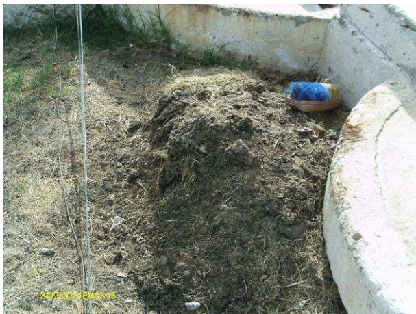
Foto 22 - Areia e materiais removidos do cesto de retenção da EEE-01.
