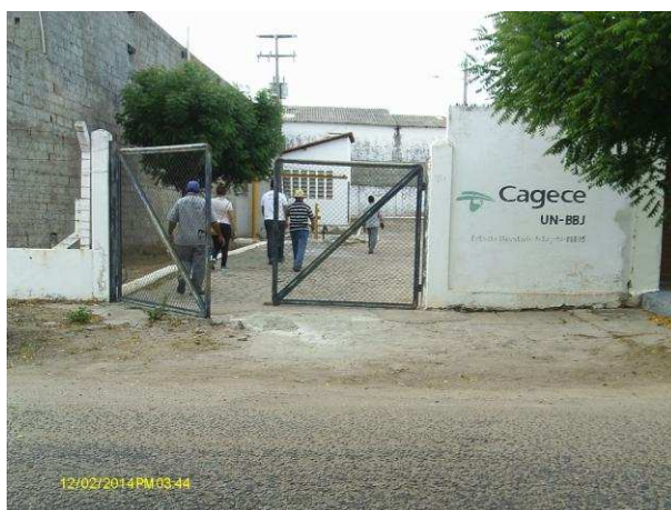
Foto 21 - EEE-05: identificação apagada.
