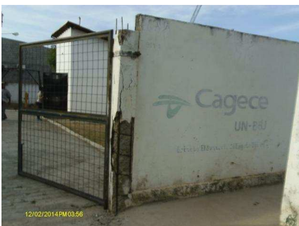
Foto 20 - EEE-04: muro deteriorado e identificação apagada.
