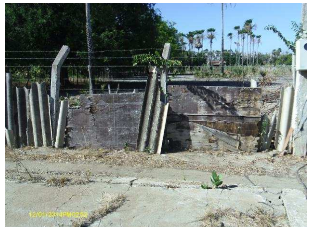
Foto 9 - Captação subterrânea: cerca danificada.
