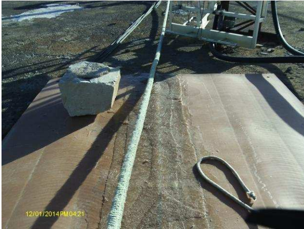
Foto 28 - REL-01: tampa de inspeção sem vedação.
