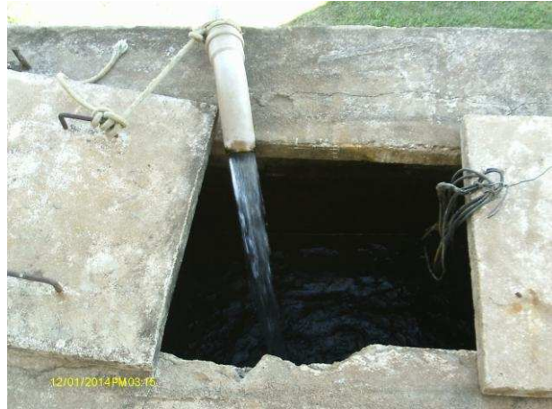
Foto 29 - RAP-01: tampa de inspeção sem vedação.
