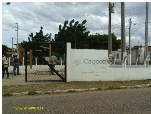
Foto 17 - EEE-01: identificação apagada.
