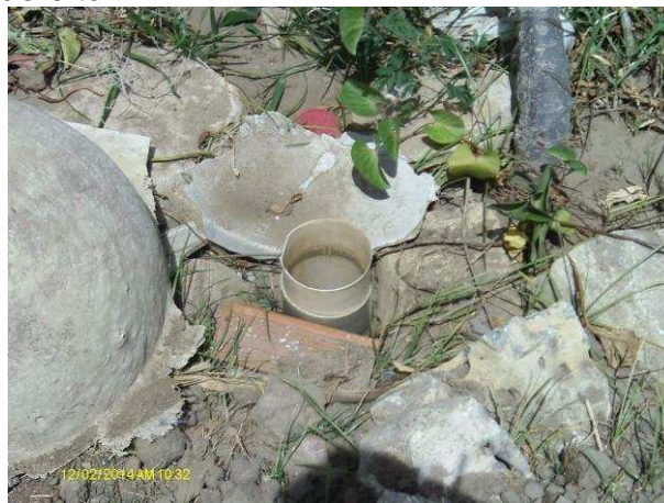
Foto 25 - Registro de descarga soterrado: Rua Eliseu Ferreira Lima, 431.
