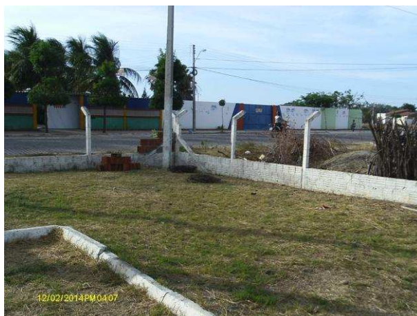
Foto 32 - EEE-06: cerca danificada.
