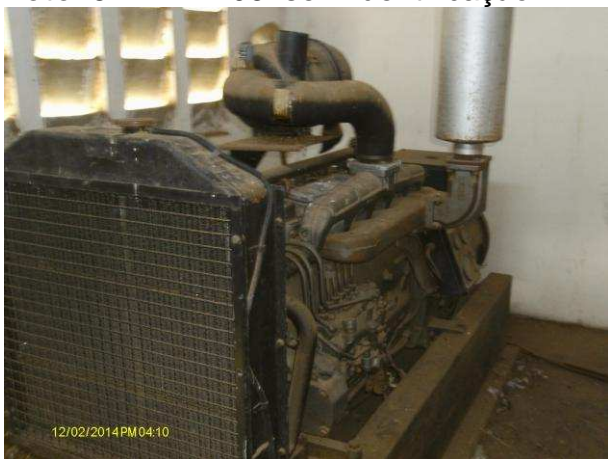
Foto 33 - EEE-06: grupo gerador de energia elétrica com defeito.
