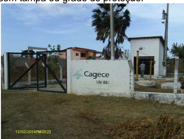
Foto 18 - EEE-02: identificação apagada.
