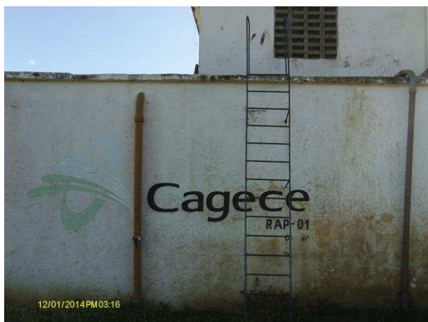
Foto 26 - RAP-01: pintura deteriorada.
