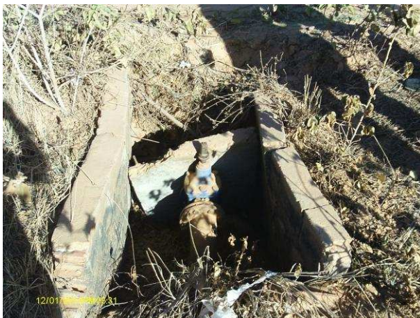
Foto 8 - AAB-01: caixa do registro de descarga danificada.
