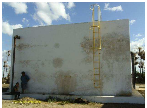
Foto 15 - Decantador: sem identificação e apresentando sinais de vazamento.
