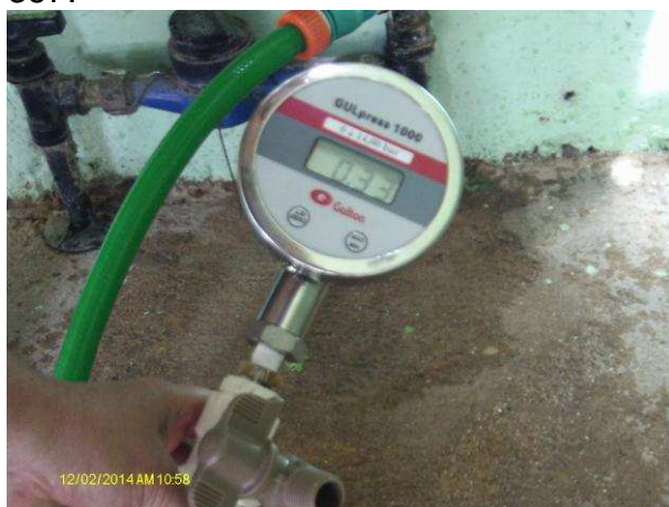
Foto 4 - Medição instantânea de pressão na rede de distribuição: Rua Nicanor Baltazar, 28 - Multirão.
