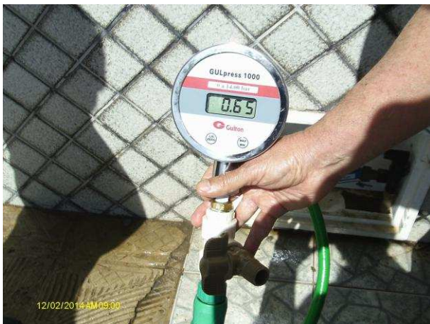
Foto 1 – Medição instantânea de pressão na rede de distribuição: Rua Ocion Lopes, 546 – Várzea Alegre
