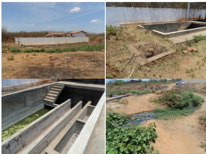
Figura 2 - Instalações inacabadas e em completo abandono do SES da Sede de Mucambo.
