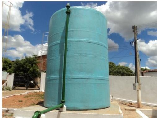
Figura 2 - Decantador instalado na ETA.
