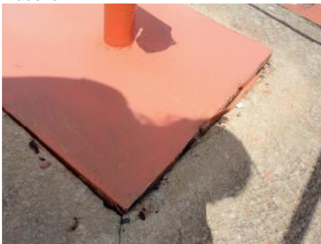
Foto 12 - REL-01: tampa de inspeção em condições inadequadas de vedação.
