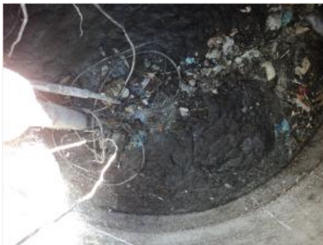
Foto 4 - EEE-01-Poço de Sucção com acúmulo de sobrenadantes.
