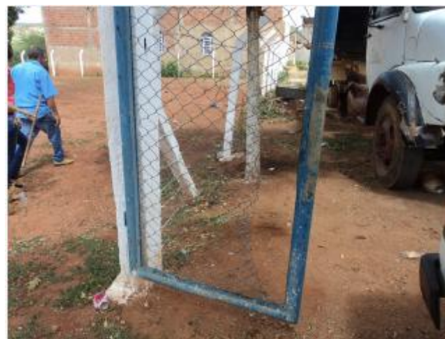
Foto 13 - REL-01: portão de acesso danificado.
