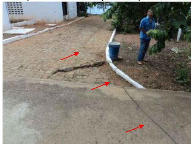
Foto 11 - ETA: fiação exposta na área da ETA.
