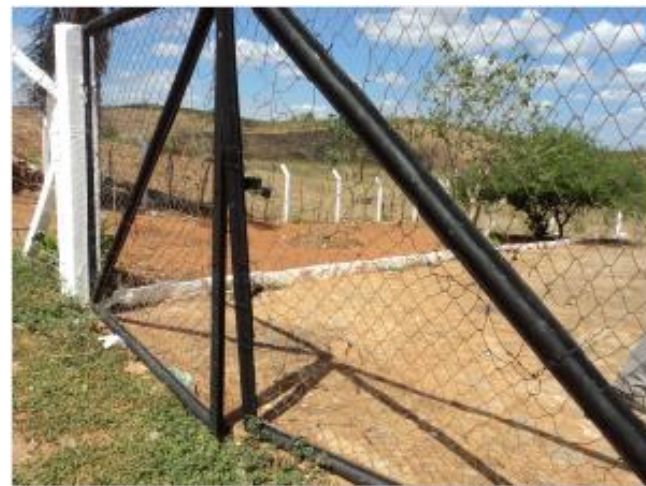
Foto 5 - EEE-01: portão deteriorado.
