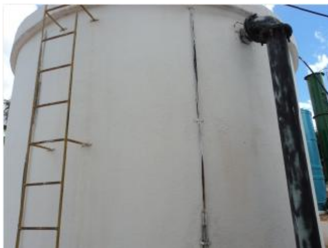
Foto 15 - RAP-01: O medidor de nível não permite a visualização do nível de água.
