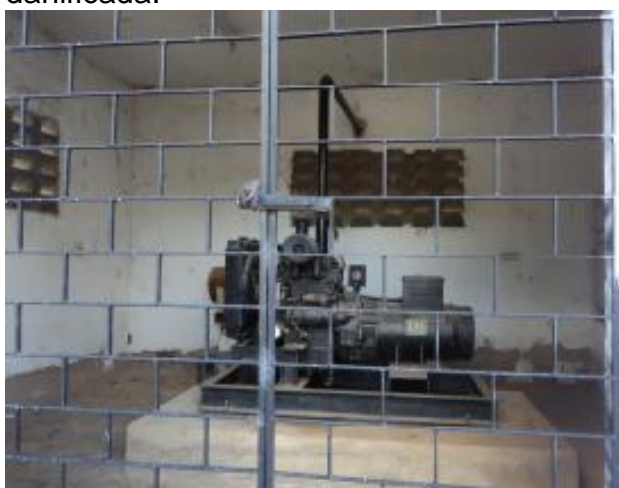
Foto 19 - ETE: grupo gerador de energia elétrica antigo.
