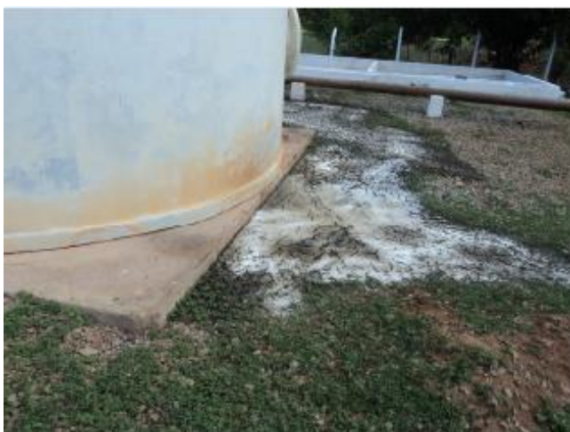
Foto 8 - ETE: extravasamento na área do Reator e do Filtro.
