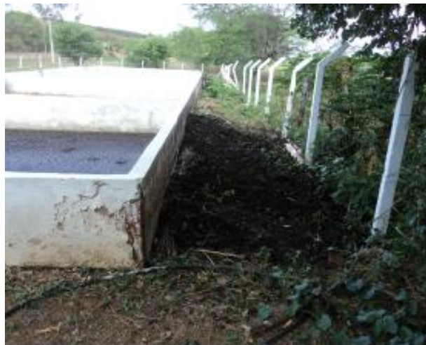
Foto 22 - Material proveniente do leito de secagem disposto na área da ETE.
