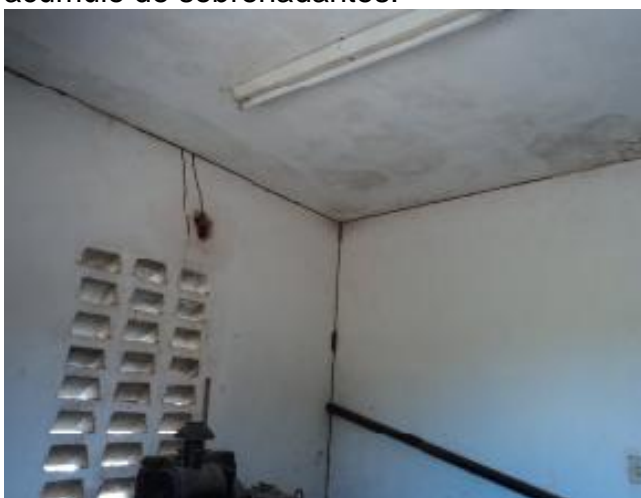
Foto 6 - EEE-01: casa de abrigo do grupo gerador de energia elétrica com cupins.
