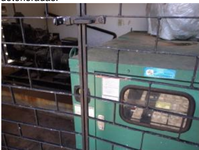
Foto 18 - EEE-01: grupo gerador de energia elétrica antigo e o novo para substituição.
