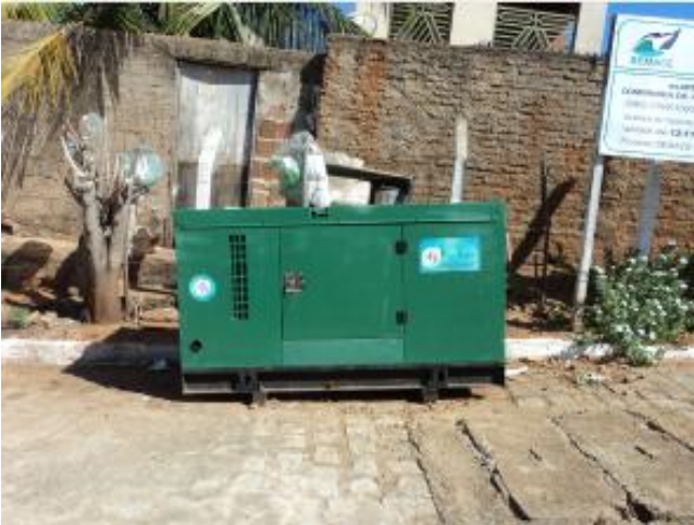
Foto 20 – ETE: grupo gerador de energia elétrica novo para substituição localizado na área da ETA.
