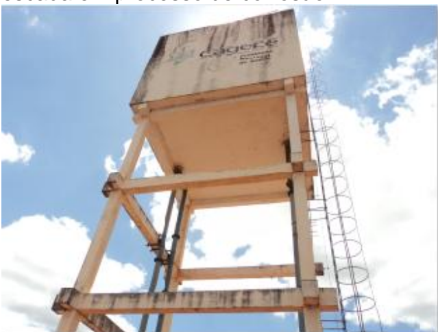
Foto 16 - REL-01: pintura e identificação deterioradas.
