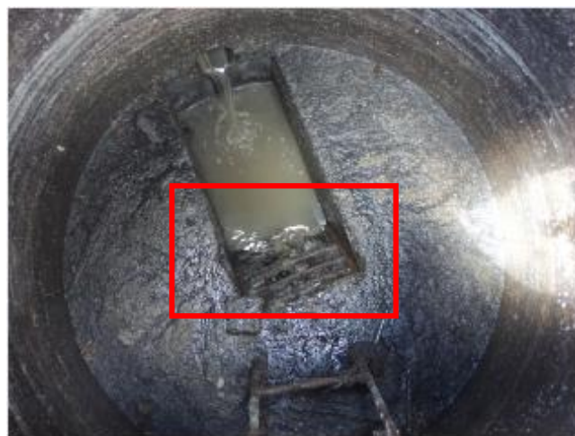
Foto 9 - ETE: gradeamento em más condições de conservação e limpeza.
