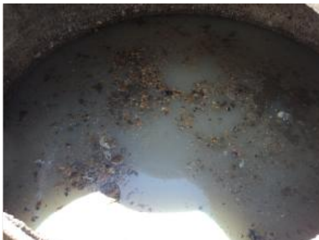
Foto 3 - EEE-01: gradeamento submerso.
