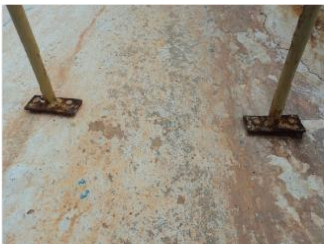
Foto 14 - RAP-01: base de fixação da escada em processo de corrosão.
