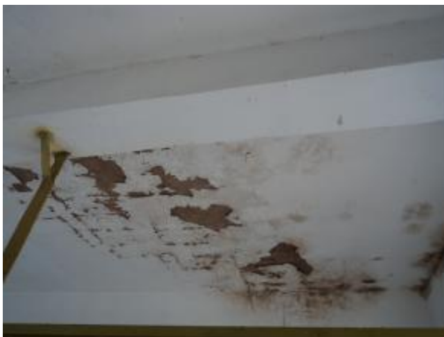
Foto 2 - EEAT-02: casa de abrigo do quadro de comando com reboco e pintura deteriorados.
