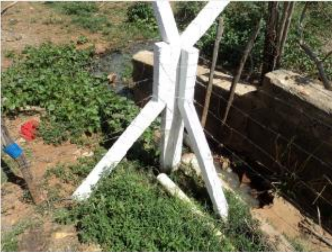
Foto 1 – EEE-01: ponto de extravazamento de esgoto, provocando maus odores.
