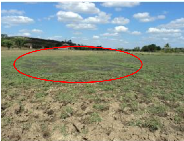
Foto 21 - Sinais de vazamento, com presença de esgoto e maus odores, no terreno por onde passa o emissário que encaminha o efluente para o Riacho do Meio.
