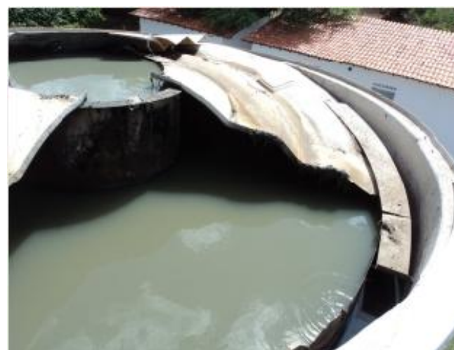
Foto 7 - Reator UASB: tampa deteriorada.
