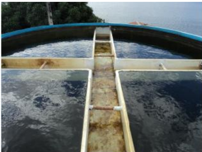
Foto 25 - Decantador: ausência de passarelas com guarda-corpos de proteção.
