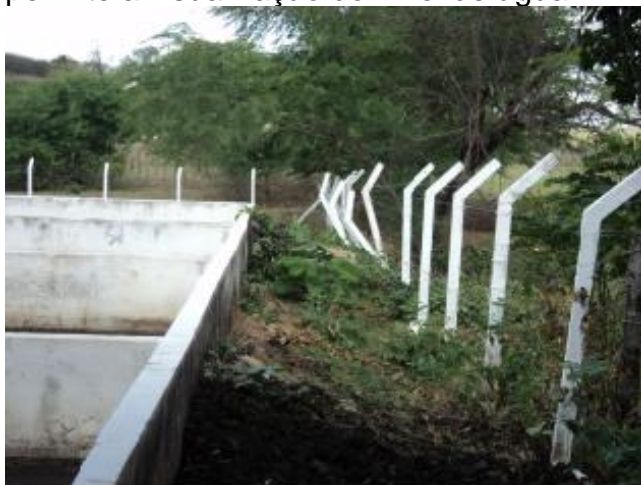
Foto 17 - ETE: cerca de delimitação danificada.
