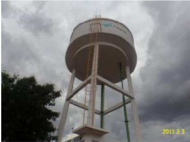
**Foto 18** – REL-02: escada sem fixação adequada.
