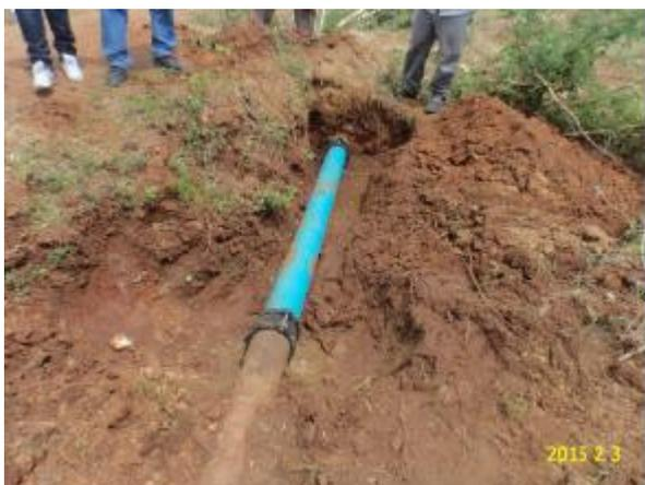
**Foto 21** – Rompimento da tubulação de ferro de 150 mm no terreno de um cliente.
