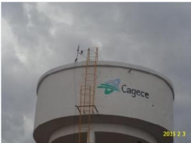
**Foto 7** – REL-02: Ausência de guarda corpos na laje de abertura.
