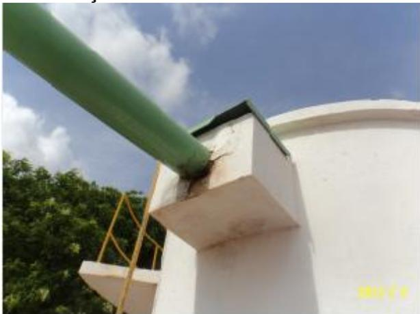
**Foto 10** – Filtro-01: estrutura da calha de água deteriorada.
