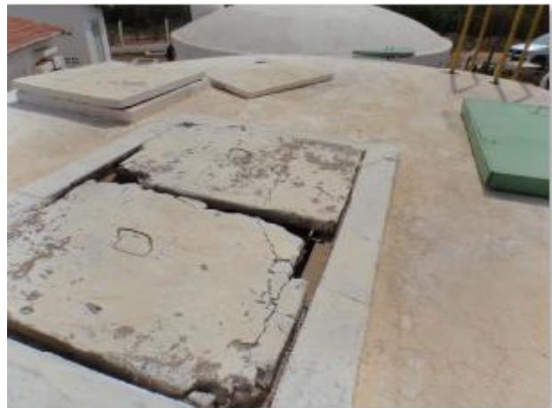
**Foto 11** – Filtro-01: tampas deterioradas.
