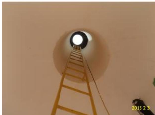
**Foto 6** – REL-01: ausência de tampa de inspeção.
