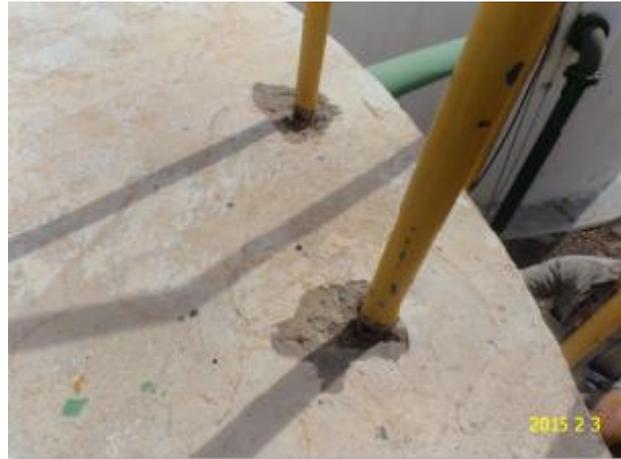
**Foto 9** – Filtro-01: base de fixação da escada deteriorada.
