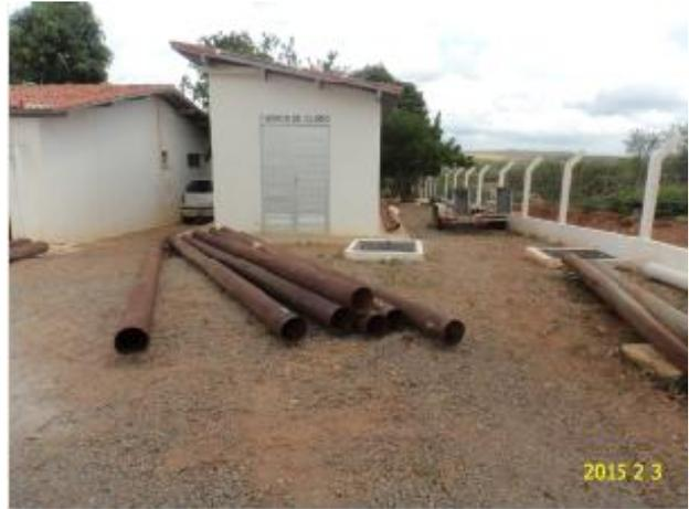
**Foto 13** – ETA: tubulações armazenadas na área sem proteção.
