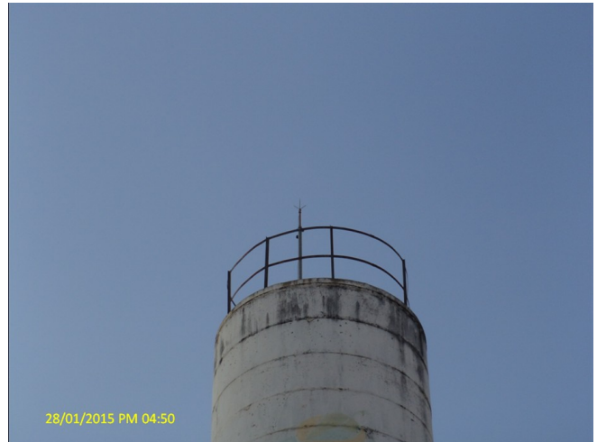
Foto 8 – REL-02: ausência de para-raios.
