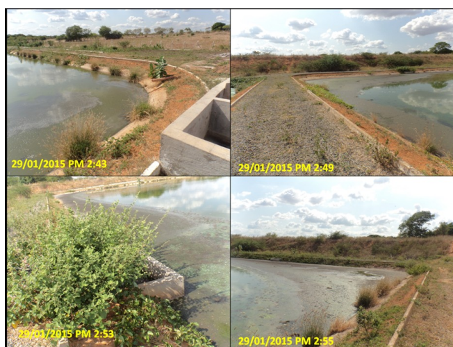
Foto 17 – ETE: ausência de placas de proteção nos taludes, presença de vegetação e sobrenadantes na LF.
