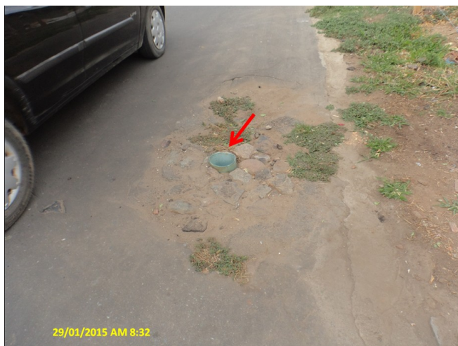
Foto 21 - RDA: registro de descarga sem caixa localizado na Rua Jucelino Kubishek, nº 110.
