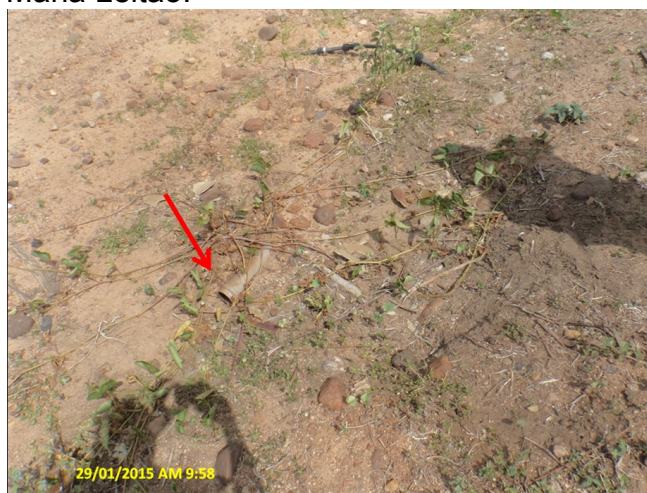
Foto 24 - RDA: registro de descarga sem caixa localizado na Av. Rio Branco.
