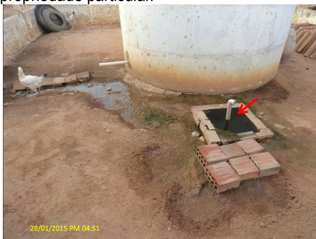
Foto 31 - REL-02: com vazamento no registro.
