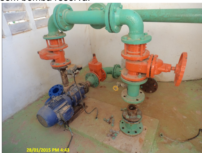
Foto 3 – EERD-01: sem bomba reserva.
