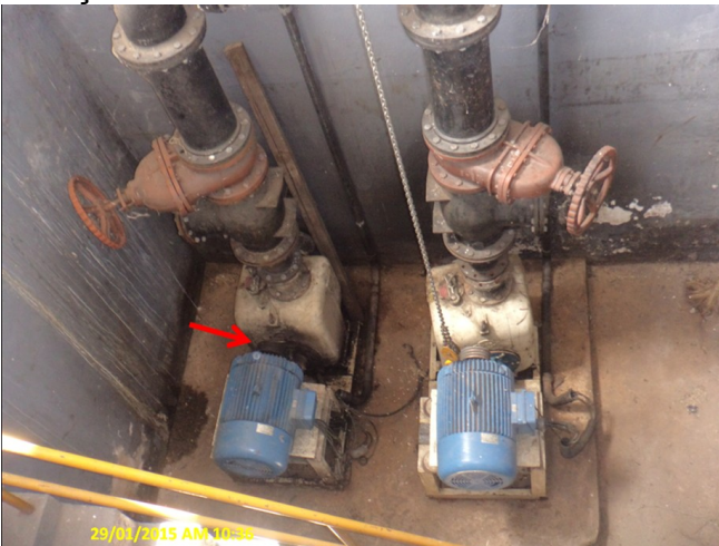
Foto 13 - EEE-01: uma das bombas parada sem polia.
