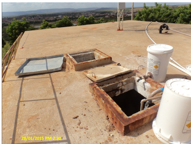
Foto 27 - RAP-02: tampa de inspeção em condições inadequadas de vedação.
