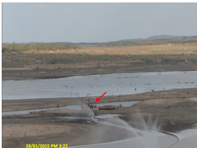
Foto 1 – EECS-01 (Açude Flor do Campo): sem bomba reserva.
