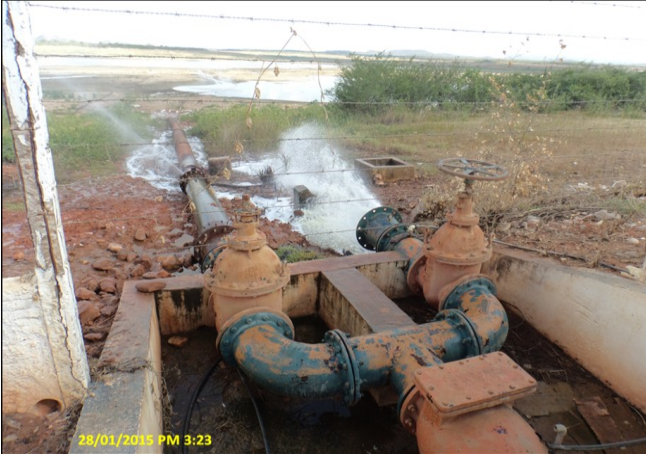
Foto 9 – AAB-01: adutora com vazamentos.
