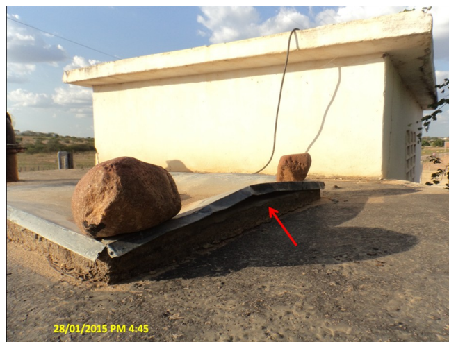
Foto 28 - RSE-01: tampa de inspeção em condições inadequadas de vedação.
