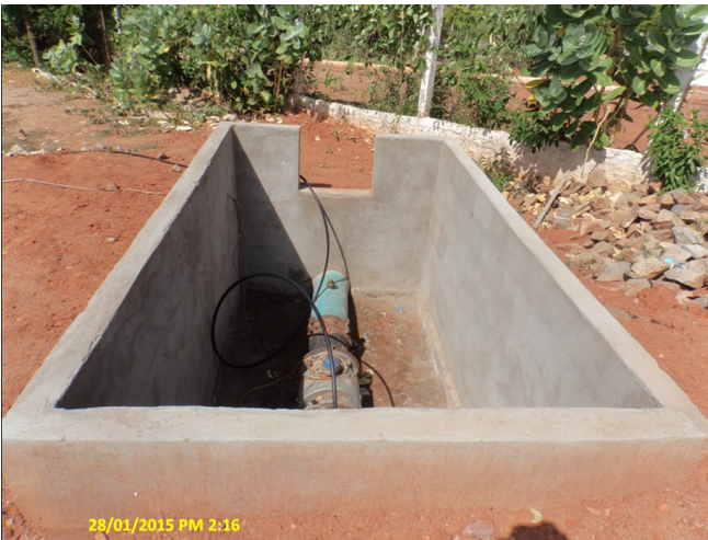
Foto 11 – AAB-01: caixa do macromedidor na entrada da ETA sem tampa ou grade de proteção.
