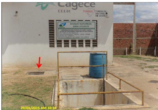
Foto 15 – EEE-01: poço sem tampa.
