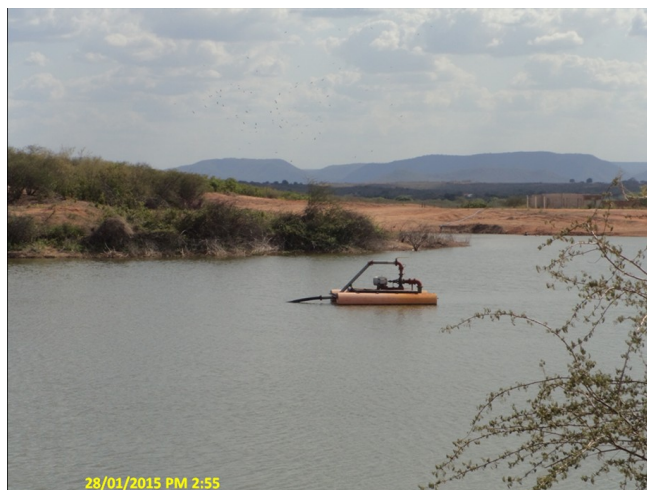
Foto 2 – EECS-02 (Açude dos Rodrigues): sem bomba reserva.
