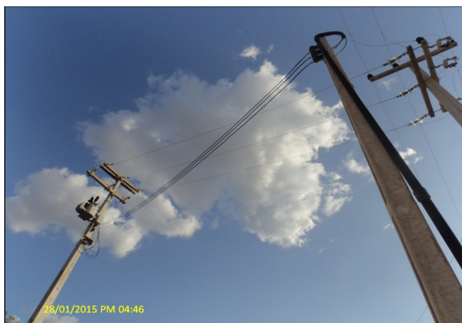
Foto 5 – EERD-01: sem iluminação para trabalhos noturnos.
