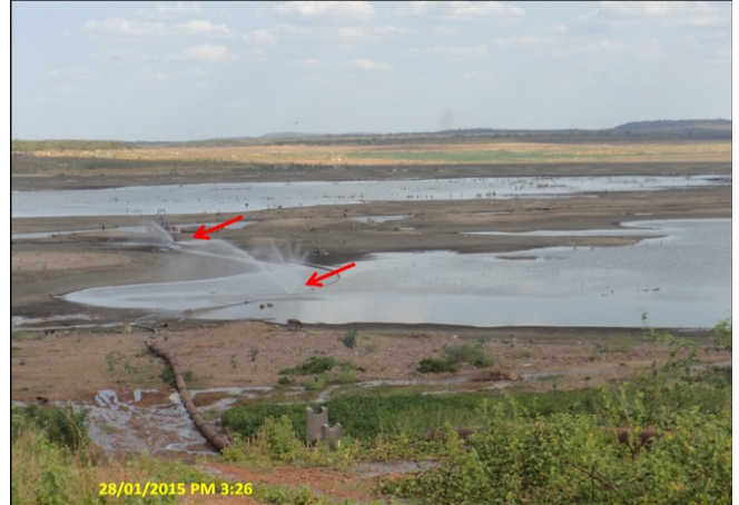
Foto 10 – AAB-01: mangueira danificada.
