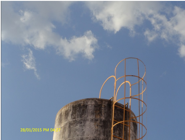
Foto 7 – REL de Agrovila: ausência de guarda-corpo, para-raios e sinalizador noturno
