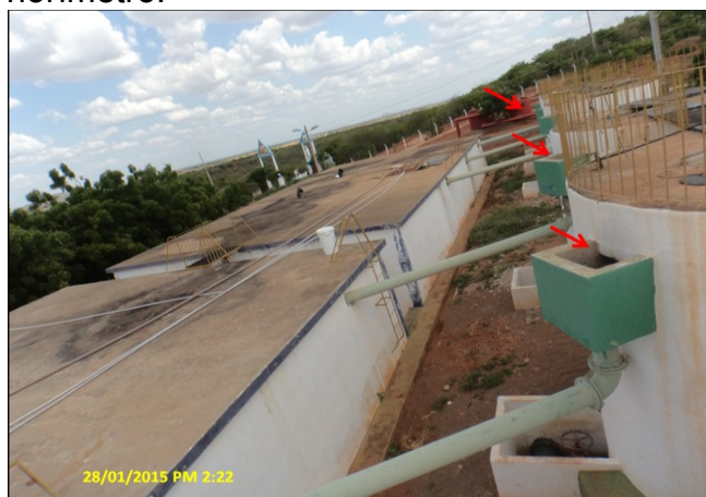
Foto 6 - ETA: nos filtros 01, 02, 03, 04, 05 e 06, verificou-se ausência de tampa de proteção nas caixas de saída da água tratada.
