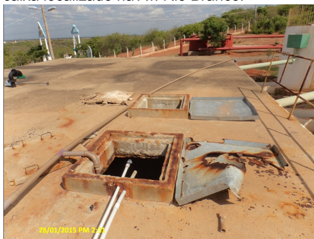
Foto 26 - RAP-01: tampa de inspeção em condições inadequadas de vedação.
