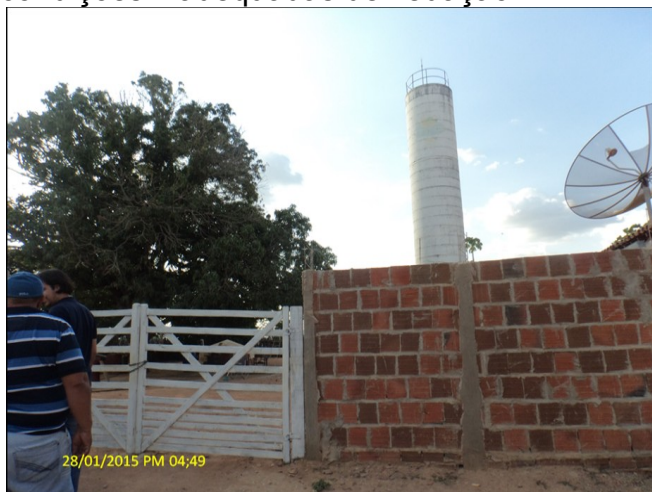
Foto 29 - REL-02: sem acesso locado em propriedade particular.
