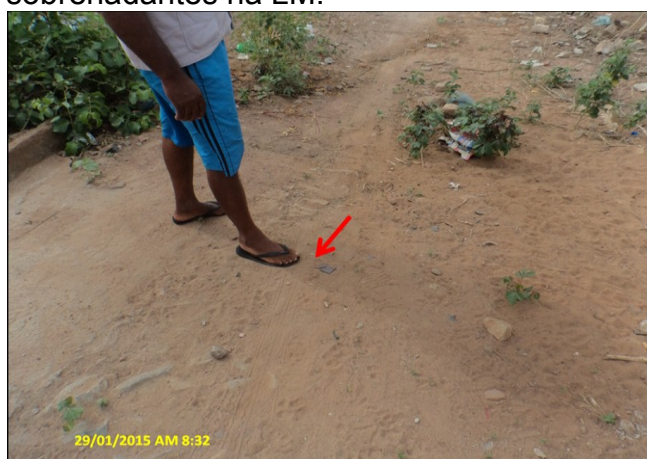
Foto 20 - RDA: registro de descarga soterrado localizado na Rua Otaviano Coelho.
