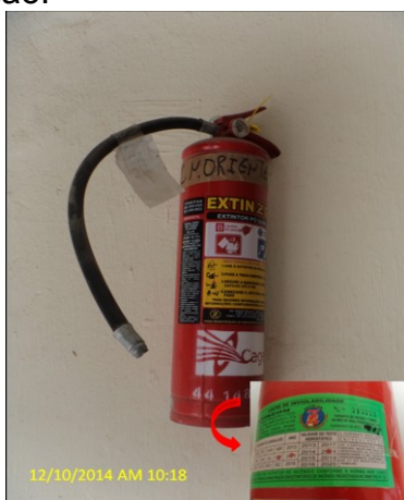
Foto 34 – Loja de atendimento: extintor vencido em ago/14.
