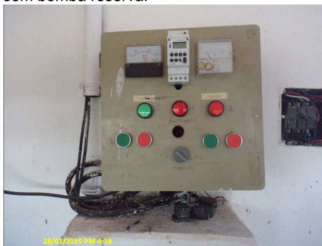
Foto 4 – EERD-01: quadro de comando sem horímetro.
