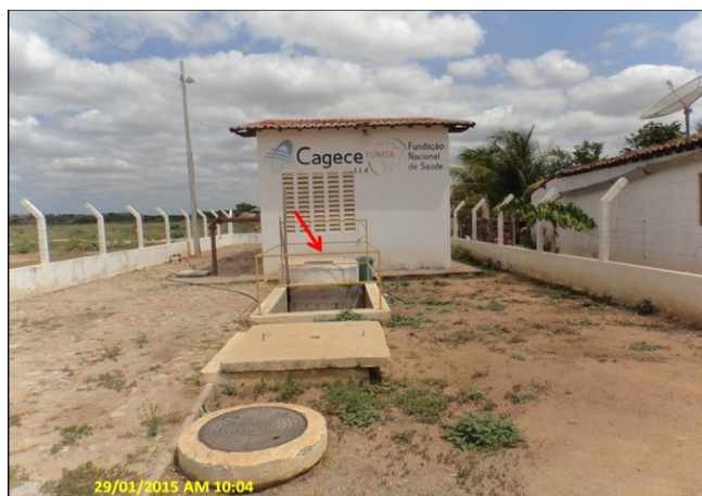
Foto 16 – EEE-04: poço de sucção sem tampa.
