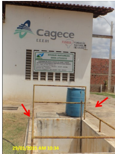
Foto 36 – EEE-01: altura da grade de proteção inadequada.
