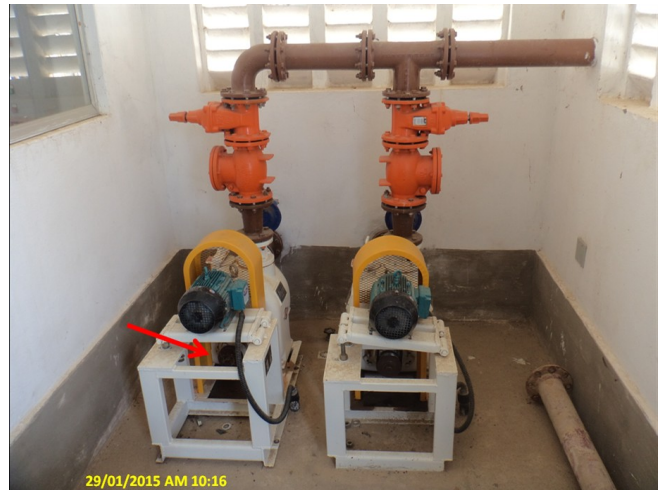
Foto 14 - EEE-03: uma das bombas parada sem correia.
