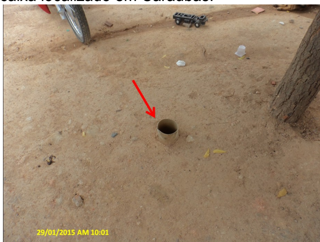
Foto 25 - RDA: registro de descarga sem caixa localizado na Rua Capitão Nenen.
