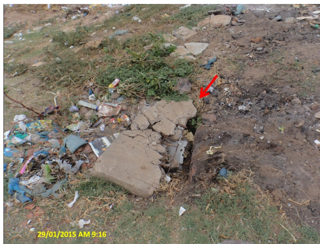
Foto 22 - RDA: registro de descarga com caixa danificada localizado na Rua Dr. José Maria Leitão.
