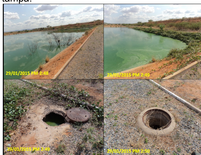
Foto 18 – ETE: ausência de placas de proteção nos taludes, poços de inspeção sem tampa, presença de vegetação e sobrenadantes na LM.
