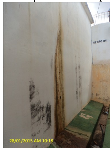
Foto 30 - RAP-02: com rachaduras e infiltrações.
