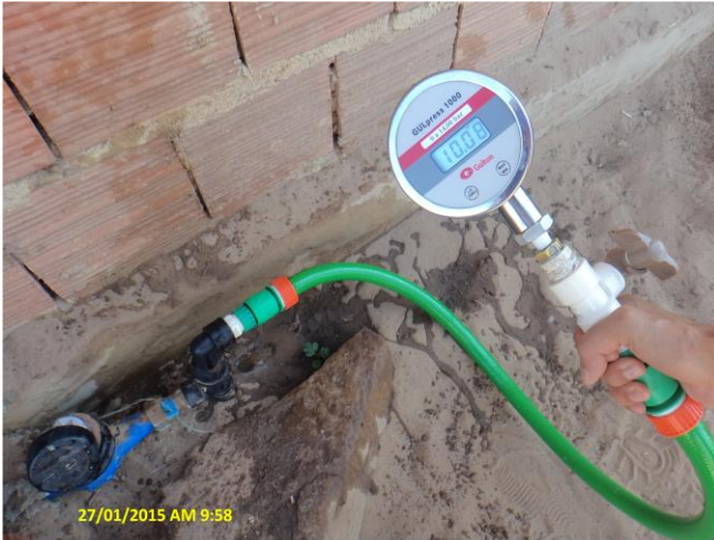
Foto 1 – Medição de pressão na Rua 01, s/n – Bom Princípio.
