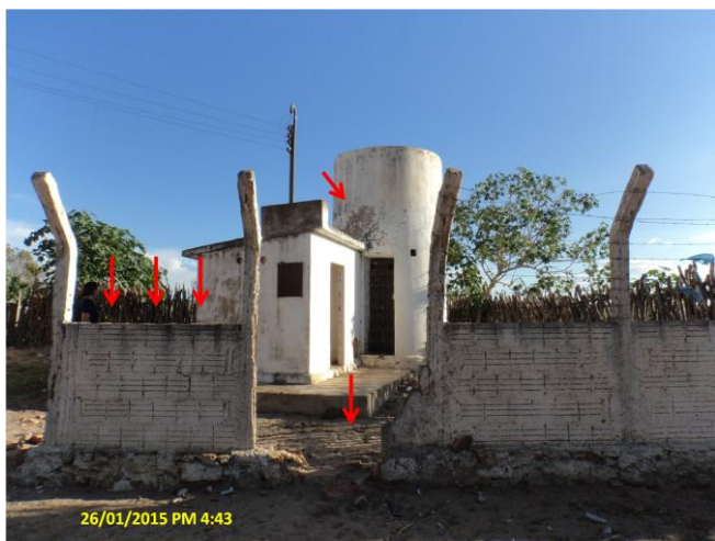
Foto 12 – PT-01: mureta, cerca danificada, casa de abrigo do QC com reboco e pintura deteriorada.
