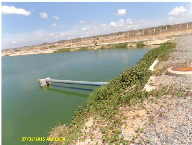
Foto 18 – ETE: talude danificado e com vegetação na lagoa facultativa.
