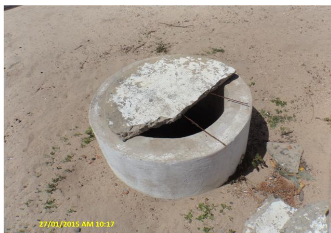
Foto 15 – EEE-01: poço de chegada com tampa deteriorada.
