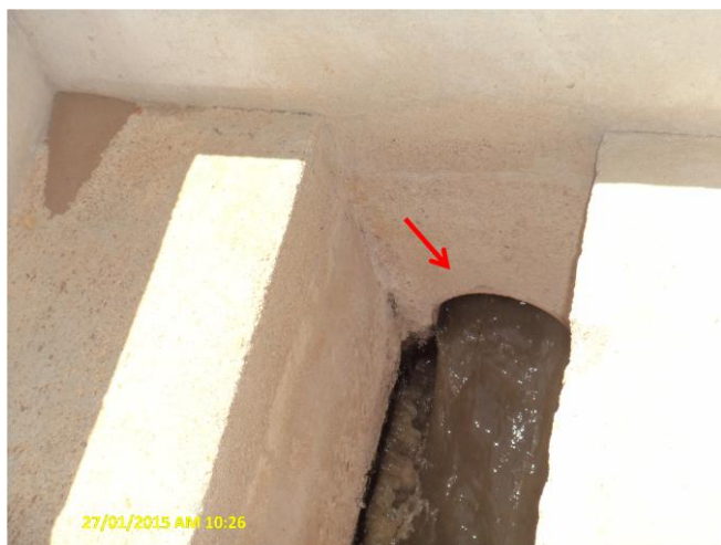
Foto 6 – ETE: falta gradeamento na entrada do tratamento preliminar.
