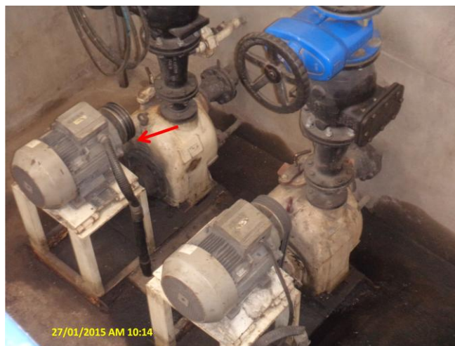
Foto 13 - EEE-01: uma das bombas parada com problema na correia.
