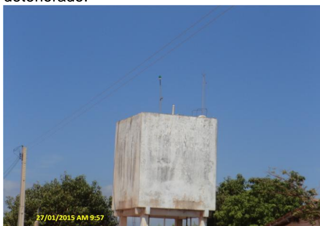
Foto 11 – REL-03: ausência de guarda-corpo, tubulação de ventilação, revestimento e pintura deteriorados.
