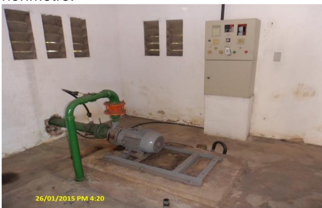
Foto 4 – EEAT-02: sem bomba reserva.
