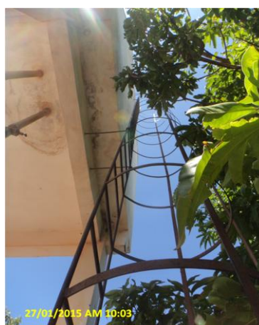
Foto 23 – REL-03: guarda-corpo da escadas de acesso com ferrugem.
