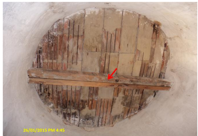
Foto 3 – PT-01: sem iluminação para trabalhos noturnos.
