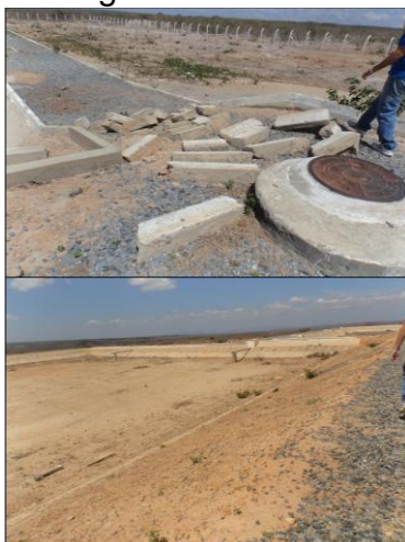
Foto 20 – ETE: guias e placas de proteção dos taludes das lagoas de maturação deterioradas.
