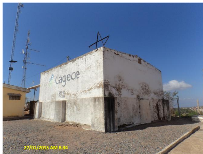
Foto 7 – RAP-01: ausência de guarda-corpo, revestimento e pintura deteriorados.
