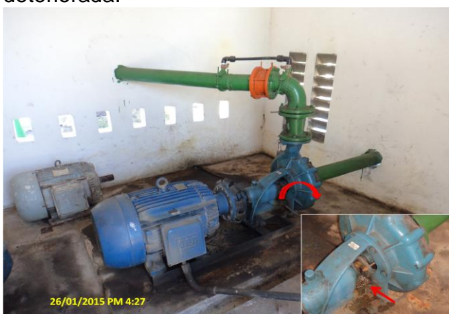
Foto 14 – EEAT-03: apresenta vazamento no fuso da bomba.
