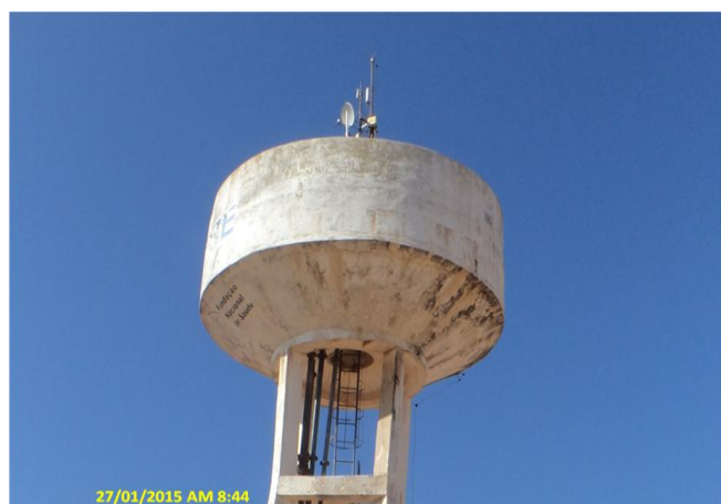
Foto 10 – REL-01: Falta sinalização de obstáculo, revestimento e pintura deteriorados.
