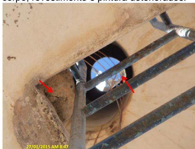
Foto 9 – REL-01: ausência de tampa na abertura de inspeção, infiltração e reboco deteriorado.
