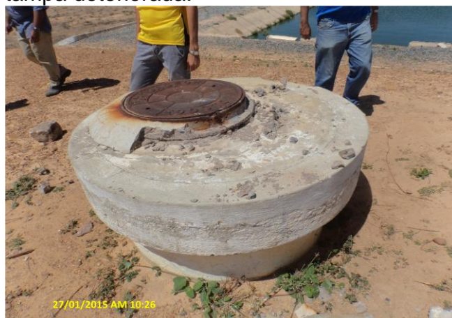
Foto 17 – ETE: poço de chegada com estrutura danificada.
