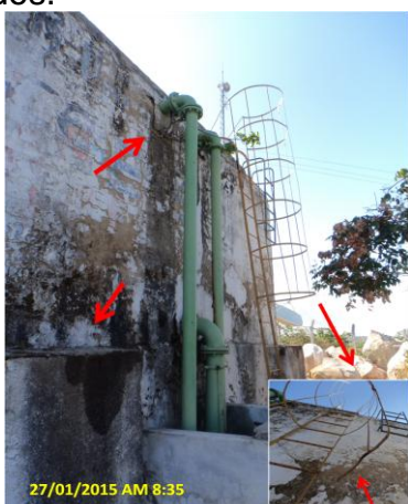
Foto 22 – RAP-01: a escadas de acesso com estrutura solta, corroída e infiltração nas paredes.
