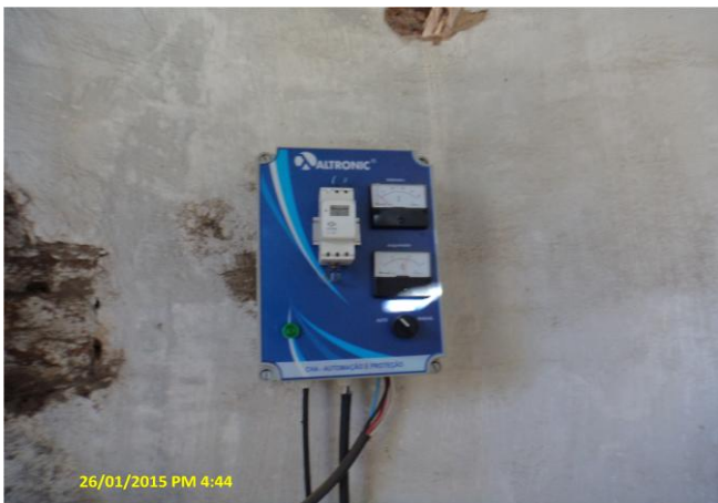
Foto 2 – PT-01: quadro de comando sem horímetro.
