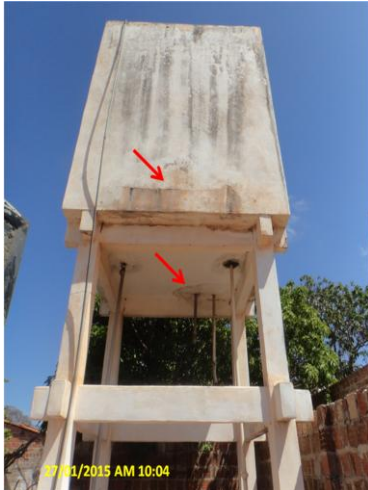
Foto 24 – REL-03: infiltração na laje.
