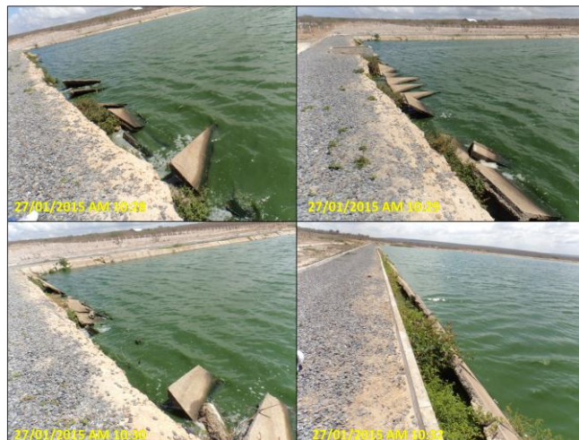
Foto 19 – ETE: placas de proteção dos taludes da lagoa facultativa deterioradas.
