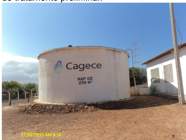
Foto 8 – RAP-02: ausência de guarda-corpo.
