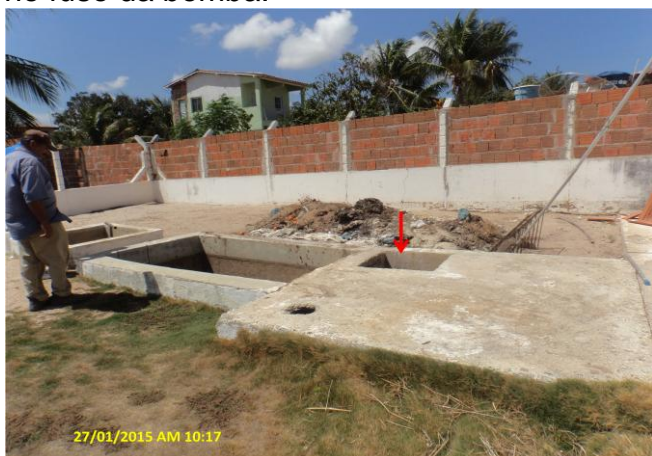
Foto 16 – EEE: poço de sucção sem tampa.
