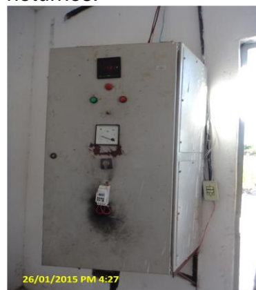
Foto 5 – EEAT-03: quadro de comando sem horímetro.
